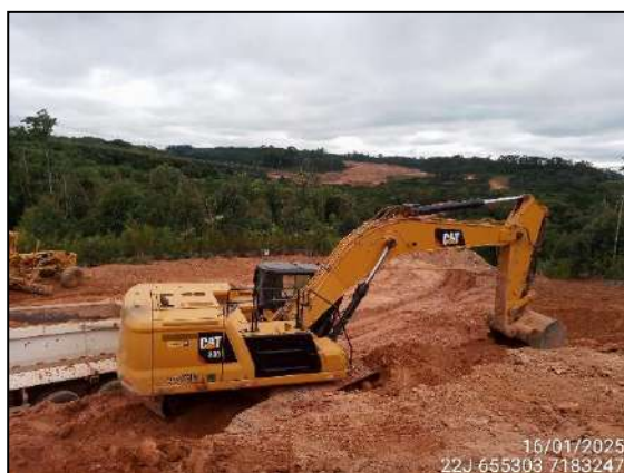
FIGURA 7: ESCAVAÇÃO PARA RETIRADA DE MATERIAL DESTINADO A TERRAPLANAGEM.
