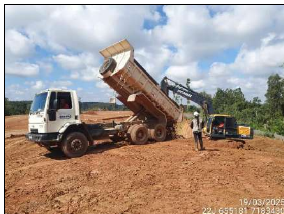
FIGURA 6: ARQUEOLOGA ACOMPANHANDO ESCAVAÇÃO DE MATERIAL PARA ATERRO.
