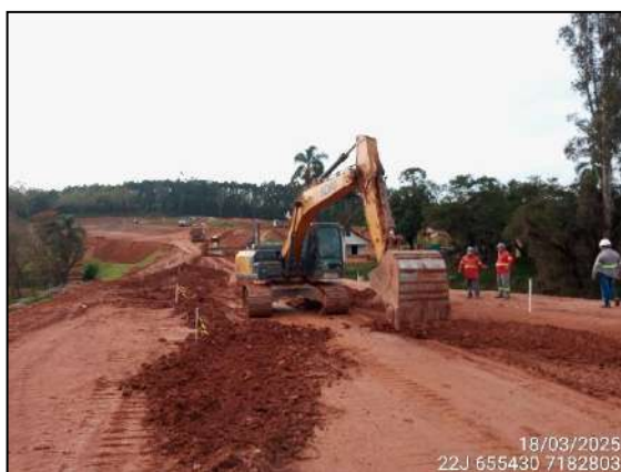
FIGURA 3: ESCAVAÇÃO PARA NIVELAMENTO DA RUA.
