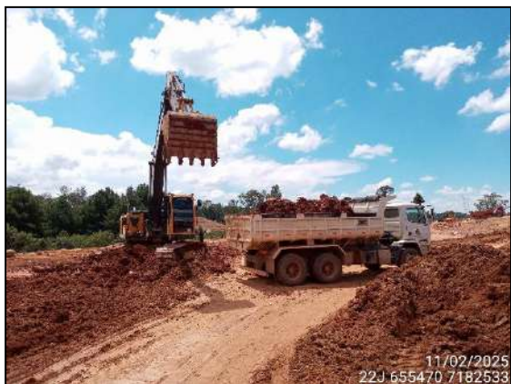
FIGURA 3: ESCAVAÇÃO PARA RETIRADA DE MATERIAL
