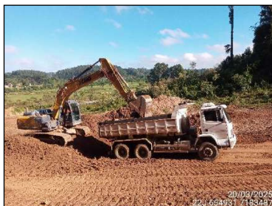
FIGURA 38: ESCAVAÇÃO PARA RETIRADA DE TERRA DESTINADO A ATERRO.
