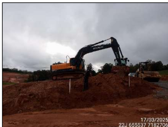
FIGURA 1: ATIVIDADE PARADA DEVIDO À CHUVA.
