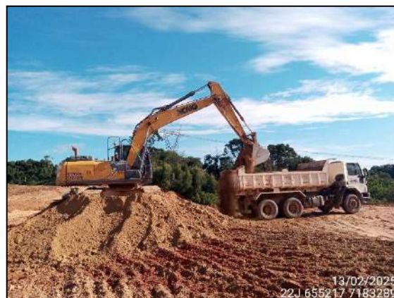
FIGURA 6: MOVIMENTAÇÃO DE ATERRO.
