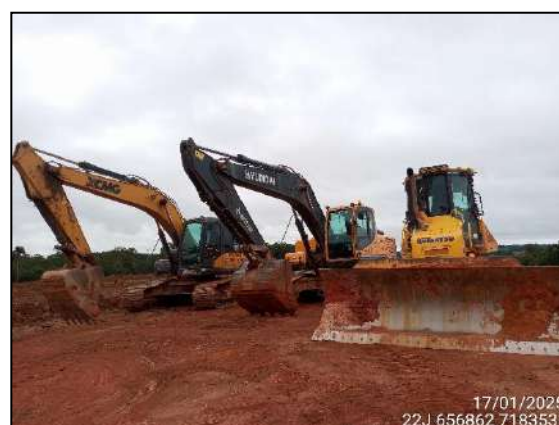
FIGURA 10: ATIVIDADE PARADA DEVIDO À CHUVA.
