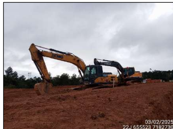
FIGURA 2: ATIVIDADE PARADA DEVIDO À CHUVA.
