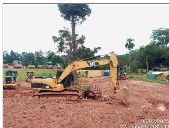
FIGURA 6: ATIVIDADE PARADA DEVIDO À CHUVA.
