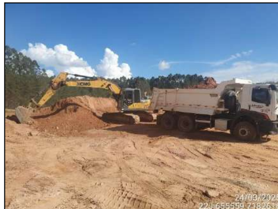
FIGURA 2: ESCAVAÇÃO PARA UTILIZAÇÃO DO MATERIAL EM ATERRO.
