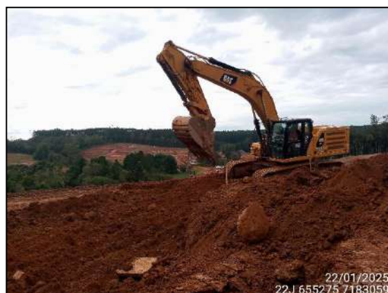
FIGURA 4: ESCAVAÇÃO PARA RETIRADA DE MATERIAL DESTINADO A TERRAPLANAGEM.
