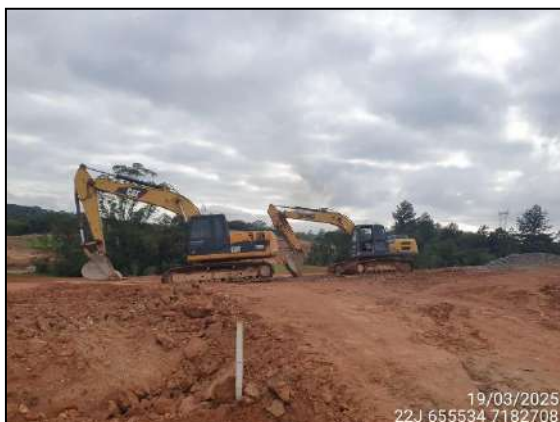
FIGURA 5: ATIVIDADE PARADA DEVIDO À CHUVA.
