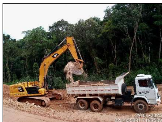
FIGURA 6: ESCAVAÇÃO PARA RETIRADA DE MATERIAL DESTINADO A TERRAPLANAGEM.
