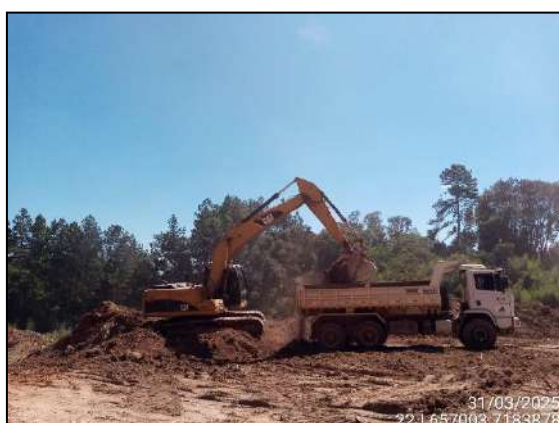
FIGURA 45: ESCAVAÇÃO PARA RETIRADA DE TERRA DESTINADO A ATERRO.
