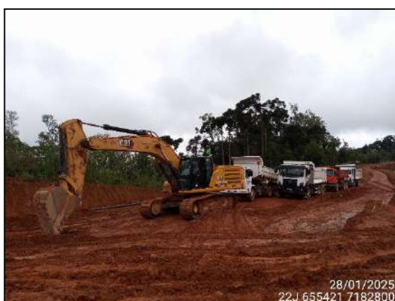
FIGURA 3: ATIVIDADES PARADAS DEVIDO À CHUVA.
