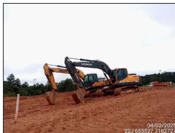
FIGURA 25: ATIVIDADES PARADAS DEVIDO A CHUVA.
