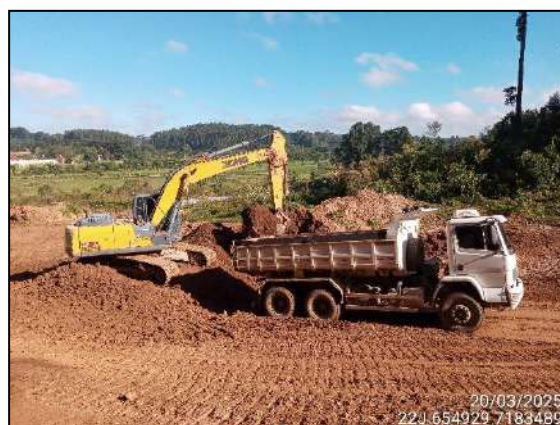
FIGURA 8: ESCAVAÇÃO PARA UTILIZAÇÃO DESSE MATERIAL EM ATERRO.
