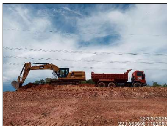
FIGURA 13: ESCAVAÇÃO PARA RETIRADA DE MATERIAL DESTINADA A ATERRO.
