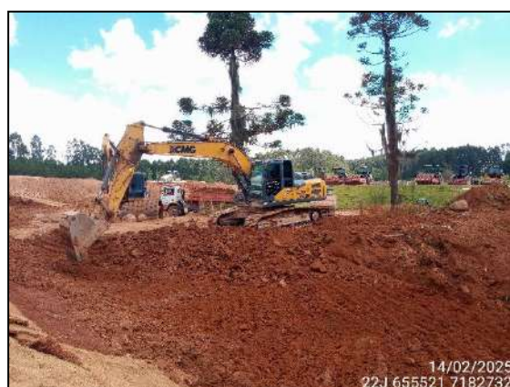
FIGURA 10: MOVIMENTAÇÃO DE ATERRO.
