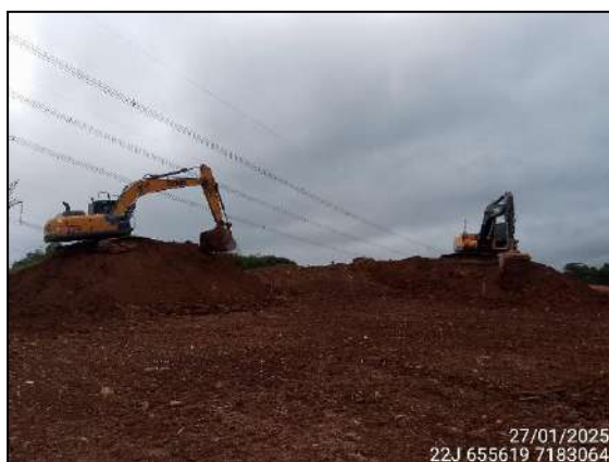
FIGURA 1: MOVIMENTAÇÃO DE TERRA.
