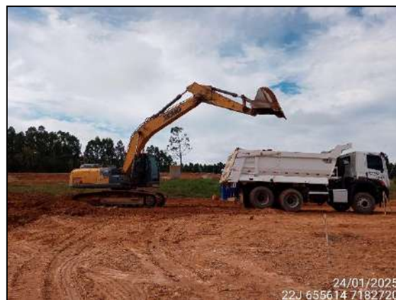
FIGURA 8: ALINHAMENTO DA VIA QUE LEVA A ÁREA 6 COM RETIRADA DO EXCESSO DE MATERIAL.
