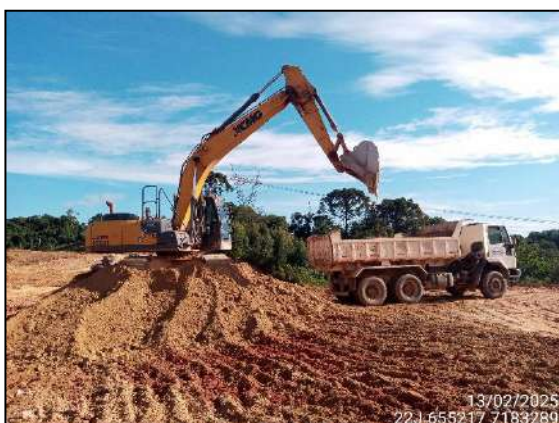
FIGURA 32: ESCAVAÇÃO PARA RETIRADA DE TERRA DESTINADO A ATERRO.
