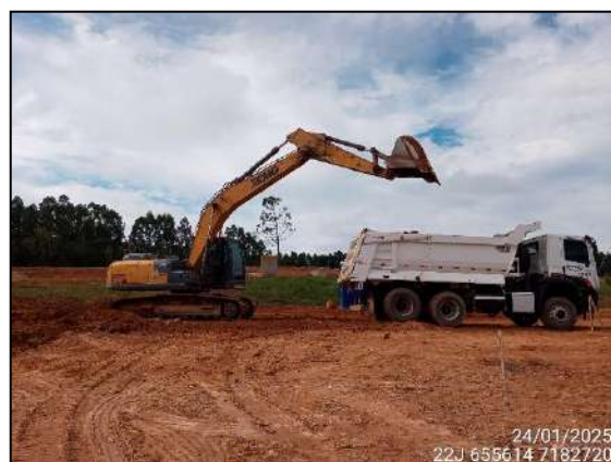
FIGURA 15: ESCAVAÇÃO E MOVIMENTAÇÃO DE SOLO.
