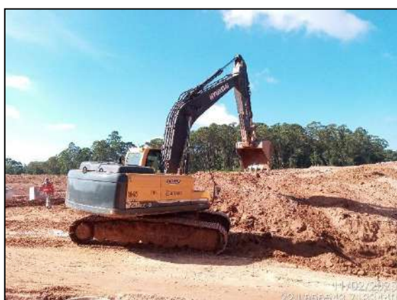
FIGURA 29: ESCAVAÇÃO PARA RETIRADA DE TERRA DESTINADO A ATERRO.
