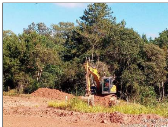
FIGURA 4: ESCAVAÇÃO PARA NIVELAMENTO DE AREA PARA COLOCAR GRAMA.
