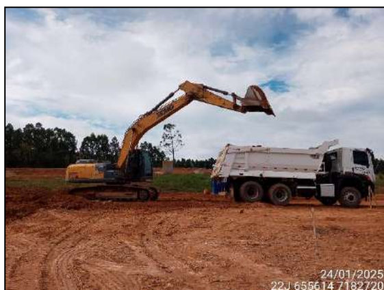
FIGURA 16: ALINHAMENTO DA VIA QUE LEVA A ÁREA 6 COM RETIRADA DO EXCESSO DE MATERIAL.
