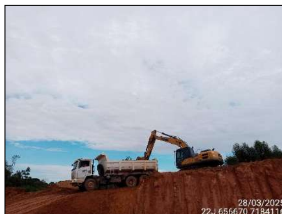
FIGURA 44: ESCAVAÇÃO PARA RETIRADA DE TERRA DESTINADO A ATERRO.
