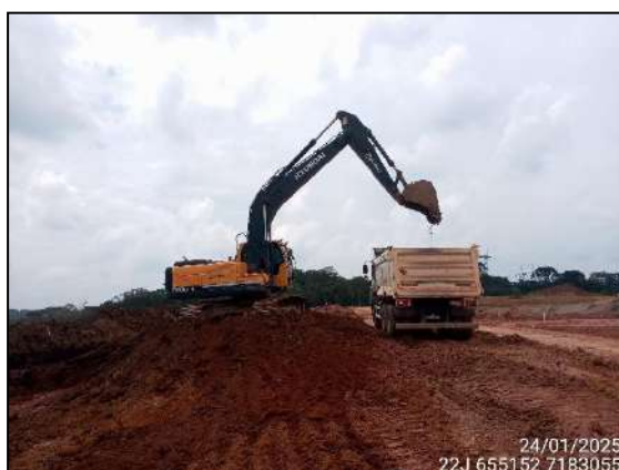
FIGURA 9: ALINHAMENTO DA VIA PRINCIPAL COM RETIRADA DO EXCESSO DE MATERIAL.
