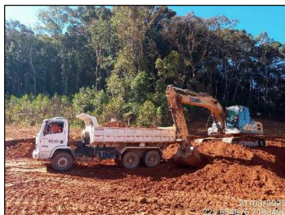
FIGURA 39: ESCAVAÇÃO PARA NIVELAMENTO DE RUA E ATERRO.
