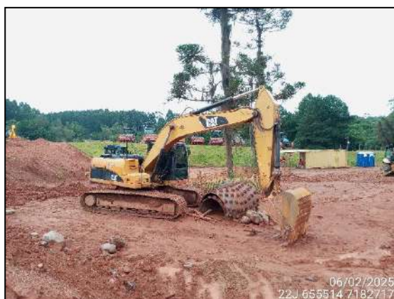
FIGURA 7: ATIVIDADE PARADA DEVIDO À CHUVA.
