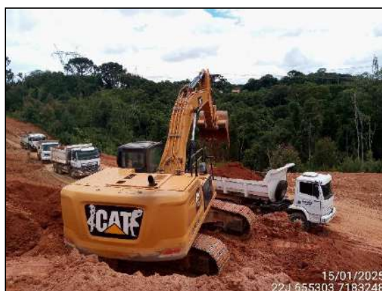
FIGURA 6: ESCAVAÇÃO PARA RETIRADA DE MATERIAL DESTINADO A TERRAPLANAGEM.
