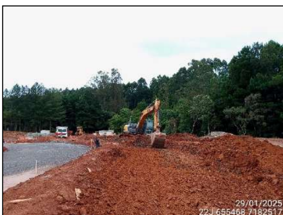
FIGURA 5: ALINHAMENTO ENTRADA DA ÁREA 6 COM RETIRADA DO EXCESSO DE MATERIAL.
