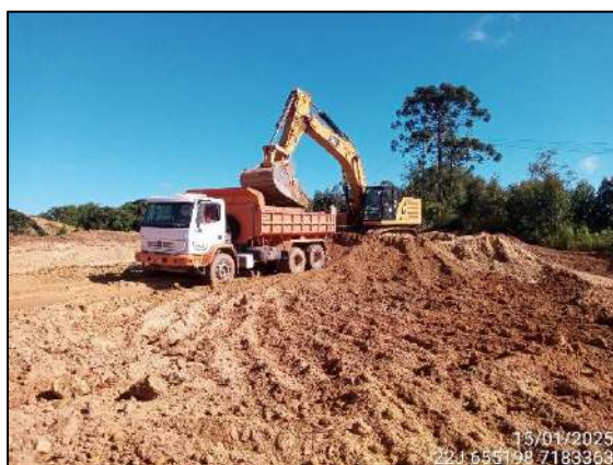
FIGURA 8: ESCAVAÇÃO PARA RETIRADA DE MATERIAL DESTINADA A ATERRO.
