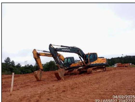
FIGURA 3: ATIVIDADE PARADA DEVIDO À CHUVA.
