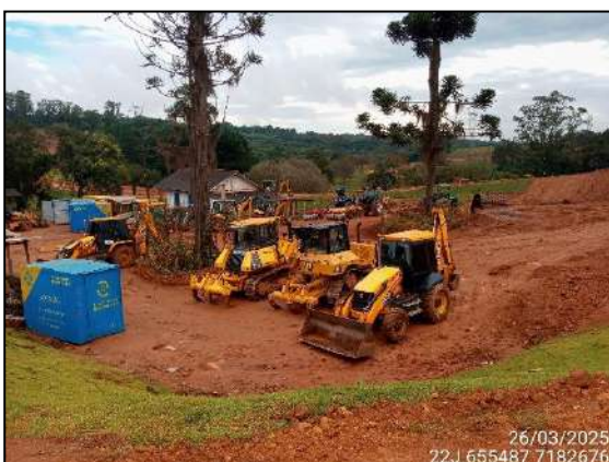
FIGURA 5: ATIVIDADE PARADA DEVIDO À CHUVA.
