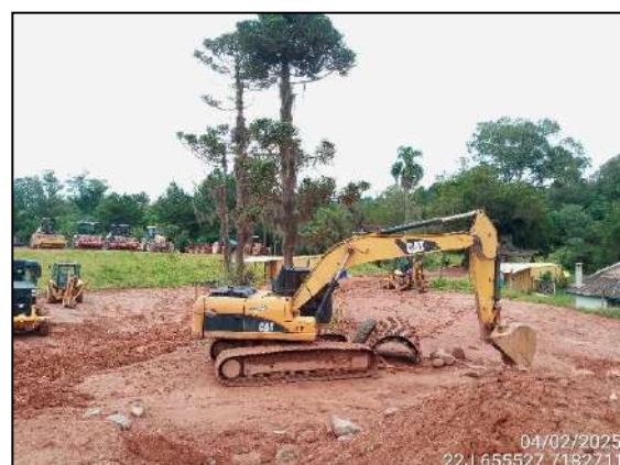
FIGURA 4: ATIVIDADE PARADA DEVIDO À CHUVA.
