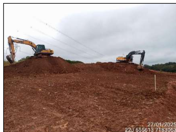
FIGURA 2: MOVIMENTAÇÃO DE TERRA
