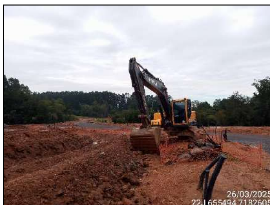
FIGURA 6: ATIVIDADE PARADA DEVIDO À CHUVA.
