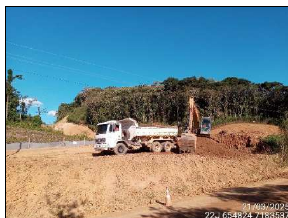
FIGURA 10: ESCAVAÇÃO PARA UTILIZAÇÃO DESSE MATERIAL EM ATERRO.
