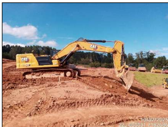
FIGURA 1: ESCAVAÇÃO E MOVIMENTAÇÃO DE ATERRO.
