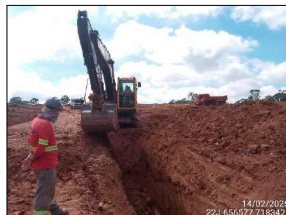
FIGURA 33: ESCAVAÇÃO E MOVIMENTAÇÃO DE SOLO PARA IMPLANTAÇÃO DE REDE HIDRICA.
