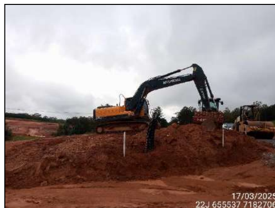
FIGURA 2: ATIVIDADE PARADA DEVIDO À CHUVA.
