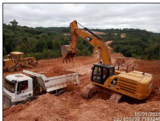
FIGURA 9: ESCAVAÇÃO PARA RETIRADA DE MATERIAL DESTINADA A ATERRO.
