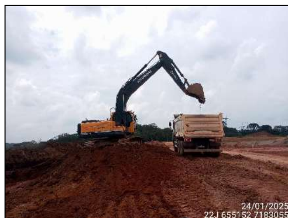
FIGURA 17: ALINHAMENTO DA VIA PRINCIPAL COM RETIRADA DO EXCESSO DE MATERIAL.
