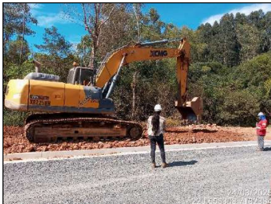
FIGURA 1: ARQUEOLOGA ACOMPANHANDO ESCAVAÇÃO PARA NIVELAMENTO DE CALÇADA.
