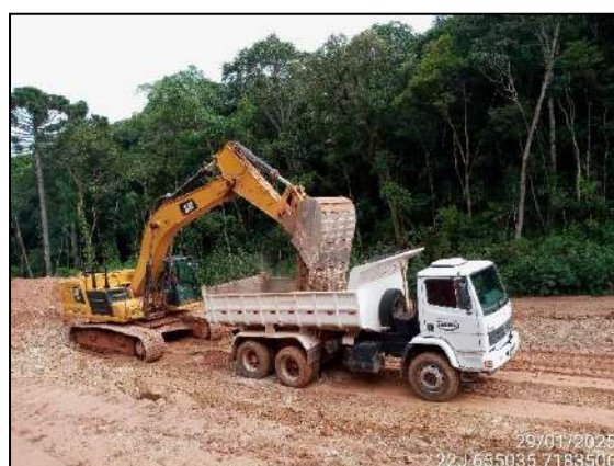
FIGURA 20: ESCAVAÇÃO PARA RETIRADA DE MATERIAL DESTINADA A ATERRO.
