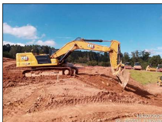
FIGURA 28: ESCAVAÇÃO E MOVIMENTAÇÃO DE ATERRO.
