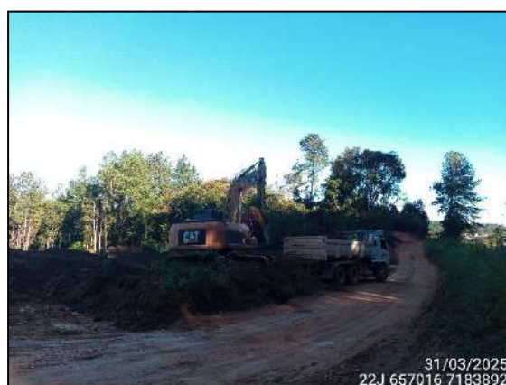
FIGURA 11: ESCAVAÇÃO DE ALERA PARA ATERRO.
