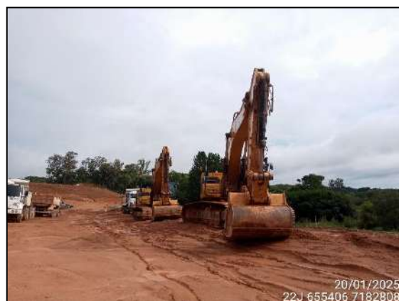
FIGURA 11: ATIVIDADES PARALISADAS DEVIDO ÀS CHUVAS.
