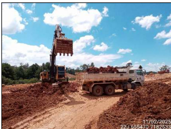
FIGURA 30: MOVIMENTAÇÃO DE ATERRO.
