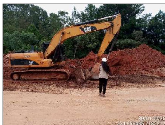
FIGURA 21: ARQUEÓLOGA ACOMPANHANDO ESCAVAÇÃO E MOVIMENTAÇÃO DE SOLO.
