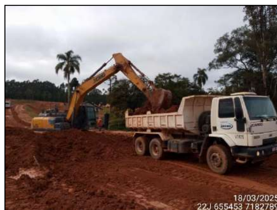
FIGURA 36: ESCAVAÇÃO PARA NIVELAMENTO DA RUA.
