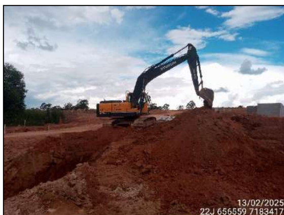
FIGURA 7: ESCAVAÇÃO PARA IMPLANTAÇÃO DAS CAIXAS HÍDRICAS E TUBULAÇÃO.
