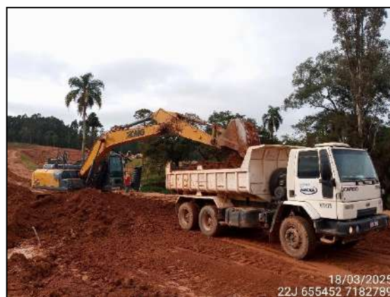
FIGURA 4: ESCAVAÇÃO PARA ALINHAMENTO DA RUA E DA CALÇADA.
