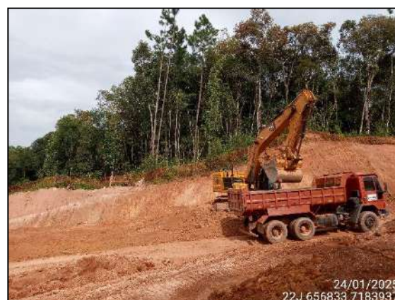
FIGURA 10: ESCAVAÇÃO PARA RETIRADA DE MATERIAL DESTINADO A TERRAPLANAGEM.
