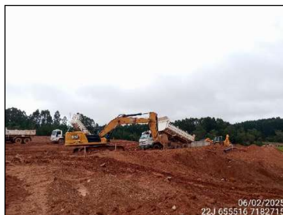
FIGURA 8: ATIVIDADE PARADA DEVIDO À CHUVA.
