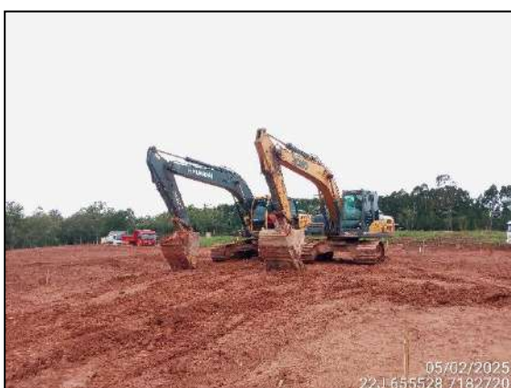
FIGURA 5: ATIVIDADE PARADA DEVIDO À CHUVA.
