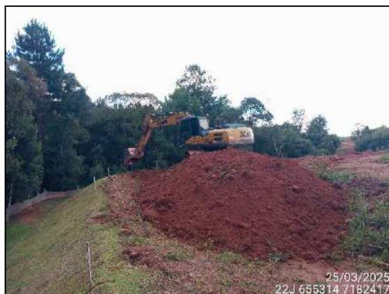
FIGURA 41: ESCAVAÇÃO PARA RETIRADA DE TERRA PARA PLANTAR GRAMA.
