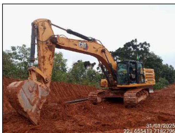
FIGURA 22: ATIVIDADES PARALISADAS DEVIDO ÀS CHUVAS.
