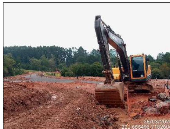
FIGURA 42: ESCAVAÇÃO PARA RETIRADA DE TERRA PARA NIVELAR A CALÇADA.
