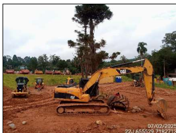
FIGURA 9: ATIVIDADE PARADA DEVIDO À CHUVA.
