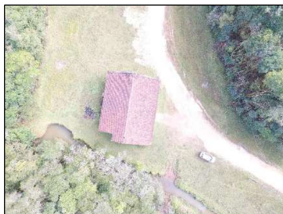
FIGURA 5: BARRACÃO DA ANTIGA MINA TIMBUTUVA
