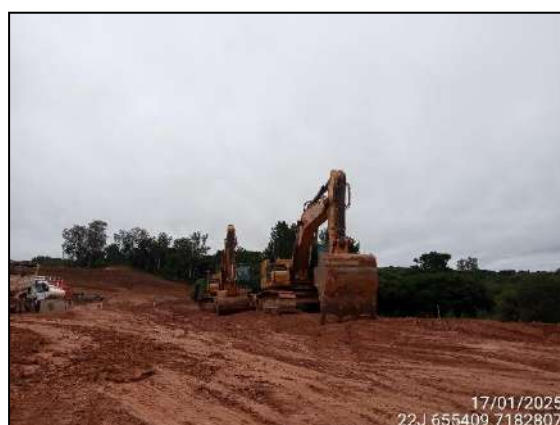
FIGURA 9: ATIVIDADE PARADA DEVIDO À CHUVA.
