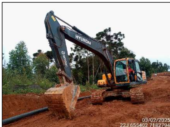
FIGURA 1: ATIVIDADE PARADA DEVIDO À CHUVA.
