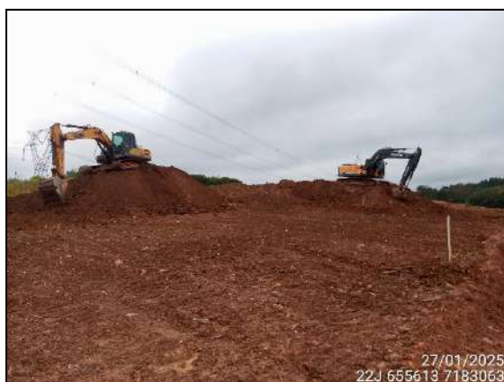
FIGURA 18: ESCAVAÇÃO E MOVIMENTAÇÃO DE SOLO.
