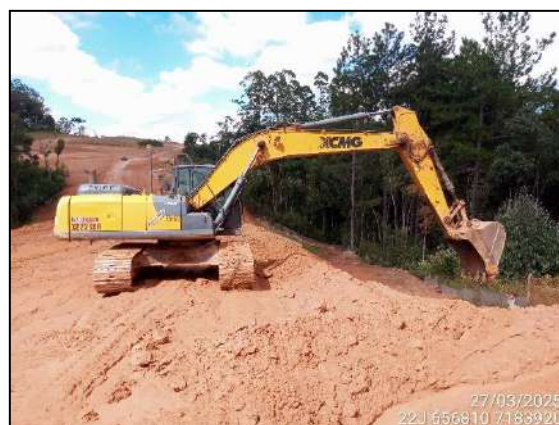
FIGURA 8: ESCAVAÇÃO DE RAMPA PARA PLANTAR GRAMA.
