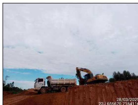
FIGURA 10: ESCAVAÇÃO PARA UTILIZAÇÃO DESSE MATERIAL EM ATERRO.
