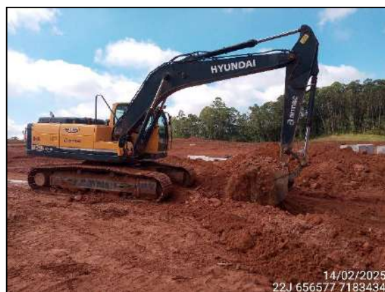
FIGURA 8: ESCAVAÇÃO PARA IMPLANTAÇÃO DAS CAIXAS HÍDRICAS E TUBULAÇÃO.
