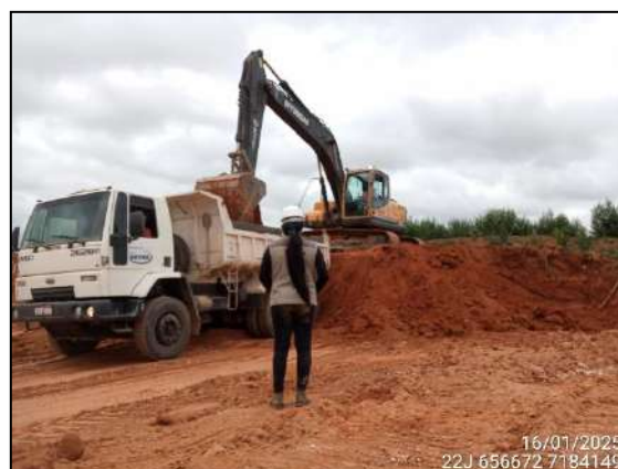
FIGURA 8: ESCAVAÇÃO PARA RETIRADA DE MATERIAL DESTINADO A TERRAPLANAGEM.
