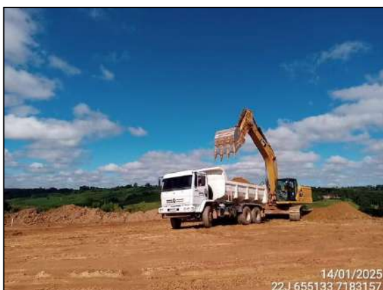
FIGURA 3: ESCAVAÇÃO PARA RETIRADA DE MATERIAL DESTINADO A TERRAPLANAGEM.
