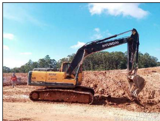
FIGURA 2: ESCAVAÇÃO PARA NIVELAMENTO DE RUA
