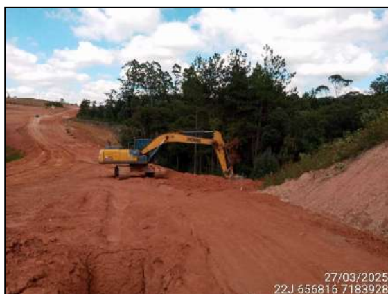
FIGURA 7: ESCAVAÇÃO DE RAMPA PARA PLANTAR GRAMA.
