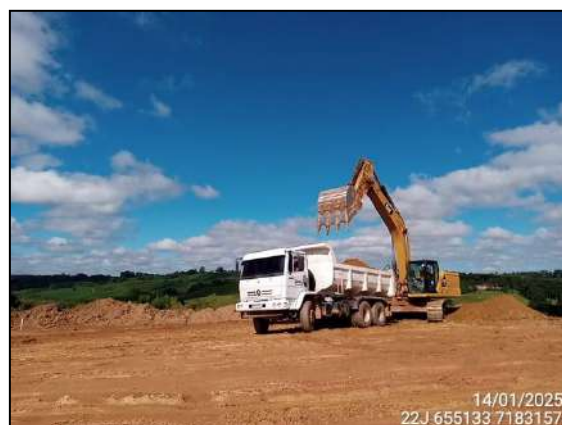
FIGURA 7: ESCAVAÇÃO PARA REPARO DE DANOS CAUSADOS PELA CHUVA.
