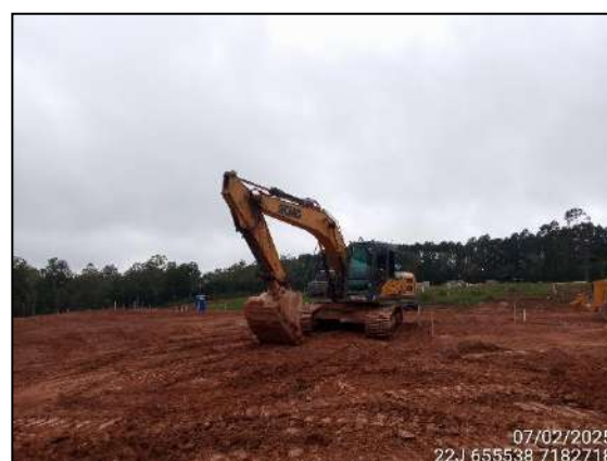
FIGURA 10: ATIVIDADE PARADA DEVIDO À CHUVA.
