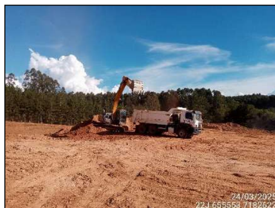
FIGURA 40: ESCAVAÇÃO PARA RETIRADA DE TERRA DESTINADO A ATERRO.
