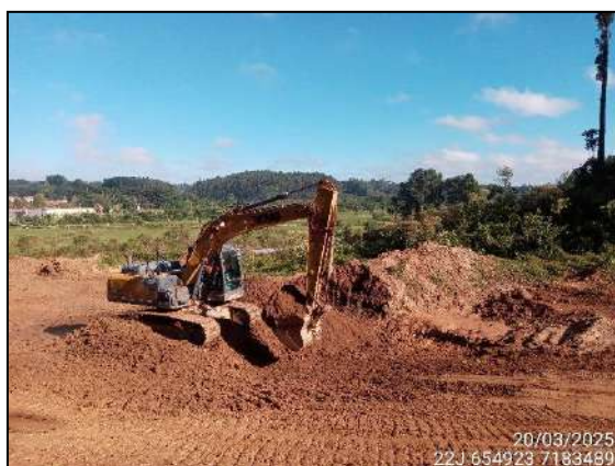
FIGURA 7: ESCAVAÇÃO PARA UTILIZAÇÃO DESSE MATERIAL EM ATERRO.
