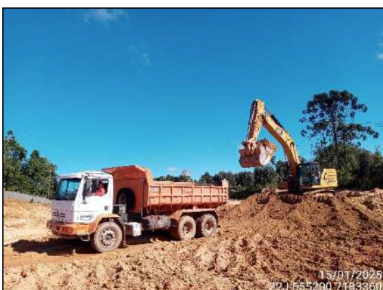
FIGURA 5: ESCAVAÇÃO PARA RETIRADA DE MATERIAL DESTINADO A TERRAPLANAGEM.
