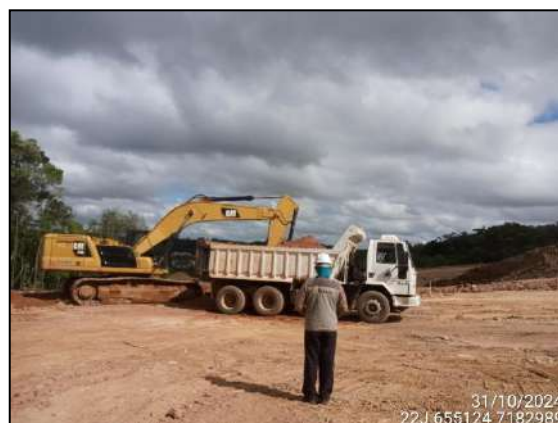
FIGURA 29: ABERTURA DE VALA
