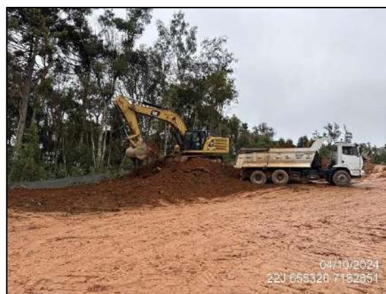
FIGURA 9: MONITORAMENTO DAS ATIVIDADES DE ESCAVAÇÃO E MOVIMENTAÇÃO DE SOLO.
