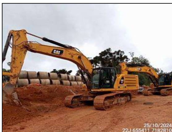
FIGURA 24: ARQUEÓLOGA ACOMPANHANDO ESCAVAÇÃO E MOVIMENTAÇÃO DE SOLO.
