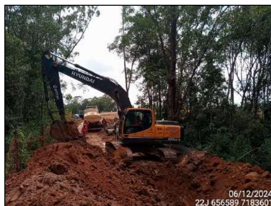
FIGURA 8: ESCAVAÇÃO PARA INSTALAÇÃO DE ESCAPE DE ESGOTO.
