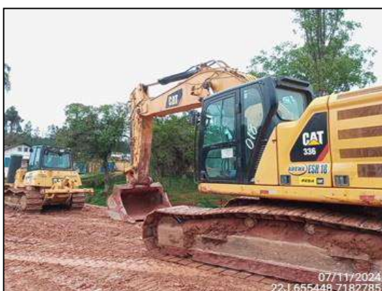
FIGURA 5: ATIVIDADES PARADAS DEVIDO A CHUVA.
