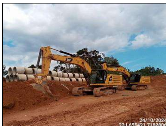
FIGURA 6: MONITORAMENTO DE ATIVIDADE DE ESCAVAÇÃO E MOVIMENTAÇÃO DE SOLO.
