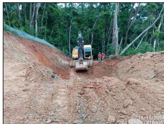
FIGURA 51: ESCAVAÇÃO PARA INSTALAÇÃO DE TUBULAÇÃO DE ESCAPE HÍDRICO.
