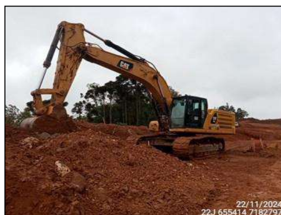
FIGURA 53: ESCAVAÇÃO E MOVIMENTAÇÃO DE SOLO PARA ABERTURA DE LOTES E VIA NO LOTEAMENTO.
