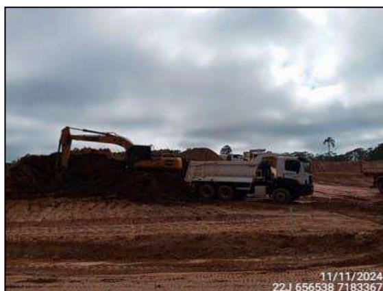
FIGURA 46: ESCAVAÇÃO PARA RETIRADA DE MATERIAL DESTINADO A ATERRO
