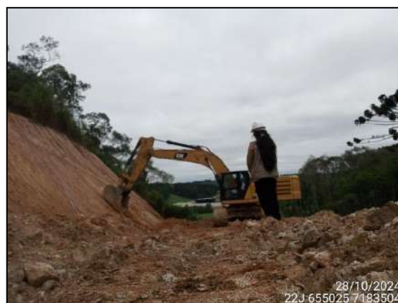
FIGURA 25: ARQUEÓLOGA ACOMPANHANDO ESCAVAÇÃO E MOVIMENTAÇÃO DE SOLO.
