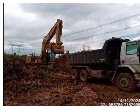
FIGURA 49: MOVIMENTAÇÃO DE ATERRO.
