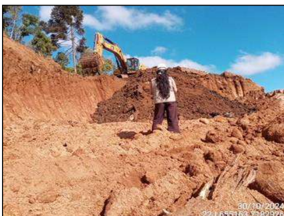
FIGURA 28: ESCAVAÇÃO E MOVIMENTAÇÃO DE SOLO
