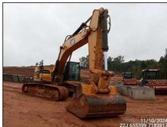
FIGURA 8: MÁQUINAS ESTACIONADAS EM DIA EM QUE AS CONDIÇÕES CLIMÁTICAS NÃO PERMITIRAM A REALIZAÇÃO DE ESCAVAÇÕES.
