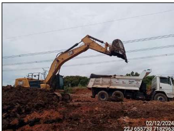
FIGURA 1: ESCAVAÇÃO E MOVIMENTAÇÃO DE SOLO.
