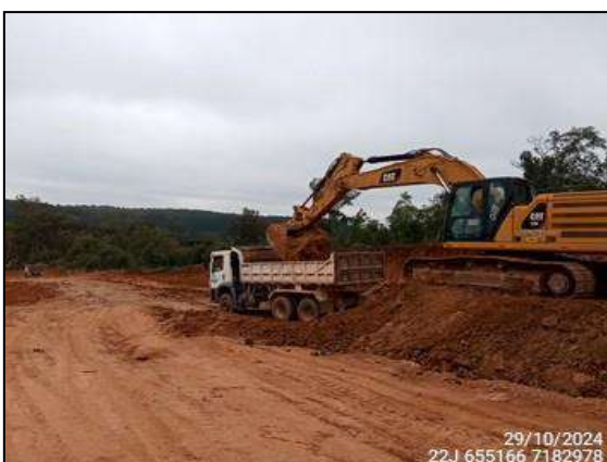
FIGURA 3: ACOMPANHAMENTO DE ATIVIDADES DE ESCAVAÇÃO E MOVIMENTAÇÃO DE SOLO.
