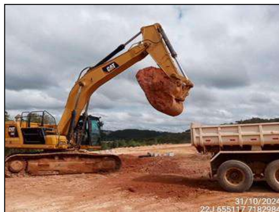
FIGURA 8: ESCAVAÇÃO E MOVIMENTAÇÃO DE SOLO.
