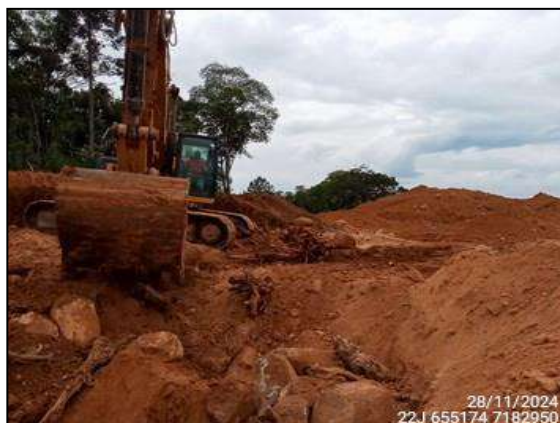
FIGURA 7: ESCAVAÇÃO E MOVIMENTAÇÃO DE SOLO.
