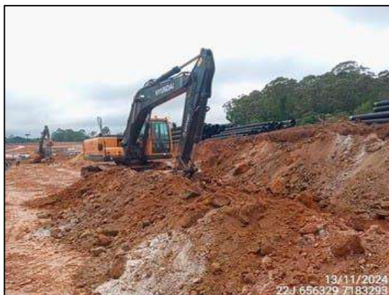
FIGURA 5: ESCAVAÇÃO PARA INSTALAÇÃO DE TUBULAÇÃO.
