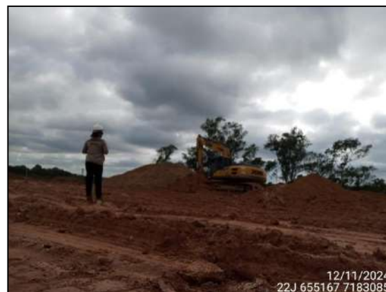
FIGURA 4: ARQUEÓLOGA ACOMPANHANDO ESCAVAÇÃO E MOVIMENTAÇÃO DE SOLO.
