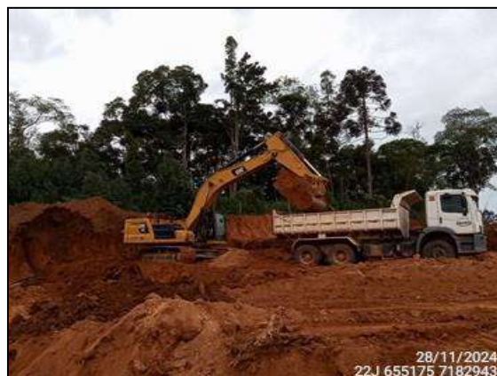
FIGURA 8: ESCAVAÇÃO E MOVIMENTAÇÃO DE SOLO.
