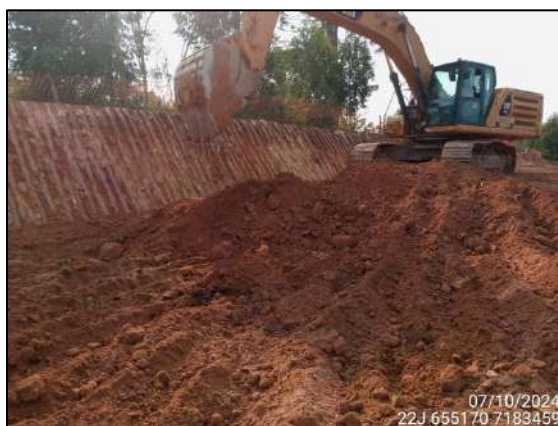
FIGURA 10: ACOMPANHAMENTO DE ESCAVAÇÃO E MOVIMENTAÇÃO DE SOLO.
