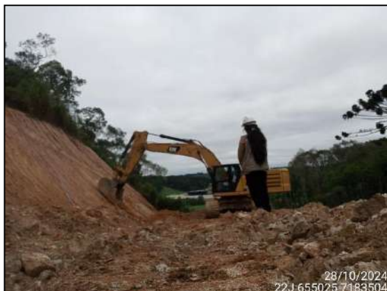
FIGURA 1: ARQUEÓLOGA ACOMPANHANDO ESCAVAÇÃO E MOVIMENTAÇÃO DE SOLO.
