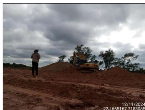
FIGURA 47: ARQUEÓLOGA ACOMPANHANDO ESCAVAÇÃO E MOVIMENTAÇÃO DE SOLO.
