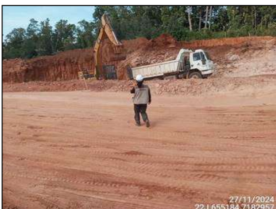
FIGURA 5: ARQUEÓLOGA ACOMPANHANDO ESCAVAÇÃO E MOVIMENTAÇÃO DE SOLO.
