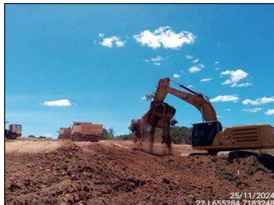
FIGURA 2: ESCAVAÇÃO E MOVIMENTAÇÃO DE SOLO.
