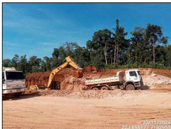
FIGURA 56: ESCAVAÇÃO E MOVIMENTAÇÃO DE SOLO.
