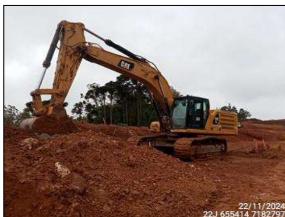
FIGURA 7: ATIVIDADES PARADAS DEVIDO À CHUVA.
