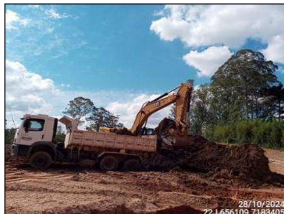
FIGURA 2: ACOMPANHAMENTO DE ATIVIDADES DE ESCAVAÇÃO E MOVIMENTAÇÃO DE SOLO.
