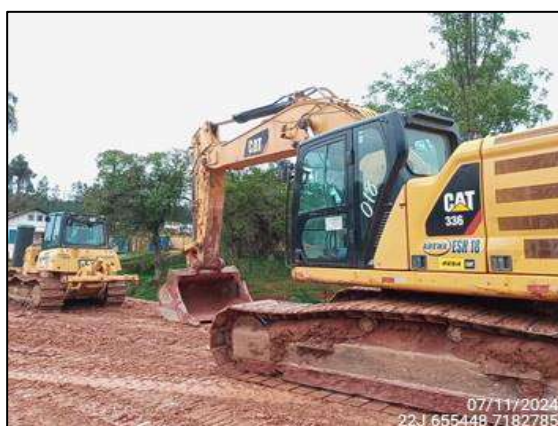
FIGURA 44: ATIVIDADES PARADAS DEVIDO A CHUVA.
