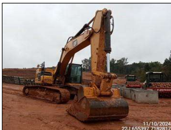
FIGURA 14: MÁQUINAS ESTACIONADAS EM DIA EM QUE AS CONDIÇÕES CLIMÁTICAS NÃO PERMITIRAM A REALIZAÇÃO DE ESCAVAÇÕES.
