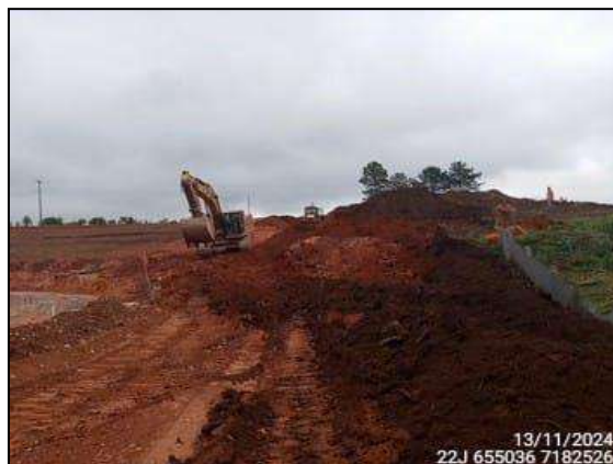
FIGURA 6: ESCAVAÇÃO E MOVIMENTAÇÃO DE SOLO.
