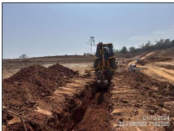
FIGURA 1: ACOMPANHAMENTO DE ESCAVAÇÃO MOVIMENTAÇÃO DE SOLO E ABERTURA DE VALA.
