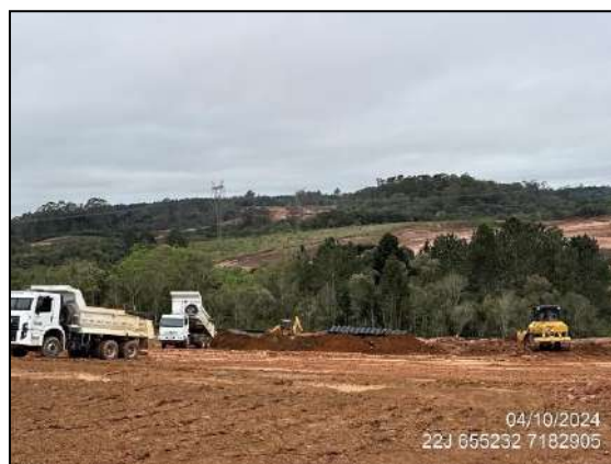
FIGURA 4: ATERRAMENTO E TERRAPLENAGEM.
