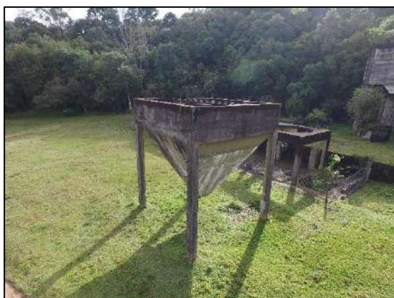
FIGURA 2: ANTIGA ESTRUTURA DOS BRITADORES DA MINA TIMBUTUVA
