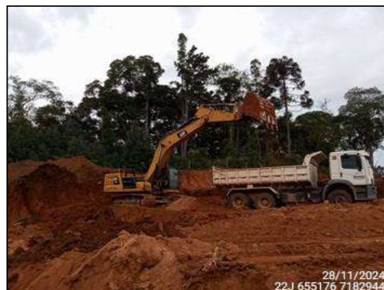
FIGURA 57: ESCAVAÇÃO E MOVIMENTAÇÃO DE SOLO.
