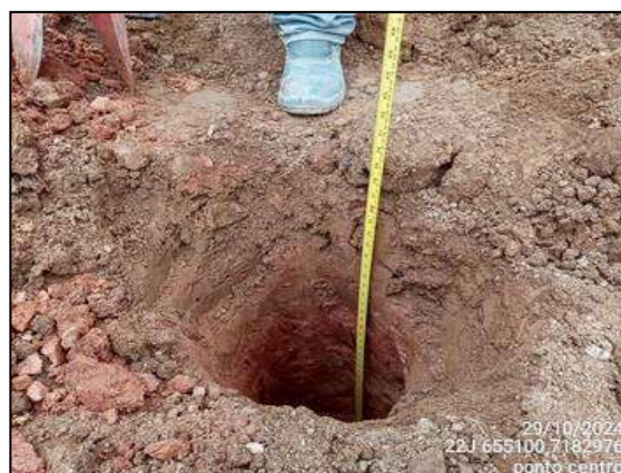
FIGURA 35: SONDAGEM POÇO-TESTE CENTRAL.
