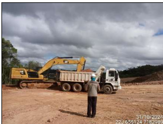
FIGURA 7: ARQUEÓLOGA ACOMPANHANDO ESCAVAÇÃO E MOVIMENTAÇÃO DE SOLO.
