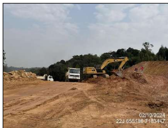
FIGURA 7: ATIVIDADES DE ESCAVAÇÃO E MOVIMENTAÇÃO DE SOLO.
