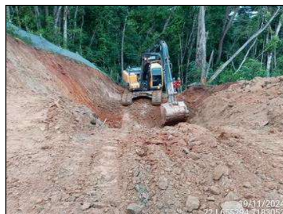
FIGURA 4: ESCAVAÇÃO PARA INSTALAÇÃO DE TUBULAÇÃO E ESCAPE DA ÁGUA.
