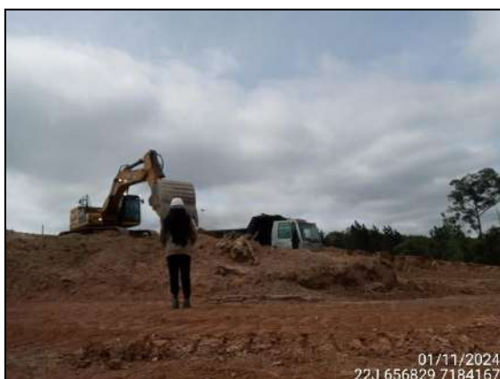
FIGURA 11: ARQUEÓLOGA ACOMPANHANDO ESCAVAÇÃO E MOVIMENTAÇÃO DE SOLO.
