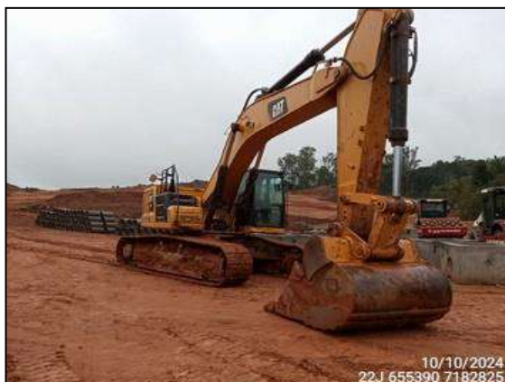
FIGURA 7: MÁQUINAS ESTACIONADAS EM DIA EM QUE AS CONDIÇÕES CLIMÁTICAS NÃO PERMITIRAM A REALIZAÇÃO DE ESCAVAÇÕES.
