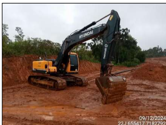
FIGURA 1: ESCAVAÇÃO E MOVIMENTAÇÃO DE SOLO.
