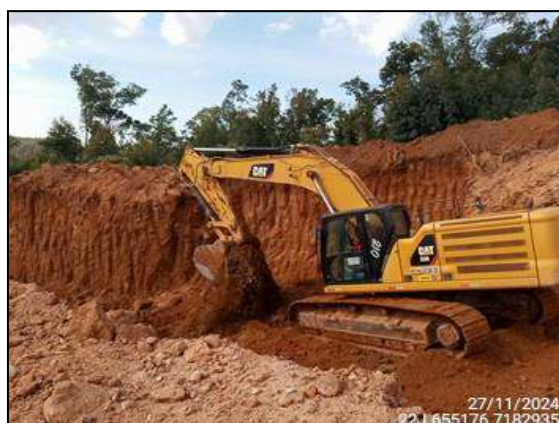
FIGURA 6: ESCAVAÇÃO E MOVIMENTAÇÃO DE SOLO.
