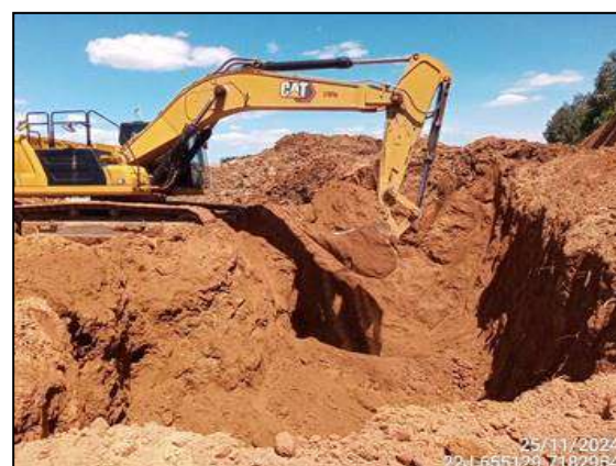
FIGURA 54: ESCAVAÇÃO PARA RETIRADA DE ATERRO.
