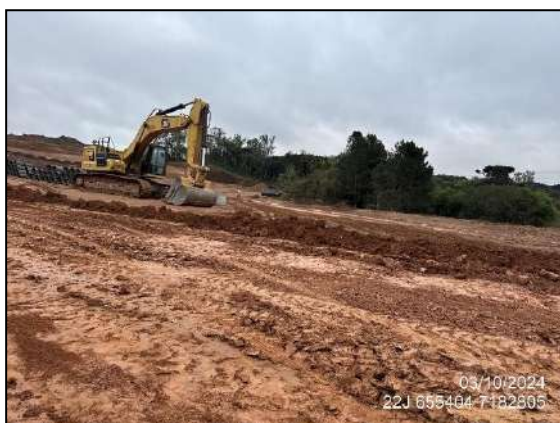
FIGURA 3: ATIVIDADES PARADAS DEVIDO A CHUVA
