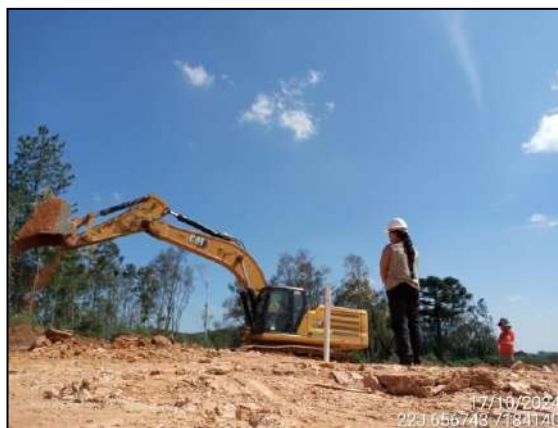
FIGURA 7: ARQUEÓLOGA ACOMPANHANDO ESCAVAÇÃO E MOVIMENTAÇÃO DE SOLO.
