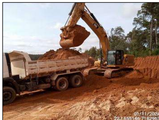
FIGURA 12: ESCAVAÇÃO E MOVIMENTAÇÃO DE SOLO.
