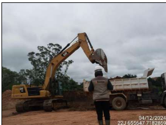
FIGURA 69: ARQUEÓLOGA ACOMPANHANDO ESCAVAÇÃO E MOVIMENTAÇÃO DE SOLO.
