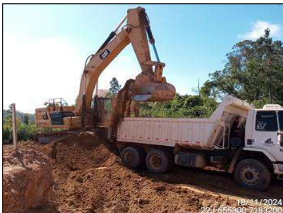
FIGURA 1: ESCAVAÇÃO E MOVIMENTAÇÃO DE SOLO.
