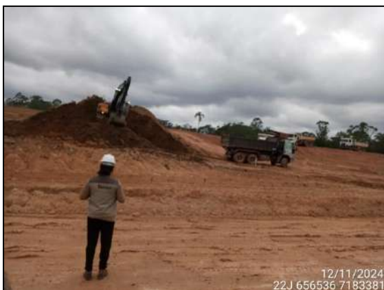
FIGURA 3: ARQUEÓLOGA ACOMPANHANDO ESCAVAÇÃO E MOVIMENTAÇÃO DE SOLO.
