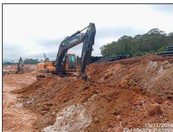
FIGURA 48: ESCAVAÇÃO PARA RETIRADA DE ATERRO
