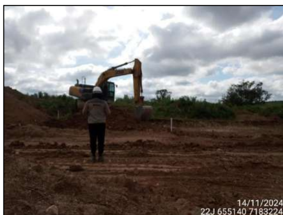
FIGURA 7: ARQUEÓLOGA ACOMPANHANDO ESCAVAÇÃO E MOVIMENTAÇÃO DE SOLO.
