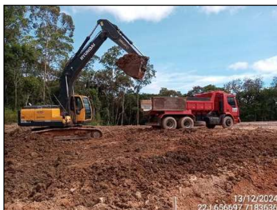
FIGURA 6: ACOMPANHAMENTO ESCAVAÇÃO E MOVIMENTAÇÃO DE SOLO.
