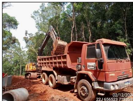
FIGURA 2: ESCAVAÇÃO PARA INSTALAÇÃO DE ESCAPE DE ESGOTO.
