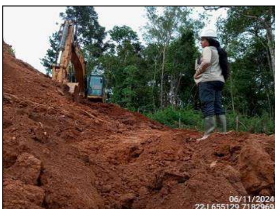
FIGURA 3: ARQUEÓLOGA ACOMPANHANDO ESCAVAÇÃO E MOVIMENTAÇÃO DE SOLO.
