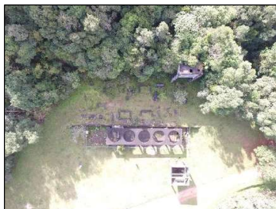
FIGURA 3: ESTRUTURA DA ANTIGA MINA TIMBUTUVA
