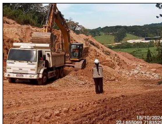
FIGURA 19: ARQUEÓLOGA ACOMPANHANDO ESCAVAÇÃO E MOVIMENTAÇÃO DE SOLO.
