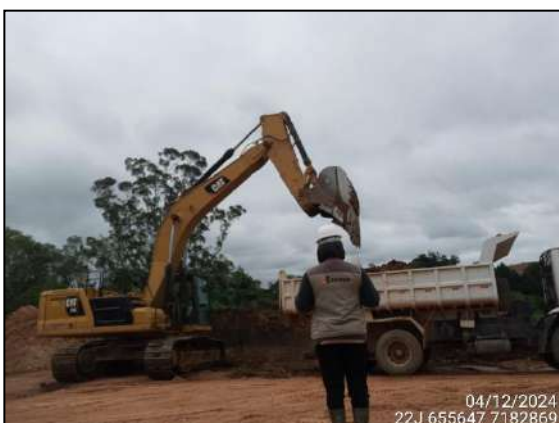
FIGURA 5: ARQUEÓLOGA ACOMPANHANDO ESCAVAÇÃO E MOVIMENTAÇÃO DE SOLO.
