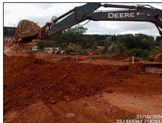
FIGURA 2: ESCAVAÇÃO E MOVIMENTAÇÃO DE SOLO.
