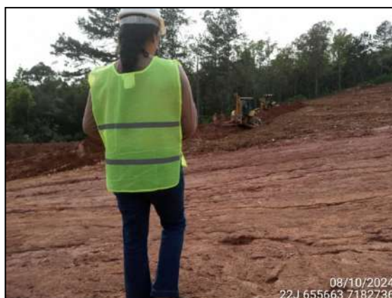
FIGURA 4: ARQUEÓLOGA ACOMPANHANDO ESCAVAÇÃO E MOVIMENTAÇÃO DE SOLO.
