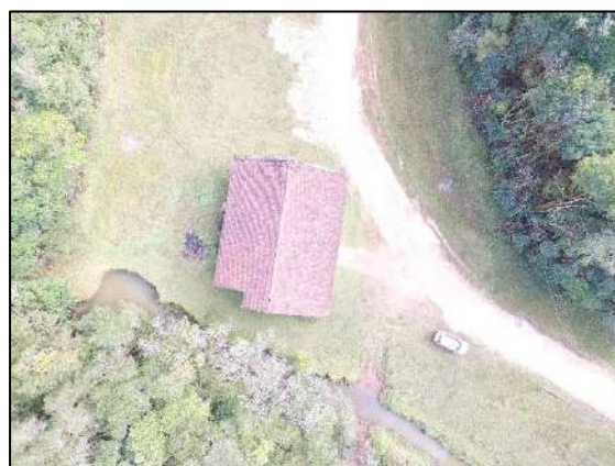
FIGURA 5: BARRACÃO DA ANTIGA MINA TIMBUTUVA
