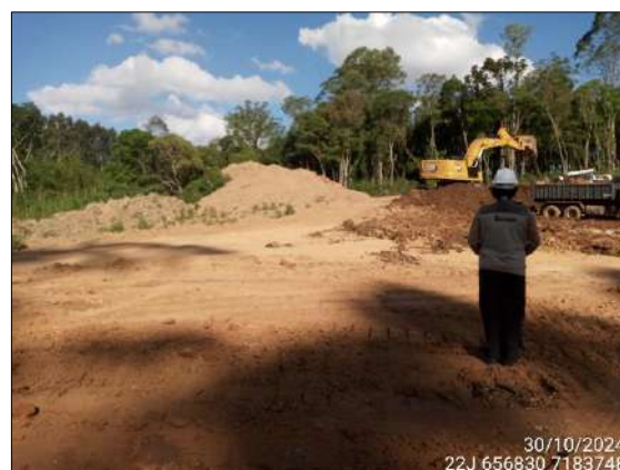
FIGURA 27: ACOMPANHAMENTO DE ATIVIDADES DE ESCAVAÇÃO E MOVIMENTAÇÃO DE SOLO.
