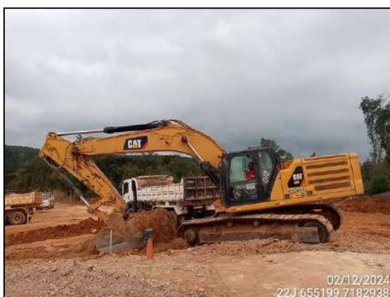
FIGURA 67: ACOMPANHAMENTO DE ESCAVAÇÃO PARA ALINHAMENTO DA RUA.
