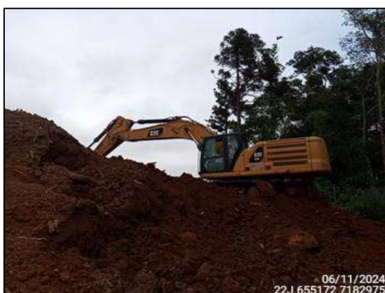
FIGURA 4: ESCAVAÇÃO E MOVIMENTAÇÃO DE SOLO.
