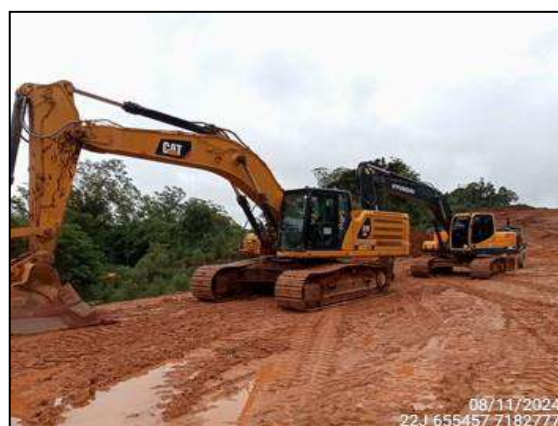
FIGURA 45: ATIVIDADES PARADAS DEVIDO A CHUVA.
