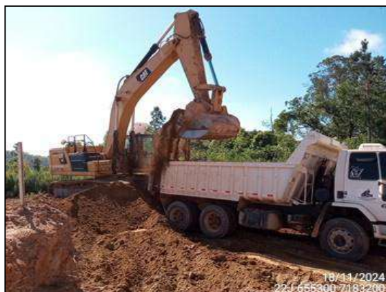
FIGURA 50: ESCAVAÇÃO E MOVIMENTAÇÃO DE SOLO PARA ABERTURA DE LOTES E VIA NO LOTEAMENTO.
