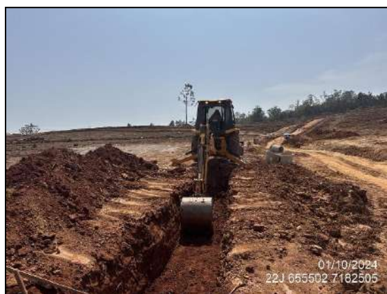
FIGURA 6: ACOMPANHAMENTO DE ESCAVAÇÃO, MOVIMENTAÇÃO DE SOLO E ABERTURA DE VALA.
