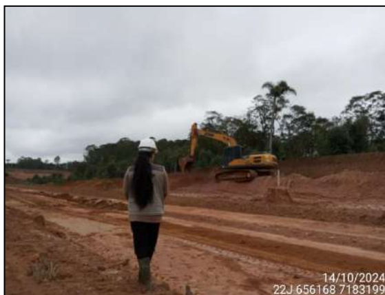
FIGURA 1: MONITORAMENTO DE ATIVIDADE DE ESCAVAÇÃO E MOVIMENTAÇÃO DE SOLO.
