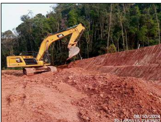
FIGURA 3: ESCAVAÇÃO E MOVIMENTAÇÃO DE SOLO.
