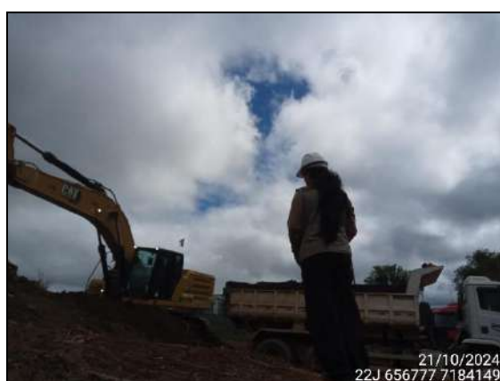
FIGURA 20: ARQUEÓLOGA ACOMPANHANDO ESCAVAÇÃO E MOVIMENTAÇÃO DE SOLO.
