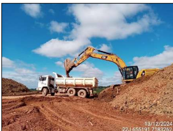
FIGURA 5: ACOMPANHAMENTO ESCAVAÇÃO E MOVIMENTAÇÃO DE SOLO.
