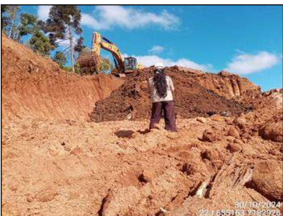
FIGURA 5: ESCAVAÇÃO E MOVIMENTAÇÃO DE SOLO.
