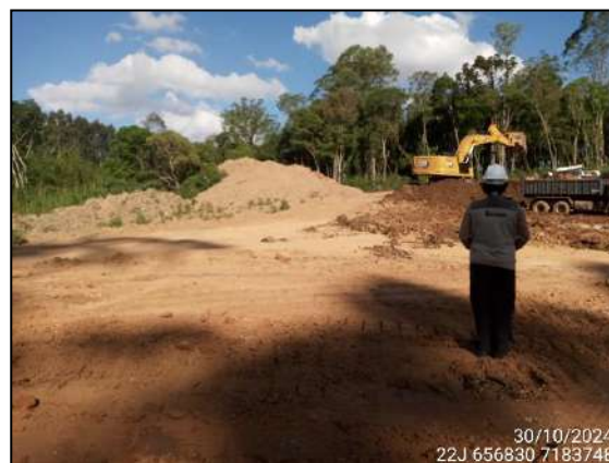
FIGURA 6: ARQUEÓLOGA ACOMPANHANDO ESCAVAÇÃO E MOVIMENTAÇÃO DE SOLO.
