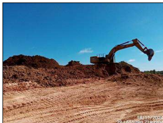
FIGURA 2: ESCAVAÇÃO E MOVIMENTAÇÃO DE SOLO.
