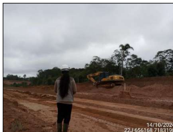
FIGURA 15: MONITORAMENTO DE ATIVIDADE DE ESCAVAÇÃO E MOVIMENTAÇÃO DE SOLO.
