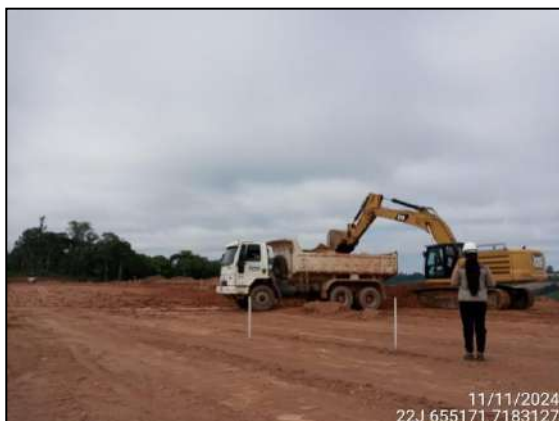
FIGURA 1: ARQUEÓLOGA ACOMPANHANDO ESCAVAÇÃO E MOVIMENTAÇÃO DE SOLO.
