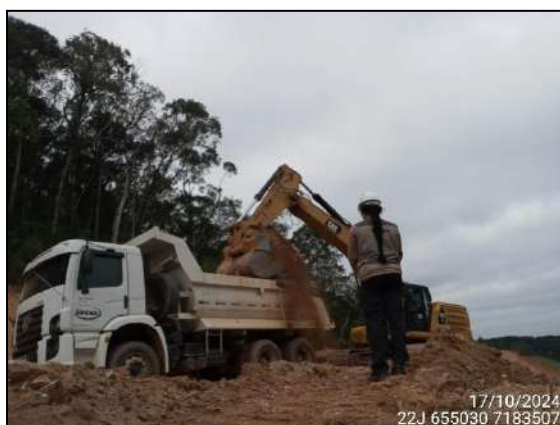
FIGURA 18: ARQUEÓLOGA ACOMPANHANDO ESCAVAÇÃO E MOVIMENTAÇÃO DE SOLO.
