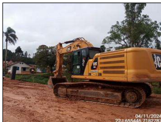
FIGURA 41: ATIVIDADES PARADAS DEVIDO A CHUVA.
