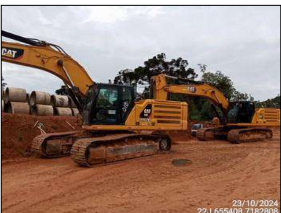
FIGURA 5: MONITORAMENTO DE ATIVIDADE DE ESCAVAÇÃO E MOVIMENTAÇÃO DE SOLO.
