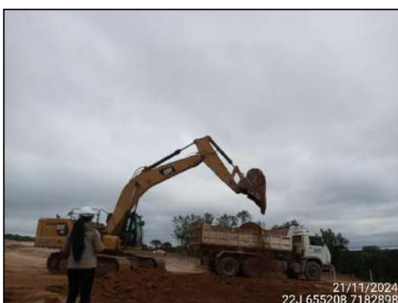
FIGURA 5: ARQUEÓLOGA ACOMPANHANDO ESCAVAÇÃO E MOVIMENTAÇÃO DE SOLO.
