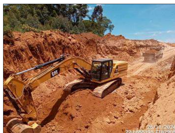
FIGURA 55: ESCAVAÇÃO PARA RETIRADA DE ATERRO.
