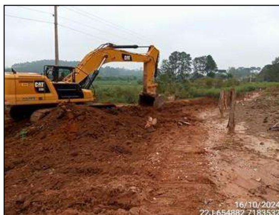
FIGURA 6: ESCAVAÇÃO E MOVIMENTAÇÃO DE SOLO.
