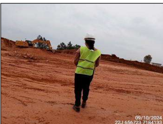
FIGURA 5: ARQUEÓLOGA ACOMPANHANDO ESCAVAÇÃO E MOVIMENTAÇÃO DE SOLO.
