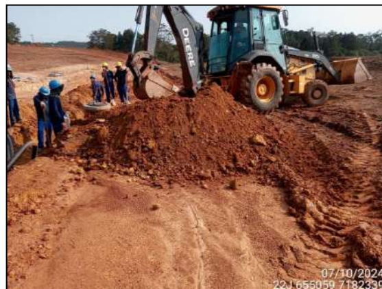
FIGURA 2: ESCAVAÇÃO E MOVIMENTAÇÃO DE SOLO.
