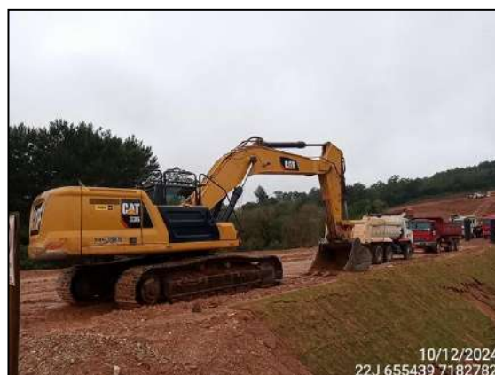
FIGURA 2: ESCAVAÇÃO ESCAPE DE ESGOTO.
