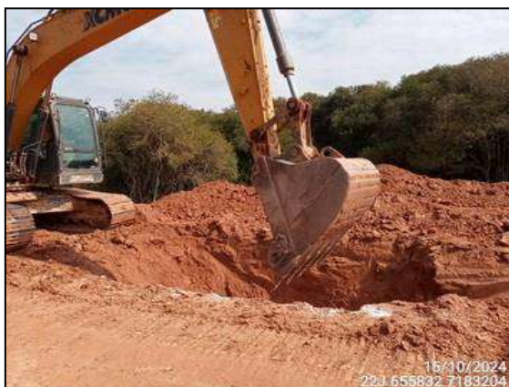
FIGURA 3: ESCAVAÇÃO E MOVIMENTAÇÃO DE SOLO.
