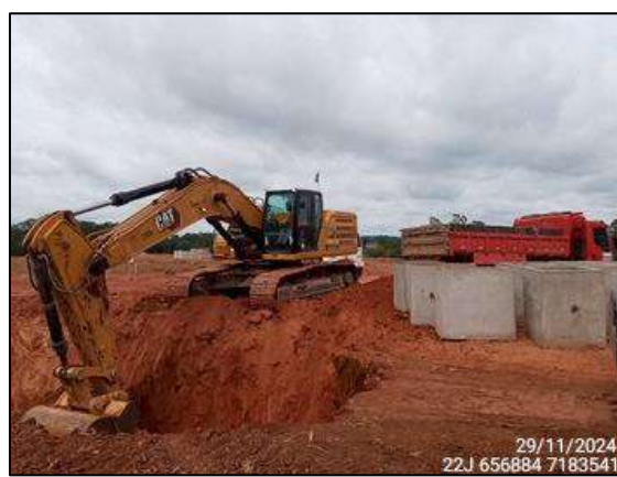
FIGURA 10: ESCAVAÇÃO E MOVIMENTAÇÃO DE SOLO.
