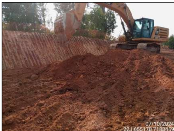
FIGURA 1: ACOMPANHAMENTO DE ESCAVAÇÃO E MOVIMENTAÇÃO DE SOLO.
