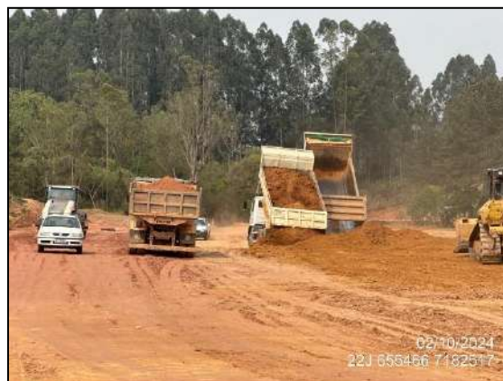
FIGURA 2: ATERRAMENTO E TERRAPLENAGEM.
