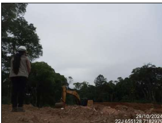
FIGURA 26: MONITORAMENTO DE ATIVIDADE DE MOVIMENTAÇÃO DE SOLO.
