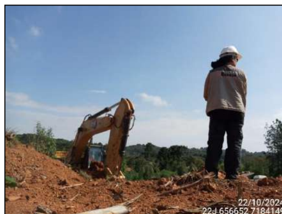
FIGURA 4: ARQUEÓLOGA ACOMPANHANDO ESCAVAÇÃO E MOVIMENTAÇÃO DE SOLO.
