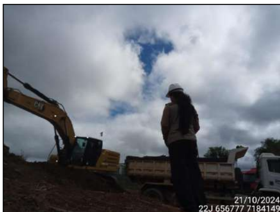
FIGURA 1: ARQUEÓLOGA ACOMPANHANDO ESCAVAÇÃO E MOVIMENTAÇÃO DE SOLO.
