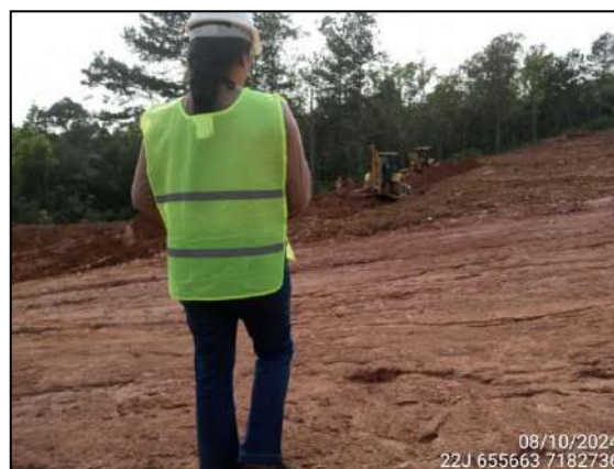
FIGURA 11: ARQUEÓLOGA ACOMPANHANDO ESCAVAÇÃO E MOVIMENTAÇÃO DE SOLO.
