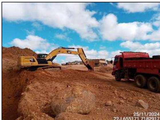
FIGURA 1: ESCAVAÇÃO E MOVIMENTAÇÃO DE SOLO.
