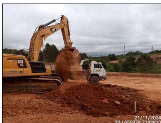
FIGURA 6: ESCAVAÇÃO E MOVIMENTAÇÃO DE SOLO.
