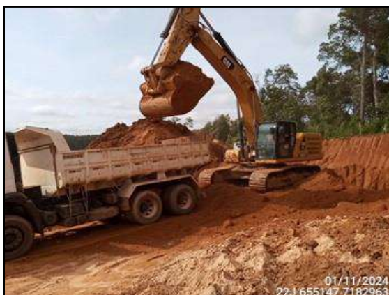
FIGURA 40: ACOMPANHAMENTO DE ESCAVAÇÃO PARA ABERTURA DE VALA.
