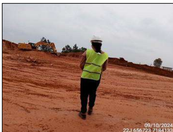
FIGURA 12: ARQUEÓLOGA ACOMPANHANDO ESCAVAÇÃO E MOVIMENTAÇÃO DE SOLO.
