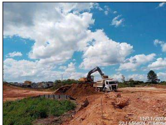
FIGURA 2: ESCAVAÇÃO E MOVIMENTAÇÃO DE SOLO.
