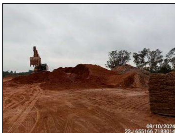
FIGURA 6: ESCAVAÇÃO E MOVIMENTAÇÃO DE SOLO.
