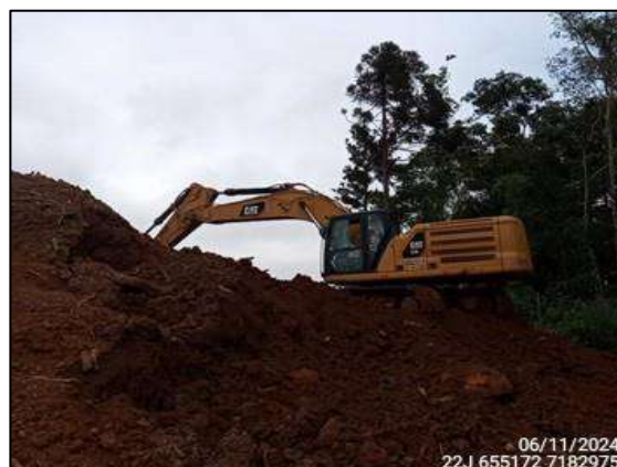
FIGURA 43: ACOMPANHAMENTO DE ESCAVAÇÃO E MOVIMENTAÇÃO DE SOLO.
