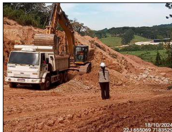
FIGURA 8: MONITORAMENTO DE ATIVIDADE DE ESCAVAÇÃO E MOVIMENTAÇÃO DE SOLO.
