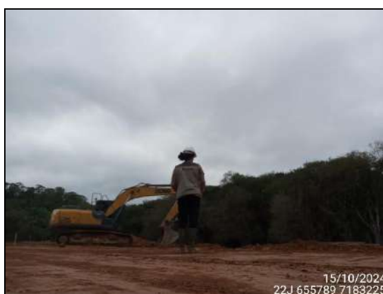
FIGURA 16: ARQUEÓLOGA ACOMPANHANDO ESCAVAÇÃO E MOVIMENTAÇÃO DE SOLO.
