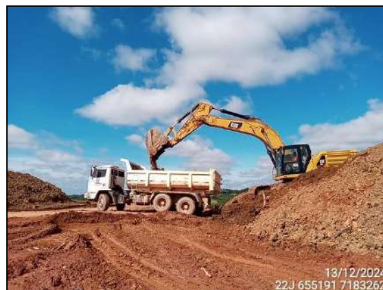
FIGURA 76: ESCAVAÇÃO E MOVIMENTAÇÃO DE SOLO.
