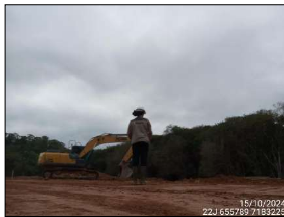
FIGURA 4: ARQUEÓLOGA ACOMPANHANDO ESCAVAÇÃO E MOVIMENTAÇÃO DE SOLO.
