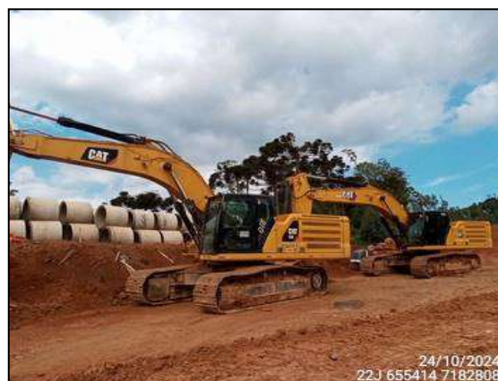
FIGURA 23: MONITORAMENTO DE ATIVIDADE DE ESCAVAÇÃO E MOVIMENTAÇÃO DE SOLO.
