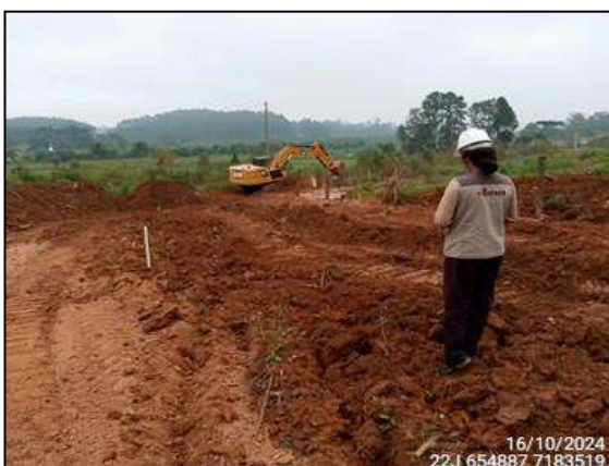
FIGURA 5: ARQUEÓLOGA ACOMPANHANDO ESCAVAÇÃO E MOVIMENTAÇÃO DE SOLO.
