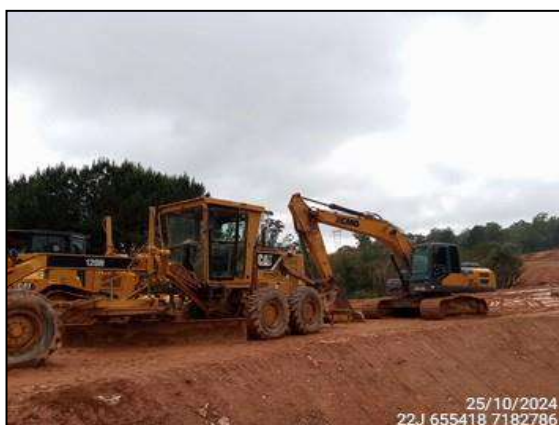
FIGURA 7: ATIVIDADES PARADAS DEVIDO A CHUVA.
