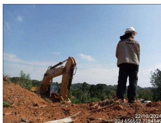
FIGURA 21: ARQUEÓLOGA ACOMPANHANDO ESCAVAÇÃO E MOVIMENTAÇÃO DE SOLO.
