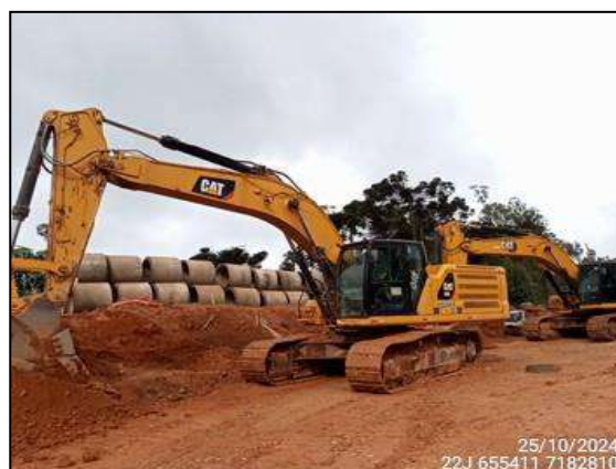
FIGURA 8: ARQUEÓLOGA ACOMPANHANDO ESCAVAÇÃO E MOVIMENTAÇÃO DE SOLO.
