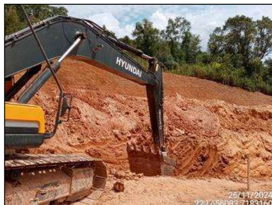
FIGURA 4: ESCAVAÇÃO E MOVIMENTAÇÃO DE SOLO.
