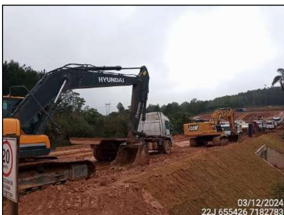
FIGURA 3: ATIVIDADES PARADAS DEVIDO A CHUVA.
