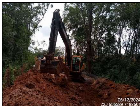
FIGURA 71: ESCAVAÇÃO E MOVIMENTAÇÃO DE SOLO.
