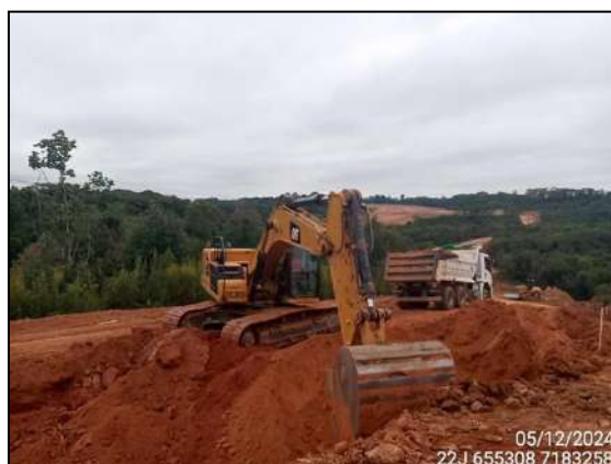
FIGURA 6: ESCAVAÇÃO E MOVIMENTAÇÃO DE SOLO.
