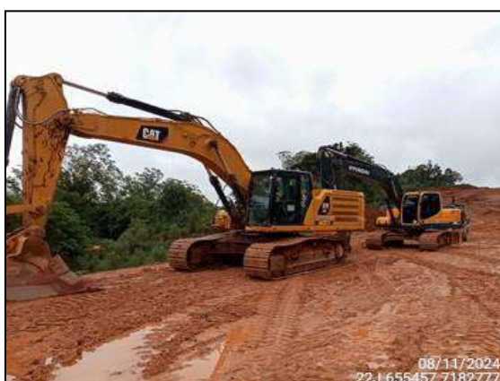
FIGURA 6: ATIVIDADES PARADAS DEVIDO A CHUVA.
