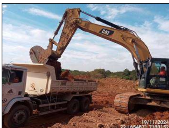
FIGURA 3: ESCAVAÇÃO E MOVIMENTAÇÃO DE SOLO.
