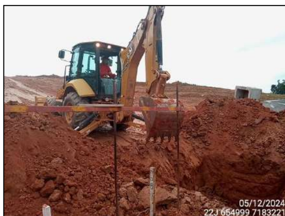
FIGURA 7: ATIVIDADES DE ESCAVAÇÃO PARA INSTALAÇÃO DA REDE HÍDRICA.
