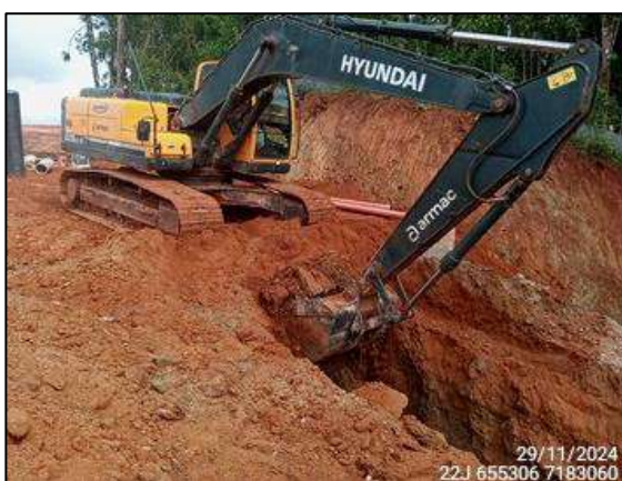
FIGURA 9: ESCAVAÇÃO DE TUBULAÇÃO PARA ESGOTO.
