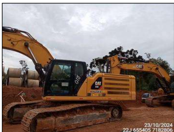
FIGURA 22: MONITORAMENTO DE ATIVIDADE DE ESCAVAÇÃO E MOVIMENTAÇÃO DE SOLO.
