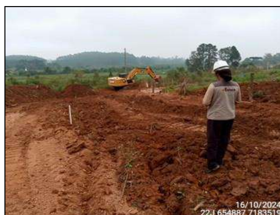
FIGURA 17: ARQUEÓLOGA ACOMPANHANDO ESCAVAÇÃO E MOVIMENTAÇÃO DE SOLO.
