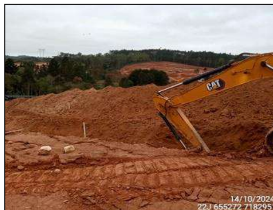
FIGURA 2: ESCAVAÇÃO E MOVIMENTAÇÃO DE SOLO.
