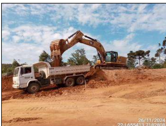
FIGURA 3: ESCAVAÇÃO E MOVIMENTAÇÃO DE SOLO.
