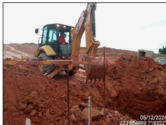
FIGURA 70: ESCAVAÇÃO PARA INSTALAÇÃO DE TUBULAÇÃO E ESCAPE DE REDE HÍDRICA
