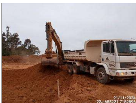
FIGURA 52: ESCAVAÇÃO E MOVIMENTAÇÃO DE SOLO PARA ABERTURA DE LOTES E VIA NO LOTEAMENTO.
