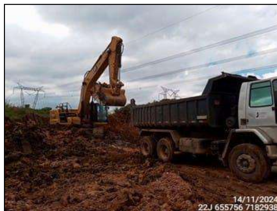
FIGURA 8: ACOMPANHANDO ESCAVAÇÃO E MOVIMENTAÇÃO DE SOLO.
