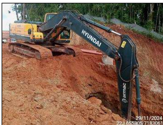
FIGURA 58: ESCAVAÇÃO PARA INSTALAÇÃO DE TUBULAÇÃO DE ESGOTO.
