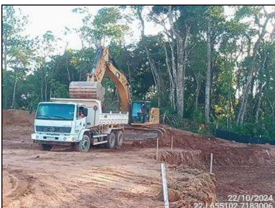
FIGURA 3: ESCAVAÇÃO E MOVIMENTAÇÃO DE SOLO.
