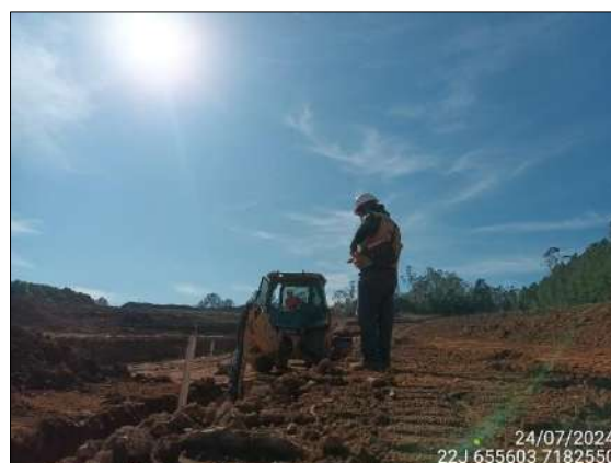
FIGURA 31: ARQUEÓLOGO ACOMPANHANDO ESCAVAÇÃO E MOVIMENTAÇÃO DE SOLO.
