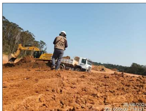
FIGURA 77: ARQUEÓLOGO ACOMPANHANDO ESCAVAÇÃO E MOVIMENTAÇÃO DE SOLO.
