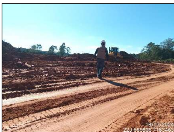
FIGURA 24: ARQUEÓLOGO ACOMPANHANDO TERRAPLANAGEM.
