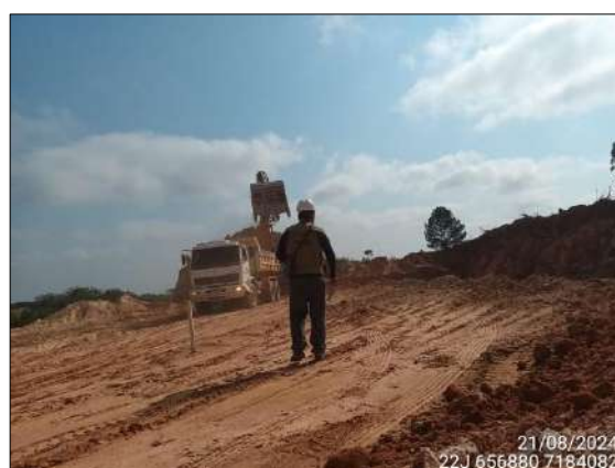
FIGURA 67: ARQUEÓLOGO ACOMPANHANDO ESCAVAÇÃO E MOVIMENTAÇÃO DE SOLO.
