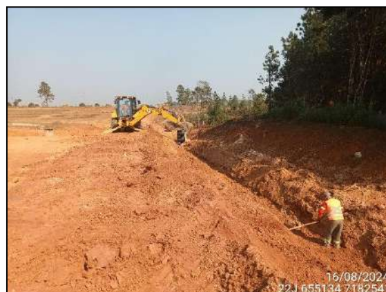
FIGURA 8: ESCAVAÇÃO E MOVIMENTAÇÃO DE SOLO.
