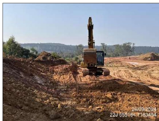
FIGURA 104: ESCAVAÇÃO E MOVIMENTAÇÃO DE SOLO.
