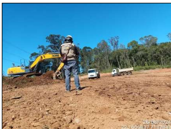
FIGURA 72: ARQUEÓLOGO ACOMPANHANDO ESCAVAÇÃO E MOVIMENTAÇÃO DE SOLO.
