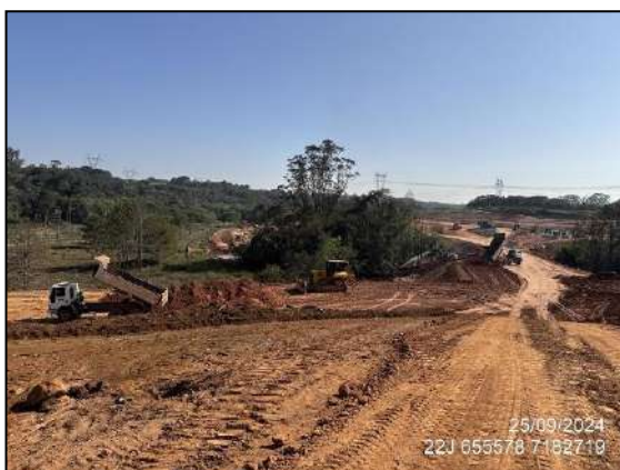
FIGURA 3: ATERRAMENTO E TERRAPLENAGEM.
