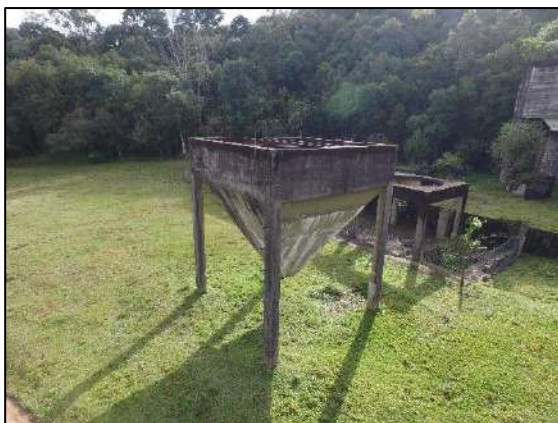
FIGURA 2: ANTIGA ESTRUTURA DOS BRITADORES DA MINA TIMBUTUVA
