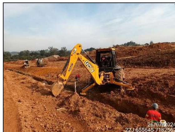
FIGURA 6: ESCAVAÇÃO E MOVIMENTAÇÃO DE SOLO.
