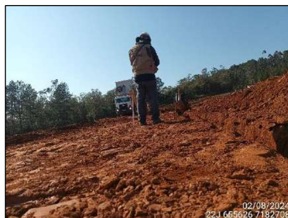
FIGURA 43: ARQUEÓLOGO ACOMPANHANDO ESCAVAÇÃO E MOVIMENTAÇÃO DE SOLO.
