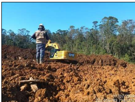
FIGURA 22: ARQUEÓLOGO ACOMPANHANDO ESCAVAÇÃO E MOVIMENTAÇÃO DE SOLO.
