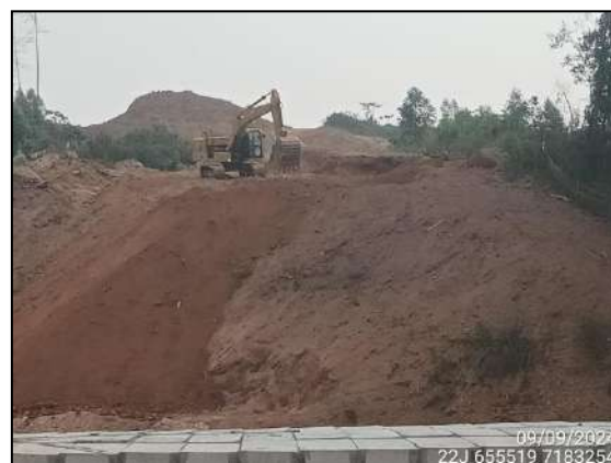
FIGURA 92: ESCAVAÇÃO E MOVIMENTAÇÃO DE SOLO.
