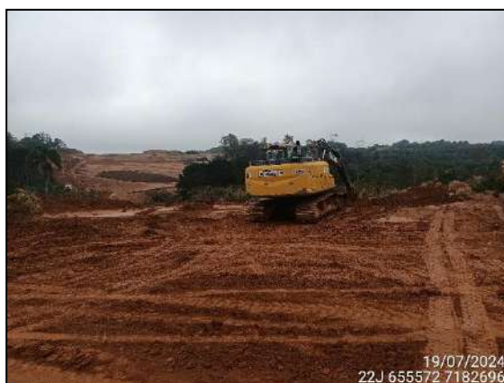
FIGURA 5: ESCAVAÇÃO E MOVIMENTAÇÃO DE SOLO.
