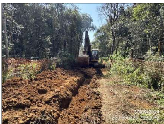
FIGURA 107: ABERTURA DE VALA.
