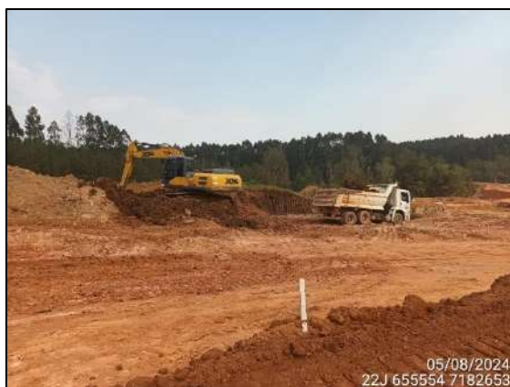
FIGURA 44: ESCAVAÇÃO E MOVIMENTAÇÃO DE SOLO.
