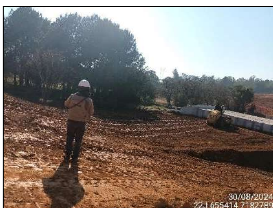
FIGURA 80: ARQUEÓLOGO ACOMPANHANDO TERRAPLANAGEM.
