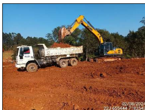
FIGURA 10: ESCAVAÇÃO E MOVIMENTAÇÃO DE SOLO.
