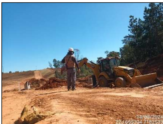
FIGURA 58: ARQUEÓLOGO ACOMPANHANDO ESCAVAÇÃO E MOVIMENTAÇÃO DE SOLO.
