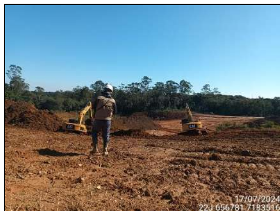
FIGURA 23: ARQUEÓLOGO ACOMPANHANDO ESCAVAÇÃO E MOVIMENTAÇÃO DE SOLO.
