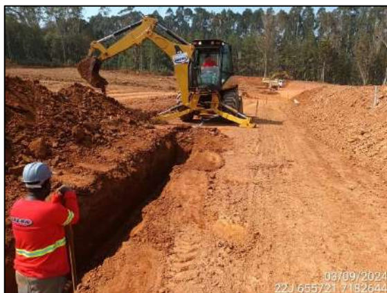
FIGURA 85: ESCAVAÇÃO E MOVIMENTAÇÃO DE SOLO.
