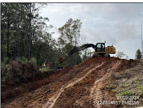
FIGURA 5: ESCAVAÇÃO E MOVIMENTAÇÃO DE SOLO.
