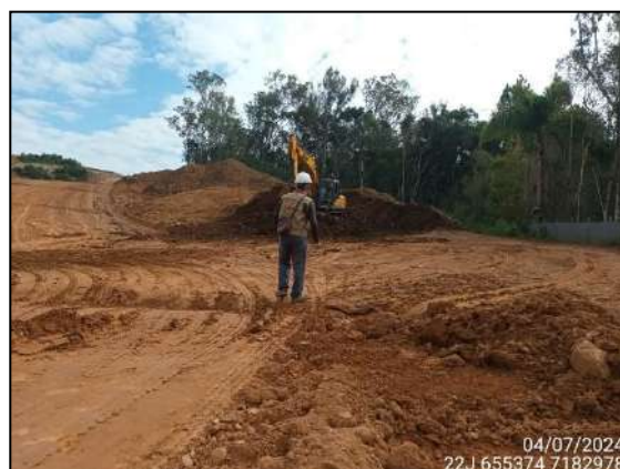
FIGURA 6: ARQUEÓLOGO ACOMPANHANDO ESCAVAÇÃO E MOVIMENTAÇÃO DE SOLO.
