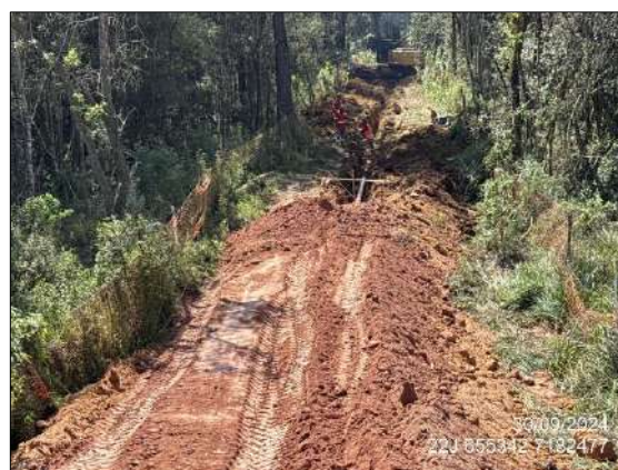
FIGURA 108: ESCAVAÇÃO E MOVIMENTAÇÃO DE SOLO.
