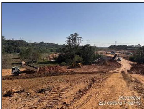
FIGURA 105: ESCAVAÇÃO E MOVIMENTAÇÃO DE SOLO
