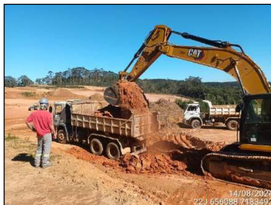
FIGURA 59: ESCAVAÇÃO E MOVIMENTAÇÃO DE SOLO.
