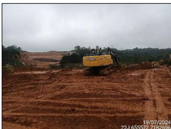
FIGURA 26: ESCAVAÇÃO E MOVIMENTAÇÃO DE SOLO
