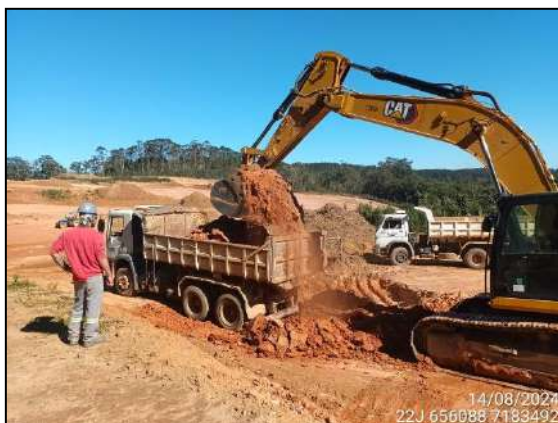
FIGURA 5: ESCAVAÇÃO E MOVIMENTAÇÃO DE SOLO.
