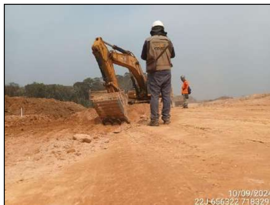
FIGURA 94: ARQUEÓLOGO ACOMPANHANDO ESCAVAÇÃO E MOVIMENTAÇÃO DE SOLO.
