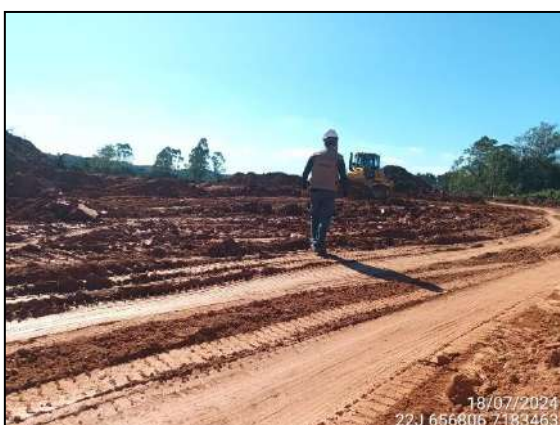
FIGURA 5: ARQUEÓLOGO ACOMPANHANDO TERRAPLANAGEM.
