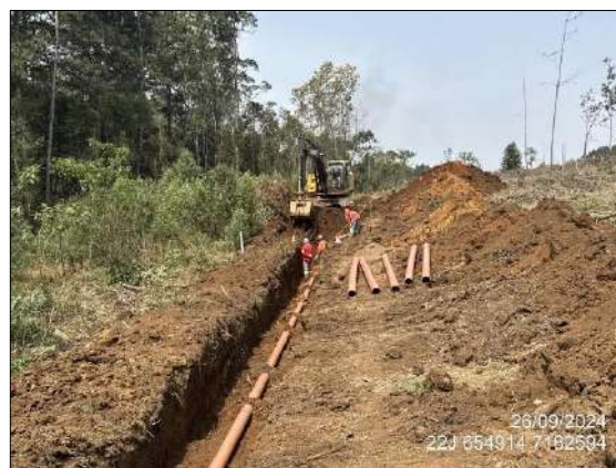
FIGURA 106: ESCAVAÇÃO E MOVIMENTAÇÃO DE SOLO.
