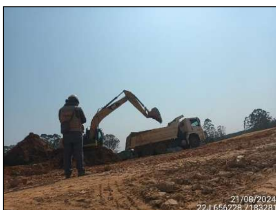
FIGURA 68: ARQUEÓLOGO ACOMPANHANDO ESCAVAÇÃO E MOVIMENTAÇÃO DE SOLO.
