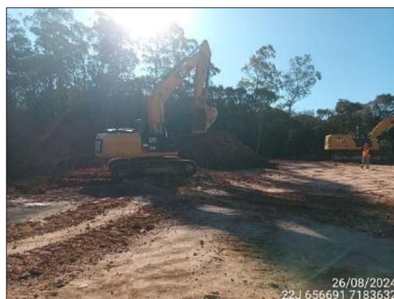
FIGURA 73: ESCAVAÇÃO E MOVIMENTAÇÃO DE SOLO.
