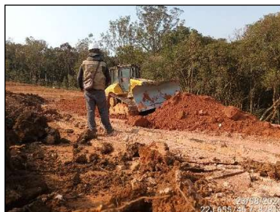
FIGURA 8: ARQUEÓLOGO ACOMPANHANDO TERRAPLANAGEM.
