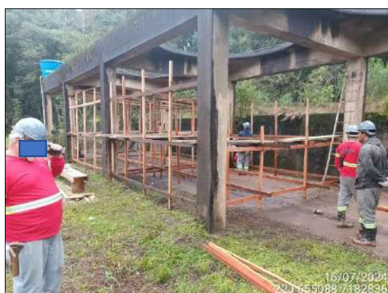
FIGURA 21: LEVANTAMENTO DE ESTRUTURA PARA GUARDAR TUBULAÇÃO.
