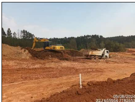
FIGURA 1: ESCAVAÇÃO E MOVIMENTAÇÃO DE SOLO.
