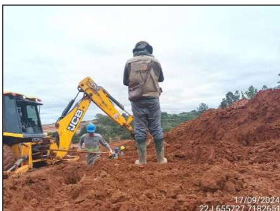
FIGURA 3: ARQUEÓLOGO ACOMPANHANDO ESCAVAÇÃO E MOVIMENTAÇÃO DE SOLO.
