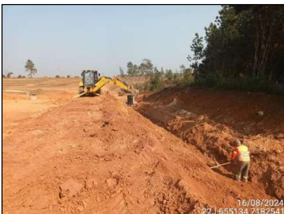
FIGURA 62: ESCAVAÇÃO E MOVIMENTAÇÃO DE SOLO
