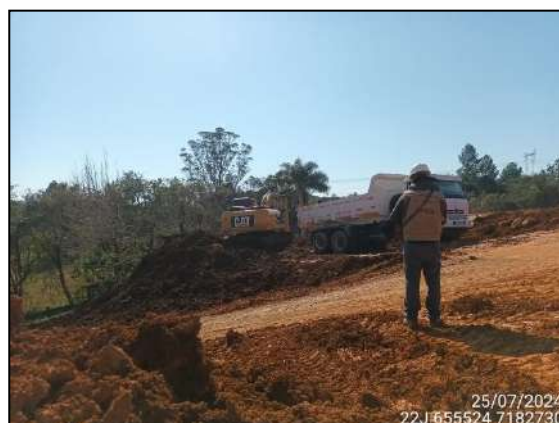
FIGURA 6: ARQUEÓLOGO ACOMPANHANDO ESCAVAÇÃO E MOVIMENTAÇÃO DE SOLO.
