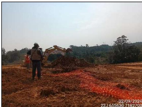
FIGURA 1: ARQUEÓLOGO ACOMPANHANDO ESCAVAÇÃO E MOVIMENTAÇÃO DE SOLO.
