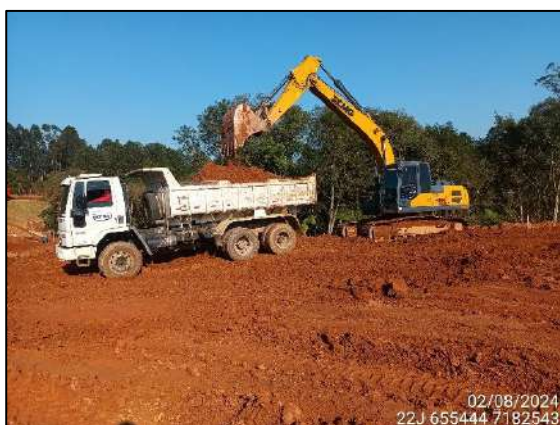
FIGURA 42: ESCAVAÇÃO E MOVIMENTAÇÃO DE SOLO.
