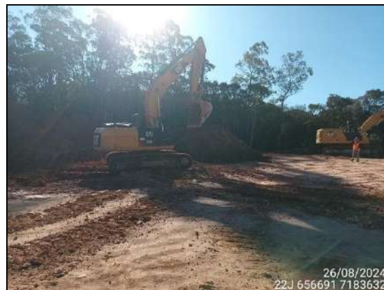
FIGURA 2: ESCAVAÇÃO E MOVIMENTAÇÃO DE SOLO.
