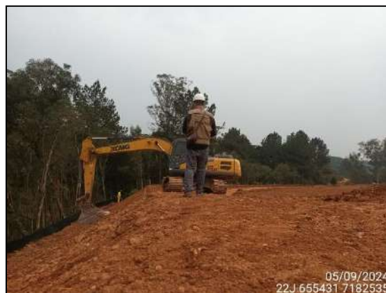
FIGURA 88: ARQUEÓLOGO ACOMPANHANDO ESCAVAÇÃO E MOVIMENTAÇÃO DE SOLO.
