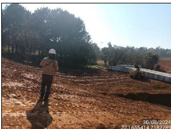
FIGURA 9: ARQUEÓLOGO ACOMPANHANDO TERRAPLANAGEM.
