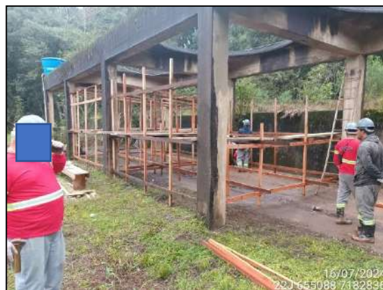
FIGURA 2:CONSTRUÇÃO DE ESTRUTURA.
