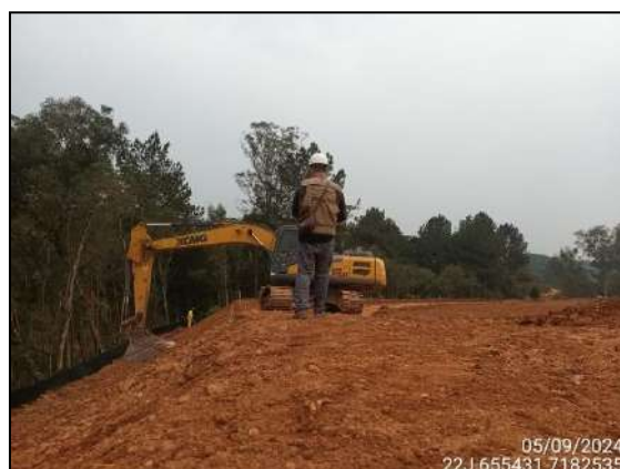
FIGURA 6: ARQUEÓLOGO ACOMPANHANDO ESCAVAÇÃO E MOVIMENTAÇÃO DE SOLO.
