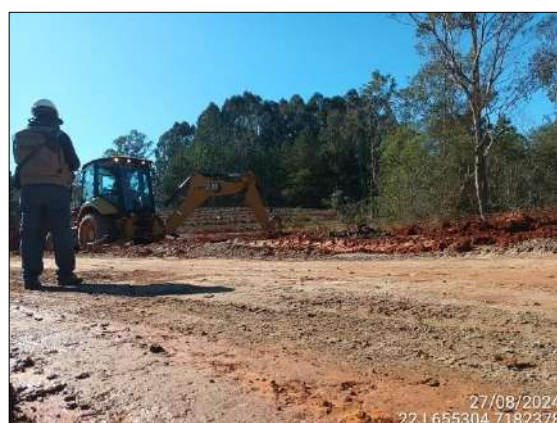
FIGURA 75: ARQUEÓLOGO ACOMPANHANDO ESCAVAÇÃO E MOVIMENTAÇÃO DE SOLO.
