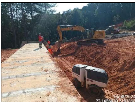
FIGURA 7: ESCAVAÇÃO E MOVIMENTAÇÃO DE SOLO.
