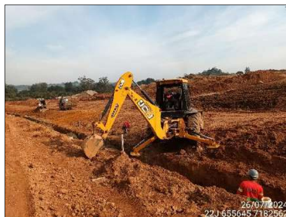
FIGURA 35: ESCAVAÇÃO E MOVIMENTAÇÃO DE SOLO.
