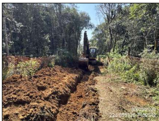
FIGURA 6: ESCAVAÇÃO E MOVIMENTAÇÃO DE SOLO.
