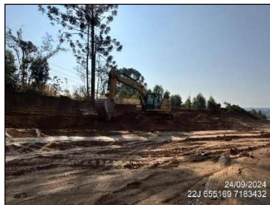
FIGURA 2: ESCAVAÇÃO E MOVIMENTAÇÃO DE SOLO.
