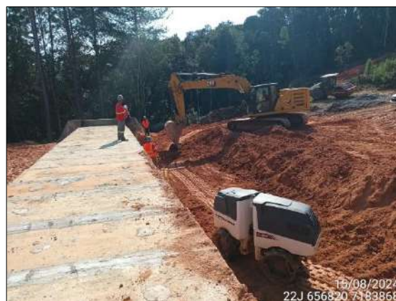
FIGURA 61: ESCAVAÇÃO E MOVIMENTAÇÃO DE SOLO.
