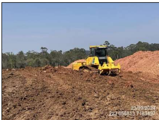
FIGURA 1: ESCAVAÇÃO E MOVIMENTAÇÃO DE SOLO.
