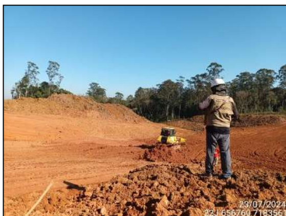
FIGURA 30: ARQUEÓLOGO ACOMPANHANDO TERRAPLANAGEM.
