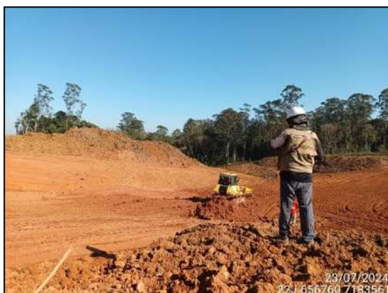
FIGURA 3: ARQUEÓLOGO ACOMPANHANDO TERRAPLANAGEM.
