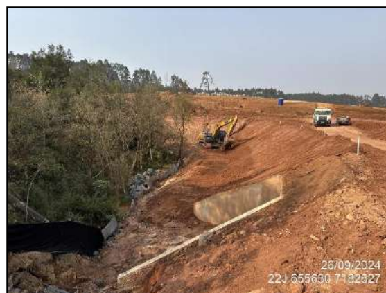
FIGURA 4: ESCAVAÇÃO E MOVIMENTAÇÃO DE SOLO.
