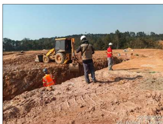
FIGURA 69: ARQUEÓLOGO ACOMPANHANDO ESCAVAÇÃO E MOVIMENTAÇÃO DE SOLO.
