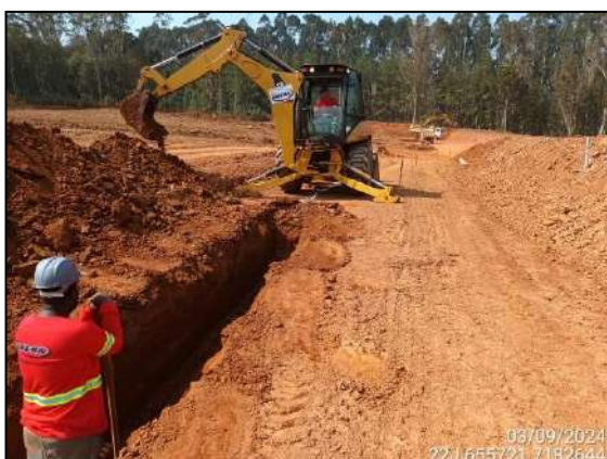
FIGURA 3: ESCAVAÇÃO E MOVIMENTAÇÃO DE SOLO.
