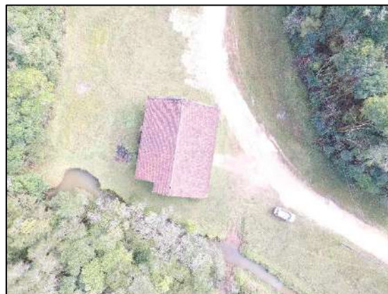
FIGURA 5: BARRACÃO DA ANTIGA MINA TIMBUTUVA
