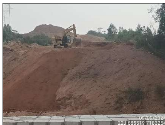
FIGURA 2: ESCAVAÇÃO E MOVIMENTAÇÃO DE SOLO.
