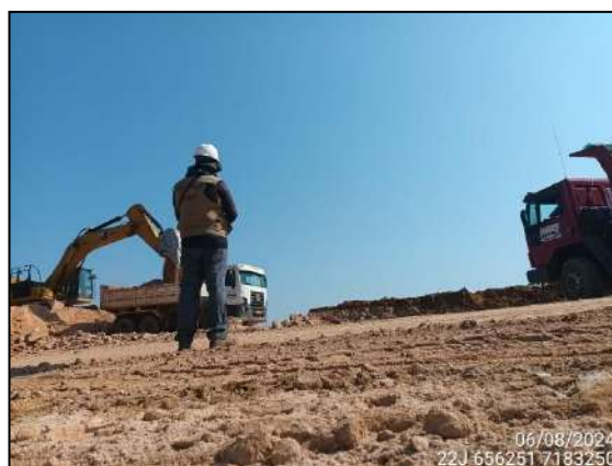
FIGURA 47: ARQUEÓLOGO ACOMPANHANDO ESCAVAÇÃO E MOVIMENTAÇÃO DE SOLO.
