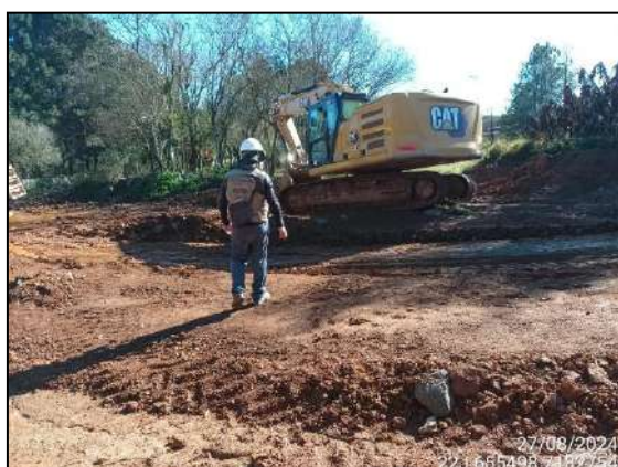
FIGURA 74: ARQUEÓLOGO ACOMPANHANDO ESCAVAÇÃO E MOVIMENTAÇÃO DE SOLO.
