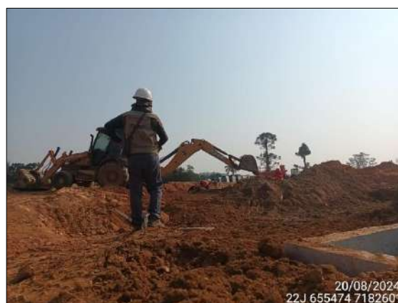
FIGURA 65: ARQUEÓLOGO ACOMPANHANDO ESCAVAÇÃO E MOVIMENTAÇÃO DE SOLO.
