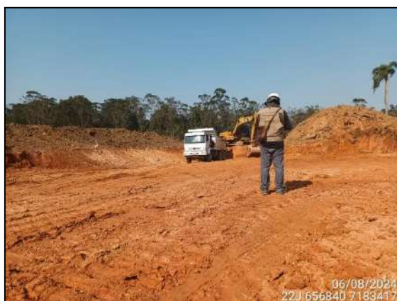
FIGURA 46: ARQUEÓLOGO ACOMPANHANDO ESCAVAÇÃO E MOVIMENTAÇÃO DE SOLO.
