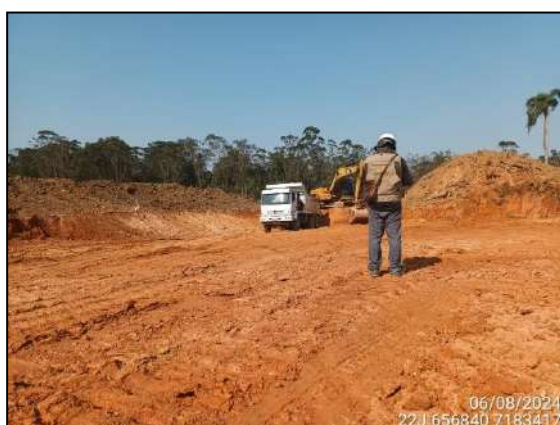
FIGURA 3: ARQUEÓLOGO ACOMPANHANDO ESCAVAÇÃO E MOVIMENTAÇÃO DE SOLO.
