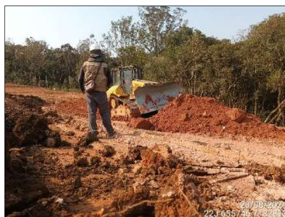
FIGURA 71: ARQUEÓLOGO ACOMPANHANDO TERRAPLANAGEM.
