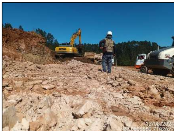
FIGURA 1: ARQUEÓLOGO ACOMPANHANDO ESCAVAÇÃO E MOVIMENTAÇÃO DE SOLO.
