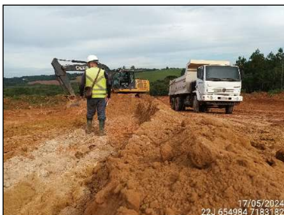
FIGURA 49: ARQUEÓLOGO ACOMPANHANDO ESCAVAÇÃO E MOVIMENTAÇÃO DE SOLO.
