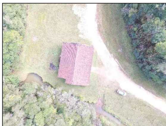
FIGURA 5: BARRACÃO DA ANTIGA MINA TIMBUTUVA
