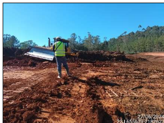
FIGURA 6: ARQUEÓLOGO ACOMPANHANDO TERRAPLANAGEM.
