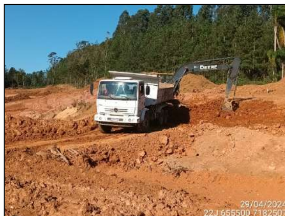
FIGURA 2: ESCAVAÇÃO E MOVIMENTAÇÃO DE SOLO.
