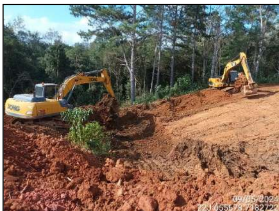
FIGURA 39: ESCAVAÇÃO E MOVIMENTAÇÃO DE SOLO.
