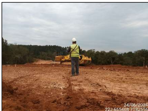
FIGURA 1: ARQUEÓLOGO ACOMPANHANDO TERRAPLANAGEM.
