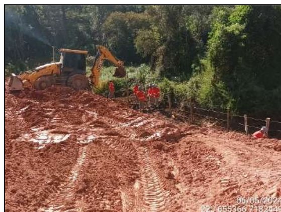
FIGURA 2: COLOCAÇÃO DE TELA EM ÁREA DE APP.
