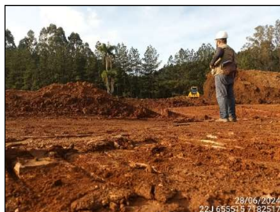
FIGURA 8: ARQUEÓLOGO ACOMPANHANDO TERRAPLANAGEM.
