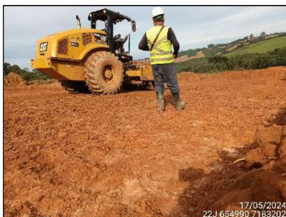
FIGURA 7: ARQUEÓLOGO ACOMPANHANDO TERRAPLANAGEM.
