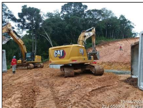
FIGURA 13: ESCAVAÇÃO E MOVIMENTAÇÃO DE SOLO.
