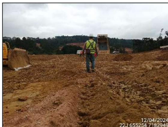
FIGURA 16: ARQUEÓLOGO ACOMPANHANDO TERRAPLANAGEM.
