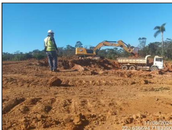
FIGURA 3: ARQUEÓLOGO ACOMPANHANDO ESCAVAÇÃO E MOVIMENTAÇÃO DE SOLO.
