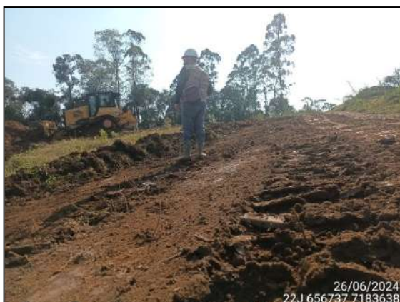
FIGURA 5: ARQUEÓLOGO ACOMPANHANDO TERRAPLANAGEM.
