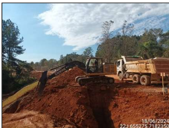
FIGURA 3: ESCAVAÇÃO E MOVIMENTAÇÃO DE SOLO.
