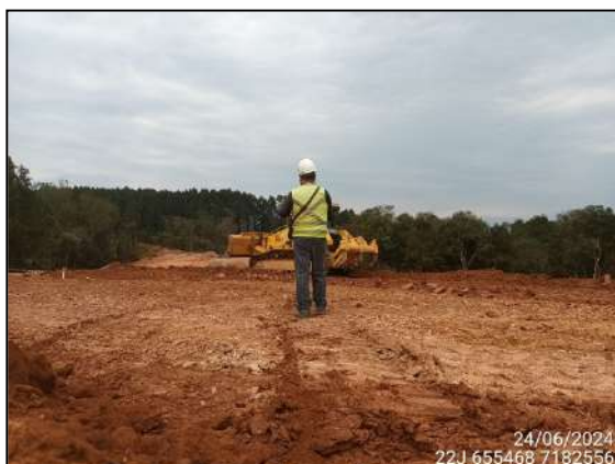
FIGURA 84: ARQUEÓLOGO ACOMPANHANDO TERRAPLANAGEM.
