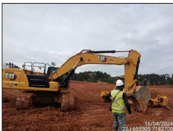
FIGURA 18: ARQUEÓLOGO ACOMPANHANDO ESCAVAÇÃO E MOVIMENTAÇÃO DE SOLO.
