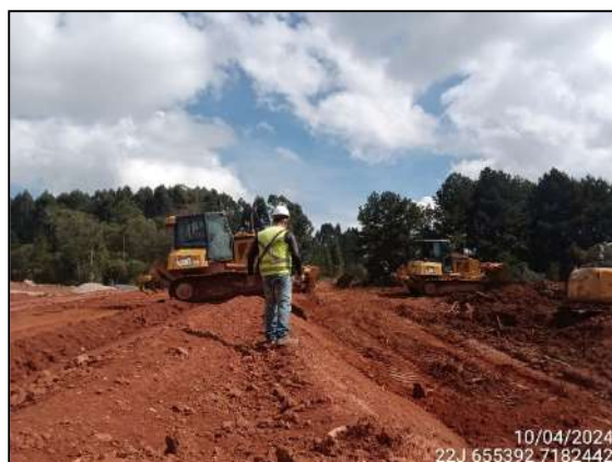
FIGURA 14: ARQUEÓLOGO ACOMPANHANDO ESCAVAÇÃO E MOVIMENTAÇÃO DE SOLO.
