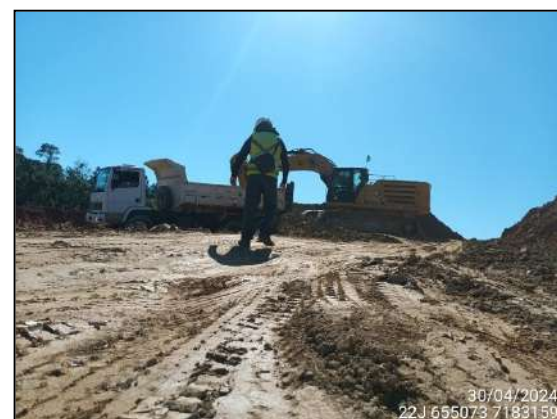
FIGURA 29: ESCAVAÇÃO E MOVIMENTAÇÃO DE SOLO.
