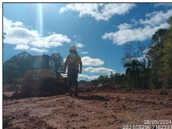
FIGURA 2: ARQUEÓLOGO ACOMPANHANDO TERRAPLANAGEM.
