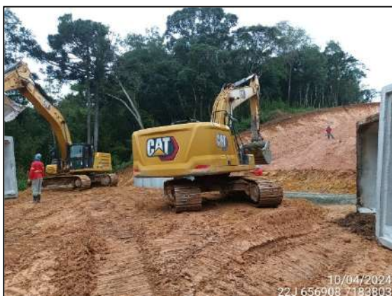
FIGURA 3: ESCAVAÇÃO E MOVIMENTAÇÃO DE SOLO.
