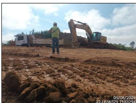
FIGURA 66: ARQUEÓLOGO ACOMPANHANDO ESCAVAÇÃO E MOVIMENTAÇÃO DE SOLO.
