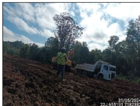
FIGURA 60: ESCAVAÇÃO E MOVIMENTAÇÃO DE SOLO.
