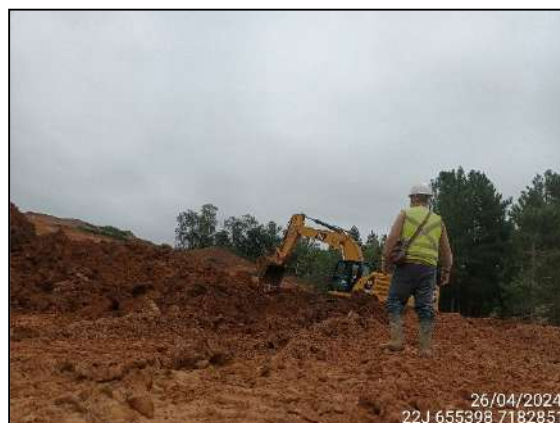
FIGURA 6: ARQUEÓLOGO ACOMPANHANDO ESCAVAÇÃO E MOVIMENTAÇÃO DE SOLO.
