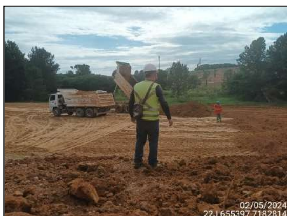
FIGURA 31: ARQUEÓLOGO ACOMPANHANDO TERRAPLANAGEM.
