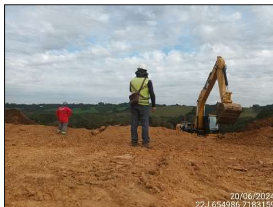
FIGURA 6: ARQUEÓLOGO ACOMPANHANDO ESCAVAÇÃO E MOVIMENTAÇÃO DE SOLO.
