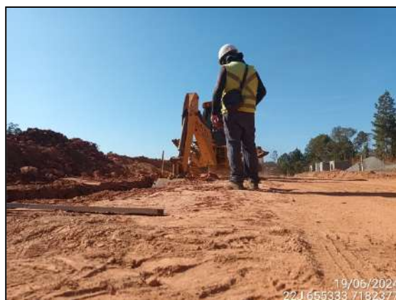
FIGURA 81: ARQUEÓLOGO ACOMPANHANDO ESCAVAÇÃO E MOVIMENTAÇÃO DE SOLO.
