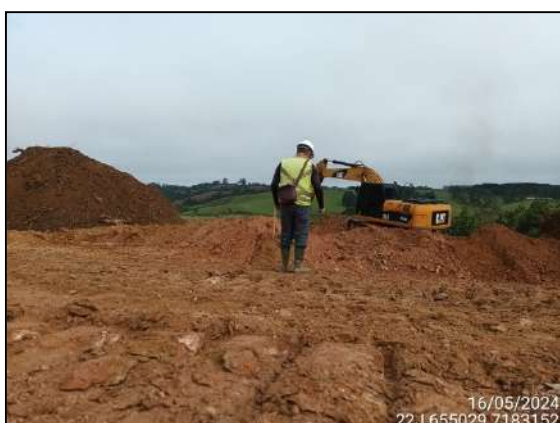
FIGURA 5: ARQUEÓLOGO ACOMPANHANDO ESCAVAÇÃO E MOVIMENTAÇÃO DE SOLO.
