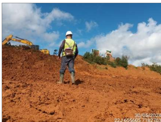
FIGURA 59: ARQUEÓLOGO ACOMPANHANDO ESCAVAÇÃO E MOVIMENTAÇÃO DE SOLO.
