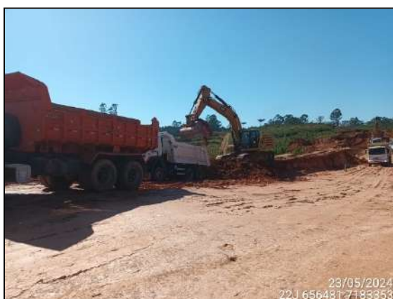
FIGURA 53: ESCAVAÇÃO E MOVIMENTAÇÃO DE SOLO.
