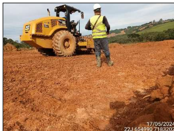
FIGURA 48: ARQUEÓLOGO ACOMPANHANDO TERRAPLANAGEM.
