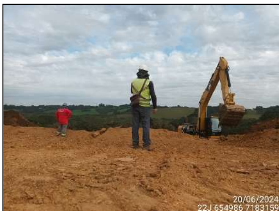
FIGURA 82: ARQUEÓLOGO ACOMPANHANDO ESCAVAÇÃO E MOVIMENTAÇÃO DE SOLO
