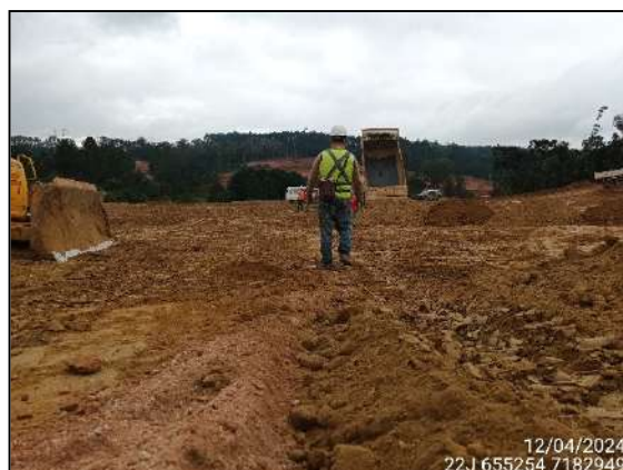
FIGURA 6: ARQUEÓLOGO ACOMPANHANDO TERRAPLANAGEM.
