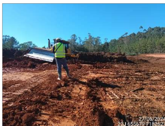
FIGURA 89: ARQUEÓLOGO ACOMPANHANDO TERRAPLANAGEM.
