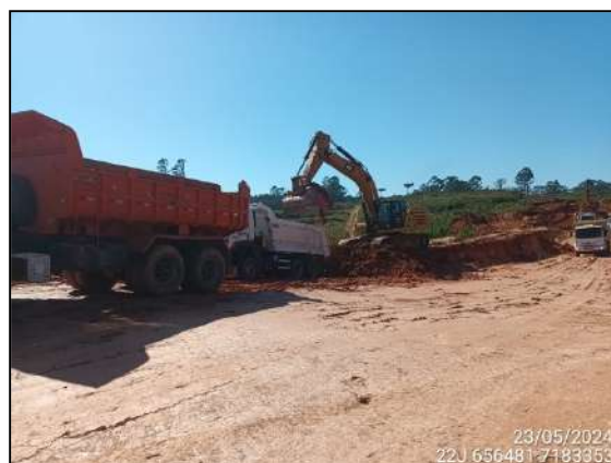
FIGURA 4: ESCAVAÇÃO E MOVIMENTAÇÃO DE SOLO.
