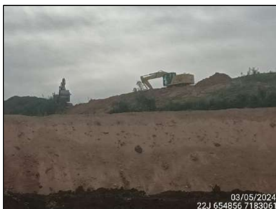
FIGURA 33: A ESCAVAÇÃO E MOVIMENTAÇÃO DE SOLO.
