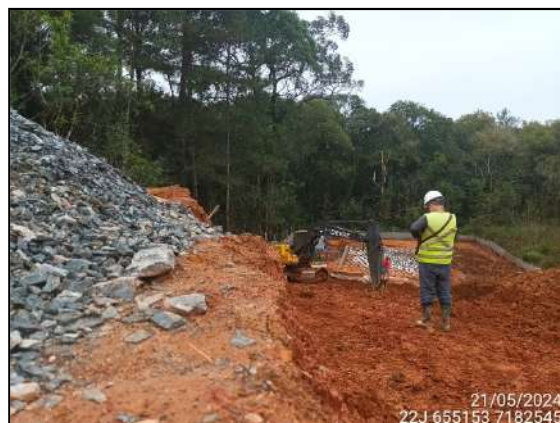
FIGURA 2: ARQUEÓLOGO ACOMPANHANDO ESCAVAÇÃO E MOVIMENTAÇÃO DE SOLO.
