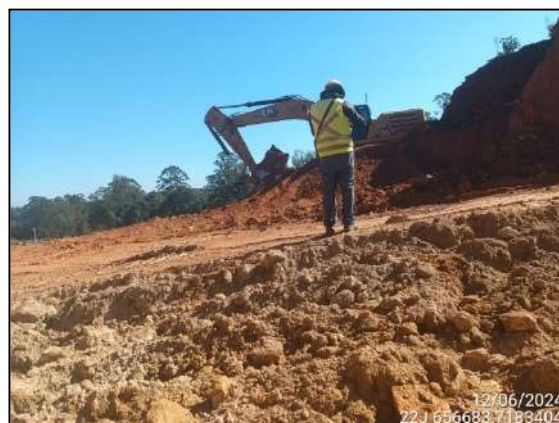
FIGURA 4: ARQUEÓLOGO ACOMPANHANDO ESCAVAÇÃO E MOVIMENTAÇÃO DE SOLO.
