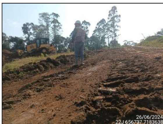
FIGURA 88: ARQUEÓLOGO ACOMPANHANDO TERRAPLANAGEM.
