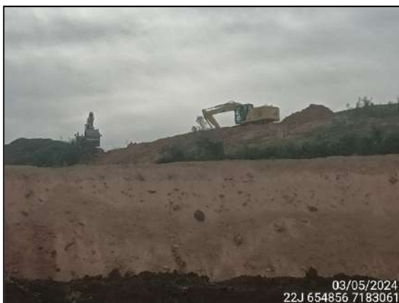
FIGURA 7: ESCAVAÇÃO E MOVIMENTAÇÃO DE SOLO.
