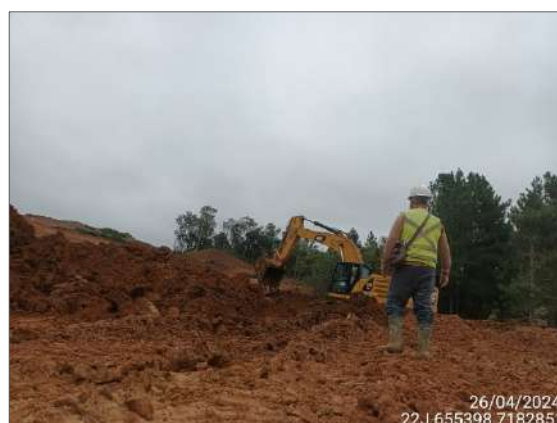
FIGURA 27: ARQUEÓLOGO ACOMPANHANDO ESCAVAÇÃO E MOVIMENTAÇÃO DE SOLO
