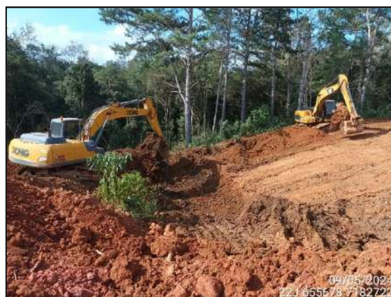
FIGURA 4: ESCAVAÇÃO E MOVIMENTAÇÃO DE SOLO.
