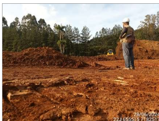
FIGURA 91: ARQUEÓLOGO ACOMPANHANDO TERRAPLANAGEM
