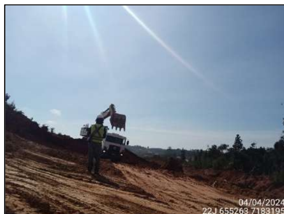
FIGURA 9: ARQUEÓLOGO ACOMPANHANDO ESCAVAÇÃO E MOVIMENTAÇÃO DE SOLO.
