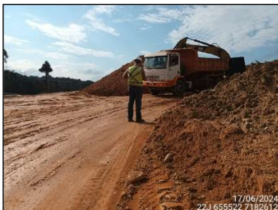
FIGURA 1: ARQUEÓLOGO ACOMPANHANDO ESCAVAÇÃO E MOVIMENTAÇÃO DE SOLO.
