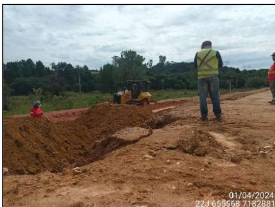
FIGURA 6: ARQUEÓLOGO ACOMPANHANDO TERRAPLANAGEM.
