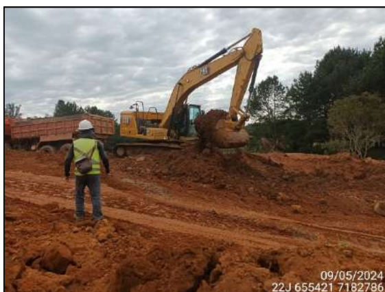
FIGURA 3: ARQUEÓLOGO ACOMPANHANDO ESCAVAÇÃO E MOVIMENTAÇÃO DE SOLO.
