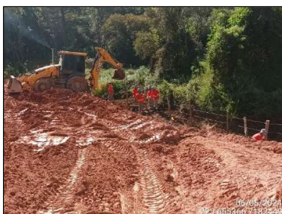
FIGURA 35: COLOCAÇÃO DE TELA EM ÁREA DE APP.
