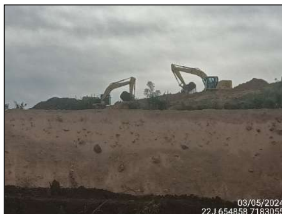
FIGURA 6: ESCAVAÇÃO E MOVIMENTAÇÃO DE SOLO.
