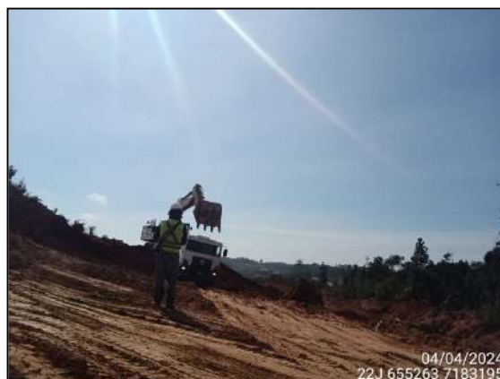
FIGURA 4: ARQUEÓLOGO ACOMPANHANDO ESCAVAÇÃO E MOVIMENTAÇÃO DE SOLO.
