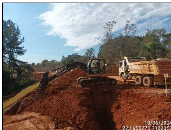
FIGURA 79: ESCAVAÇÃO E MOVIMENTAÇÃO DE SOLO.
