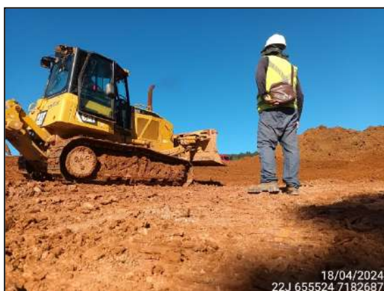
FIGURA 20: ARQUEÓLOGO ACOMPANHANDO TERRAPLANAGEM.
