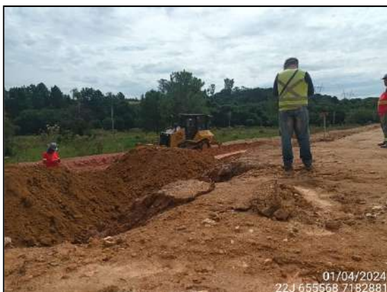
FIGURA 1: ARQUEÓLOGO ACOMPANHANDO TERRAPLANAGEM.
