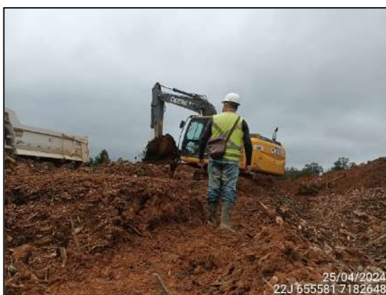
FIGURA 26: ARQUEÓLOGO ACOMPANHANDO ESCAVAÇÃO E MOVIMENTAÇÃO DE SOLO.
