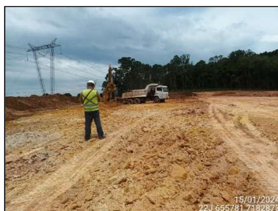
FIGURA 15: ESCAVAÇÃO E MOVIMENTAÇÃO DE SOLO.
