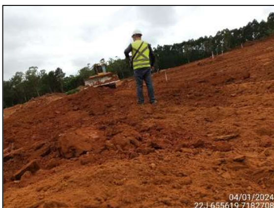
FIGURA 8: ARQUEÓLOGO ACOMPANHANDO TERRAPLANAGEM.
