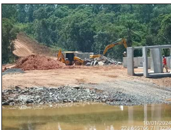
FIGURA 12: MOVIMENTAÇÃO DE MATERIAL ROCHOSO.
