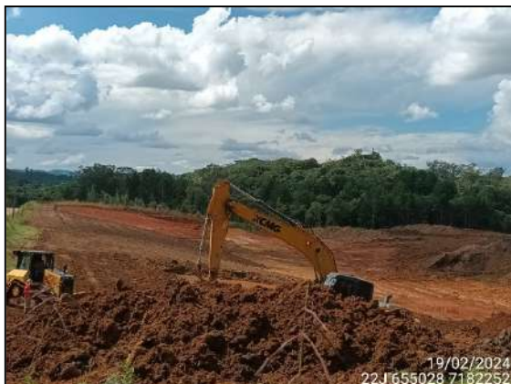
FIGURA 1: ESCAVAÇÃO E MOVIMENTAÇÃO DE SOLO.
