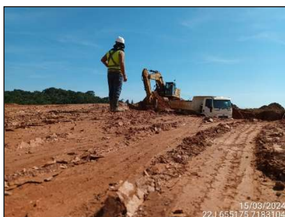
FIGURA 6: ARQUEÓLOGO ACOMPANHANDO ESCAVAÇÃO E MOVIMENTAÇÃO DE SOLO.
