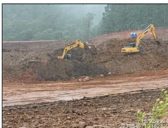
FIGURA 4: ESCAVAÇÃO E MOVIMENTAÇÃO DE SOLO.
