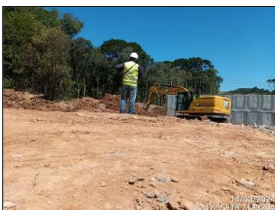
FIGURA 5: ARQUEÓLOGO ACOMPANHANDO ESCAVAÇÃO E MOVIMENTAÇÃO DE SOLO.
