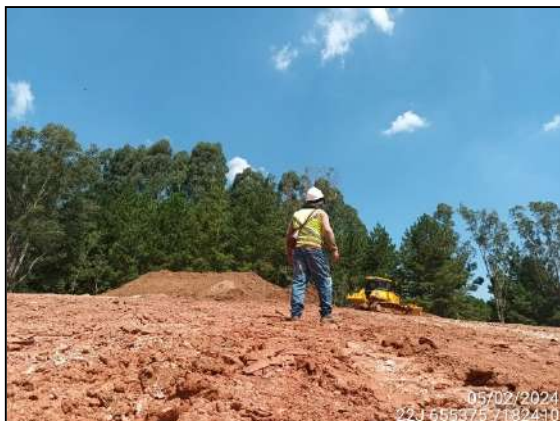
FIGURA 1: ARQUEÓLOGO ACOMPANHANDO TERRAPLANAGEM.
