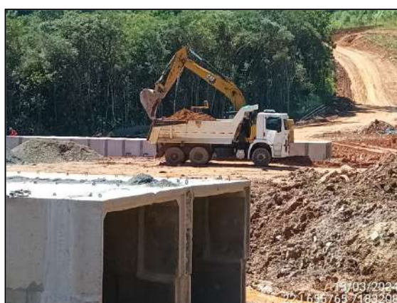
FIGURA 59: ESCAVAÇÃO E MOVIMENTAÇÃO DE SOLO.
