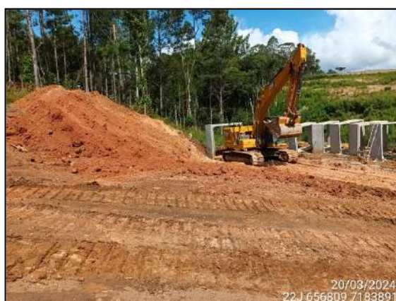
FIGURA 3: ESCAVAÇÃO E MOVIMENTAÇÃO DE SOLO.
