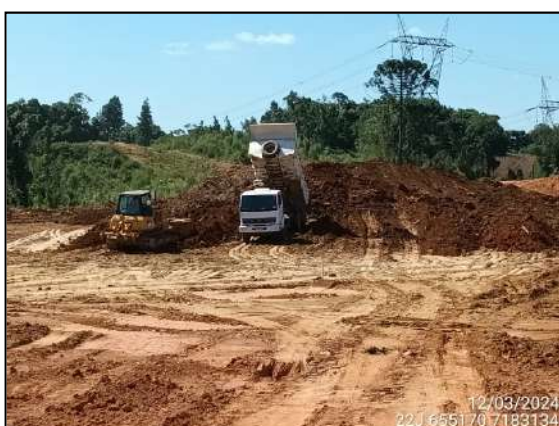
FIGURA 3: ESCAVAÇÃO E MOVIMENTAÇÃO DE SOLO.
