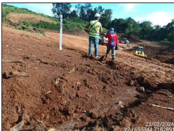
FIGURA 45: ARQUEÓLOGO ACOMPANHANDO TERRAPLANAGEM.
