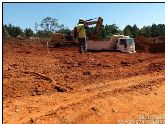
FIGURA 2: ARQUEÓLOGO ACOMPANHANDO ESCAVAÇÃO E MOVIMENTAÇÃO DE SOLO.
