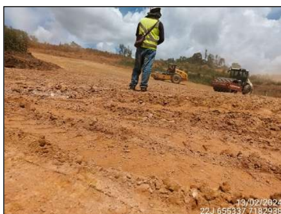
FIGURA 37: ARQUEÓLOGO ACOMPANHANDO TERRAPLANAGEM.
