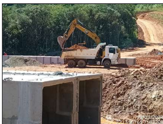
FIGURA 4: ESCAVAÇÃO E MOVIMENTAÇÃO DE SOLO.
