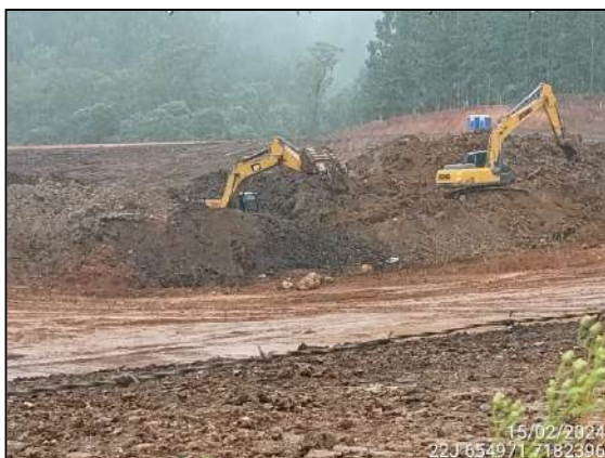
FIGURA 39: ESCAVAÇÃO E MOVIMENTAÇÃO DE SOLO
