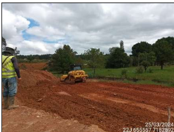
FIGURA 67: ARQUEÓLOGO ACOMPANHANDO TERRAPLANAGEM.
