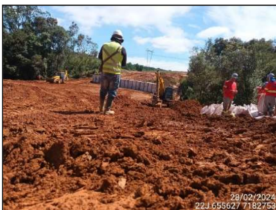
FIGURA 3: ARQUEÓLOGO ACOMPANHANDO ESCAVAÇÃO E MOVIMENTAÇÃO DE SOLO.
