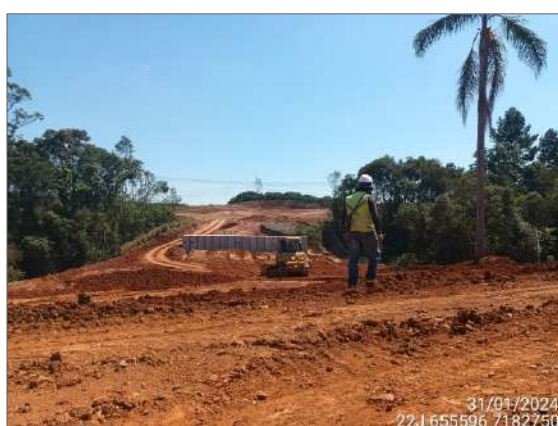
FIGURA 27: ARQUEÓLOGO ACOMPANHANDO TERRAPLANAGEM.
