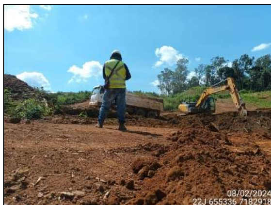
FIGURA 34: ARQUEÓLOGO ACOMPANHANDO ESCAVAÇÃO E MOVIMENTAÇÃO DE SOLO.
