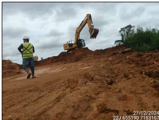
FIGURA 2: ARQUEÓLOGO ACOMPANHANDO ESCAVAÇÃO E MOVIMENTAÇÃO DE SOLO.
