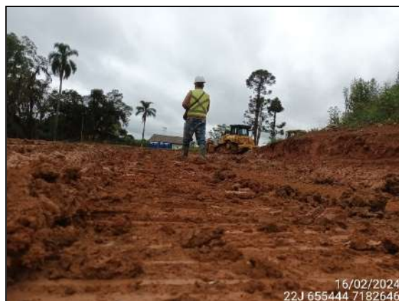
FIGURA 40: ARQUEÓLOGO ACOMPANHANDO TERRAPLANAGEM
