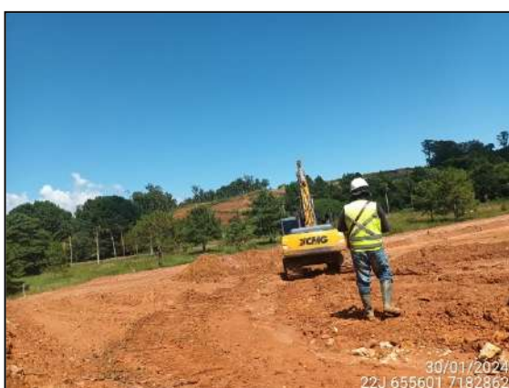
FIGURA 26: ARQUEÓLOGO ACOMPANHANDO ESCAVAÇÃO E MOVIMENTAÇÃO DE SOLO.
