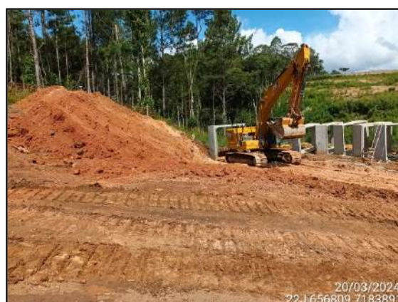
FIGURA 64: ESCAVAÇÃO E MOVIMENTAÇÃO DE SOLO.
