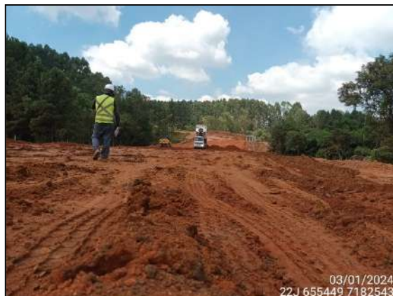
FIGURA 2: ARQUEÓLOGO ACOMPANHANDO TERRAPLANAGEM.
