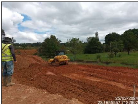
FIGURA 1: ARQUEÓLOGO ACOMPANHANDO TERRAPLANAGEM.
