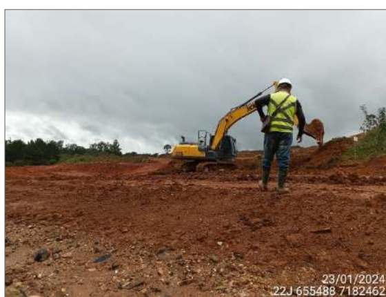
FIGURA 21: ARQUEÓLOGO ACOMPANHANDO ESCAVAÇÃO E MOVIMENTAÇÃO DE SOLO.
