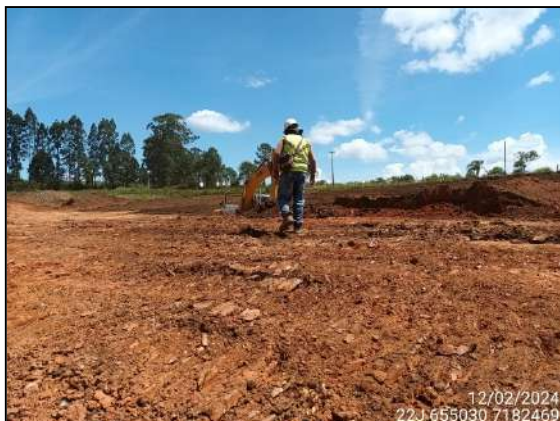
FIGURA 1: ARQUEÓLOGO ACOMPANHANDO ESCAVAÇÃO E MOVIMENTAÇÃO DE SOLO.
