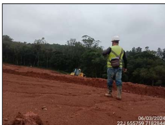
FIGURA 4: ARQUEÓLOGO ACOMPANHANDO TERRAPLANAGEM.
