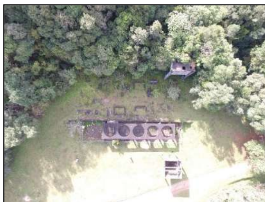
FIGURA 3: ESTRUTURA DA ANTIGA MINA TIMBUTUVA
