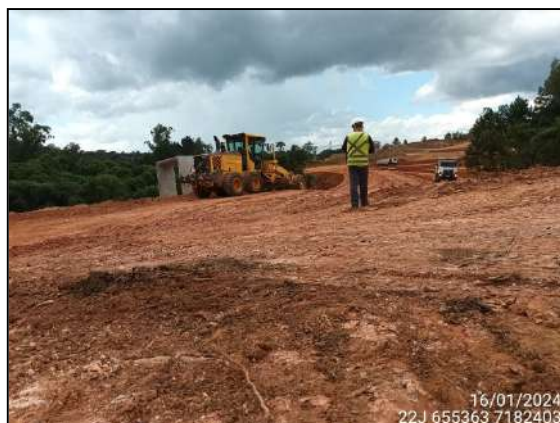
FIGURA 2: ARQUEÓLOGO ACOMPANHANDO TERRAPLANAGEM.
