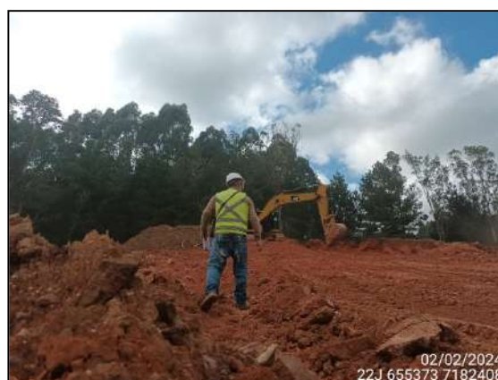
FIGURA 30: ARQUEÓLOGO ACOMPANHANDO ESCAVAÇÃO E MOVIMENTAÇÃO DE SOLO.
