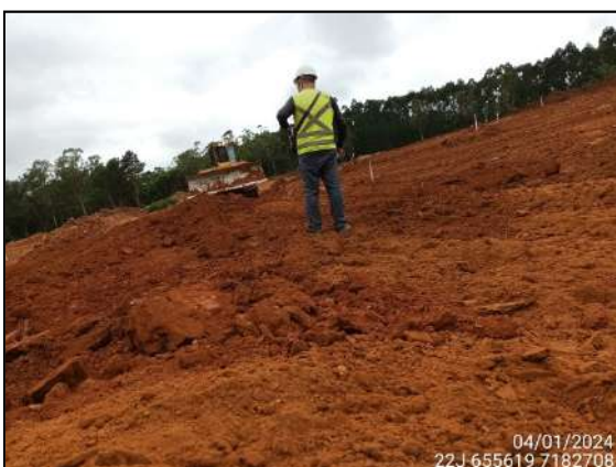
FIGURA 3: ARQUEÓLOGO ACOMPANHANDO TERRAPLANAGEM.
