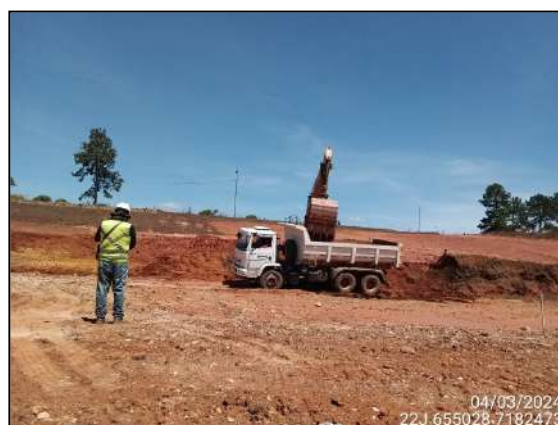
FIGURA 52: ARQUEÓLOGO ACOMPANHANDO ESCAVAÇÃO E MOVIMENTAÇÃO DE SOLO.
