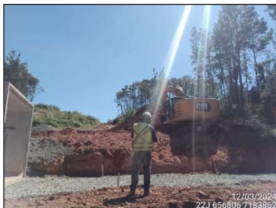
FIGURA 2: ARQUEÓLOGO ACOMPANHANDO ESCAVAÇÃO E MOVIMENTAÇÃO DE SOLO.
