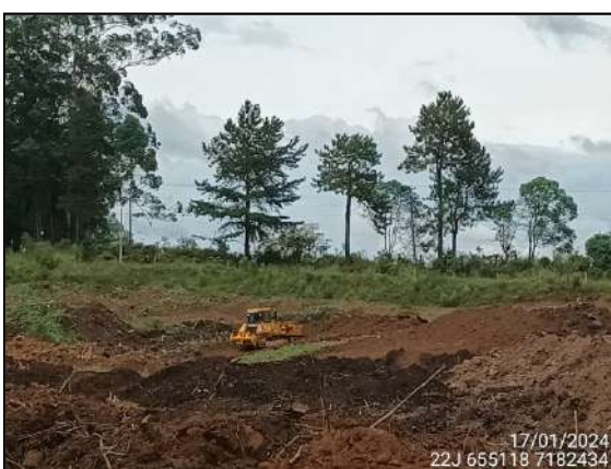
FIGURA 3: ESCAVAÇÃO E MOVIMENTAÇÃO DE SOLO.
