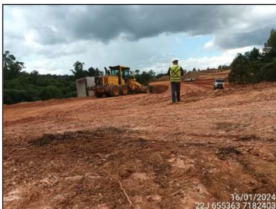
FIGURA 16: ARQUEÓLOGO ACOMPANHANDO TERRAPLANAGEM.
