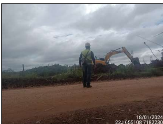
FIGURA 18: ARQUEÓLOGO ACOMPANHANDO ESCAVAÇÃO E MOVIMENTAÇÃO DE SOLO.
