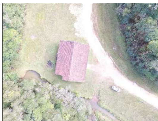
FIGURA 5: BARRACÃO DA ANTIGA MINA TIMBUTUVA
