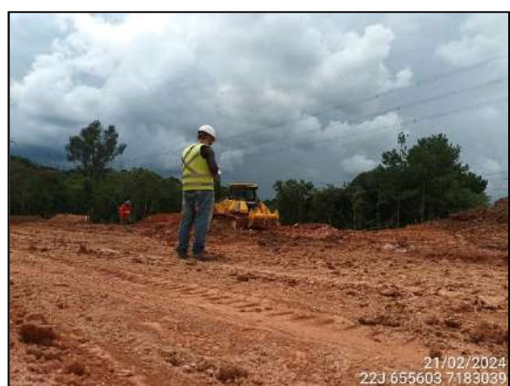
FIGURA 43: ARQUEÓLOGO ACOMPANHANDO TERRAPLANAGEM.
