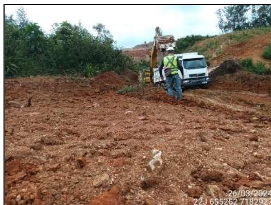
FIGURA 68: ARQUEÓLOGO ACOMPANHANDO TERRAPLANAGEM.
