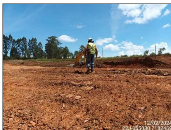
FIGURA 36: ARQUEÓLOGO ACOMPANHANDO ESCAVAÇÃO E MOVIMENTAÇÃO DE SOLO.
