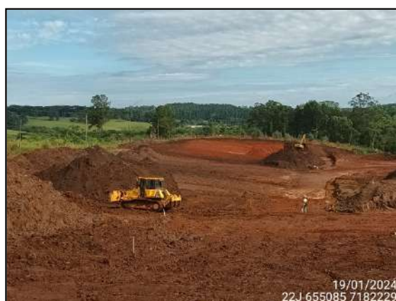
FIGURA 19: ESCAVAÇÃO E MOVIMENTAÇÃO DE SOLO.
