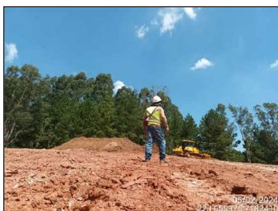
FIGURA 31: ARQUEÓLOGO ACOMPANHANDO TERRAPLANAGEM.
