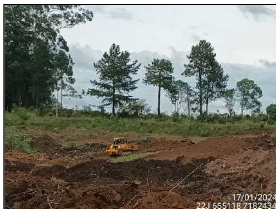
FIGURA 17: ESCAVAÇÃO E MOVIMENTAÇÃO DE SOLO.
