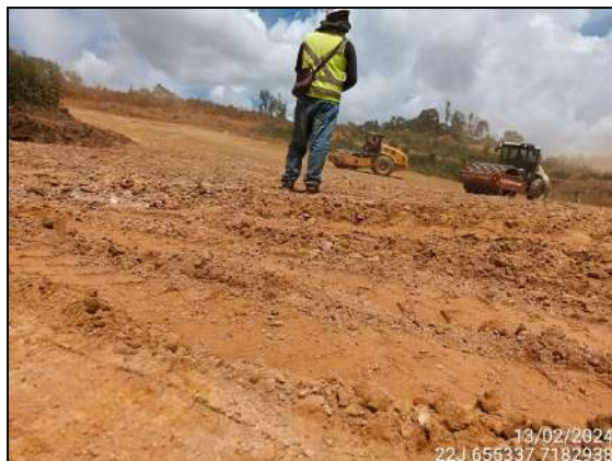
FIGURA 2: ARQUEÓLOGO ACOMPANHANDO TERRAPLANAGEM.
