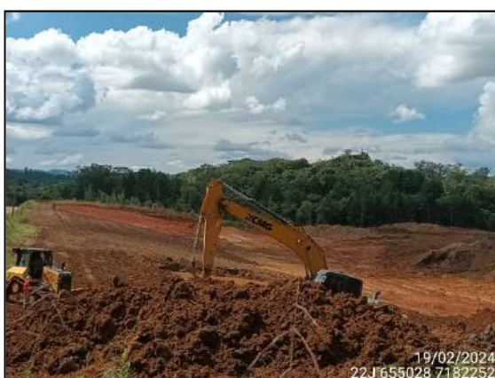
FIGURA 41: ESCAVAÇÃO E MOVIMENTAÇÃO DE SOLO.
