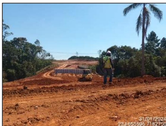
FIGURA 6: ARQUEÓLOGO ACOMPANHANDO TERRAPLANAGEM.
