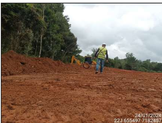
FIGURA 3: ARQUEÓLOGO ACOMPANHANDO ESCAVAÇÃO E MOVIMENTAÇÃO DE SOLO.
