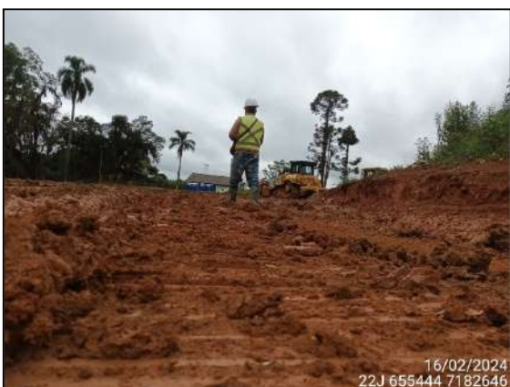
FIGURA 5: ARQUEÓLOGO ACOMPANHANDO TERRAPLANAGEM.
