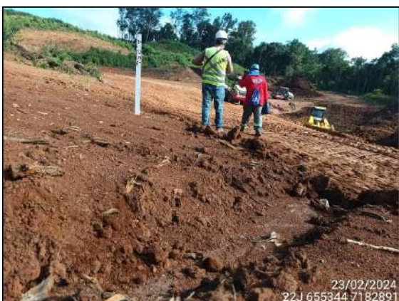
FIGURA 5: ARQUEÓLOGO ACOMPANHANDO TERRAPLANAGEM.
