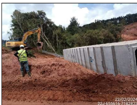
FIGURA 4: ARQUEÓLOGO ACOMPANHANDO ESCAVAÇÃO E MOVIMENTAÇÃO DE SOLO.
