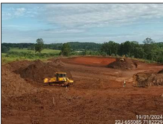
FIGURA 5: ESCAVAÇÃO E MOVIMENTAÇÃO DE SOLO.
