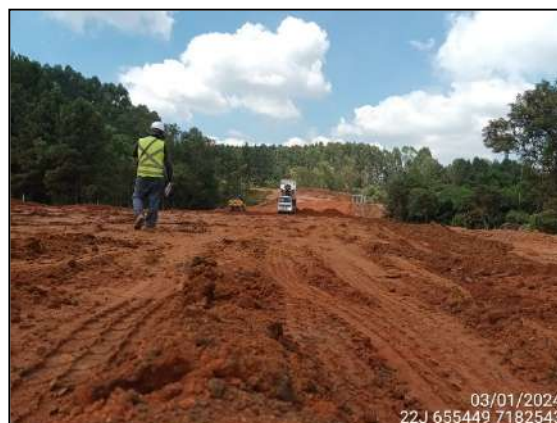
FIGURA 7: ARQUEÓLOGO ACOMPANHANDO TERRAPLANAGEM.
