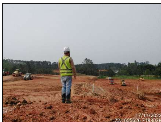
FIGURA 4: ARQUEÓLOGO ACOMPANHANDO TERRAPLANAGEM.
