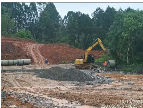
FIGURA 5: MOVIMENTAÇÃO DE TUBULAÇÕES DE CONCRETO.
