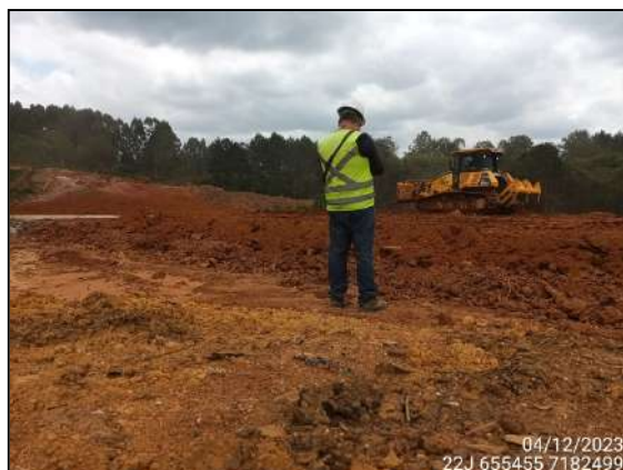
FIGURA 2: ARQUEÓLOGO ACOMPANHANDO TERRAPLANAGEM.
