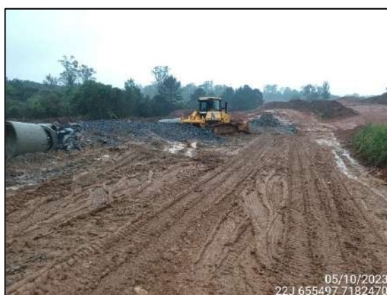
FIGURA 9: MOVIMENTAÇÃO DE MATERIAL ROCHOSO.
