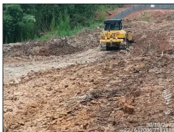
FIGURA 27: MOVIMENTAÇÃO DE SOLO.
