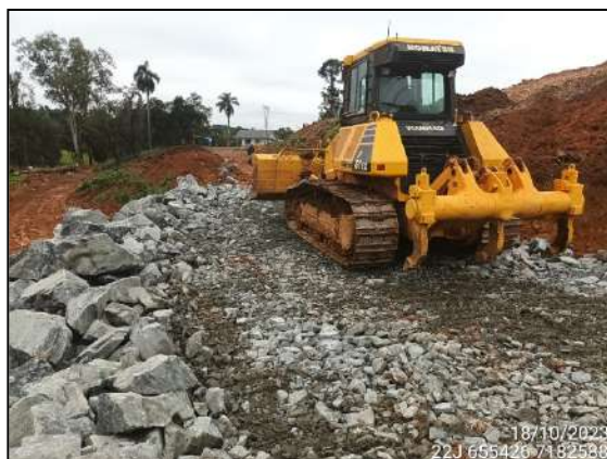
FIGURA 19: MOVIMENTAÇÃO DE MATERIAL ROCHOSO.
