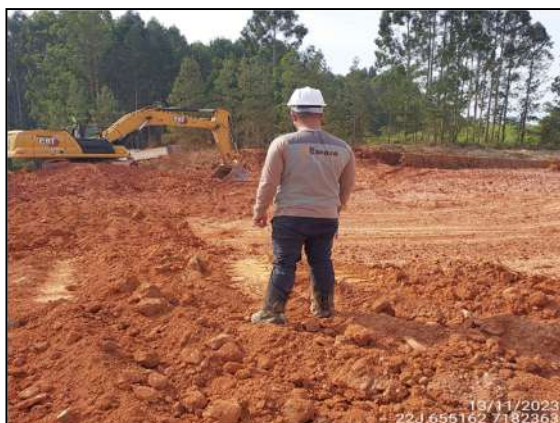
FIGURA 1: ARQUEÓLOGO ACOMPANHANDO ESCAVAÇÃO E MOVIMENTAÇÃO DE SOLO.
