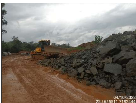
FIGURA 8: MOVIMENTAÇÃO DE MATERIAL ROCHOSO.
