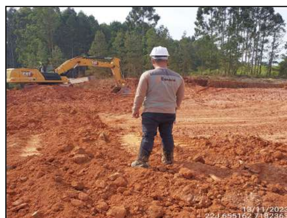
FIGURA 37: ARQUEÓLOGO ACOMPANHANDO ESCAVAÇÃO E MOVIMENTAÇÃO DE SOLO.
