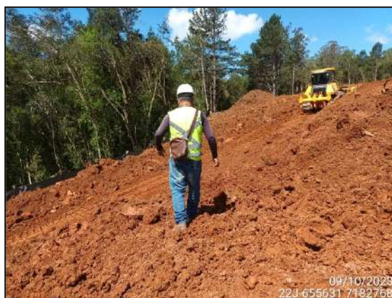
FIGURA 11: ARQUEÓLOGO ACOMPANHANDO TERRAPLANAGEM.
