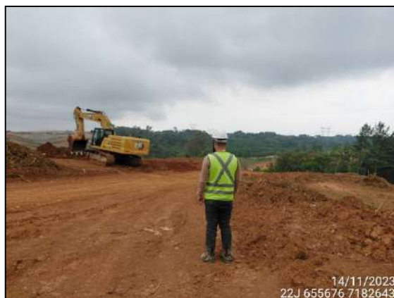
FIGURA 2: ARQUEÓLOGO ACOMPANHANDO ESCAVAÇÃO E MOVIMENTAÇÃO DE SOLO.
