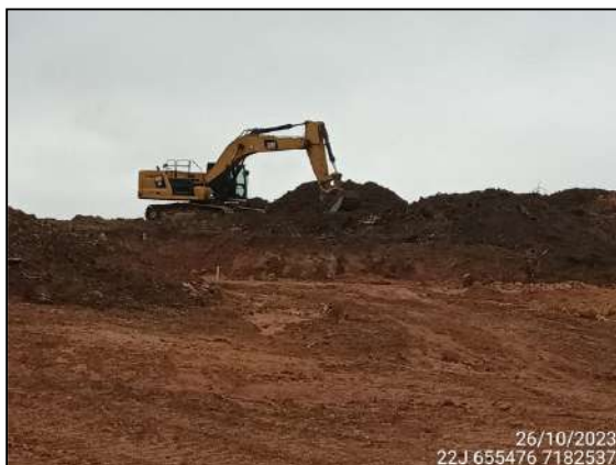
FIGURA 4: ESCAVAÇÃO E MOVIMENTAÇÃO DE SOLO.
