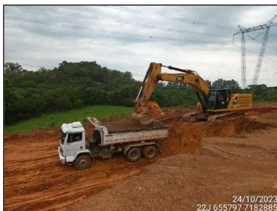
FIGURA 23: ESCAVAÇÃO E MOVIMENTAÇÃO DE SOLO.
