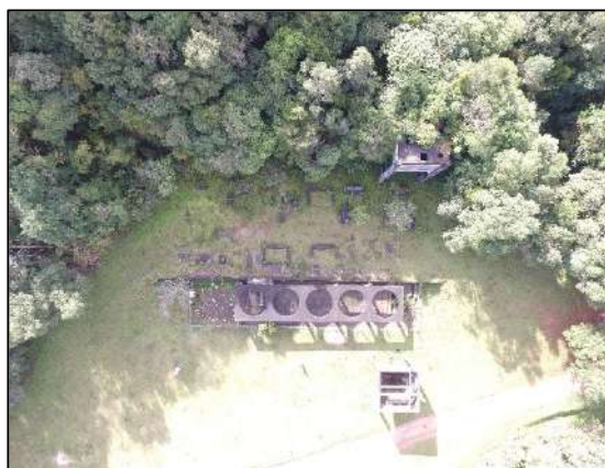
FIGURA 3: ESTRUTURA DA ANTIGA MINA TIMBUTUVA
