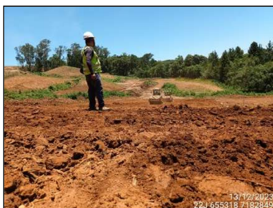
FIGURA 59: ARQUEÓLOGO ACOMPANHANDO TERRAPLANAGEM.
