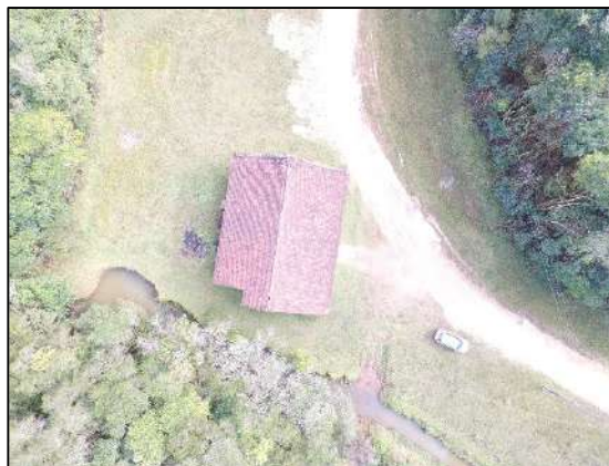
FIGURA 5: BARRACÃO DA ANTIGA MINA TIMBUTUVA
