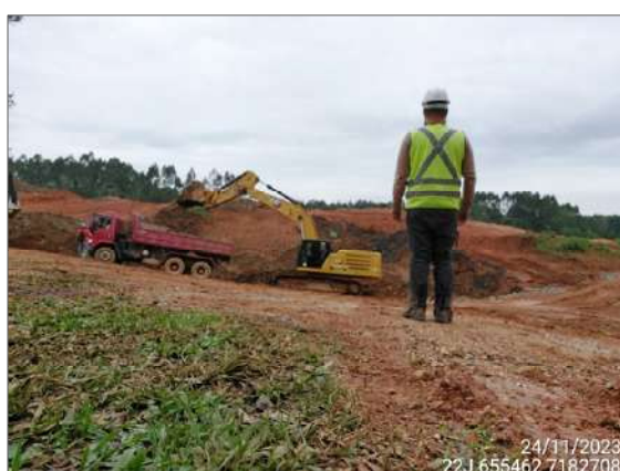
FIGURA 45: ARQUEÓLOGO ACOMPANHANDO ESCAVAÇÃO E MOVIMENTAÇÃO DE SOLO.
