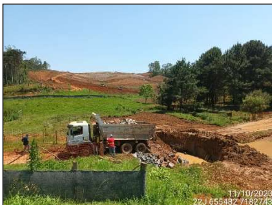
FIGURA 4: MOVIMENTAÇÃO DE MATERIAL ROCHOSO.
