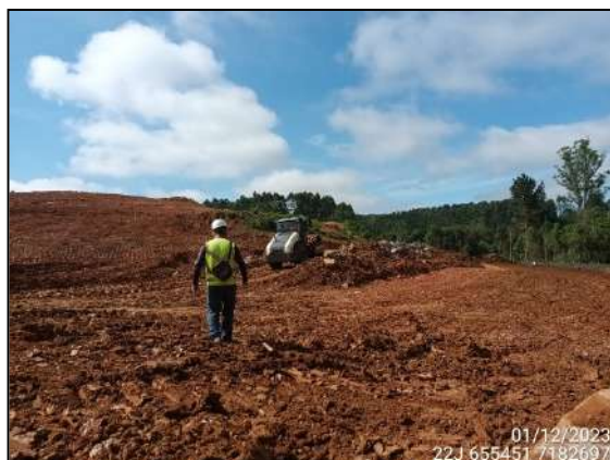
FIGURA 1: ARQUEÓLOGO ACOMPANHANDO TERRAPLANAGEM.
