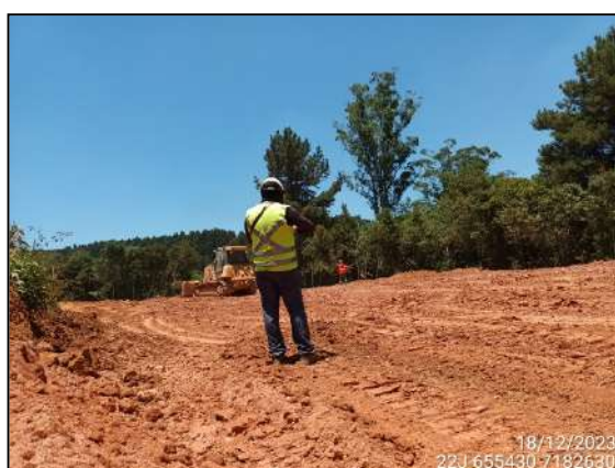
FIGURA 61: ARQUEÓLOGO ACOMPANHANDO TERRAPLANAGEM.
