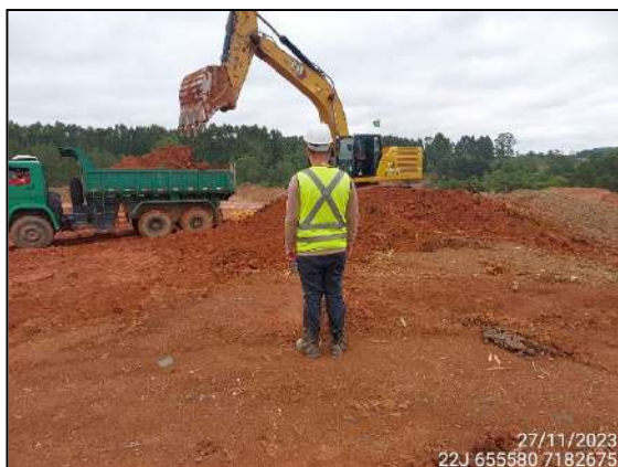
FIGURA 1: ARQUEÓLOGO ACOMPANHANDO ESCAVAÇÃO E MOVIMENTAÇÃO DE SOLO.
