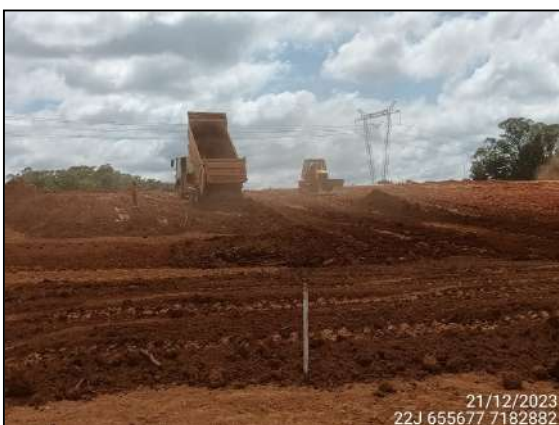
FIGURA 5: ESCAVAÇÃO E MOVIMENTAÇÃO DE SOLO.
