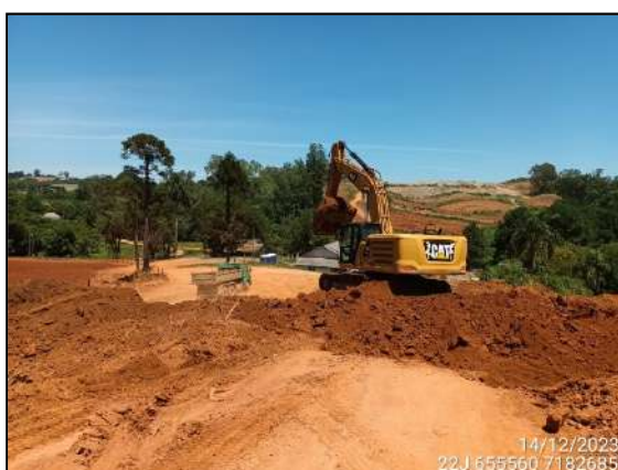
FIGURA 4: ESCAVAÇÃO E MOVIMENTAÇÃO DE SOLO.
