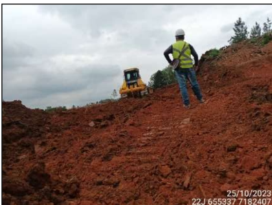
FIGURA 3: ARQUEÓLOGO DE CAMPO ACOMPANHANDO TERRAPLANAGEM.
