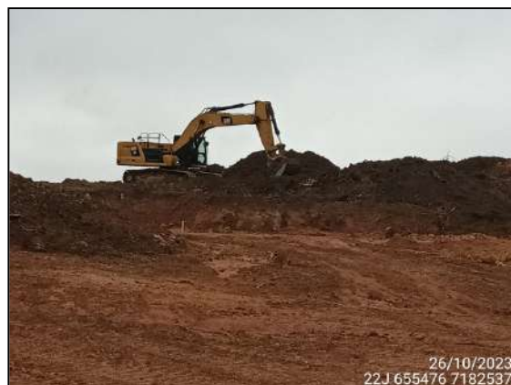
FIGURA 25: ESCAVAÇÃO E MOVIMENTAÇÃO DE SOLO.
