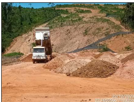
FIGURA 6: ESCAVAÇÃO E MOVIMENTAÇÃO DE SOLO.
