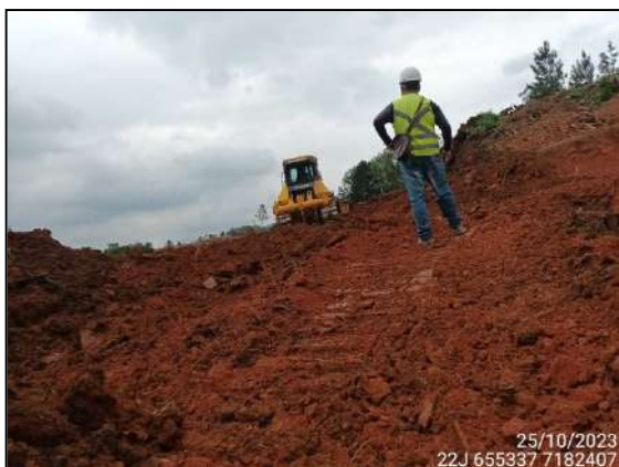
FIGURA 24: ARQUEÓLOGO DE CAMPO ACOMPANHANDO TERRAPLANAGEM.
