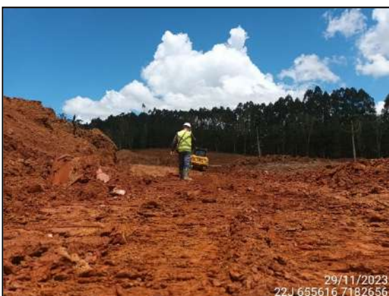
FIGURA 48: ARQUEÓLOGO DE CAMPO ACOMPANHANDO TERRAPLANAGEM.
