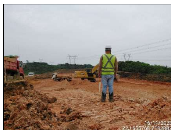
FIGURA 39: ARQUEÓLOGO ACOMPANHANDO ESCAVAÇÃO E MOVIMENTAÇÃO DE SOLO.
