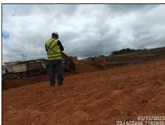
FIGURA 3: ARQUEÓLOGO ACOMPANHANDO ESCAVAÇÃO E MOVIMENTAÇÃO DE SOLO.
