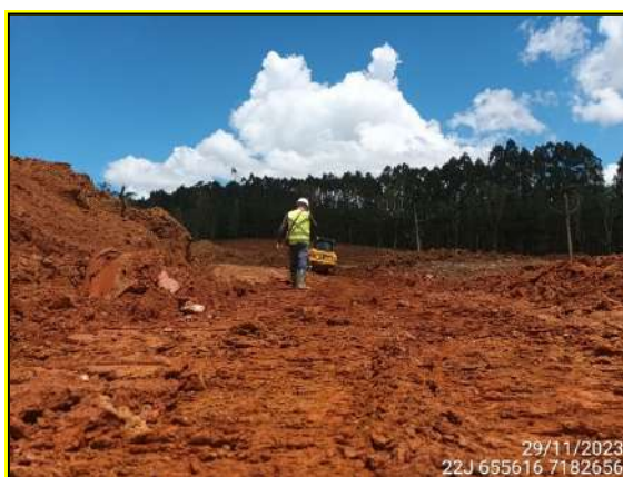
FIGURA 3: ARQUEÓLOGO ACOMPANHANDO TERRAPLANAGEM.
