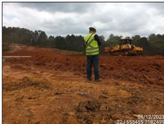
FIGURA 52: ARQUEÓLOGO ACOMPANHANDO TERRAPLANAGEM.
