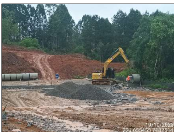
FIGURA 20: MOVIMENTAÇÃO DE TUBULAÇÃO DE CONCRETO.
