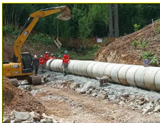
FIGURA 4: ARQUEÓLOGO ACOMPANHANDO MOVIMENTAÇÃO DE TUBULAÇÃO DE CONCRETO.
