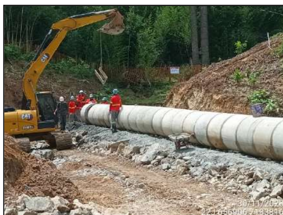
FIGURA 49: MOVIMENTAÇÃO DE TUBULAÇÃO DE CONCRETO.
