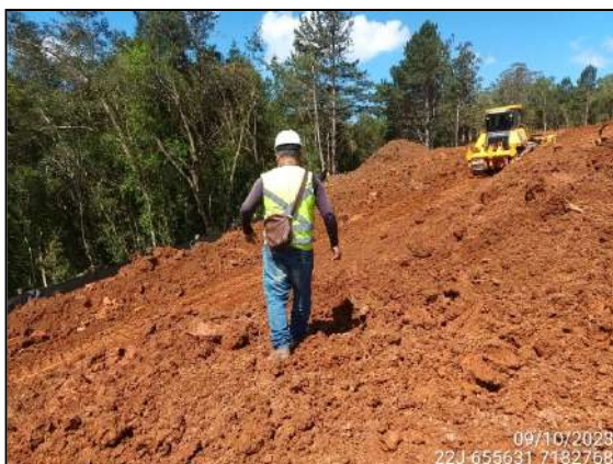
FIGURA 1: ARQUEÓLOGO DE CAMPO ACOMPANHANDO TERRAPLANAGEM.
