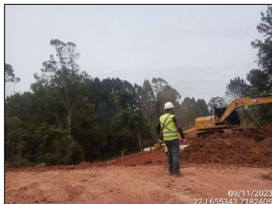
FIGURA 35: ARQUEÓLOGO ACOMPANHANDO ESCAVAÇÃO E MOVIMENTAÇÃO DE SOLO.
