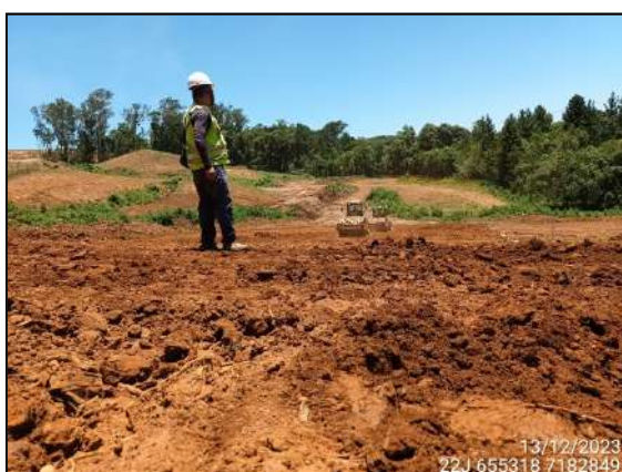
FIGURA 3: ARQUEÓLOGO ACOMPANHANDO TERRAPLANAGEM.
