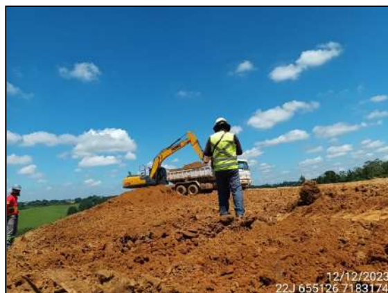
FIGURA 58: ARQUEÓLOGO ACOMPANHANDO ESCAVAÇÃO E MOVIMENTAÇÃO DE SOLO.
