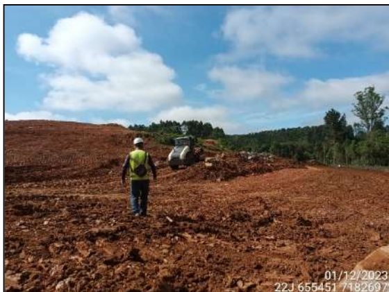
FIGURA 51: ARQUEÓLOGO ACOMPANHANDO TERRAPLANAGEM.
