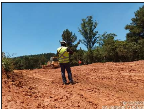
FIGURA 1: ARQUEÓLOGO ACOMPANHANDO TERRAPLANAGEM.
