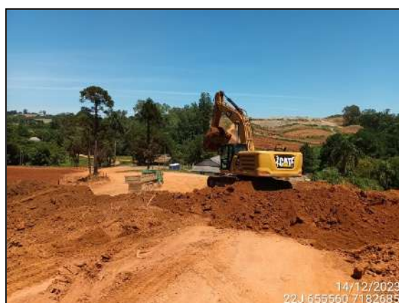
FIGURA 60: ESCAVAÇÃO E MOVIMENTAÇÃO DE SOLO.
