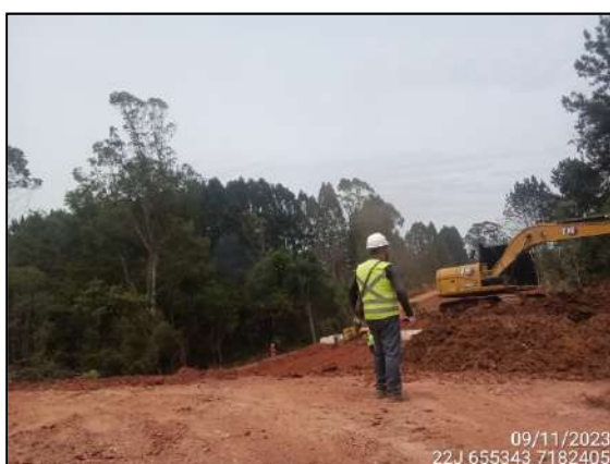
FIGURA 4: ARQUEÓLOGO ACOMPANHANDO ESCAVAÇÃO E MOVIMENTAÇÃO DE SOLO.
