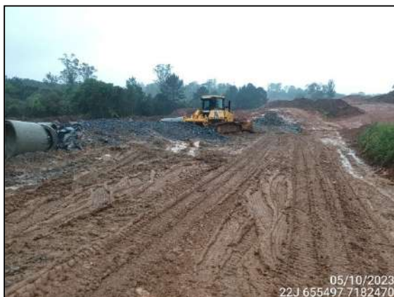
FIGURA 4: MOVIMENTAÇÃO DE MATERIAL ROCHOSO.
