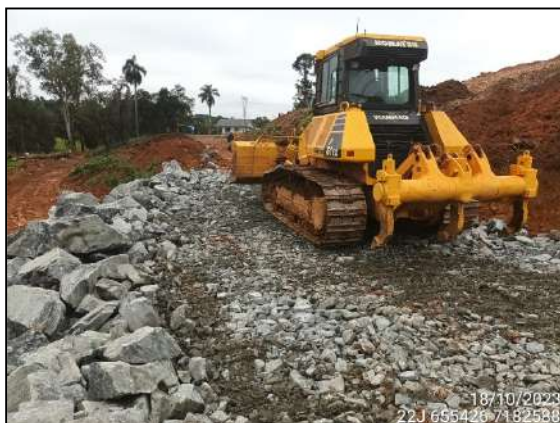
FIGURA 4: MOVIMENTAÇÃO DE MATERIAL ROCHOSO.
