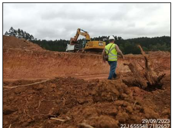
FIGURA 6: ESCAVAÇÃO E MOVIMENTAÇÃO DE SOLO.
