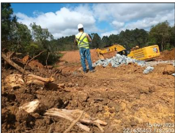
FIGURA 5: ESCAVAÇÃO E MOVIMENTAÇÃO DE MATERIAL ROCHOSO.
