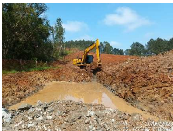
FIGURA 93: ESCAVAÇÃO DE SOLO.
