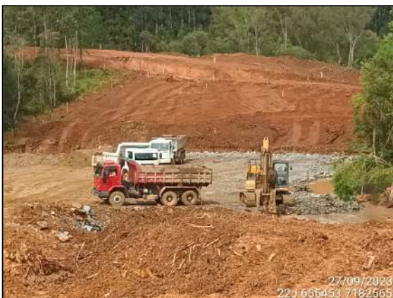
FIGURA 3: ESCAVAÇÃO DE MATERIAL ROCHOSO.
