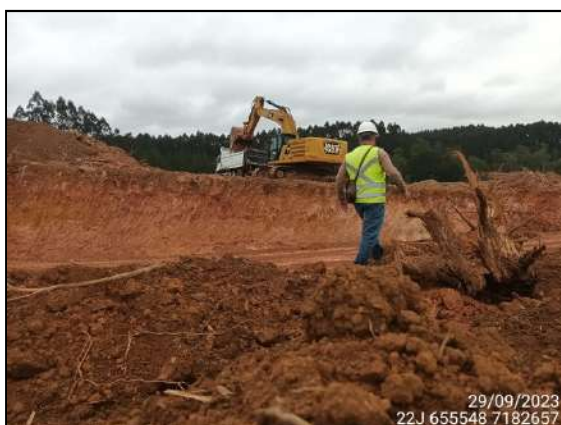
FIGURA 101: ARQUEÓLOGO DE CAMPO ACOMPANHANDO ESCAVAÇÃO DE SOLO.
