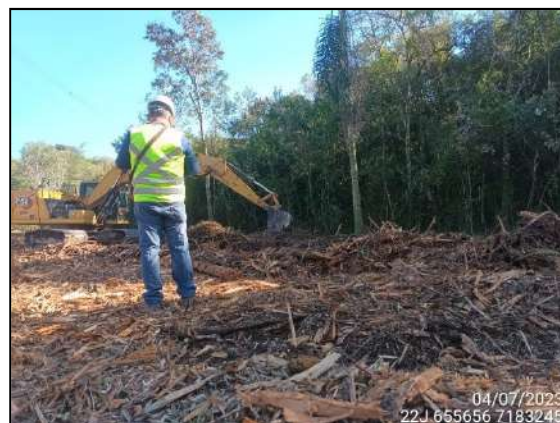
FIGURA 6: LIMPEZA SUPERFICIAL EM ÁREA SUPRIMIDA.
