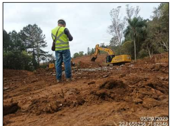
FIGURA 4: ESCAVAÇÃO E MOVIMENTAÇÃO DE MATERIAL ROCHOSO.
