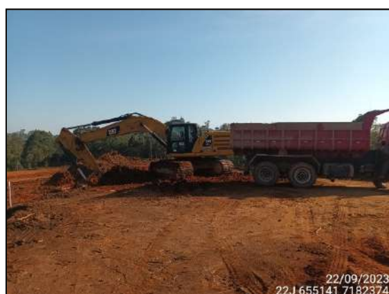
FIGURA 6: ESCAVAÇÃO E MOVIMENTAÇÃO DE SOLO.
