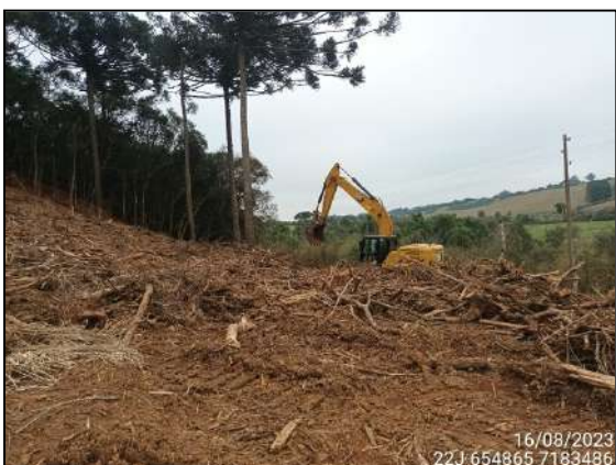
FIGURA 3: LIMPEZA DE ÁREA PREVIAMENTE SUPRIMIDA.
