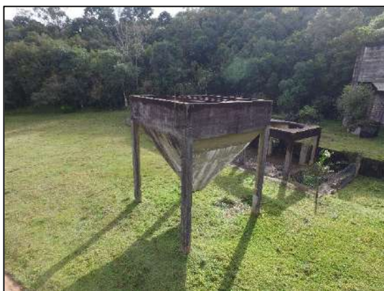
FIGURA 2: ANTIGA ESTRUTURA DOS BRITADORES DA MINA TIMBUTUVA
