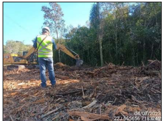
FIGURA 7: LIMPEZA DE ÁREA PREVIAMENTE SUPRIMIDA.
