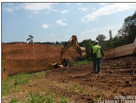
FIGURA 97: ARQUEÓLOGO DE CAMPO ACOMPANHANDO ESCAVAÇÃO DE SOLO.
