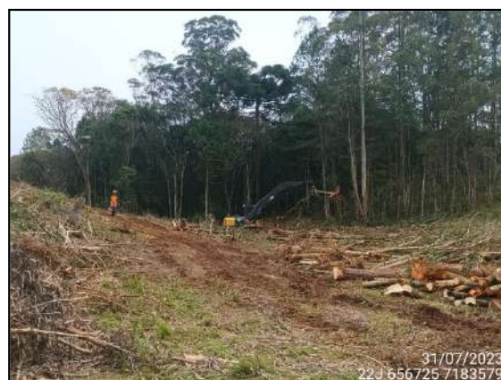
FIGURA 25: LIMPEZA EM ÁREA DE SUPRESSÃO VEGETAL.
