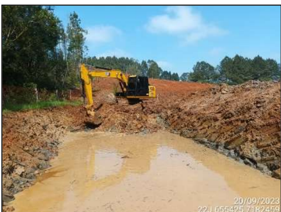
FIGURA 3: ESCAVAÇÃO E MOVIMENTAÇÃO DE SOLO.
