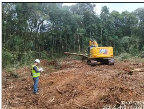
FIGURA 5: LIMPEZA E DESTOCAMENTO.
