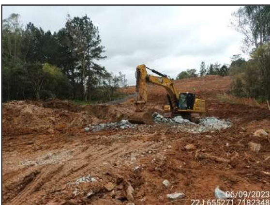
FIGURA 5: ESCAVAÇÃO E MOVIMENTAÇÃO DE MATERIAL ROCHOSO.
