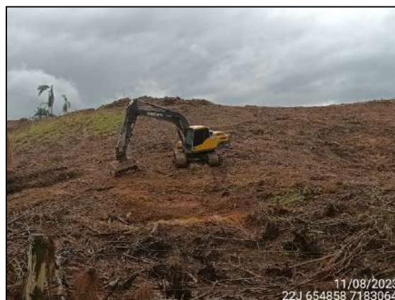
FIGURA 4: CORTE E LIMPEZA DE ÁREA PREVIAMENTE SUPRIMIDA.
