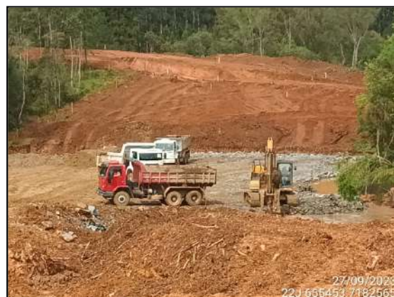
FIGURA 98: ESCAVAÇÃO DE MATERIAL ROCHOSO.
