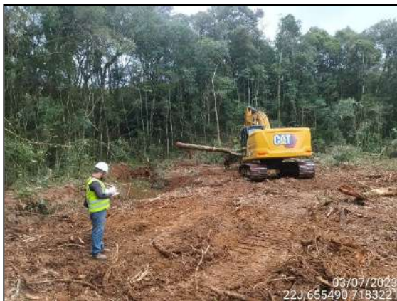
FIGURA 6: LIMPEZA E DESTOCAMENTO.
