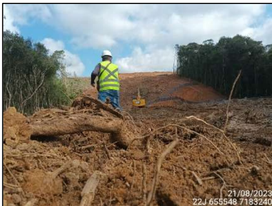
FIGURA 1: LIMPEZA DE ÁREA PREVIAMENTE SUPRIMIDA.
