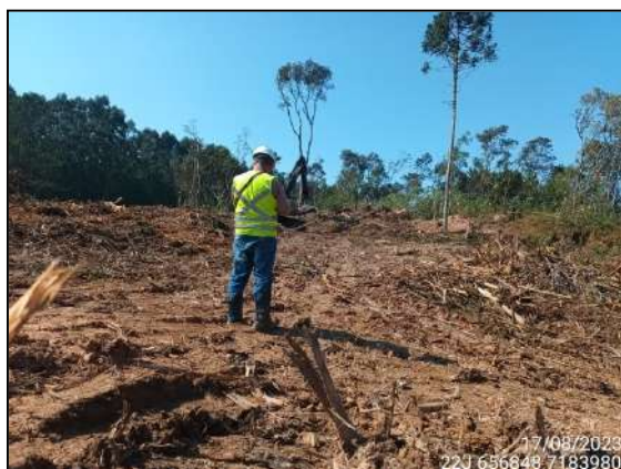
FIGURA 4: LIMPEZA DE ÁREA PREVIAMENTE SUPRIMIDA.
