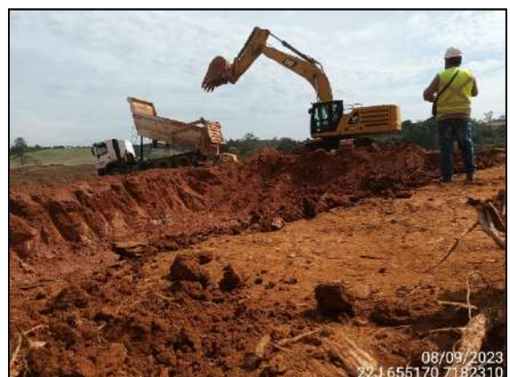
FIGURA 6: ARQUEÓLOGO ACOMPANHANDO ESCAVAÇÃO E MOVIMENTAÇÃO DE SOLO.
