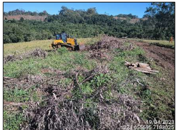
FIGURA 2: ENLEIRAMENTO / LIMPEZA SUPERFICIAL.
