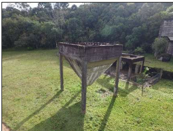
FIGURA 2: ANTIGA ESTRUTURA DOS BRITADORES DA MINA TIMBUTUVA
