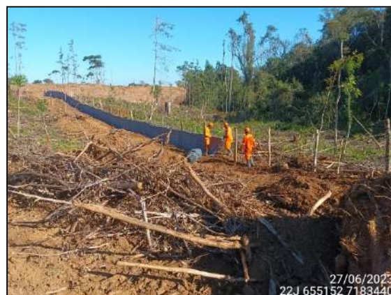
FIGURA 44: CERCAMENTO EM ÁREA DE PRESERVAÇÃO PERMANENTE.
