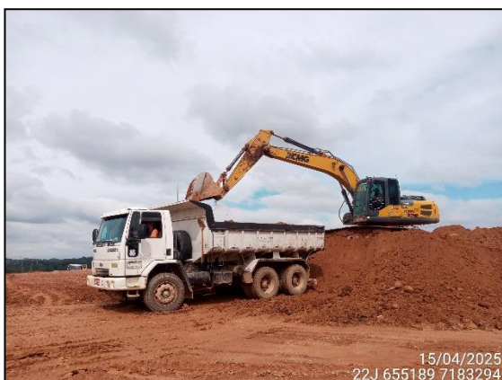
FIGURA 3: ESCAVAÇÃO PARA UTILIZAÇÃO DO MATERIAL EM ATERRO.
