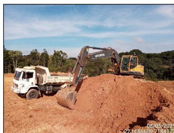
FIGURA 10: ESCAVAÇÃO PARA UTILIZAÇÃO DESSE MATERIAL EM ATERRO.
