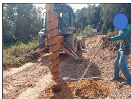
FIGURA 12: PERFURAÇÃO PARA CONSTRUÇÃO DO MURO 22 PONTOS PERFURADOS DE 3 A 3,20 DE PROFUNDIDADE A 25CM DE LARGURA.
