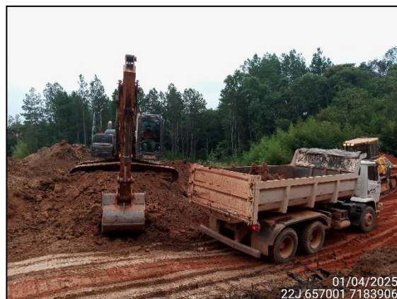
FIGURA 2: ESCAVAÇÃO E MOVIMENTAÇÃO DE OLERA.
