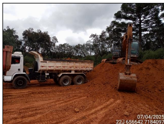
FIGURA 2: ESCAVAÇÃO PARA UTILIZAÇÃO DO MATERIAL EM ATERRO.
