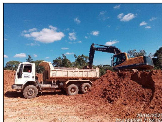
FIGURA 23: RETIRADA DE MATERIAL DESTINADO A ATERRO.
