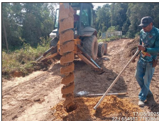
FIGURA 36: PERFURAÇÃO PARA INSTALAÇÃO DE ESTACA
