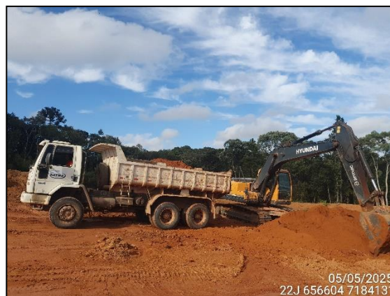
FIGURA 4 ESCAVAÇÃO PARA UTILIZAÇÃO DESSE MATERIAL EM ATERRO.
