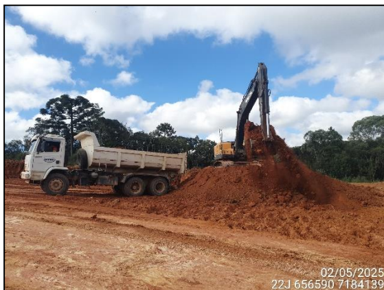
FIGURA 1: ESCAVAÇÃO PARA UTILIZAÇÃO DESSE MATERIAL EM ATERRO.
