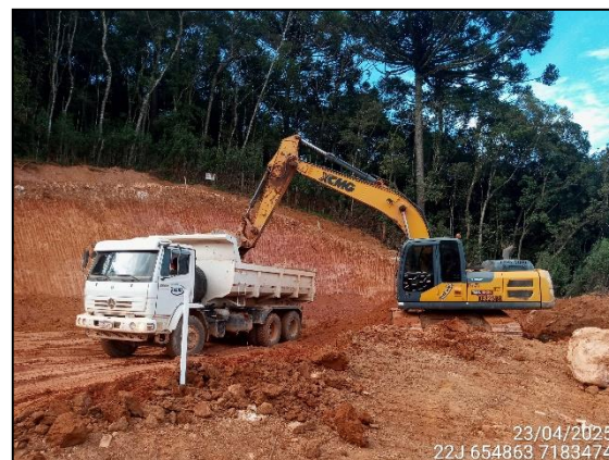
FIGURA 19: ESCAVAÇÃO PARA RETIRADA DE TERRA PARA PLANTAR GRAMA.
