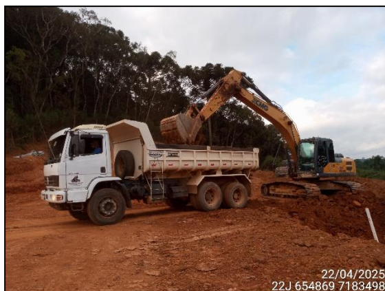
FIGURA 1: ESCAVAÇÃO PARA UTILIZAÇÃO DO MATERIAL EM ATERRO.
