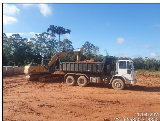
FIGURA 14: ESCAVAÇÃO PARA RETIRADA DE TERRA DESTINADO A ATERRO.
