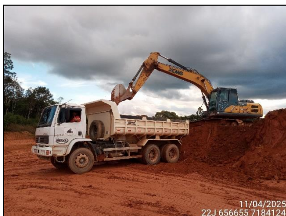
FIGURA 9: ESCAVAÇÃO PARA UTILIZAÇÃO DO MATERIAL EM ATERRO.
