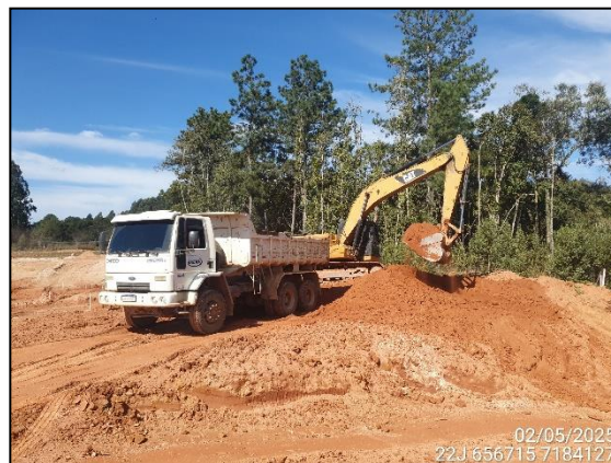
FIGURA 2: ESCAVAÇÃO PARA UTILIZAÇÃO DESSE MATERIAL EM ATERRO.
