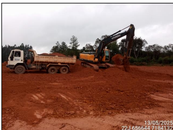
FIGURA 3: ESCAVAÇÃO PARA UTILIZAÇÃO DO MATERIAL EM ATERRO
