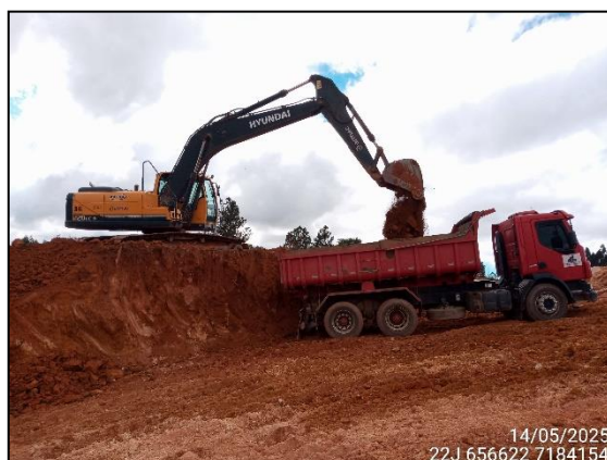
FIGURA 6: ESCAVAÇÃO PARA UTILIZAÇÃO DO MATERIAL EM ATERRO
