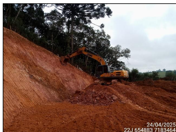
FIGURA 6: ESCAVAÇÃO DE RAMPA PARA PLANTAR GRAMA.
