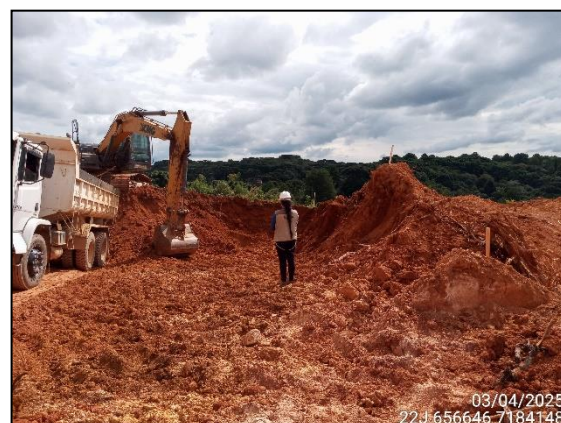
FIGURA 6: ARQUEOLOGA ACOMPANHANDO ESCAVAÇÃO DE MATERIAL PARA ATERRO.
