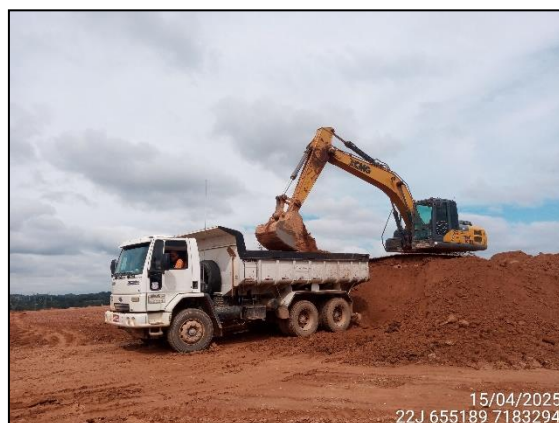
FIGURA 16: ESCAVAÇÃO PARA RETIRADA DE TERRA DESTINADO A ATERRO.
