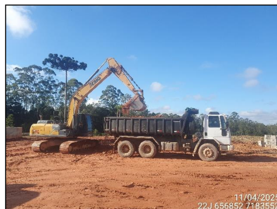
FIGURA 10: ESCAVAÇÃO PARA UTILIZAÇÃO DESSE MATERIAL EM ATERRO.
