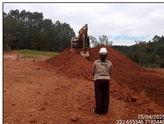
FIGURA 8: ARQUEOLOGA ACOMPANHANDO ESCAVAÇÃO PARA NIVELAMENTO DE CALÇADA.
