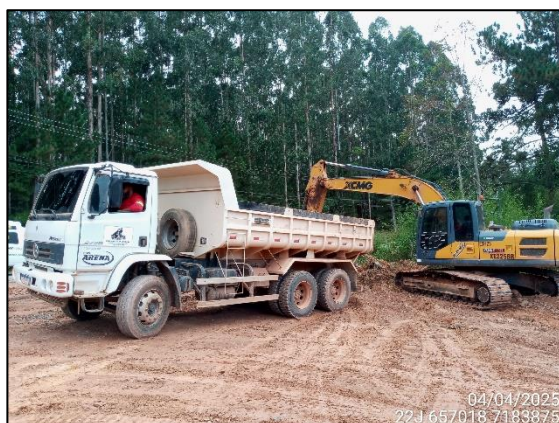
FIGURA 9: ESCAVAÇÃO PARA RETIRADA DE TERRA DESTINADO A ATERRO.
