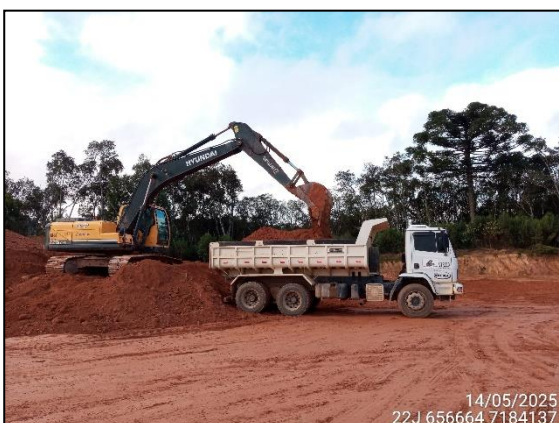
FIGURA 5: ESCAVAÇÃO PARA UTILIZAÇÃO DO MATERIAL EM ATERRO
