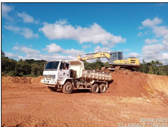
FIGURA 5: ESCAVAÇÃO PARA UTILIZAÇÃO DO MATERIAL EM ATERRO.
