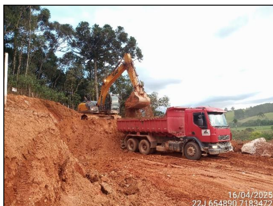
FIGURA 6: ESCAVAÇÃO PARA UTILIZAÇÃO DO MATERIAL EM ATERRO.
