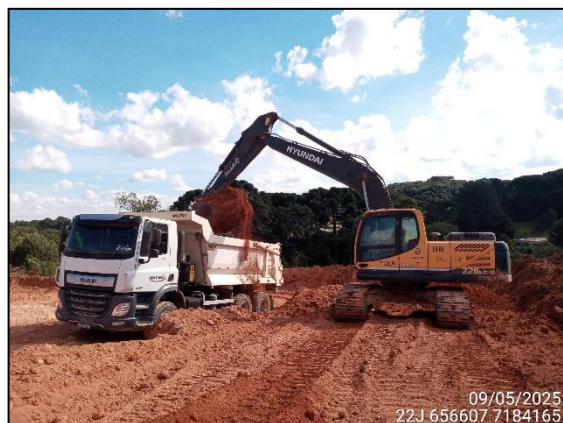
FIGURA 31: ESCAVAÇÃO PARA RETIRADA DE TERRA DESTINADA A ATERRO.
