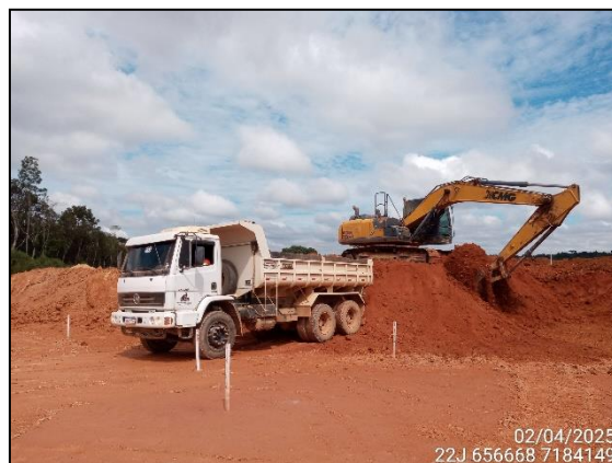
FIGURA 7: ESCAVAÇÃO PARA RETIRADA DE TERRA DESTINADO A ATERRO.
