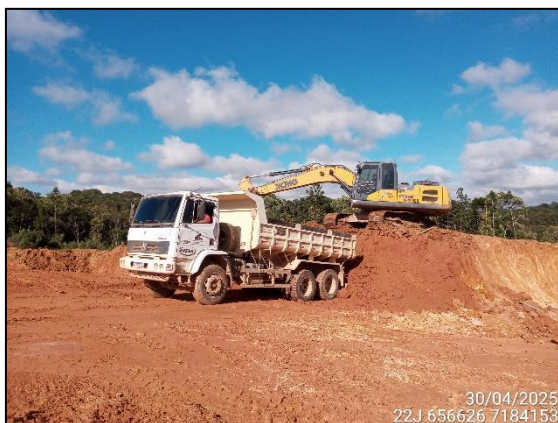
FIGURA 24: ESCAVAÇÃO PARA RETIRADA DE MATERIAL DESTINADO A ATERRO
