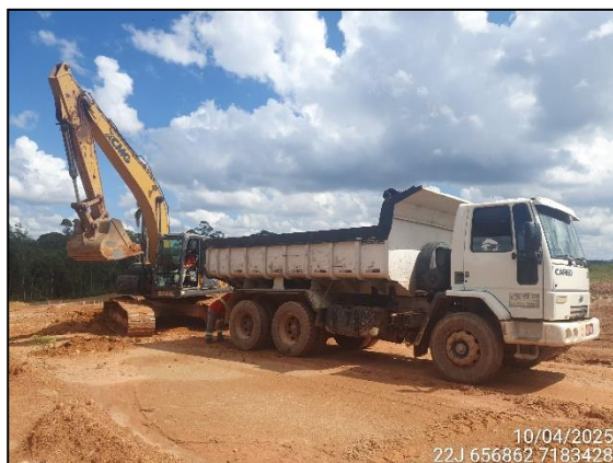
FIGURA 7: ESCAVAÇÃO PARA NIVELAMENTO E DESENHO DA RUA.
