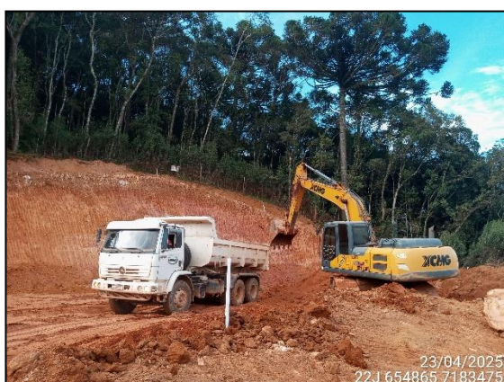
FIGURA 3: ESCAVAÇÃO PARA NIVELAMENTO DE AREA PARA COLOCAR GRAMA.
