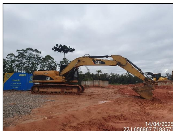
FIGURA 15: ATIVIDADES PARALISADAS DEVIDO À CHUVA.
