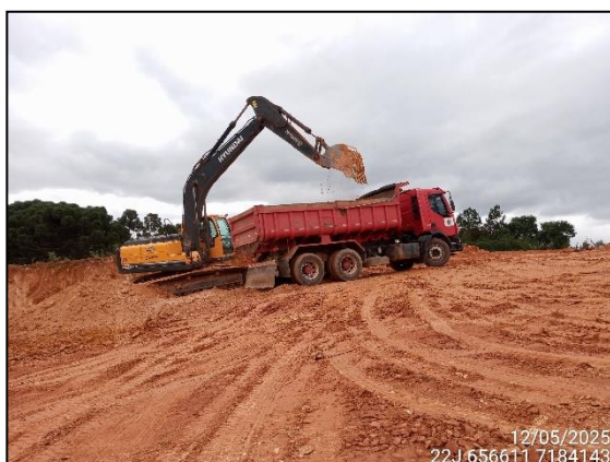
FIGURA 32: ESCAVAÇÃO PARA RETIRADA DE TERRA DESTINADA A ATERRO.
