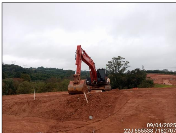
FIGURA 12: ESCAVAÇÃO PARA RETIRADA DE TERRA PARA PLANTAR GRAMA.
