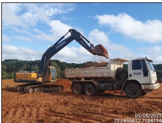
FIGURA 3: ESCAVAÇÃO PARA UTILIZAÇÃO DESSE MATERIAL EM ATERRO.
