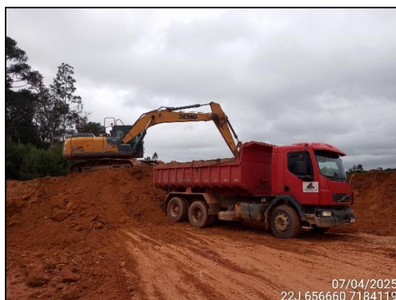
FIGURA 10: ESCAVAÇÃO PARA RETIRADA DE TERRA DESTINADO A ATERRO.
