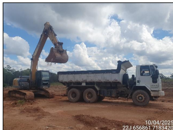
FIGURA 13: RETIRADA DE MATERIAL PARA NIVELAMENTO DE ÁREA DESTINADA À CALÇADA.
