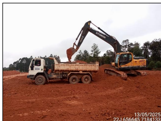
FIGURA 33: ESCAVAÇÃO PARA RETIRADA DE TERRA DESTINADA A ATERRO.
