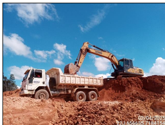
FIGURA 4: ESCAVAÇÃO DE CORTE PARA UTILIZAÇÃO DO MATERIAL EM ATERRO.
