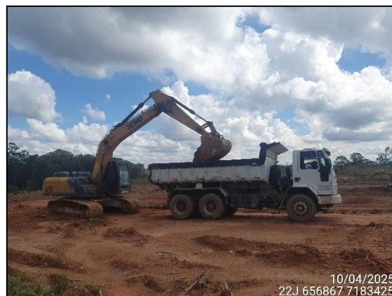
FIGURA 8: ESCAVAÇÃO PARA NIVELAMENTO E DESENHO DA RUA.
