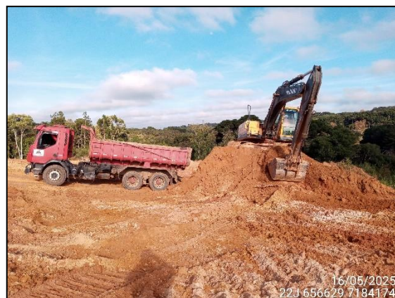
FIGURA 35: ESCAVAÇÃO PARA RETIRADA DE TERRA DESTINADA A ATERRO.
