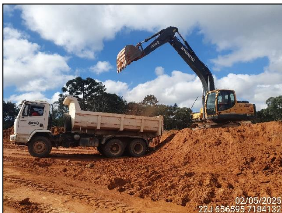
FIGURA 26: ESCAVAÇÃO PARA RETIRADA DE TERRA DESTINADA A ATERRO.
