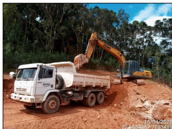
FIGURA 17: ESCAVAÇÃO PARA RETIRADA DE TERRA DESTINADO A ATERRO.
