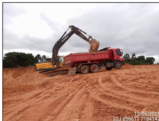
FIGURA 2: ESCAVAÇÃO PARA UTILIZAÇÃO DO MATERIAL EM ATERRO.
