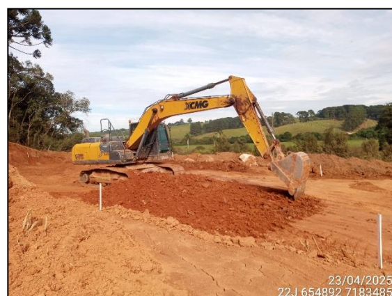
FIGURA 4: ESCAVAÇÃO PARA NIVELAMENTO DE AREA PARA RUA.
