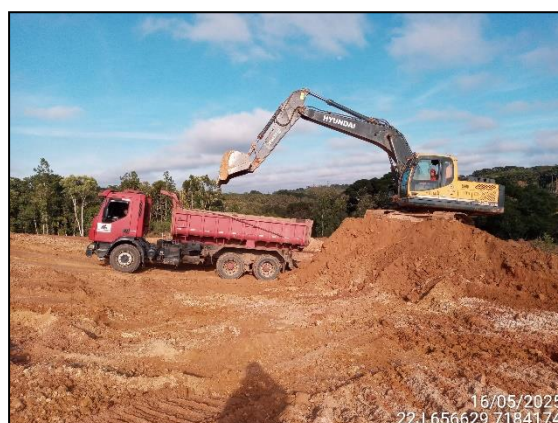
FIGURA 9: ESCAVAÇÃO PARA UTILIZAÇÃO DO MATERIAL EM ATERRO
