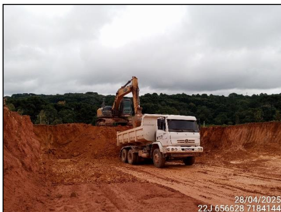
FIGURA 1: ESCAVAÇÃO PARA UTILIZAÇÃO DO MATERIAL EM ATERRO.
