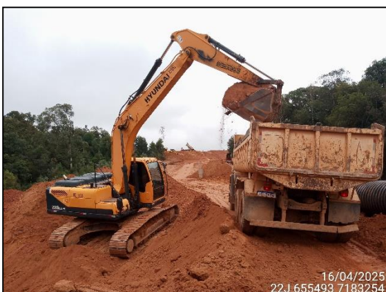
FIGURA 5: ESCAVAÇÃO PARA UTILIZAÇÃO DO MATERIAL EM ATERRO.
