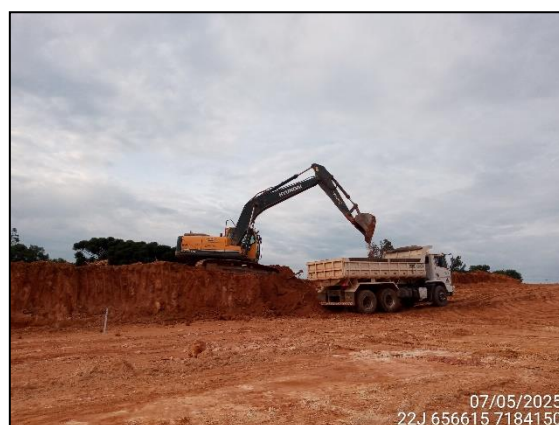
FIGURA 8: ESCAVAÇÃO PARA UTILIZAÇÃO DESSE MATERIAL EM ATERRO.
