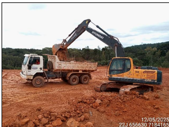
FIGURA 1: ESCAVAÇÃO PARA UTILIZAÇÃO DO MATERIAL EM ATERRO
