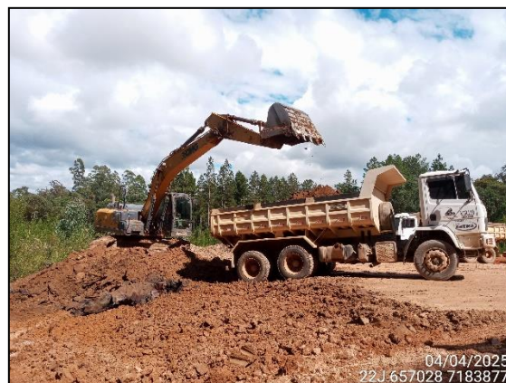
FIGURA 8: ESCAVAÇÃO DE CORTE PARA UTILIZAÇÃO DO MATERIAL EM ATERRO.
