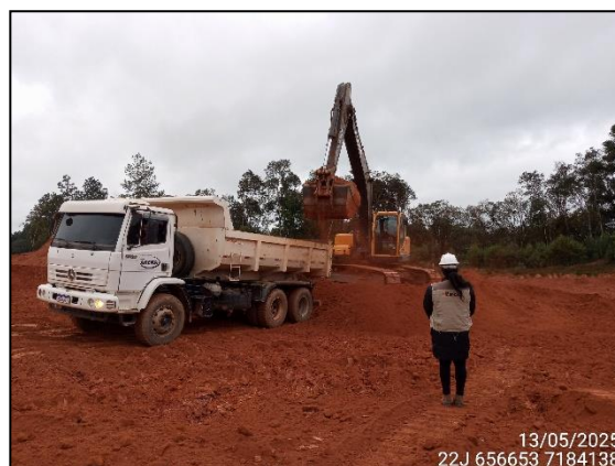
FIGURA 4: ARQUEOLOGA ACOMPANHANDO ESCAVAÇÃO PARA NIVELAMENTO DE CALÇADA.
