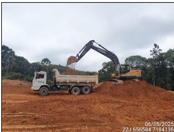
FIGURA 28: ESCAVAÇÃO PARA RETIRADA DE TERRA DESTINADA A ATERRO.
