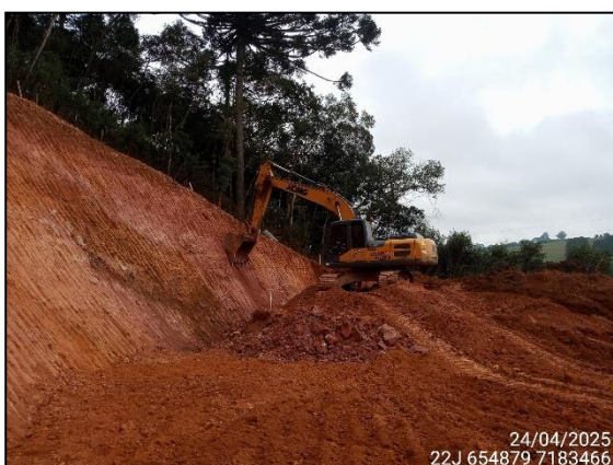
FIGURA 5: ESCAVAÇÃO DE RAMPA PARA PLANTAR GRAMA.
