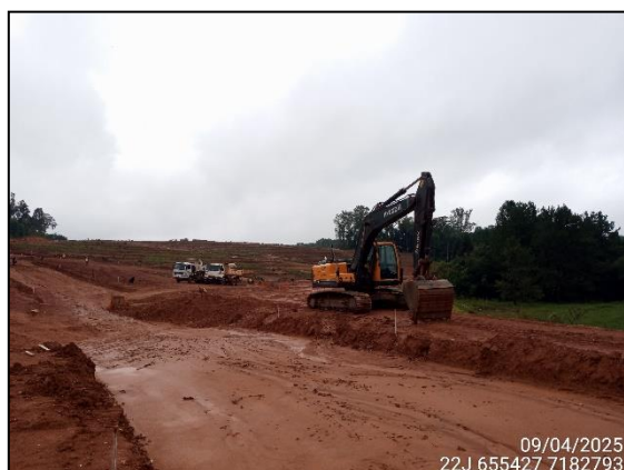
FIGURA 6: ATIVIDADE PARADA DEVIDO À CHUVA.
