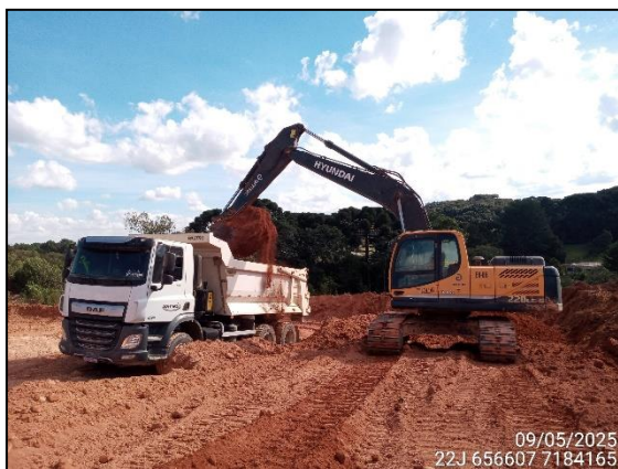
FIGURA 11: ESCAVAÇÃO PARA UTILIZAÇÃO DESSE MATERIAL EM ATERRO.
