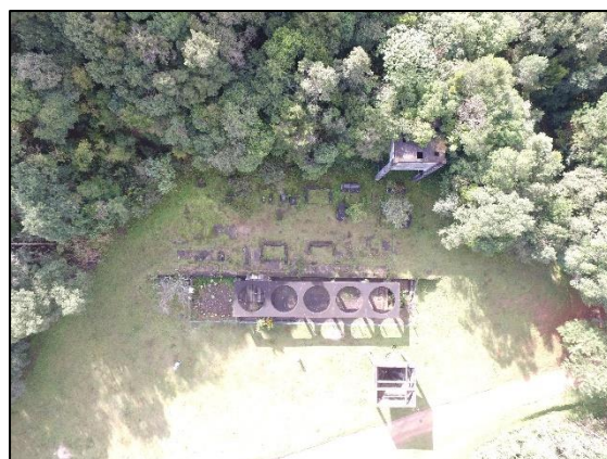
FIGURA 3: ESTRUTURA DA ANTIGA MINA TIMBUTUVA
