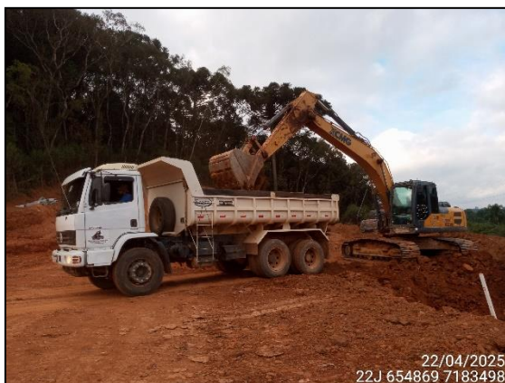
FIGURA 18: ESCAVAÇÃO PARA RETIRADA DE TERRA DESTINADO A ATERRO.
