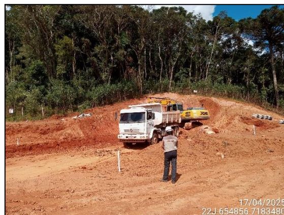
FIGURA 8: ARQUEOLOGA ACOMPANHANDO ESCAVAÇÃO PARA UTILIZAÇÃO DO MATERIAL EM ATERRO.
