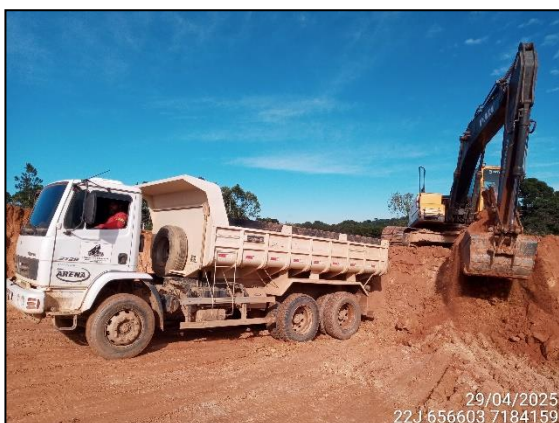
FIGURA 3: ESCAVAÇÃO PARA UTILIZAÇÃO DO MATERIAL EM ATERRO.
