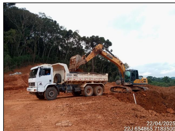
FIGURA 2: ESCAVAÇÃO PARA UTILIZAÇÃO DO MATERIAL EM ATERRO.
