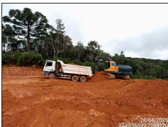
FIGURA 22: ESCAVAÇÃO DO MATERIAL PARA DESTINADO A ATERRO.
