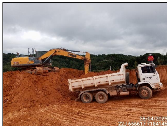
FIGURA 2: ESCAVAÇÃO PARA UTILIZAÇÃO DO MATERIAL EM ATERRO.
