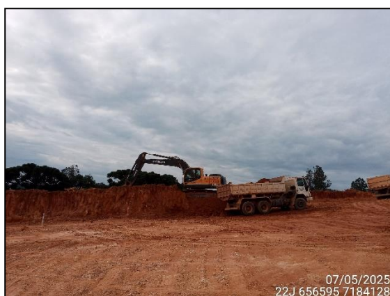
FIGURA 7: ESCAVAÇÃO PARA UTILIZAÇÃO DESSE MATERIAL EM ATERRO.
