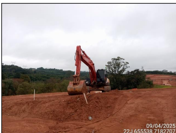
FIGURA 5: ATIVIDADE PARADA DEVIDO À CHUVA.
