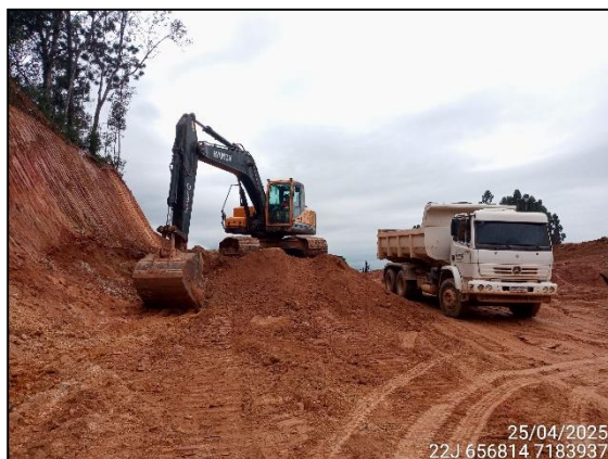
FIGURA 7: ESCAVAÇÃO DE RAMPA PARA PLANTAR GRAMA.
