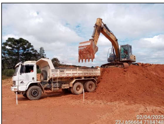
FIGURA 3: ESCAVAÇÃO DE CORTE PARA UTILIZAÇÃO DO MATERIAL EM ATERRO.
