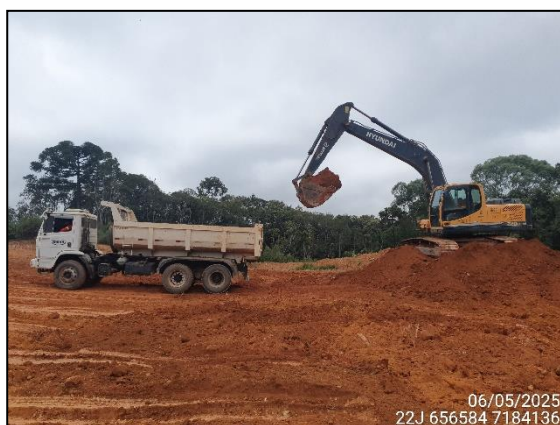
FIGURA 5: ESCAVAÇÃO PARA UTILIZAÇÃO DESSE MATERIAL EM ATERRO.
