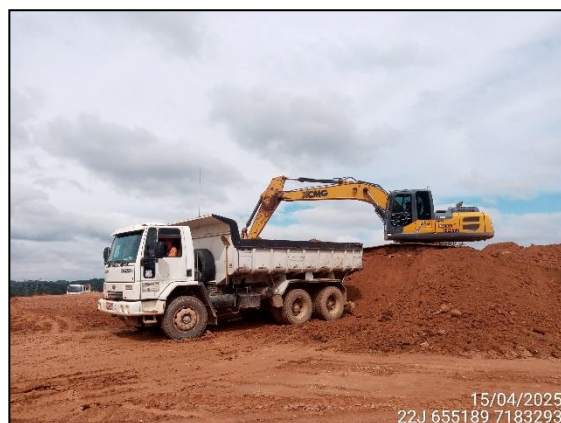
FIGURA 4: ESCAVAÇÃO PARA UTILIZAÇÃO DO MATERIAL EM ATERRO.
