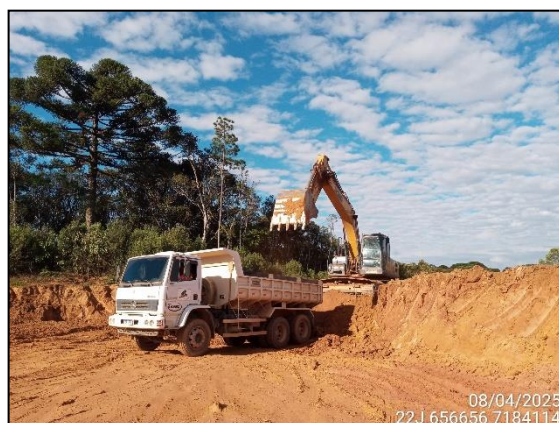
FIGURA 11: ESCAVAÇÃO PARA RETIRADA DE TERRA DESTINADO A ATERRO.
