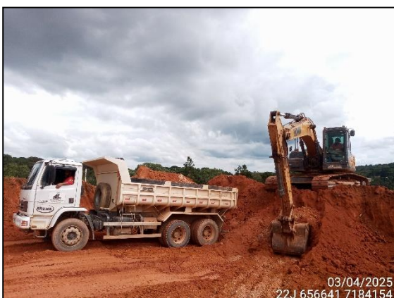
FIGURA 5: ESCAVAÇÃO DE CORTE PARA UTILIZAÇÃO DO MATERIAL EM ATERRO.
