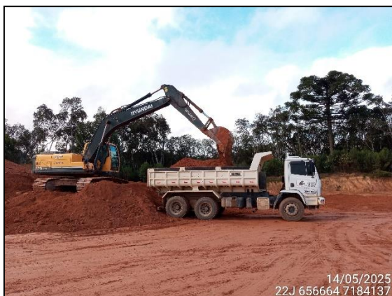
FIGURA 34: ESCAVAÇÃO PARA RETIRADA DE TERRA DESTINADA A ATERRO.
