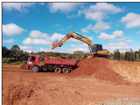
FIGURA 6: ESCAVAÇÃO PARA UTILIZAÇÃO DO MATERIAL EM ATERRO.
