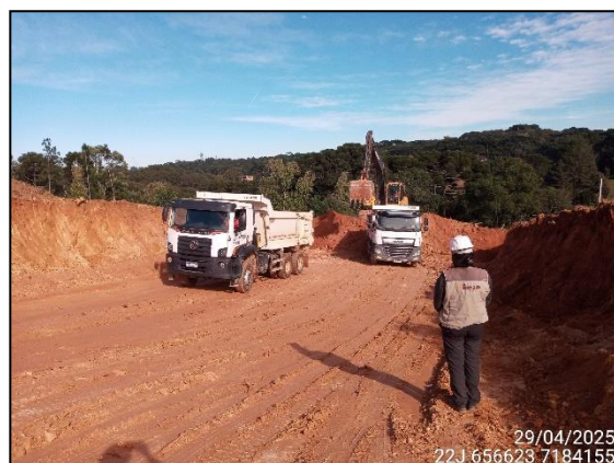
FIGURA 4: ARQUEÓLOGA ACOMPANHANDO ESCAVAÇÃO PARA NIVELAMENTO DE CALÇADA.
