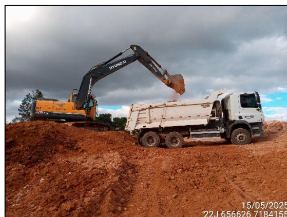
FIGURA 8: ESCAVAÇÃO PARA UTILIZAÇÃO DO MATERIAL EM ATERRO
