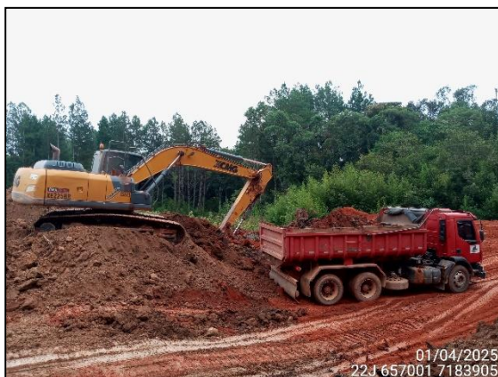
FIGURA 1: ESCAVAÇÃO E MOVIMENTAÇÃO DE OLERA.
