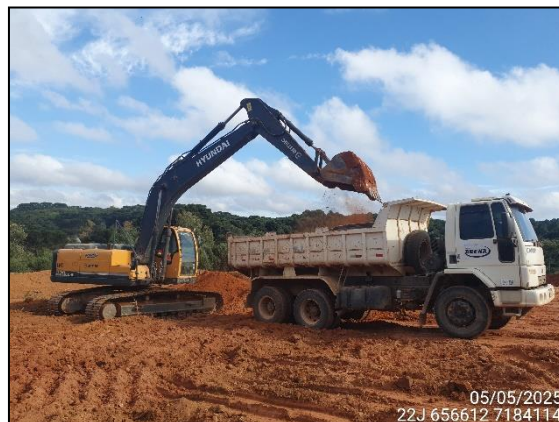
FIGURA 27: ESCAVAÇÃO PARA RETIRADA DE TERRA DESTINADA A ATERRO.
