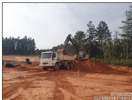
FIGURA 6: ESCAVAÇÃO PARA UTILIZAÇÃO DESSE MATERIAL EM ATERRO.
