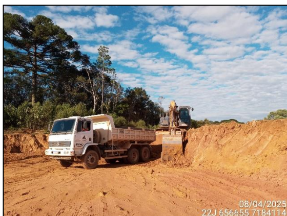
FIGURA 3: ESCAVAÇÃO PARA UTILIZAÇÃO DO MATERIAL EM ATERRO.
