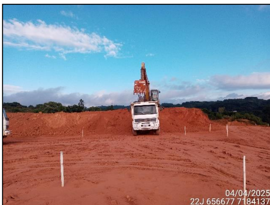
FIGURA 7: ESCAVAÇÃO DE CORTE PARA UTILIZAÇÃO DO MATERIAL EM ATERRO.
