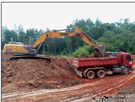
FIGURA 6: ESCAVAÇÃO PARA MOVIMENTAÇÃO DE OLERA.
