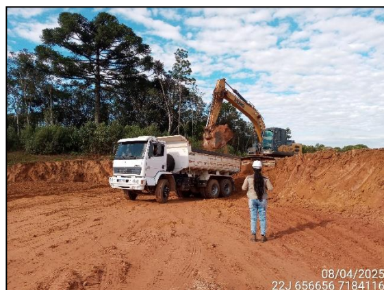
FIGURA 4: ARQUEOLOGA ACOMPANHANDO ESCAVAÇÃO PARA UTILIZAÇÃO EM ATERRO.
