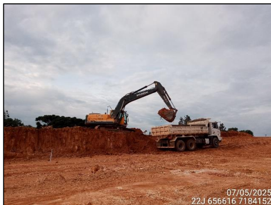
FIGURA 29: ESCAVAÇÃO PARA RETIRADA DE TERRA DESTINADA A ATERRO.
