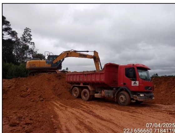
FIGURA 1: ESCAVAÇÃO PARA UTILIZAÇÃO DO MATERIAL EM ATERRO.
