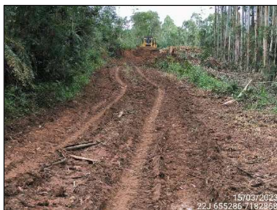
FIGURA 4: MANUTENÇÃO DE ACESSO.
