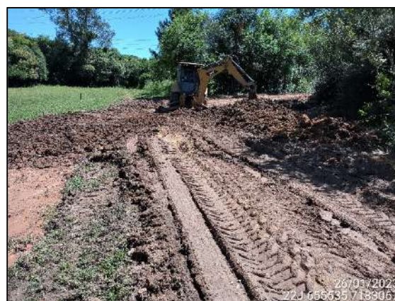
FIGURA 4: MANUTENÇÃO DE ACESSO.
