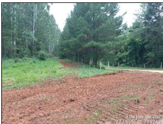
FIGURA 9: MANUTENÇÃO DO ACESSO.
