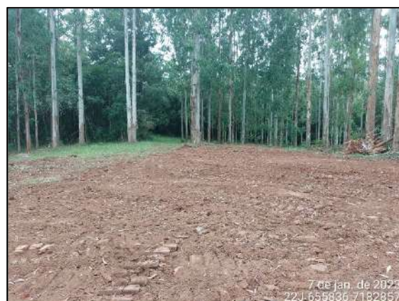
FIGURA 7: ABERTURA DO ACESSO.
