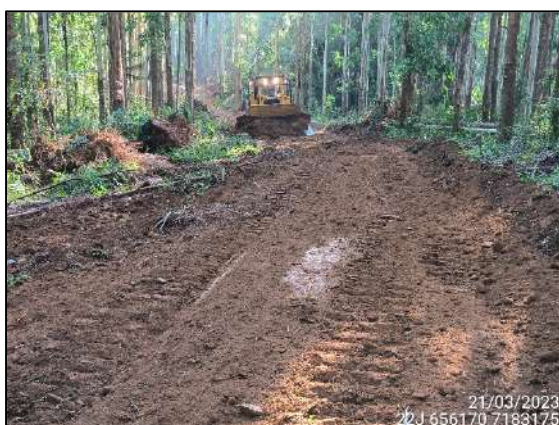
FIGURA 26: MANUTENÇÃO DE ACESSO.
