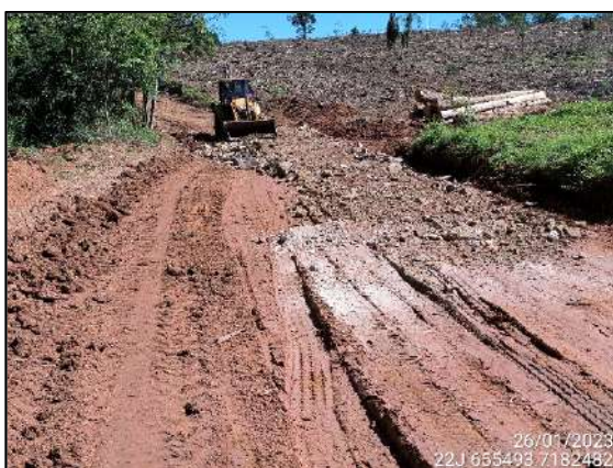
FIGURA 3: MANUTENÇÃO DE ACESSO.
