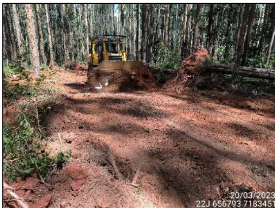
FIGURA 1: MANUTENÇÃO DE ACESSO.
