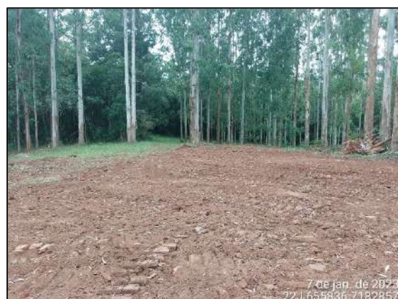
FIGURA 6: ABERTURA DE ACESSO.
