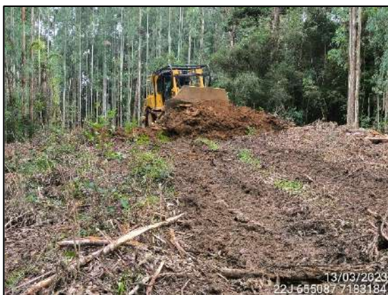
FIGURA 1: MANUTENÇÃO DE ACESSO.
