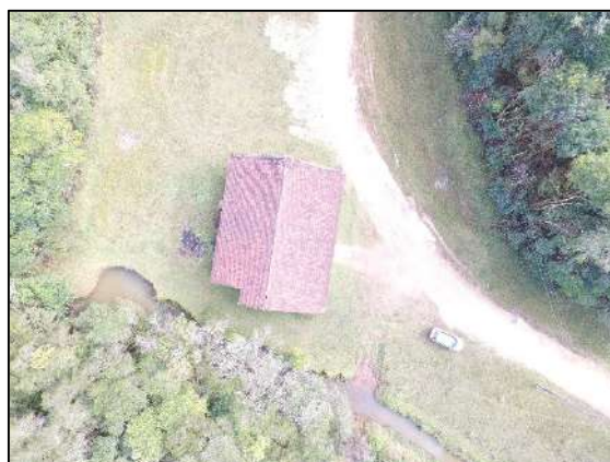
FIGURA 5: BARRACÃO DA ANTIGA MINA TIMBUTUVA
