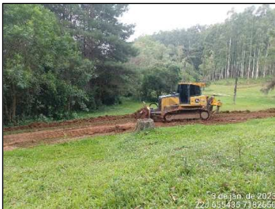
FIGURA 7: MANUTENÇÃO DO ACESSO.
