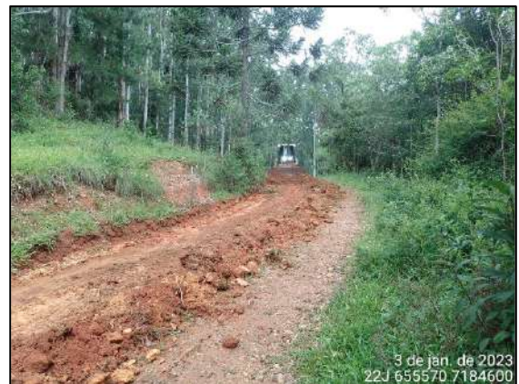
FIGURA 8: MANUTENÇÃO DO ACESSO.
