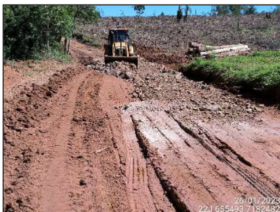
FIGURA 8: MANUTENÇÃO DO ACESSO.
