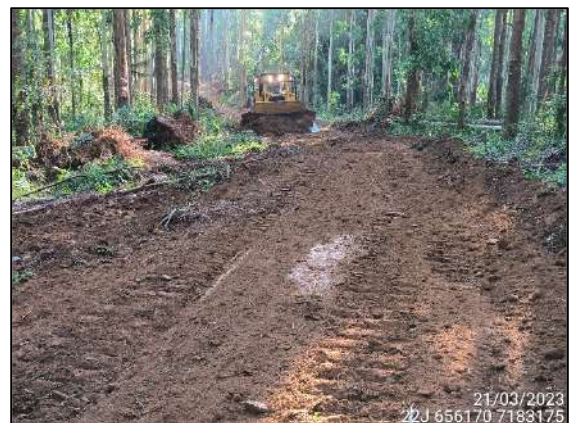
FIGURA 4: MANUTENÇÃO DE ACESSO.
