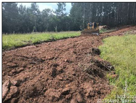
FIGURA 2: MANUTENÇÃO DE ACESSO.
