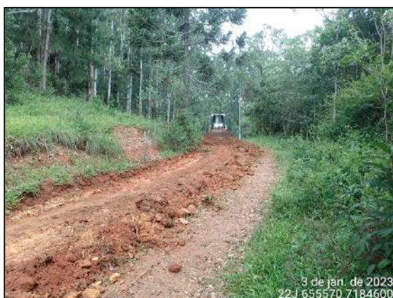
FIGURA 6: MANUTENÇÃO DO ACESSO.
