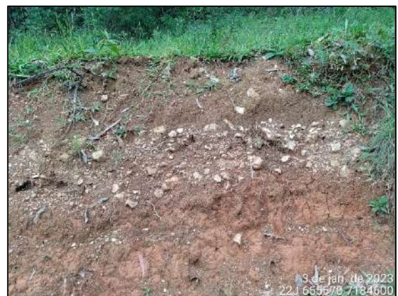
FIGURA 10: MANUTENÇÃO DO ACESSO.
