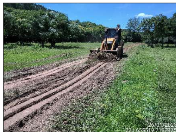
FIGURA 9: MANUTENÇÃO DO ACESSO.
