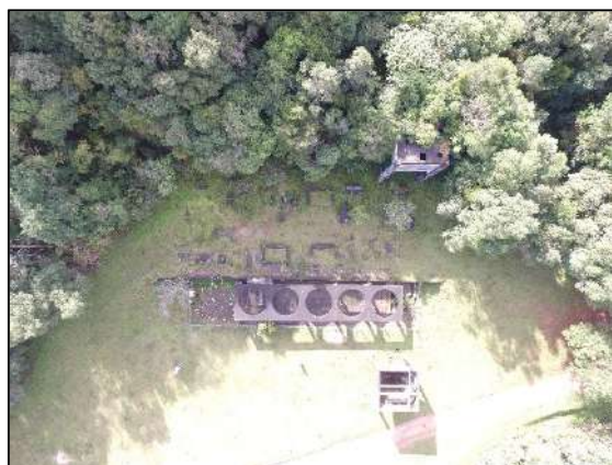
FIGURA 3: ESTRUTURA DA ANTIGA MINA TIMBUTUVA
