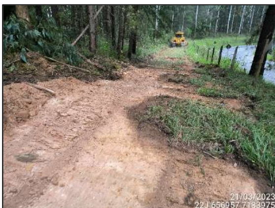
FIGURA 5: MANUTENÇÃO DE ACESSO.
