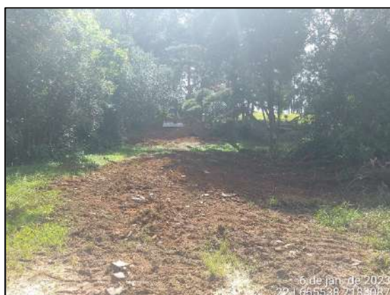
FIGURA 5: ABERTURA DE ACESSO.
