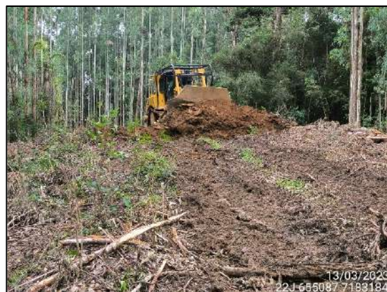
FIGURA 23: MANUTENÇÃO DE ACESSO.
