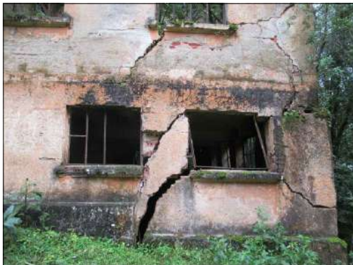
Rachaduras e Ausência de elementos na Fachada Sudoeste Acervo próprio, 2021.
