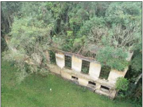
Edificação do Laboratório Coordenadas: 25°27'50.70"S / 49°27'24.81"O
