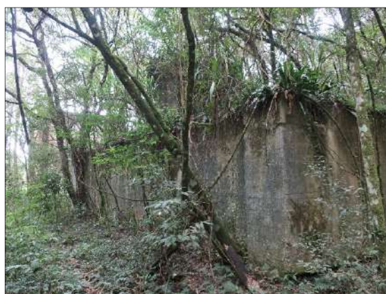
FIGURA 56: FUNDAÇÕES DE EDIFICAÇÃO [04]. FONTE: ESPAÇO ARQUEOLOGIA, 2021.
