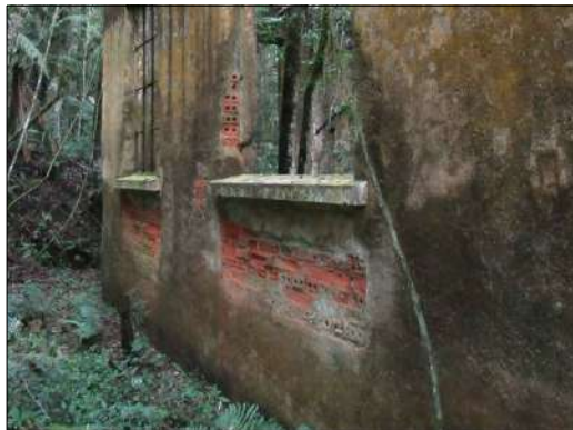
Desprendimento de argamassa e ausência de elementos na Fachada Sudoeste Acervo próprio, 2021.
