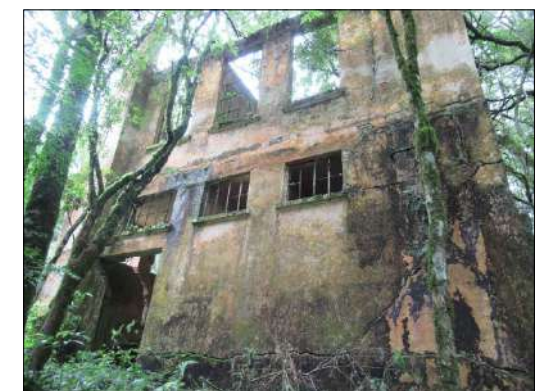
Fachada Nordeste Acervo próprio, 2021.
