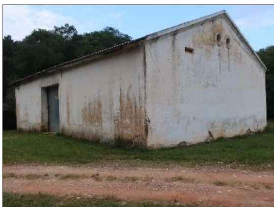
FIGURA 53: BARRACÃO [01]. FONTE: ESPAÇO ARQUEOLOGIA, 2021.
