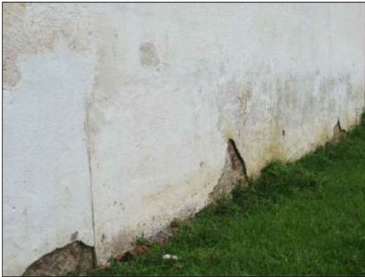
Desprendimento da argamassa na fachada Noroeste. Acervo próprio, 2021.
