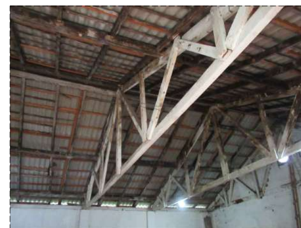
Estrutura da cobertura. Acervo próprio, 2021.
