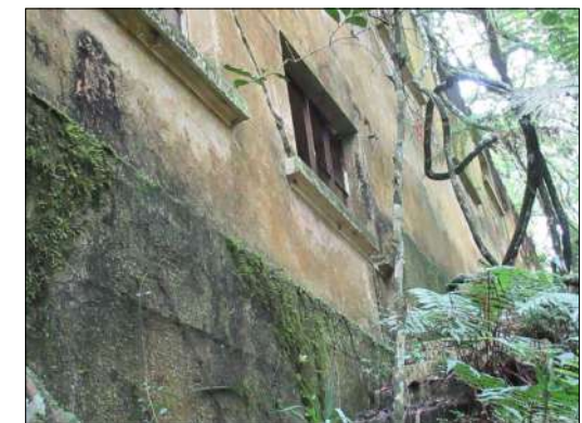
Parede de concreto moldado in loco como base para parede de alvenaria de tijolos Acervo próprio, 2021.
