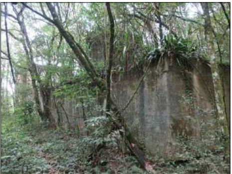
Fundações de Edificação Coordenadas: 25°27'48.22"S / 49°27'25.44"O
