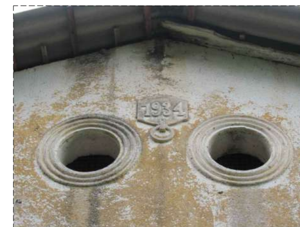
Inscrição do ano de construção na fachada Sudeste. Acervo próprio, 2021.
