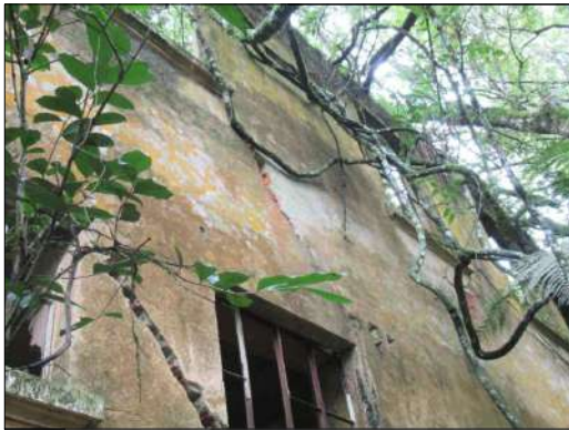
Rachaduras e Sujidade na Fachada Sudeste Acervo próprio, 2021.
