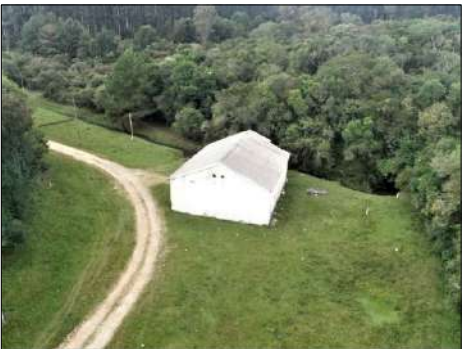
Barracão Coordenadas: 25°27'53.68"S / 49°27'20.99"O
