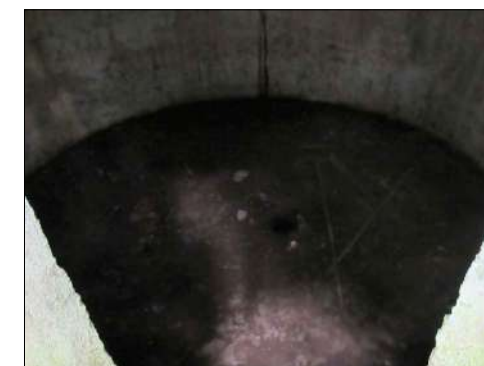
5 Pavimento no interior Acervo próprio, 2021.
