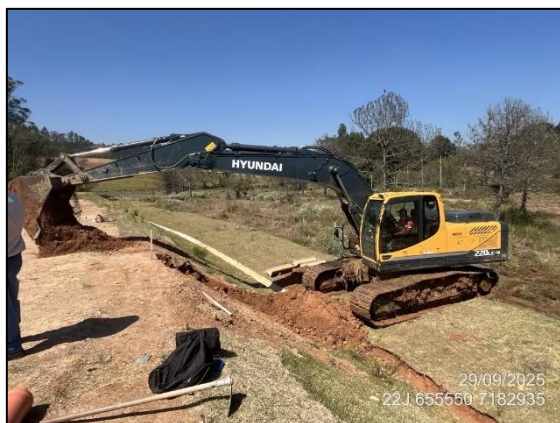
FIGURA 6: ESCAVAÇÃO PARA INSTALAÇÃO DE REDE DE ESGOTO
