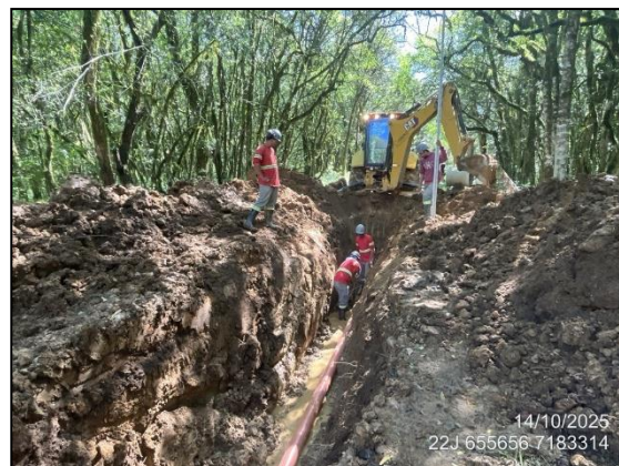
FIGURA 2: ABERTURA DE VALA PARA COLOCAÇÃO DE TUBULAÇÃO DE ESGOTO
