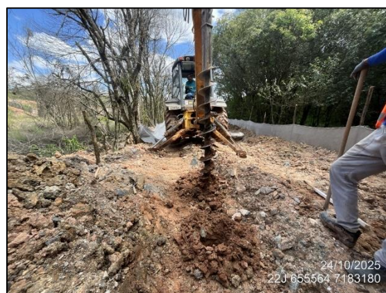
FIGURA 20: SONDAGEM PARA ESTAQUEAMENTO 02
