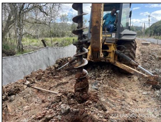
FIGURA 21: SONDAGEM PARA ESTAQUEAMENTO 03
