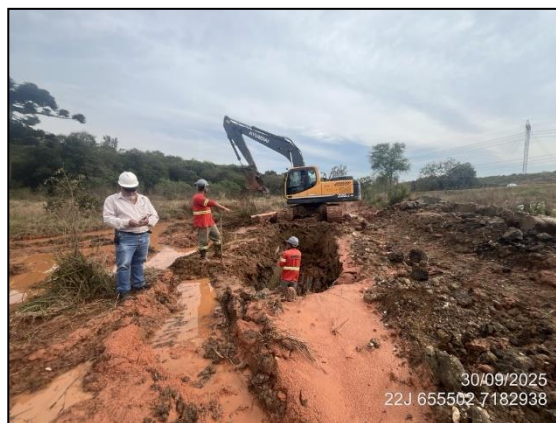
FIGURA 2: ABERTURA DE VALA PARA COLOCAÇÃO DE TUBULAÇÃO DE ESGOTO
