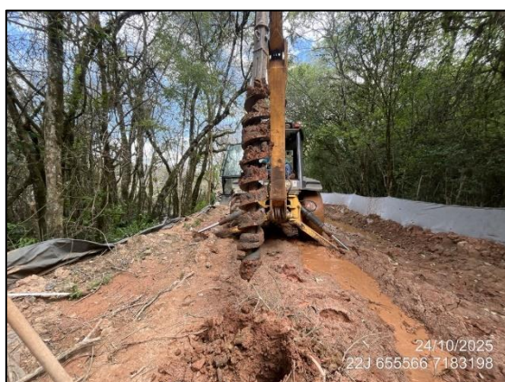
FIGURA 19: SONDAGEM PARA ESTAQUEAMENTO 01
