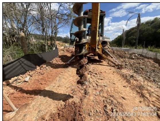
FIGURA 24: SONDAGEM PARA ESTAQUEAMENTO 06
