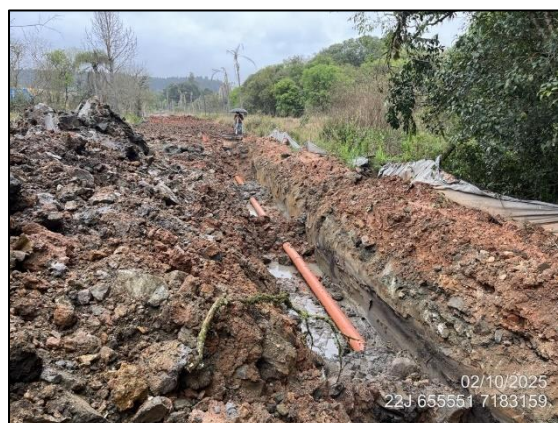
FIGURA 9: INSTALAÇÃO DE TUBULAÇÃO PARA REDE DE ESGOTO
