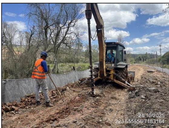
FIGURA 5: PERFURAÇÃO PARA ESTAQUEAMENTO – SONDAGEM 3
