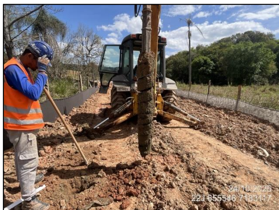
FIGURA 23: SONDAGEM PARA ESTAQUEAMENTO 05
