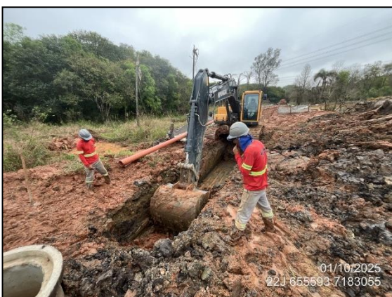
FIGURA 3: ABERTURA DE VALA PARA COLOCAÇÃO DE TUBULAÇÃO DE ESGOTO
