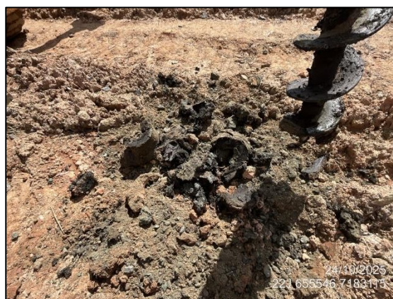
FIGURA 10: SEDIMENTO RETIRADO DA SONDAGEM 5, APROFUNDADA ATÉ 170 CM
