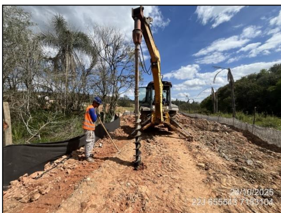
FIGURA 11: PERFURAÇÃO PARA ESTAQUEAMENTO – SONDAGEM 6
