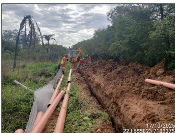
FIGURA 3: ABERTURA DE VALA PARA COLOCAÇÃO DE TUBULAÇÃO DE ESGOTO
