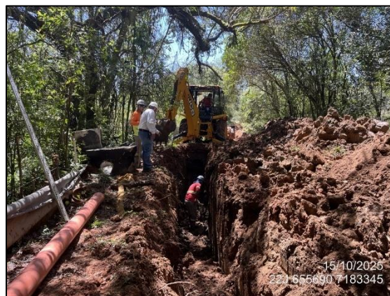
FIGURA 15: ESCAVAÇÃO PARA INSTALAÇÃO DE REDE DE ESGOTO
