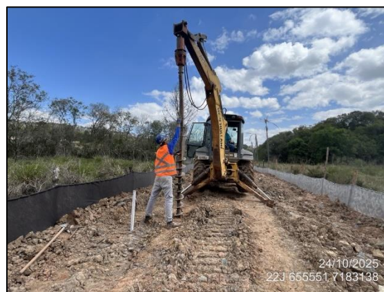
FIGURA 22: SONDAGEM PARA ESTAQUEAMENTO 04
