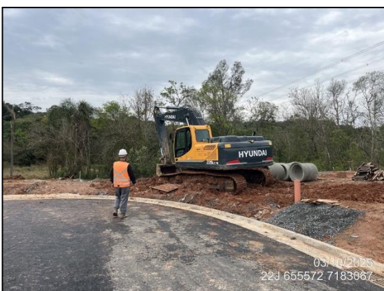
FIGURA 3: ÁREA DE FRENTE DE OBRA SEM EXECUÇÃO DE ESCAVAÇÕES NO DIA
