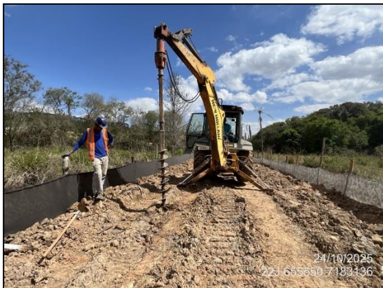
FIGURA 7: PERFURAÇÃO PARA ESTAQUEAMENTO – SONDAGEM 4
