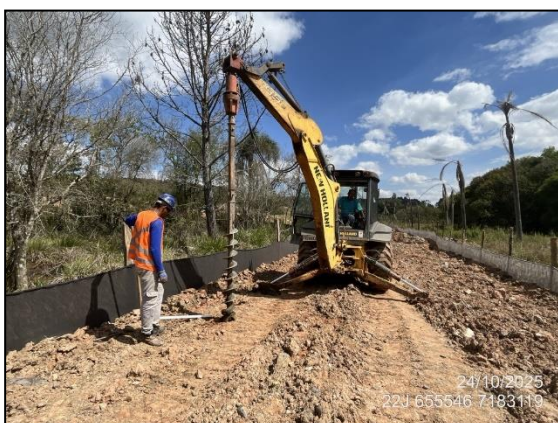
FIGURA 9: PERFURAÇÃO PARA ESTAQUEAMENTO – SONDAGEM 5
