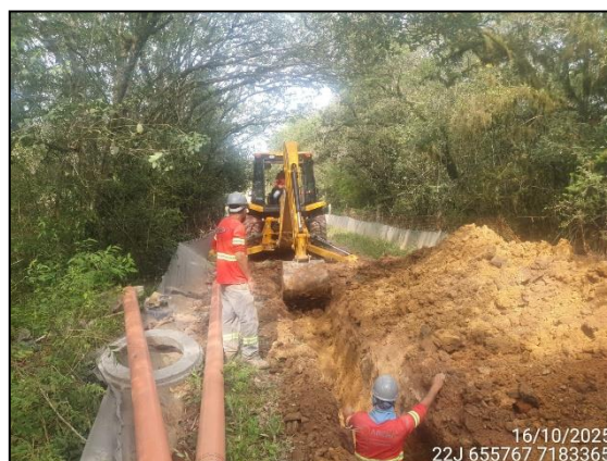
FIGURA 4: ABERTURA DE VALA PARA COLOCAÇÃO DE TUBULAÇÃO DE ESGOTO
