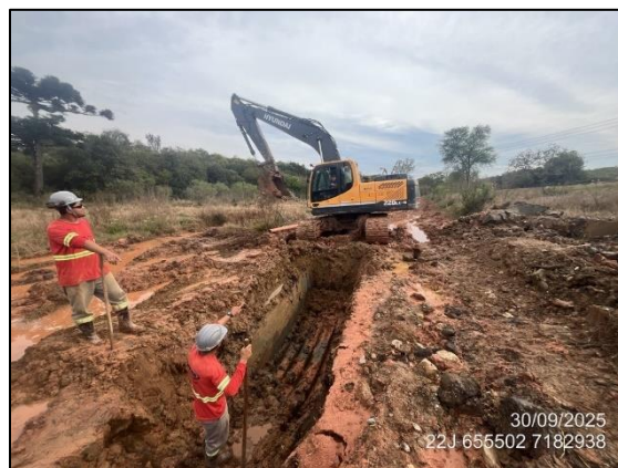
FIGURA 7: ESCAVAÇÃO PARA INSTALAÇÃO DE REDE DE ESGOTO
