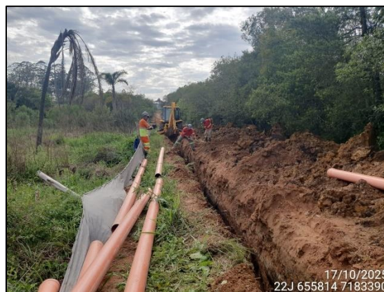
FIGURA 17: INSTALAÇÃO DE TUBULAÇÃO PARA REDE DE ESGOTO
