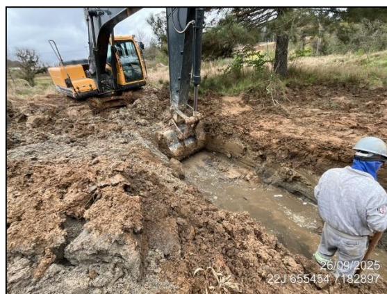
FIGURA 4: ABERTURA DE VALA PARA COLOCAÇÃO DE TUBULAÇÃO DE ESGOTO.
