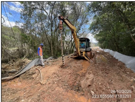
FIGURA 1: PERFURAÇÃO PARA ESTAQUEAMENTO – SONDAGEM 1
