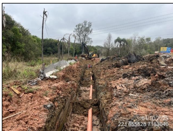
FIGURA 8: INSTALAÇÃO DE TUBULAÇÃO PARA REDE DE ESGOTO
