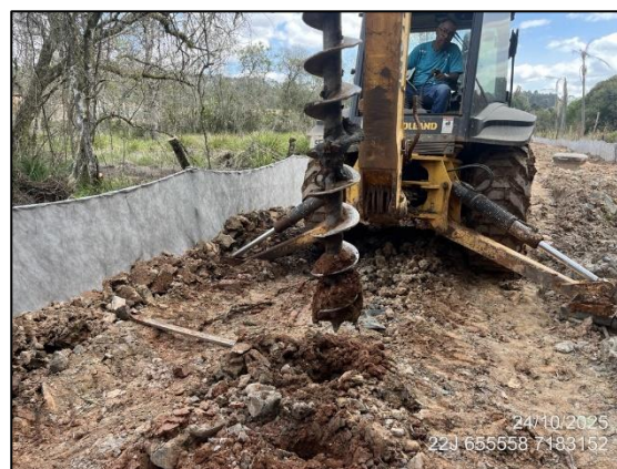
FIGURA 6: SONDAGEM 2 PERFURADA ATÉ 60 CM, ROCHA NA BASE
