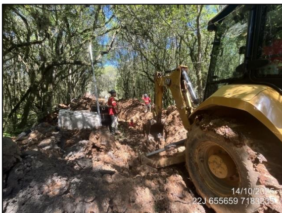
FIGURA 14: ESCAVAÇÃO PARA INSTALAÇÃO DE REDE DE ESGOTO
