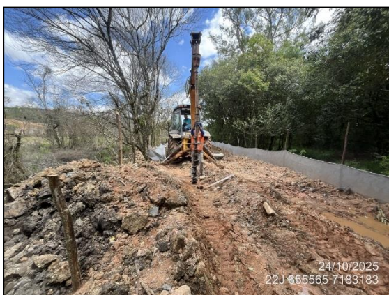
FIGURA 3: PERFURAÇÃO PARA ESTAQUEAMENTO – SONDAGEM 2
