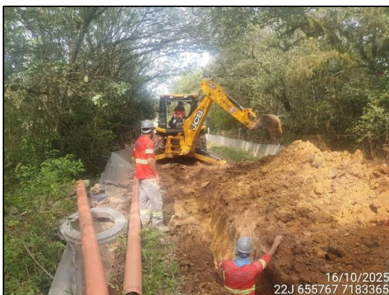
FIGURA 16: ESCAVAÇÃO PARA INSTALAÇÃO DE REDE DE ESGOTO
