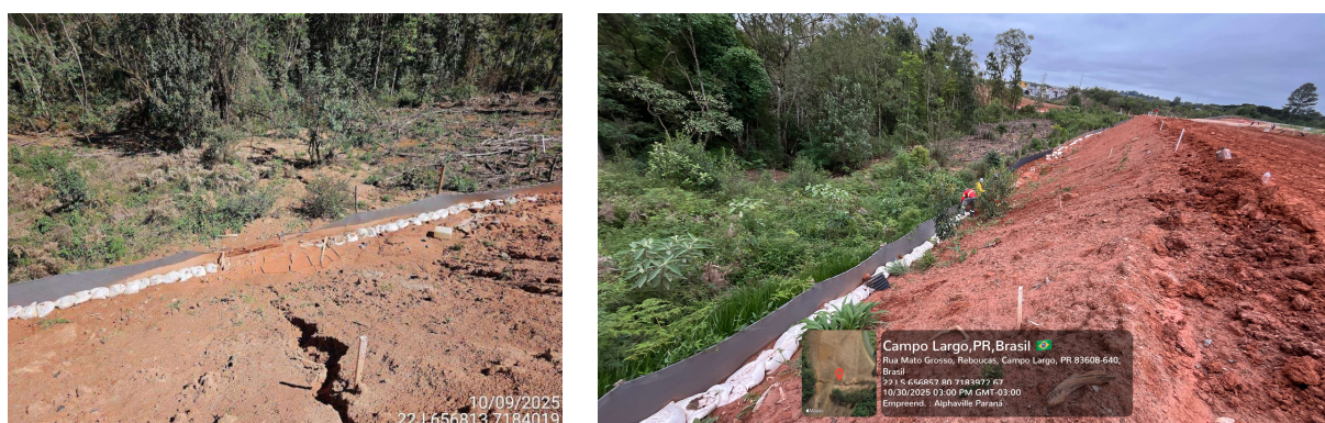
Figura 1 – A esquerda, exemplo de ponto de erosão identificado próximo à área de PRAD. A direita, ações corretivas executadas pelo empreendedor.
