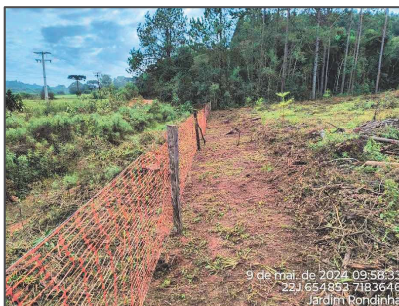
Figura 33 – Execução de aceiro (Polígono 3)
