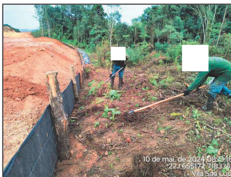
Figura 30 – Execução de aceiro (Polígono 2)
