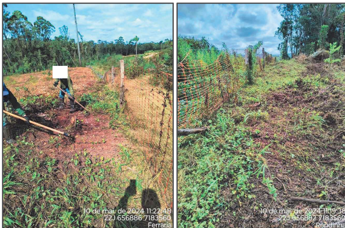
Figura 29 – Execução de aceiro (Polígono 1)
