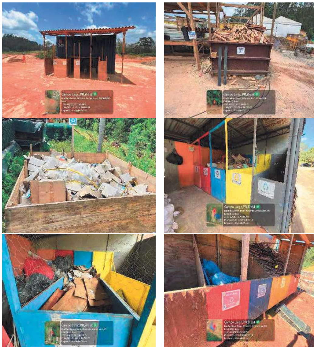
Figura 20 – Baías para armazenamento de resíduos Classe B
