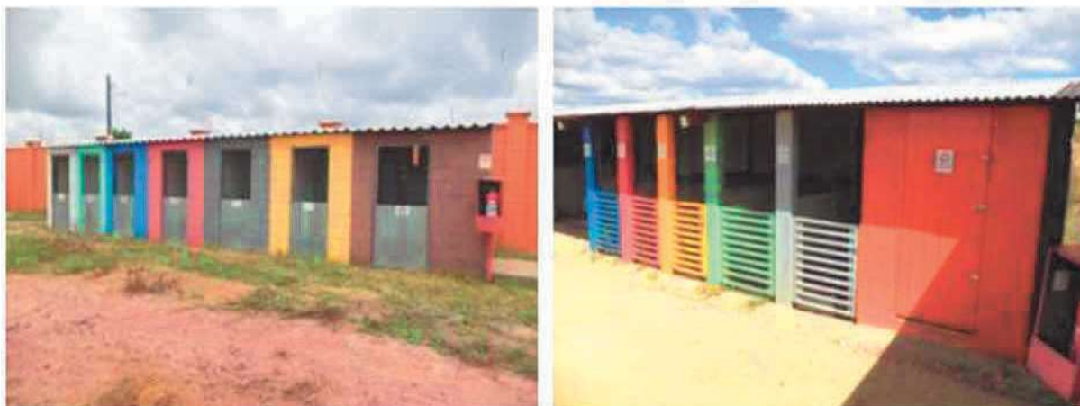
Figura 6 – Exemplos baia para alocação provisória de resíduos de obra
