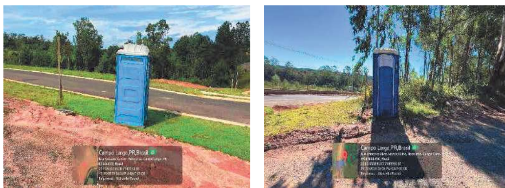
Figura 30 – Banheiros químicos e sanitários containers disponíveis aos colaboradores
