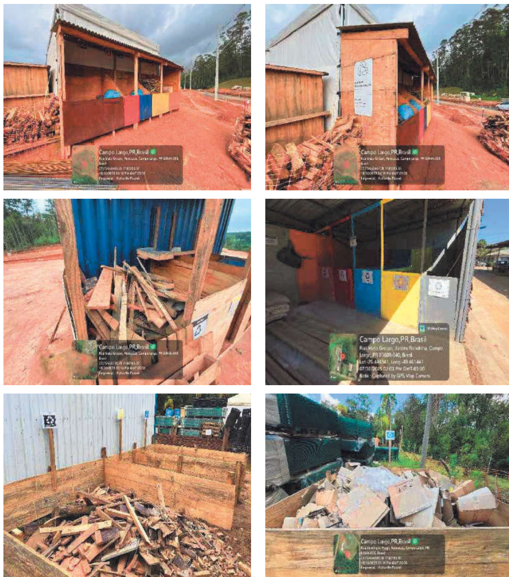
Figura 6 – Baías para armazenamento de resíduos
