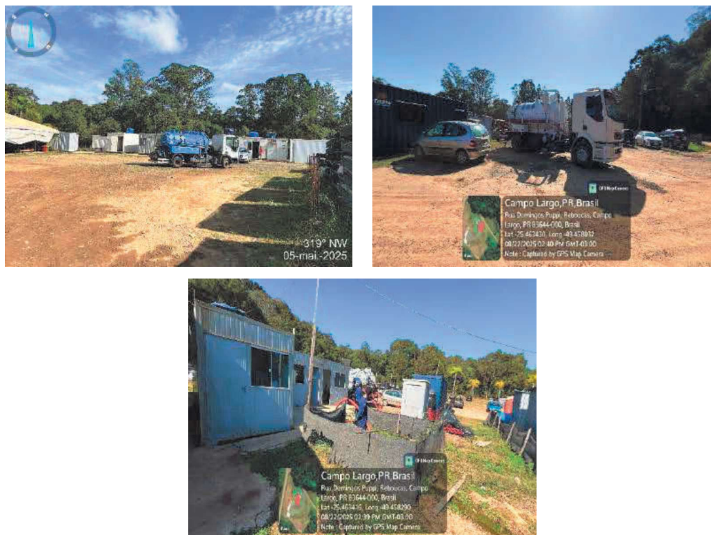
Figura 17 – Tanques impermeáveis para armazenamento do efluente
