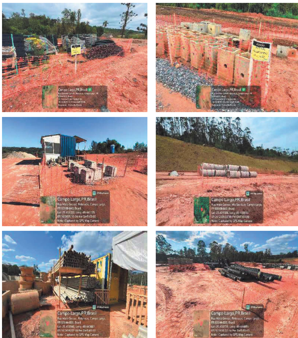
Figura 18 – Limpeza e organização geral do empreendimento
