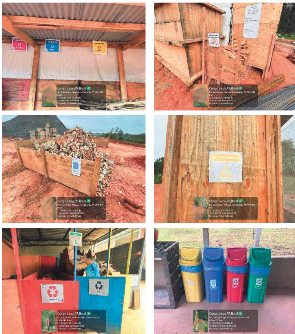
Figura 19 – Sinalizações diversas em consonância com o PGRCC
