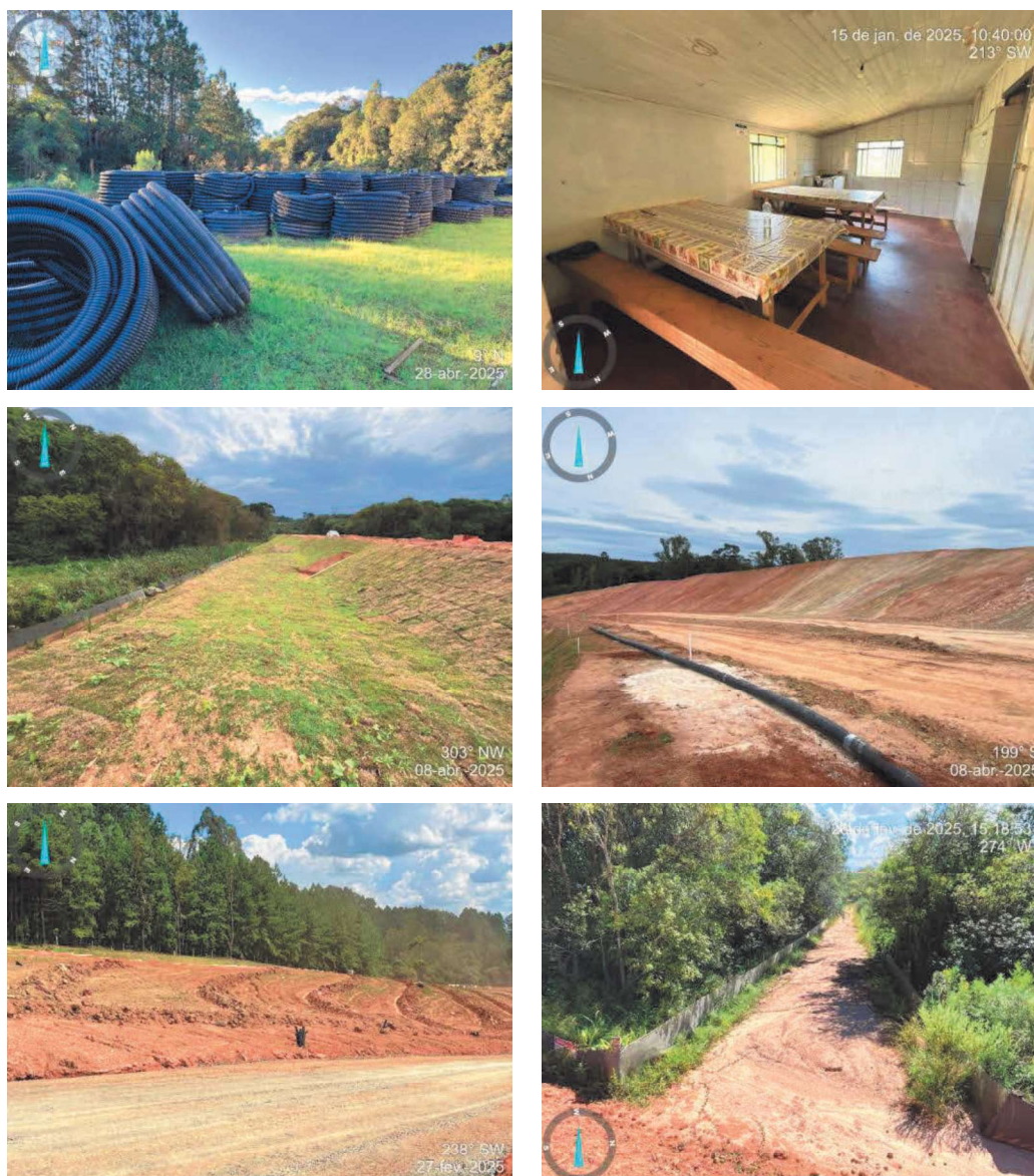
Figura 18 – Limpeza e organização geral do empreendimento
