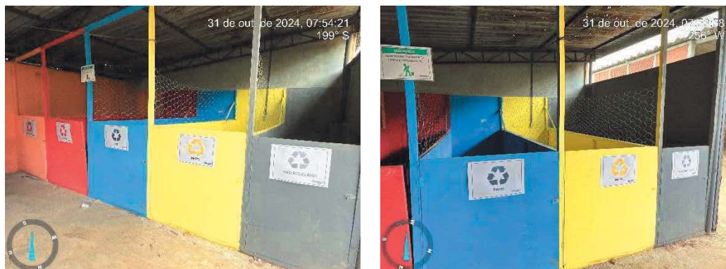
Figura 6 – Baias para armazenamento de resíduos
