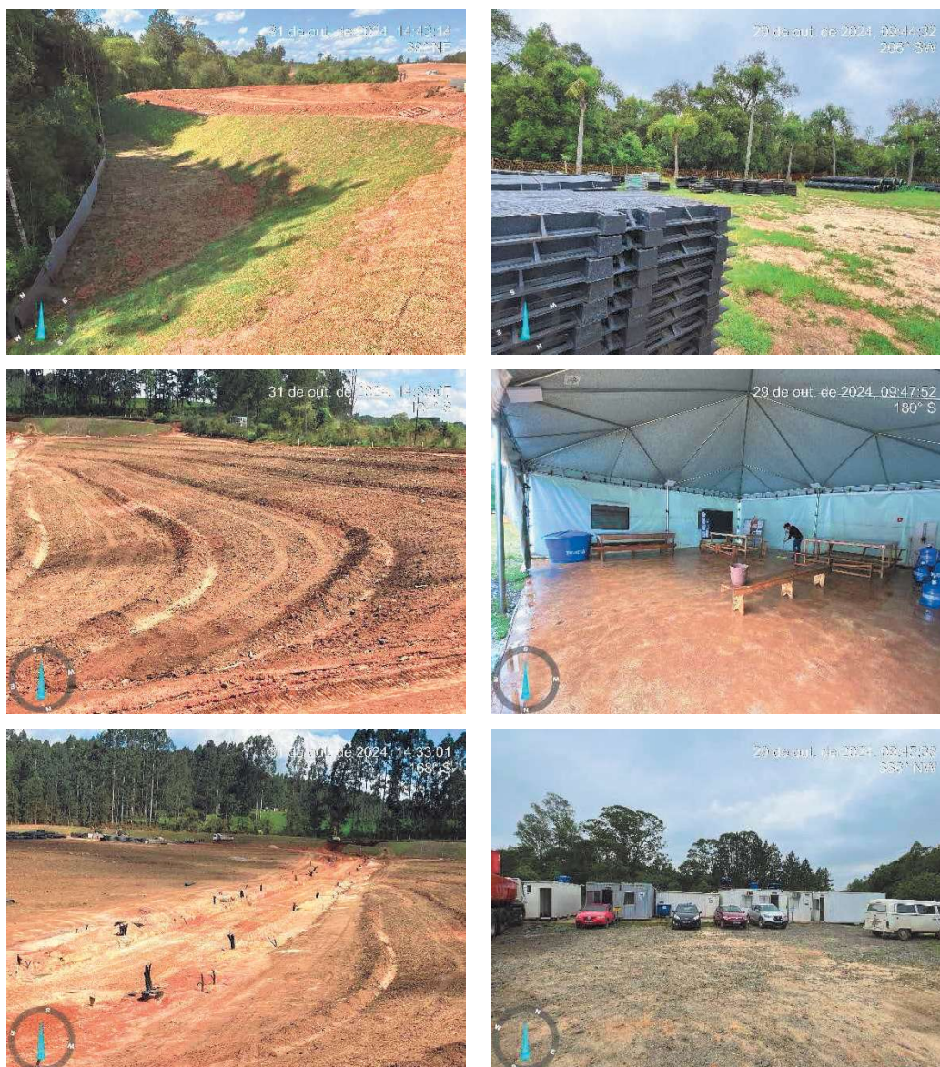
Figura 12 – Limpeza e organização geral do empreendimento
