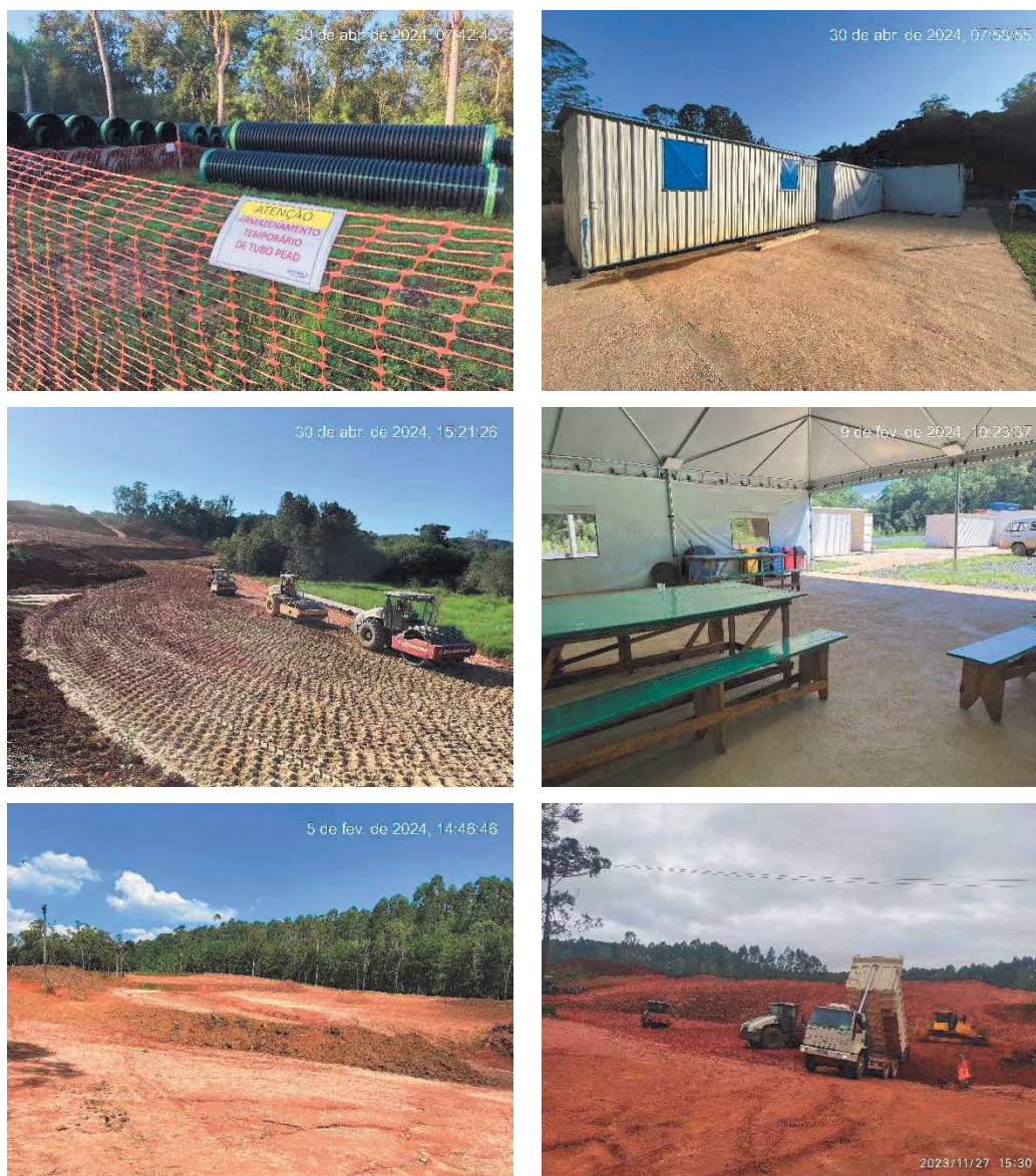
Figura 8 – Limpeza e organização geral do empreendimento
