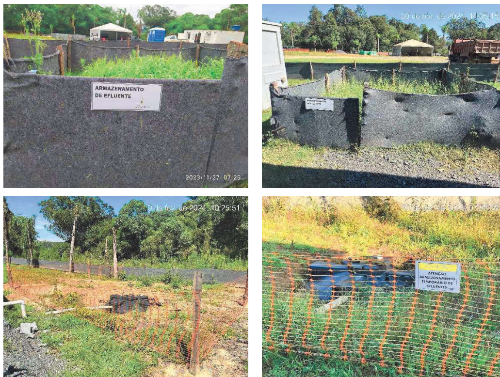
Figura 7 – Tanques impermeáveis para armazenamento do efluente
