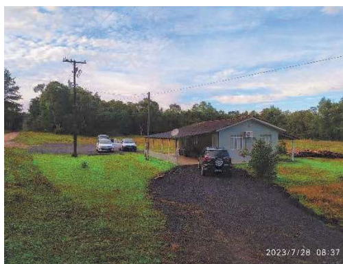
Figura 9 – Escritório técnico administrativo reformado
