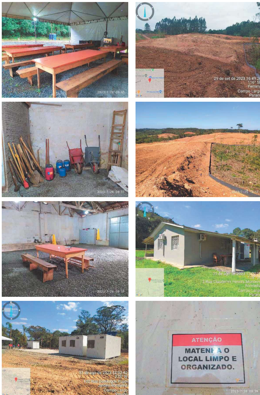
Figura 16 – Limpeza e organização geral do empreendimento
