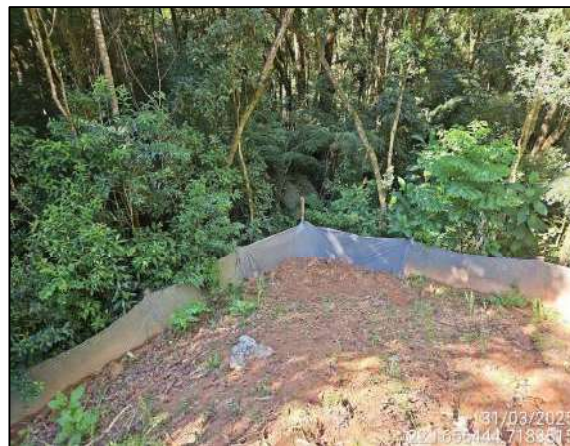
Figura 23. Sistema de contenção de sedimentos em área de solo exposto e barreira física em área de declive.
