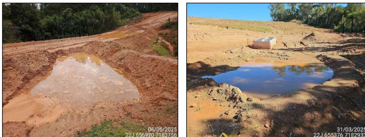
Figura 25. Medidas adotadas para a preservação dos recursos hídricos, como sistemas de contenção de sedimentos.
