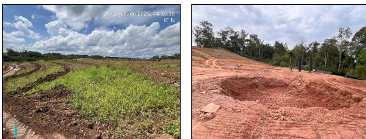
Figura 27. Práticas de recuperação ambiental com revegetação de áreas degradadas e escavação de bacias de contenção para controle de sedimentos.
