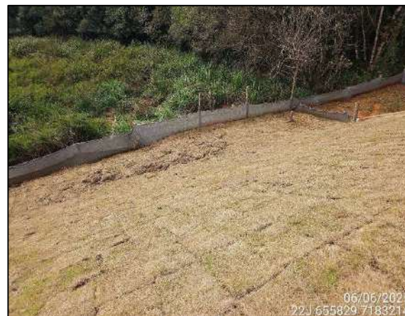
Figura 24. Barreira de contenção ao longo do talude para contenção e prevenção de sedimentos para proteção dos recursos hídricos.
