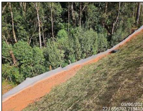
Figura 24. Barreira de contenção ao longo do talude para contenção e prevenção de sedimentos para proteção dos recursos hídricos.
