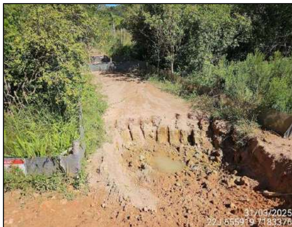
Figura 23. Sistema de contenção de sedimentos em área de solo exposto e barreira física em área de declive.
