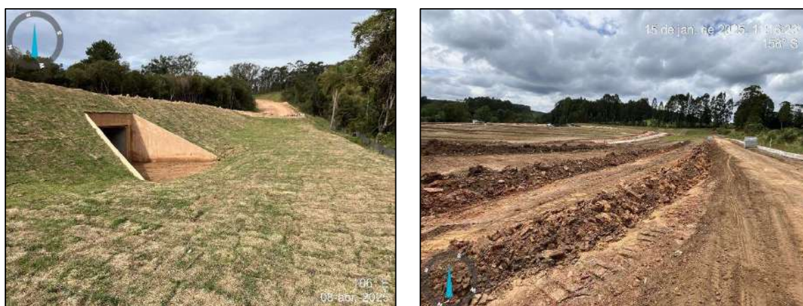
Figura 26. Ações preventivas para o controle de erosão e assoreamento, com implantação de canais de drenagem provisórios e delimitação de áreas de intervenção.
