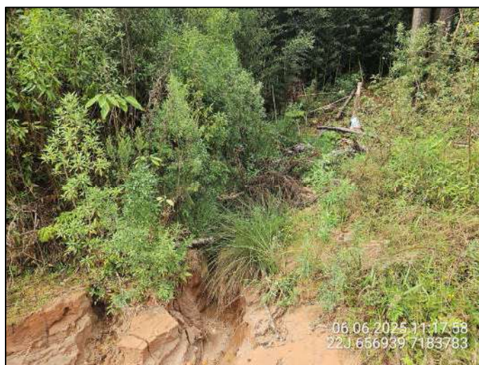
Figura 17. Ponto P07 - afluente da margem esquerda do rio Timbutuva.
