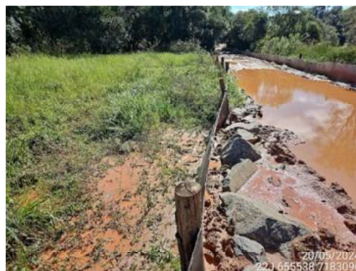
Figura 24. Medidas adotadas para a preservação dos recursos hídricos, como sistemas de contenção de sedimentos
