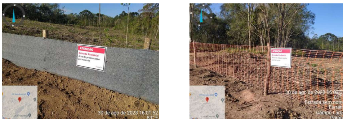
Figura 22. Medidas adotadas para a preservação dos recursos hídricos, como proteção das Áreas de Preservação Permanentes (APP).
