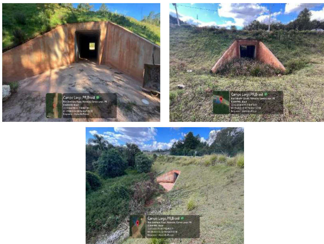
Figura 31 – Passagens de fauna subterrâneas
