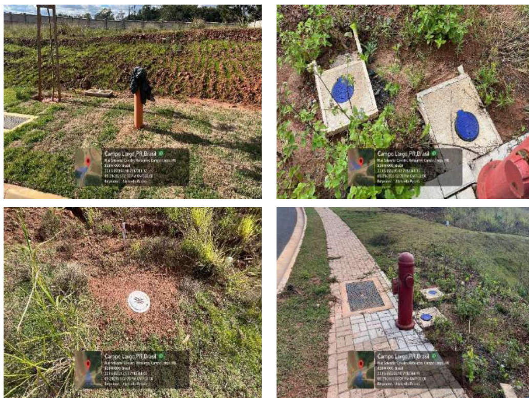
Figura 21 – Execução das redes de abastecimento de água e esgotamento sanitário
