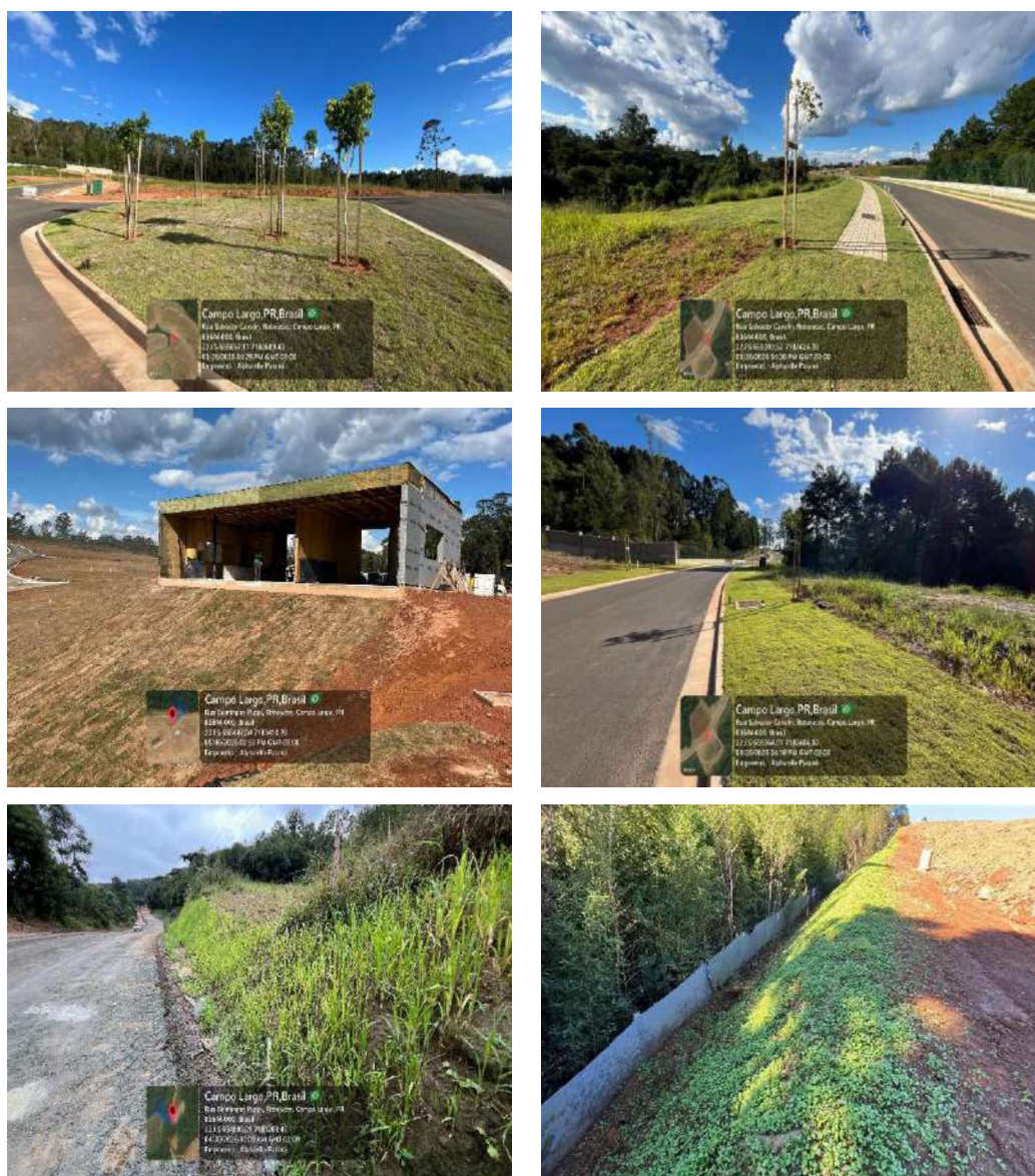
Figura 30 – Execução do paisagismo ornamental e de proteção
