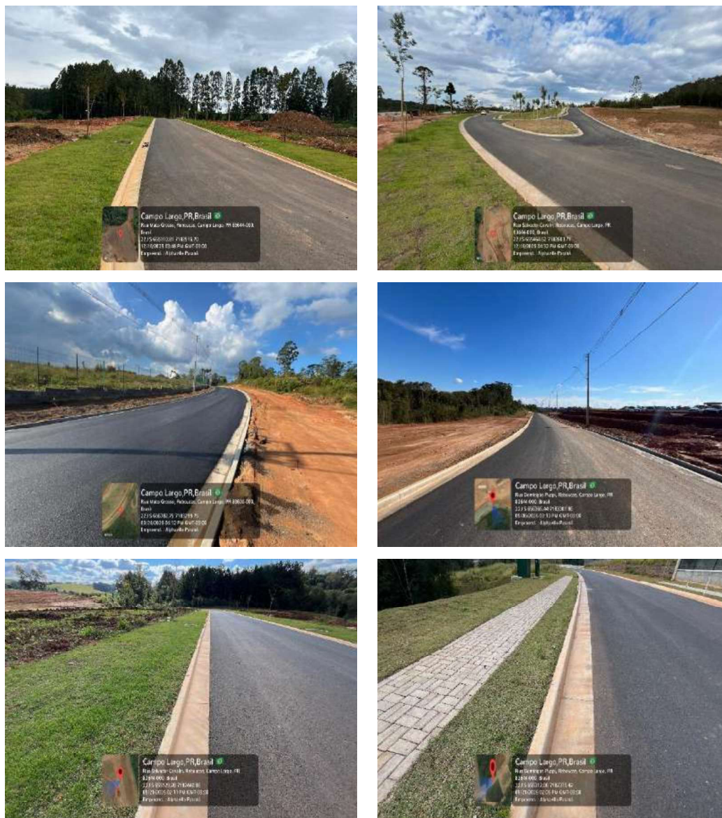
Figura 22 – Execução de guias, sarjetas e pavimentação
