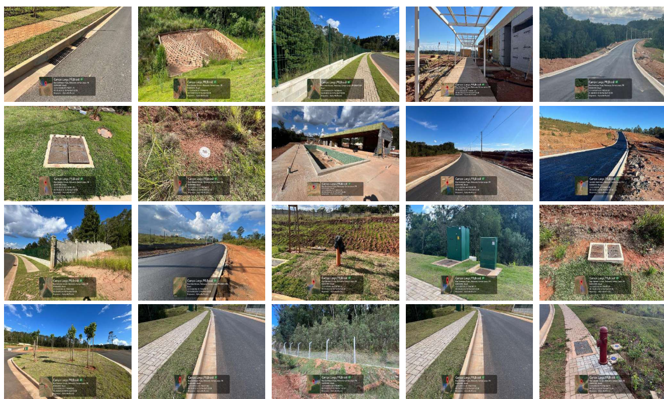
Figura 5 – Serviços executados no empreendimento Alphaville Paraná (novembro de 2025 a abril de 2026)
