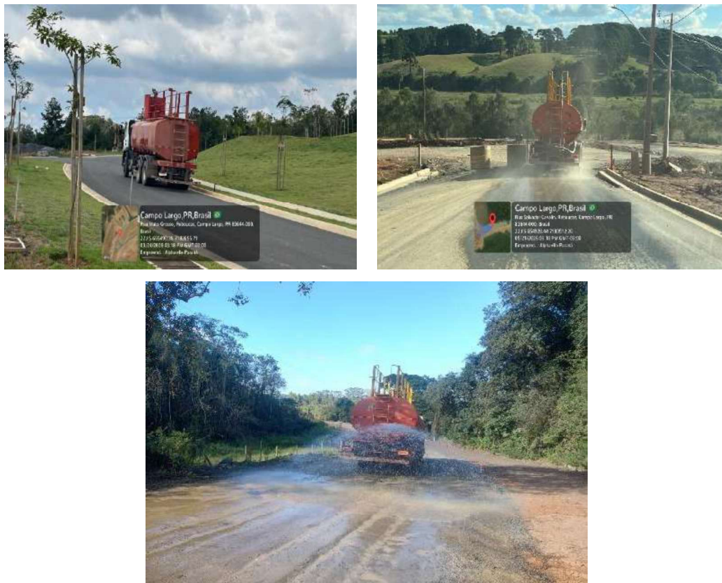
Figura 16 – Controle da poeira por meio do umedecimento das vias internas
