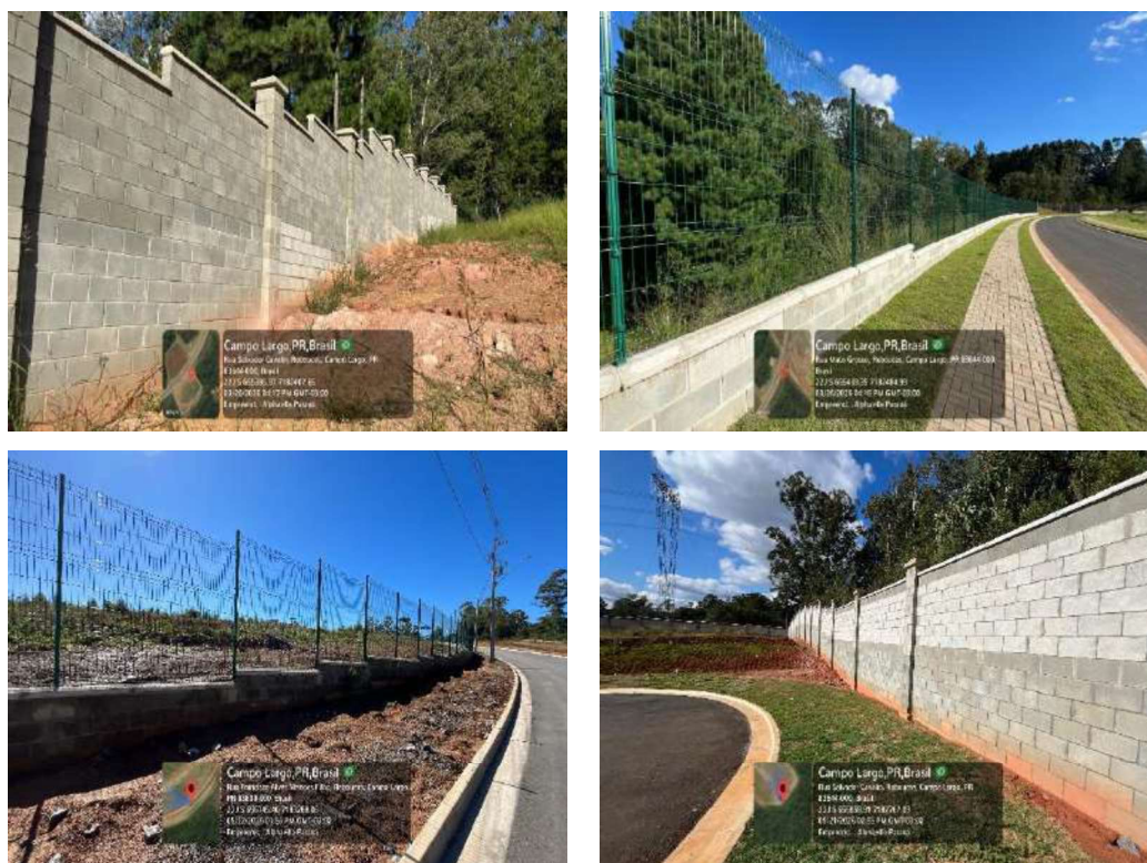
Figura 7 – Execução do fechamento definitivo do empreendimento
