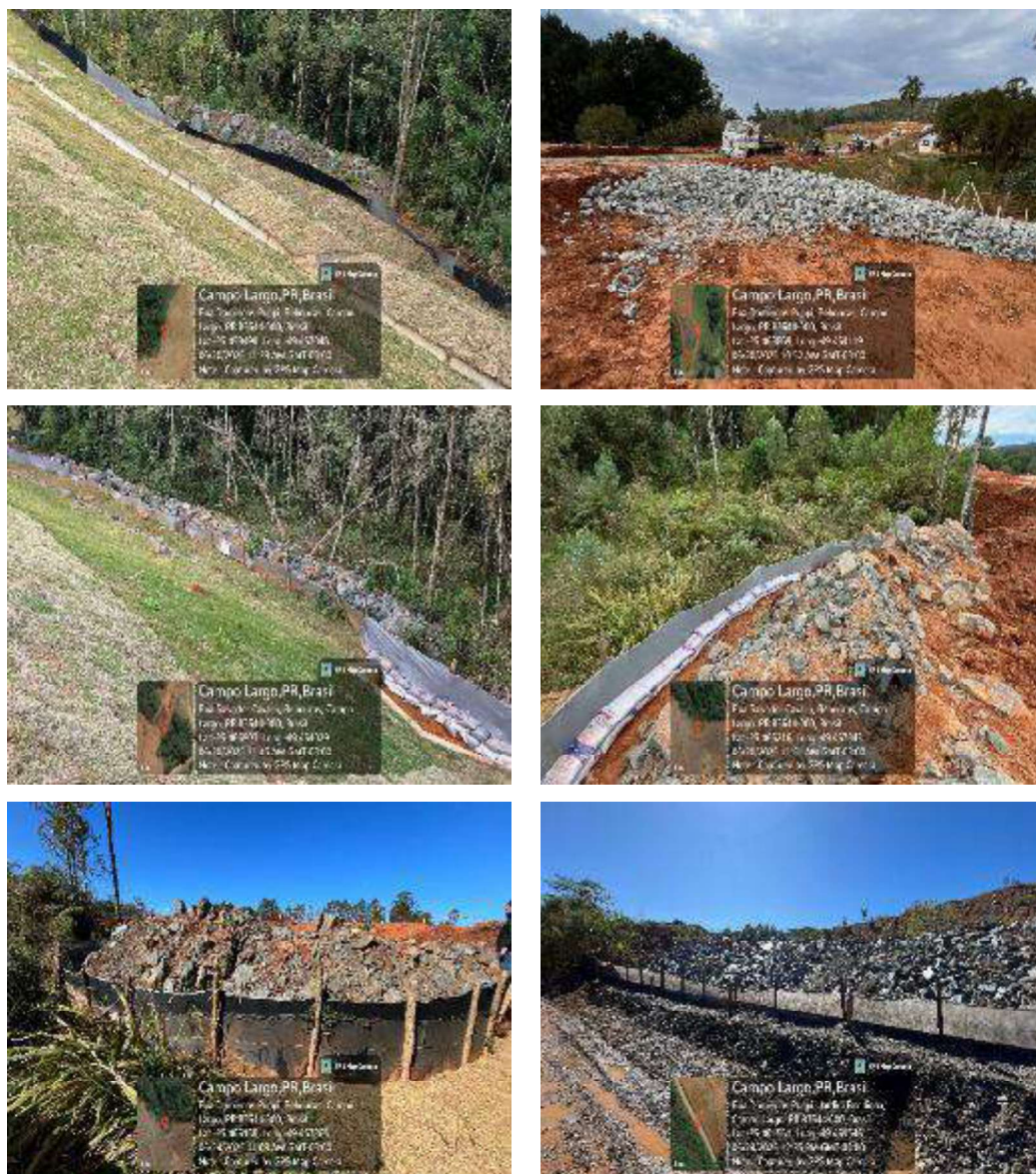
Figura 15 – Rachões para filtragem de sedimentos
