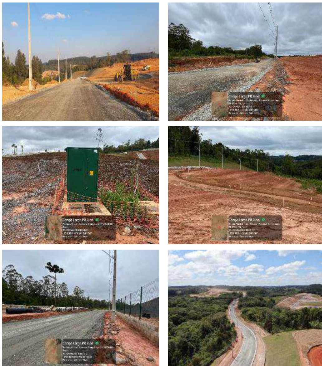
Figura 19 – Execução da rede elétrica
