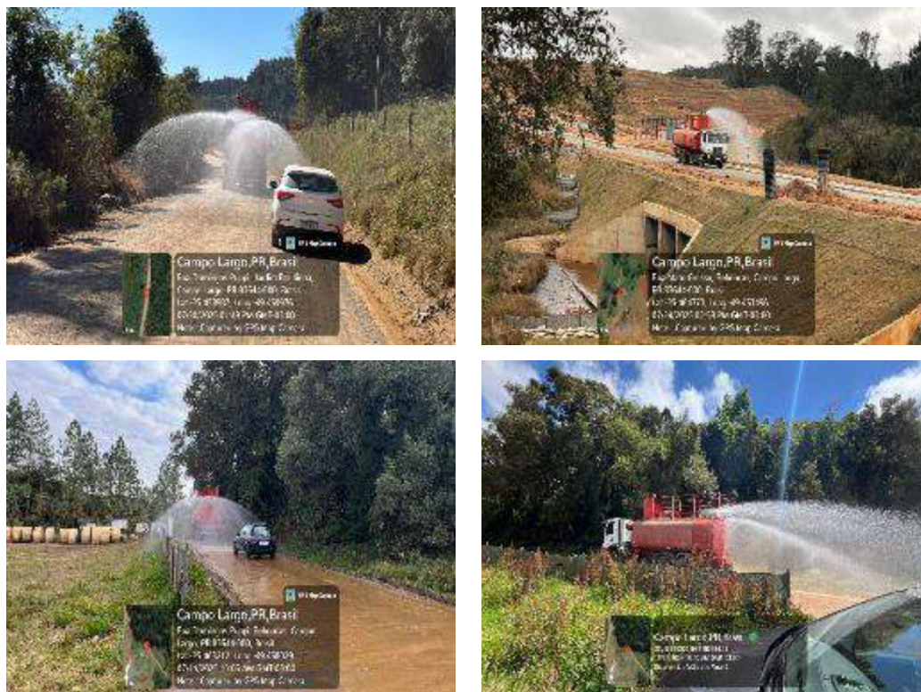
Figura 11 – Controle da poeira por meio do umedecimento das vias internas
