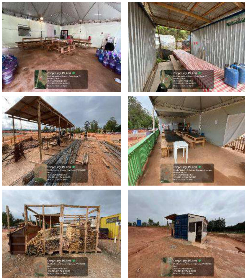
Figura 3 – Estruturas provisórias do Canteiro de Obras
