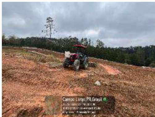
Figura 5 – Semeadura das quadras com terraplenagem finalizada
