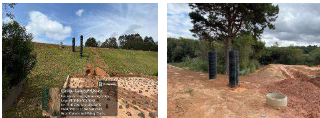
Figura 13 – Exemplo de Unidade de Qualidade de Águas de Chuva – DrenPro WQU implantada
