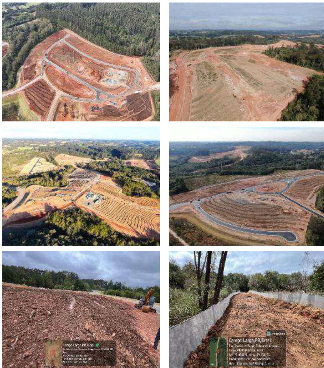
Figura 4 – Execução da terraplenagem e retorno da camada vegetal para quadras e áreas verdes
