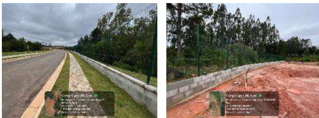
Figura 2 – Execução do fechamento do empreendimento
