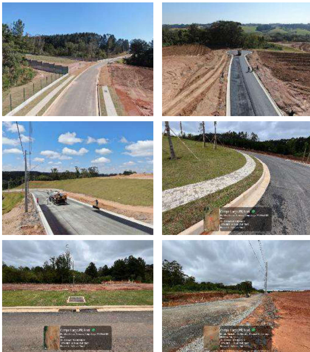
Figura 18 – Execução de guias, sarjetas e pavimentação
