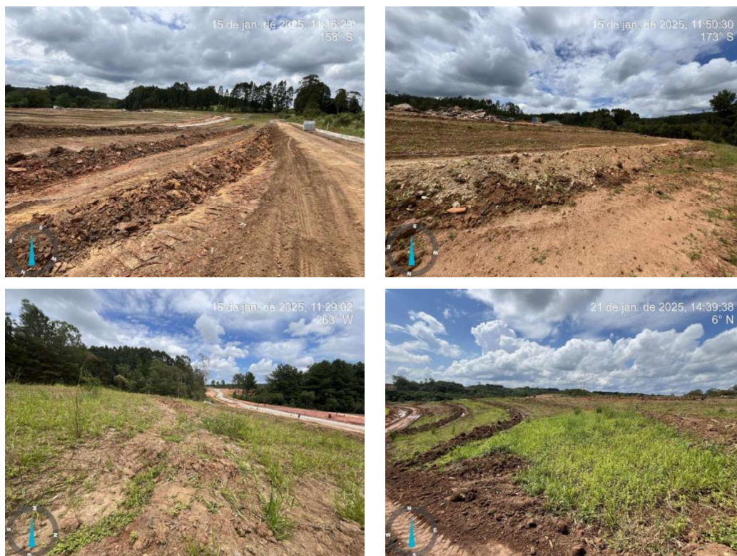
Figura 4 – Retorno da camada vegetal para quadras e áreas verdes
