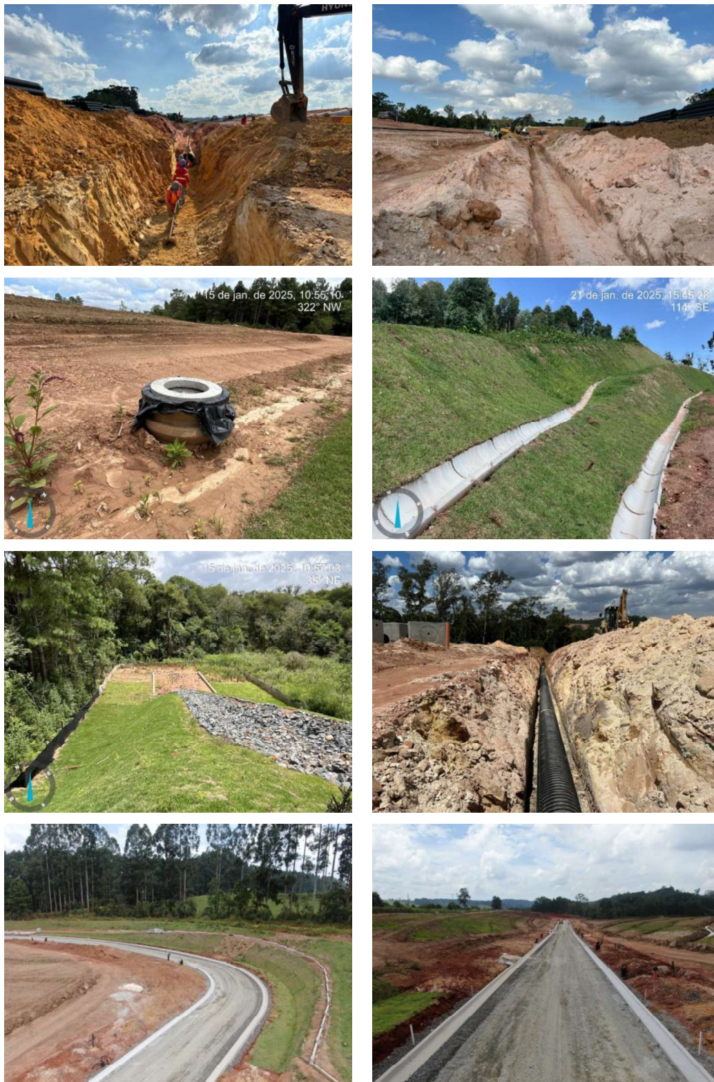
Figura 8 – Execução do projeto de drenagem aprovado
