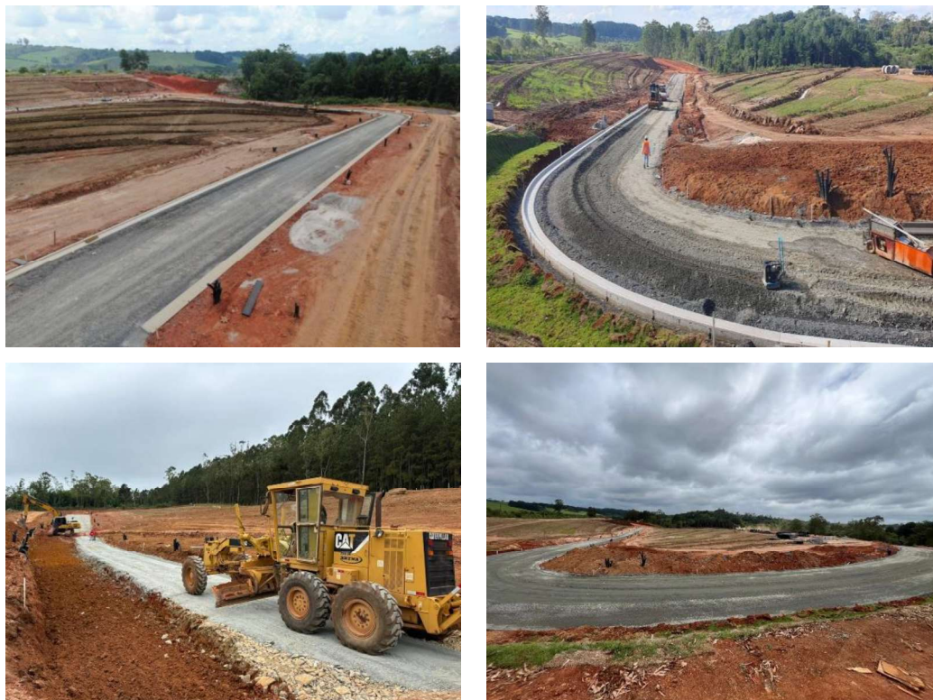
Figura 12 – Execução de guias, sarjetas e pavimentação
