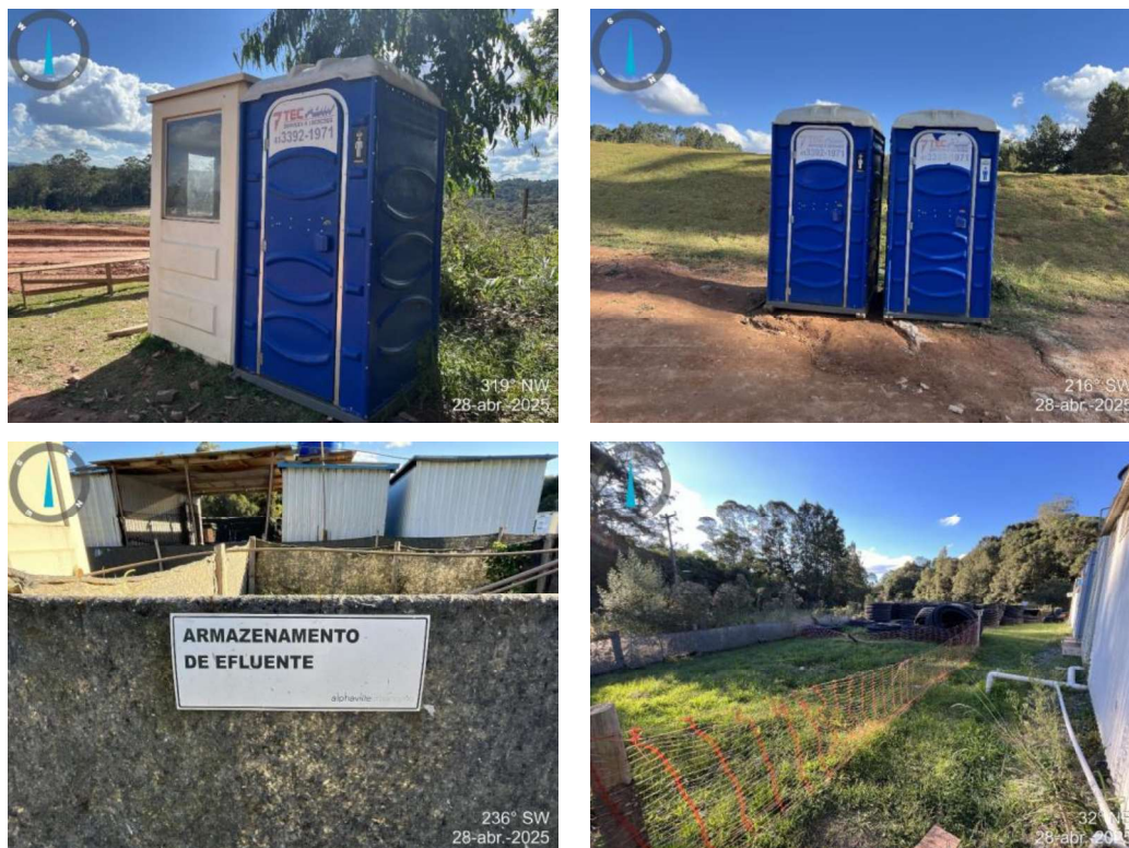
Figura 11 – Banheiros químicos e tanques de armazenamentos impermeáveis
