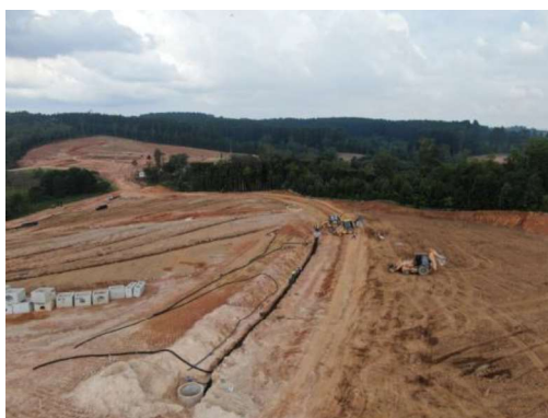
Figura 13 – Execução da rede elétrica
