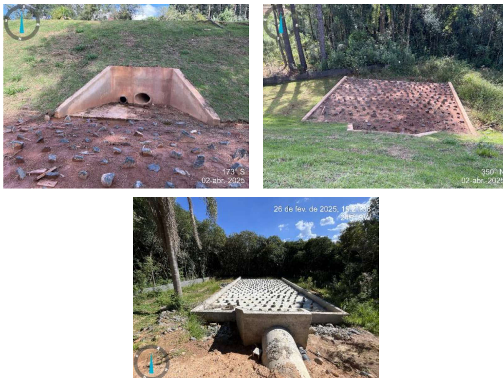
Figura 9 – Execução de lançamentos de água pluvial
