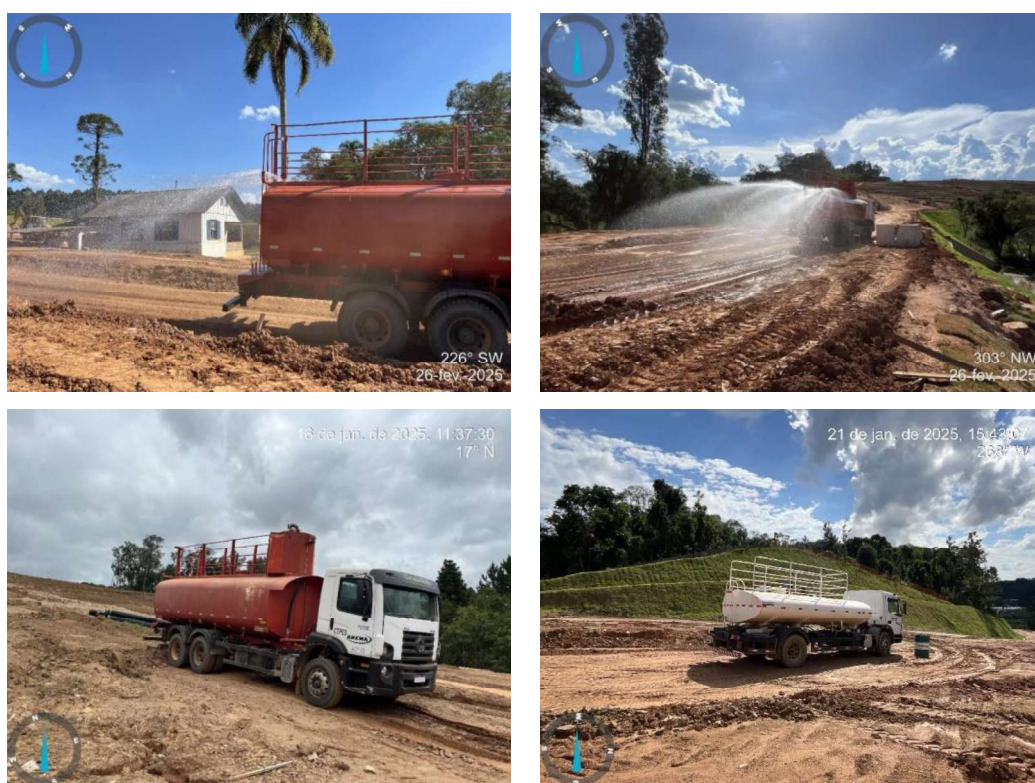
Figura 7 – Controle da poeira por meio do umedecimento das vias internas
