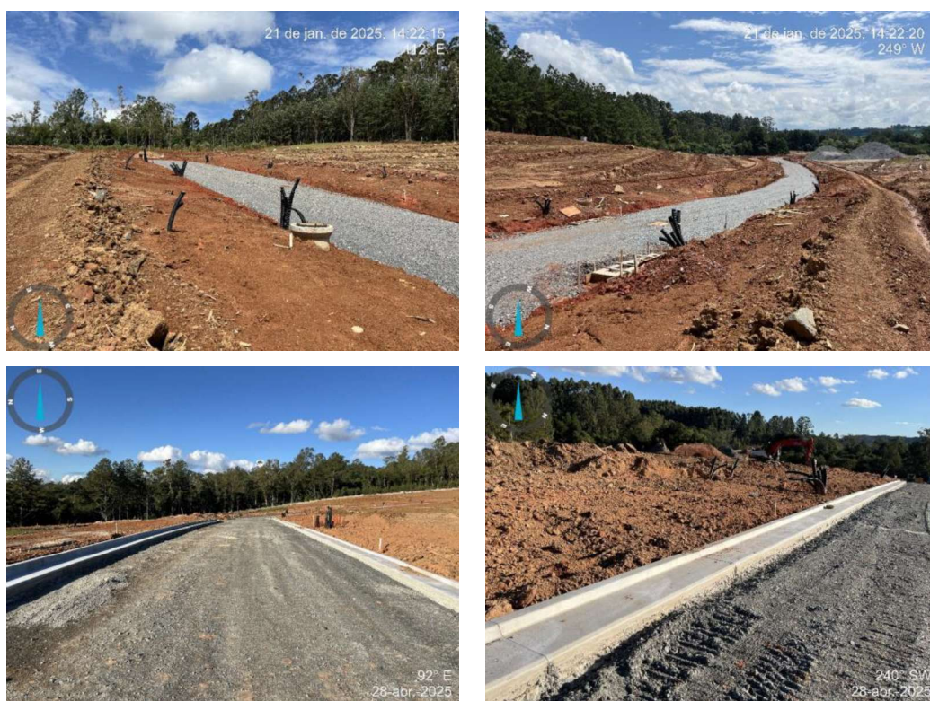
Figura 10 – Execução das redes de abastecimento de água e esgotamento sanitário
