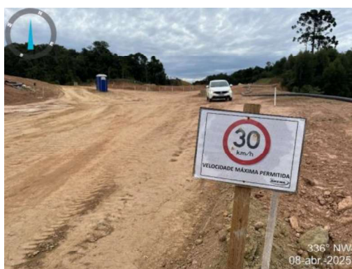
Figura 14 – Placa de sinalização viária
