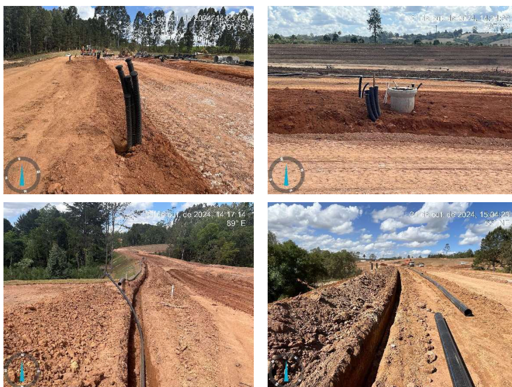
Figura 13 – Execução das redes de abastecimento de água e esgotamento sanitário
