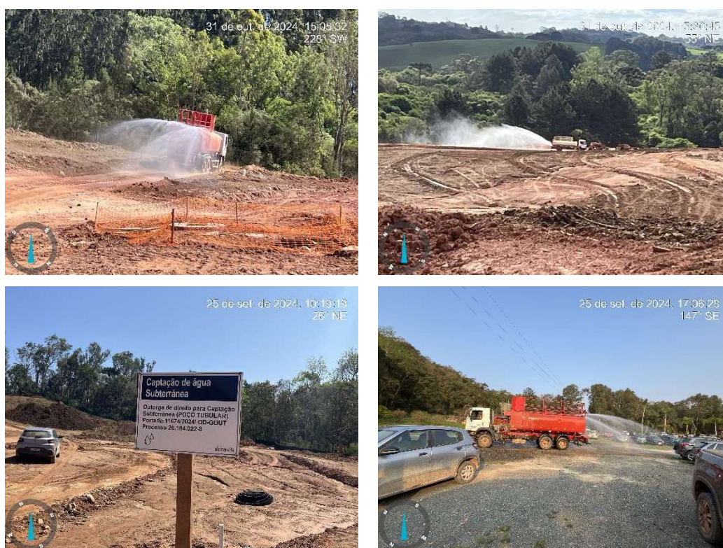
Figura 10 – Controle da poeira por meio do umedecimento das vias internas
