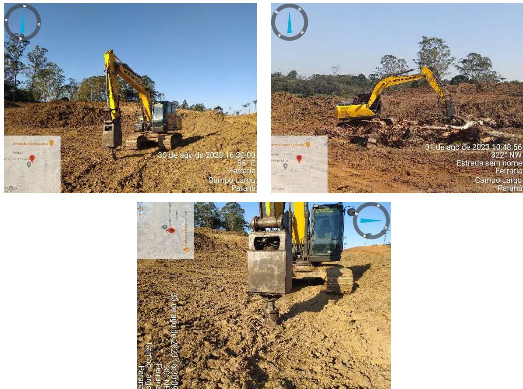
Figura 6 – Destoca das árvores e trituração do material para incorporação ao solo
