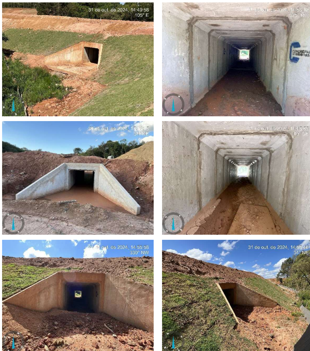
Figura 18 – Execução das passagens de fauna (em fase de obras)
