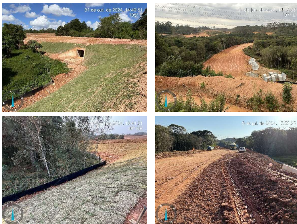
Figura 5 – Intervenções em APP devidamente autorizadas pelo órgão ambiental
