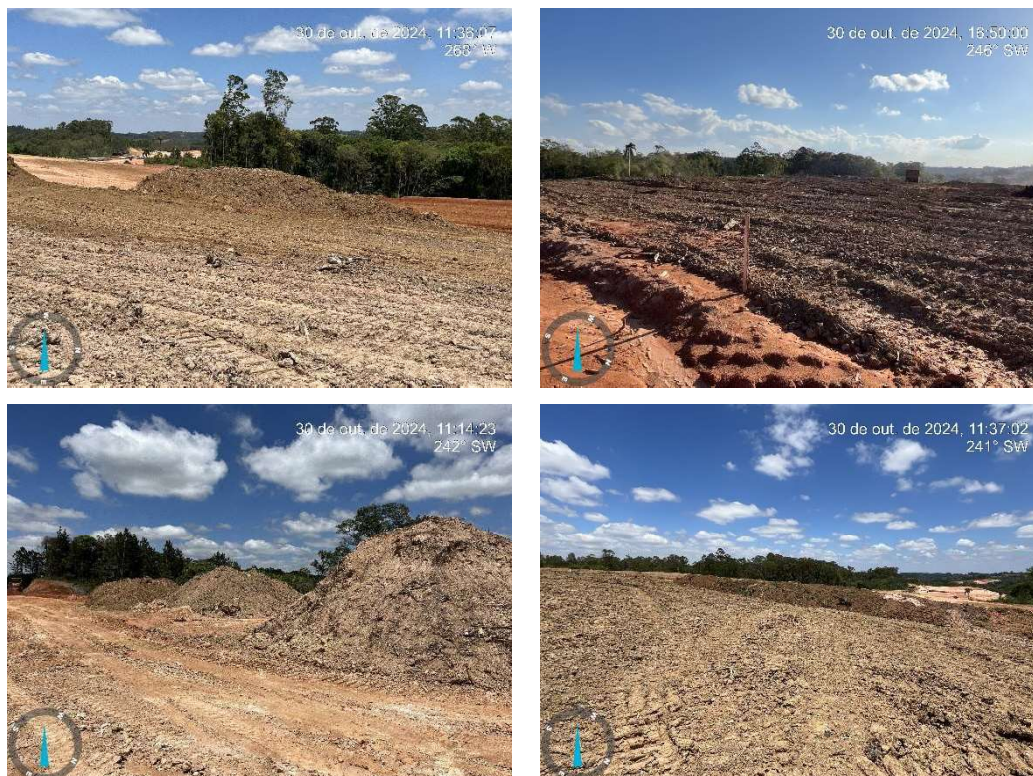
Figura 7 – Armazenamento do solo superficial e retorno do mesmo para quadras e áreas verdes
