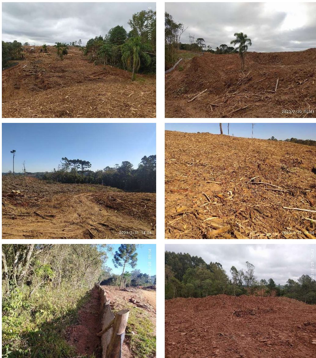
Figura 4 – Supressão dentro e fora de APP, trituração e reaproveitamento do material vegetal
