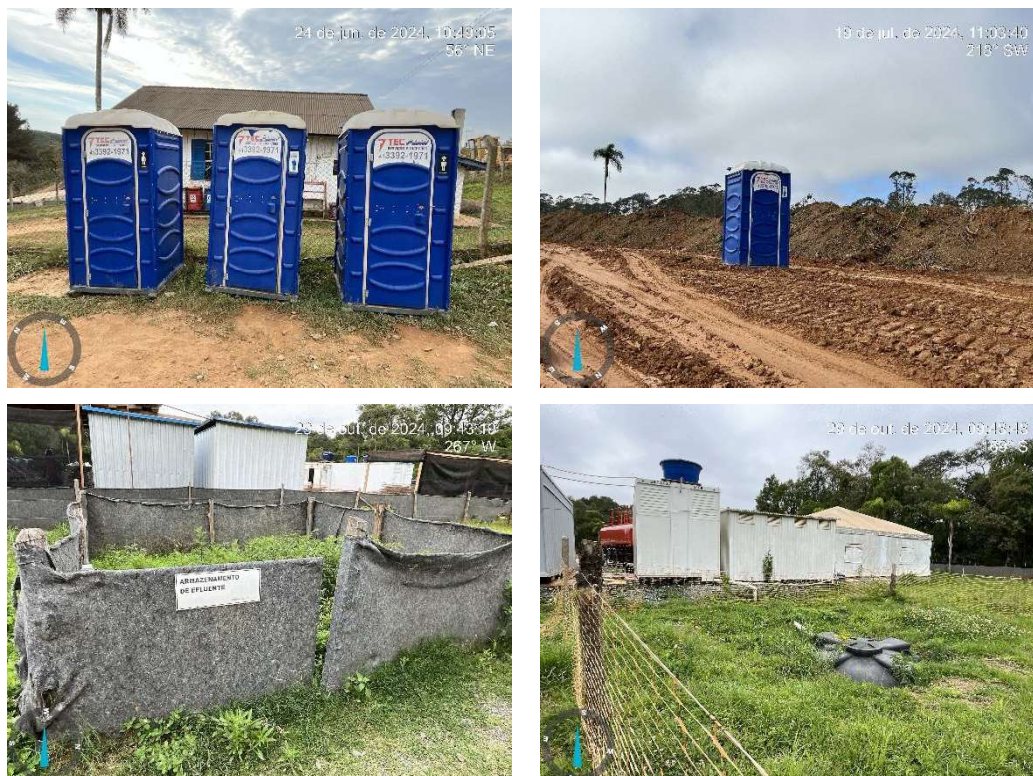
Figura 14 – Banheiros químicos e tanques de armazenamentos impermeáveis
