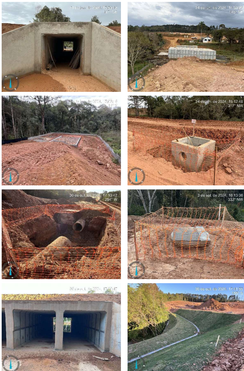
Figura 11 – Execução do projeto de drenagem aprovado
