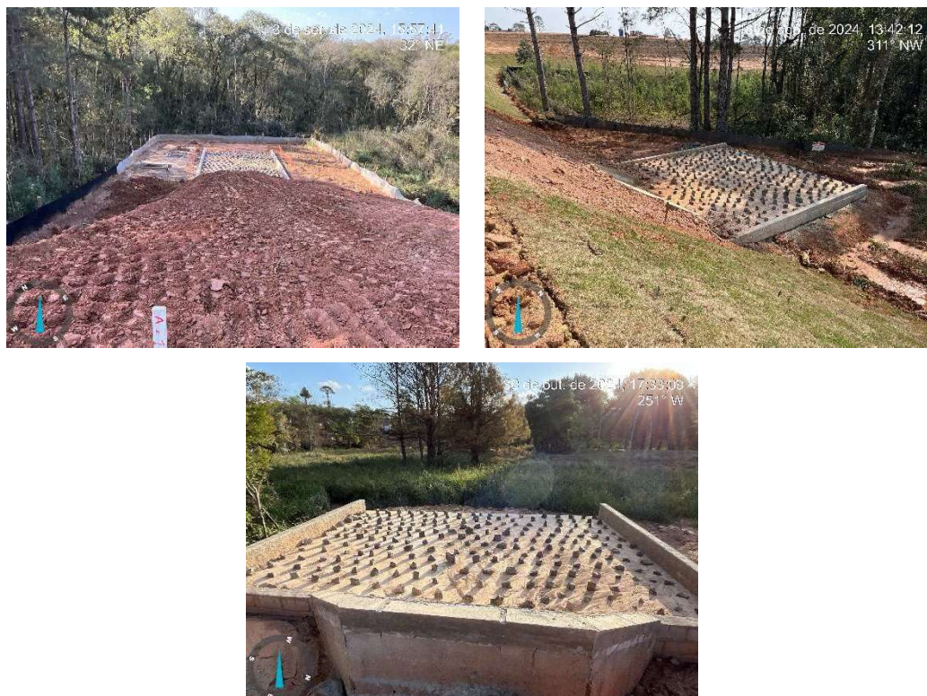
Figura 12 – Execução de lançamentos de água pluvial
