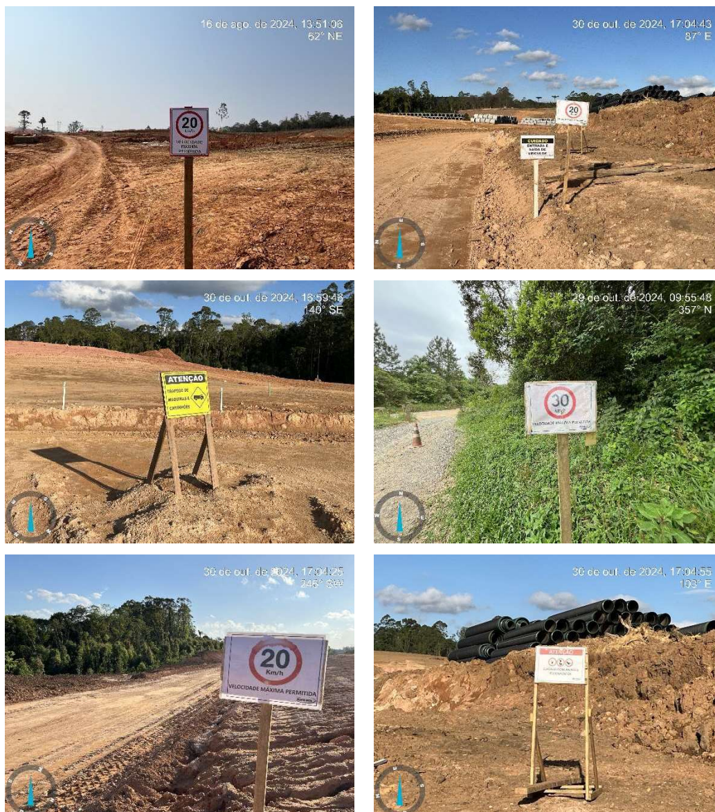
Figura 15 – Placas de sinalização viária
