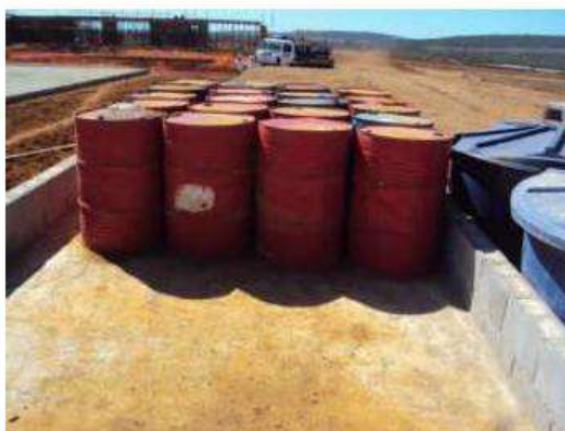
Figura 10 – Armazenamento adequado de recipientes com insumos para a obra
