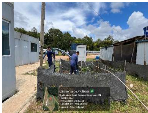
Figura 14 – Esgotamento de tanque impermeável que armazena efluentes
