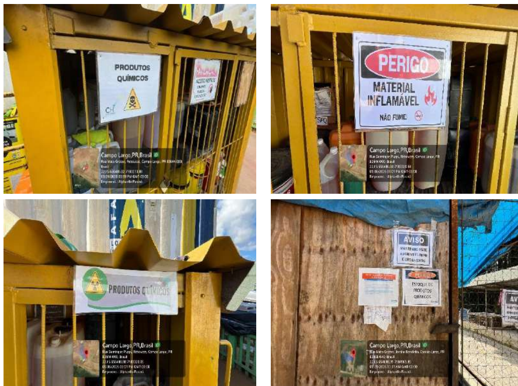
Figura 21 – Sinalizações das áreas de armazenamento de produtos químicos e contatos de emergência
