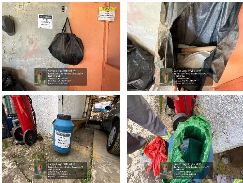
Figura 17 – Kits de mitigação ambiental distribuídos pela obra
