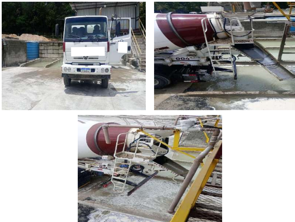
Figura 15 – Local de lavagem dos caminhões betoneira (área da empresa contratada)
