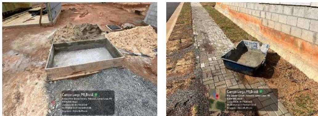
Figura 22 – Uso de maseiras quando da produção de concreto nas frentes de trabalho
