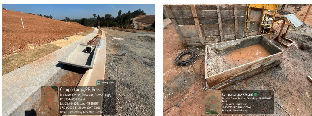
Figura 12 – Uso de masseiras quando da produção de concreto nas frentes de trabalho
