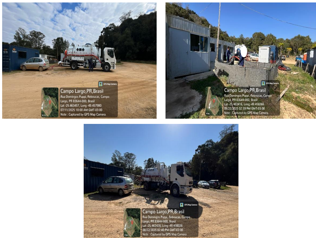
Figura 4 – Esgotamento dos banheiros químicos e tanques impermeáveis que armazenam efluente
