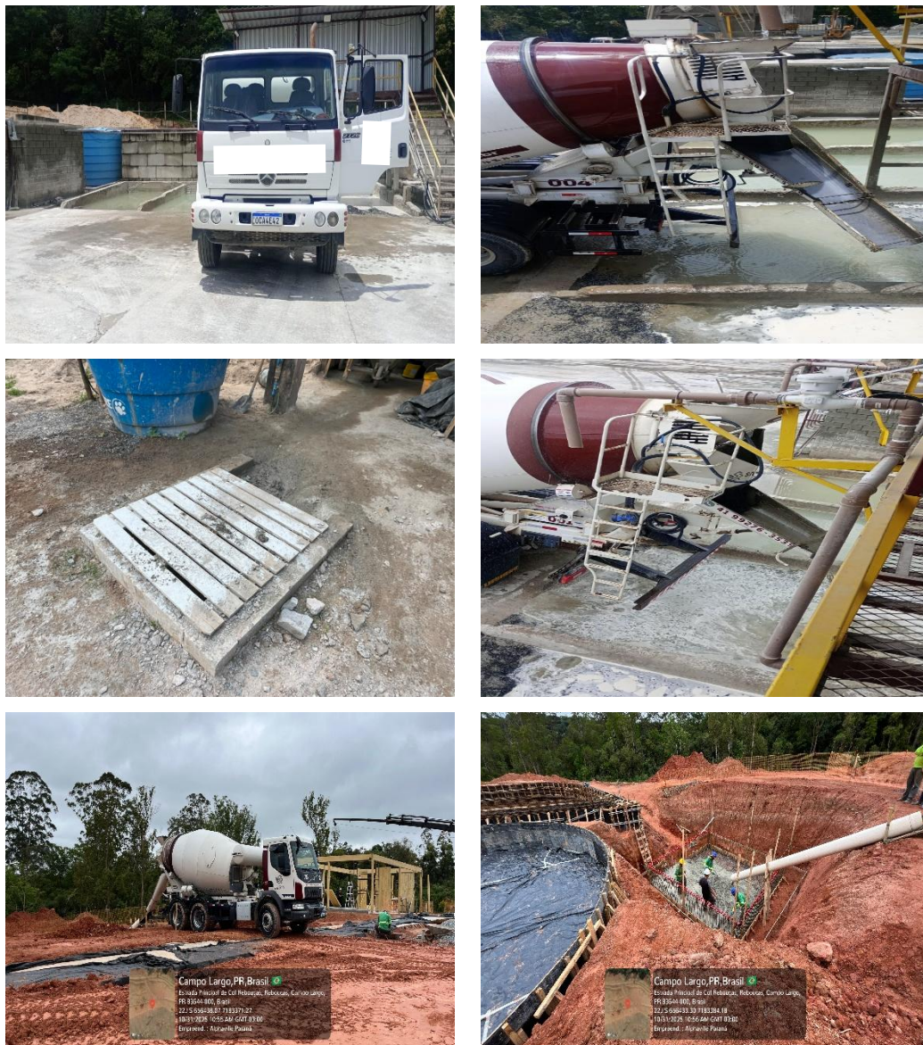
Figura 5 – Dispositivos para reutilização do efluente de lavagem das betoneiras
