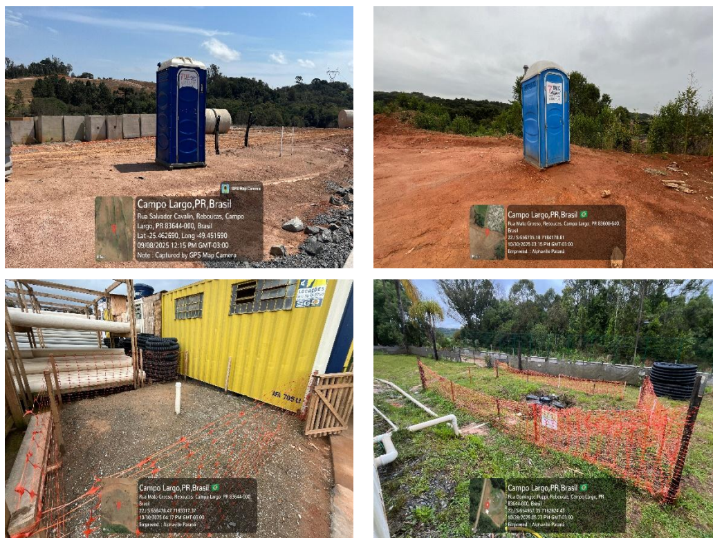
Figura 3 – Banheiros químicos e tanques impermeáveis para armazenar o efluente
