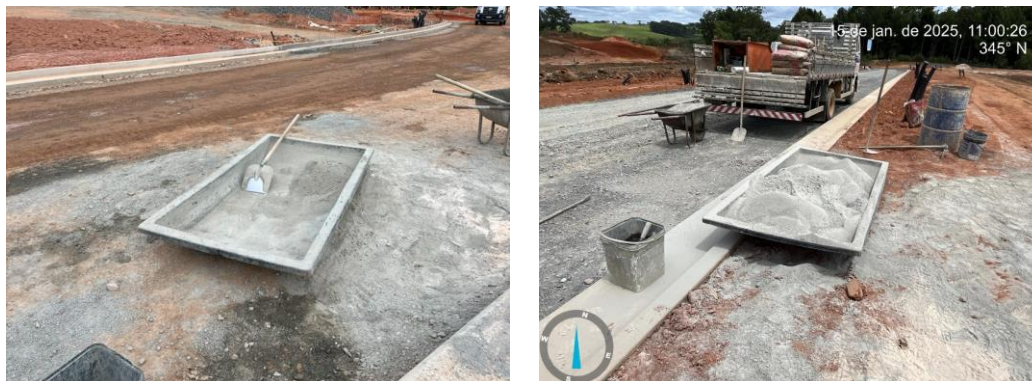
Figura 11 – Medidas preventivas contra acidentes ambientais junto as frentes de trabalho
