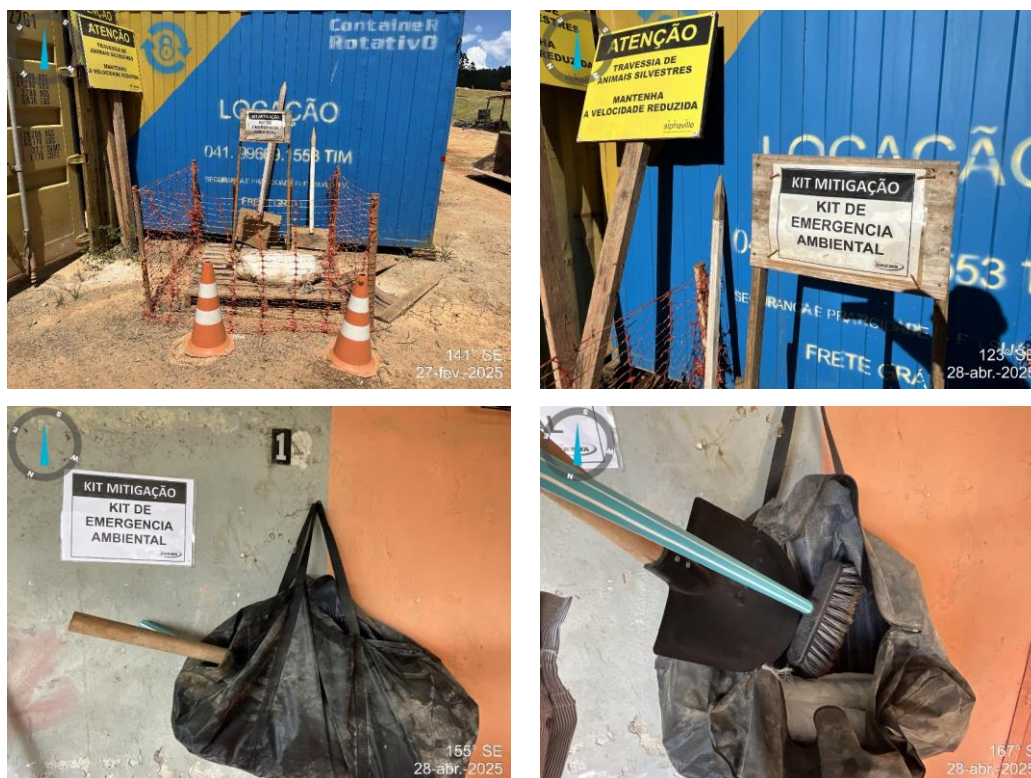
Figura 8 – Kits de mitigação ambiental distribuídos pela obra
