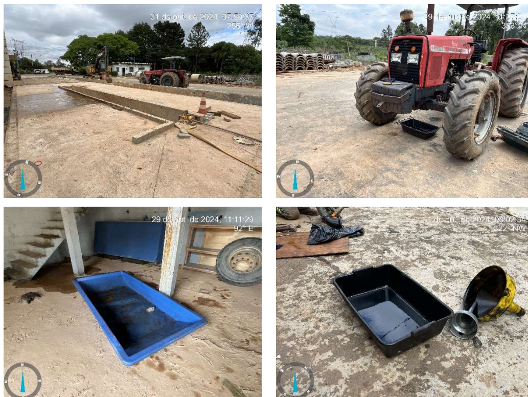
Figura 7 – Estruturas para manutenções pontuais da frota
