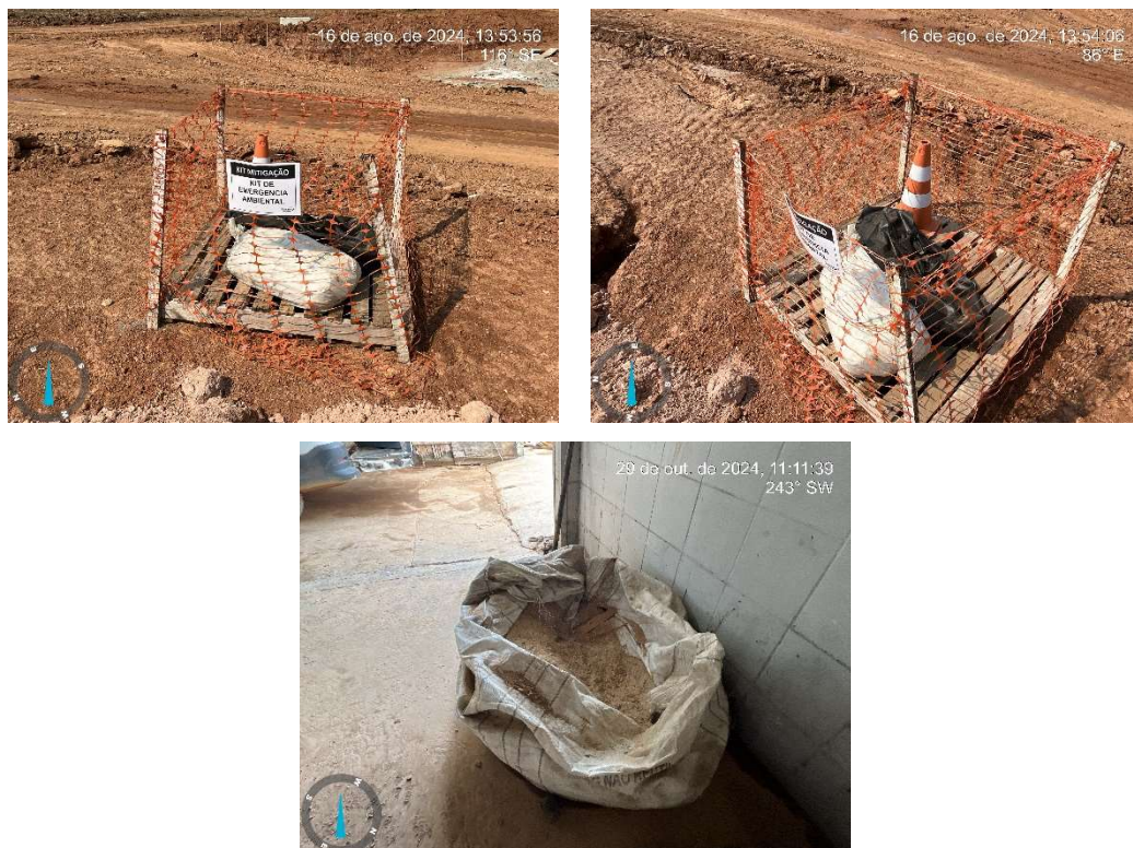
Figura 8 – Kits de mitigação ambiental distribuídos pela obra
