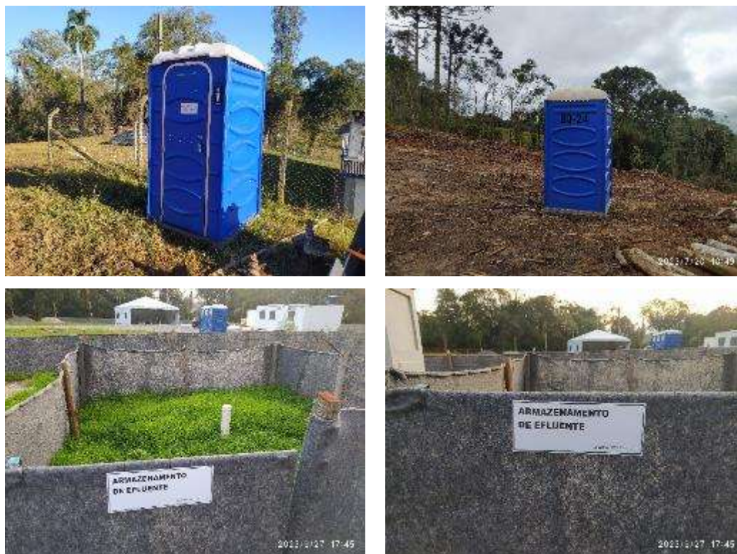
Figura 13 – Banheiros químicos e tanques impermeáveis
