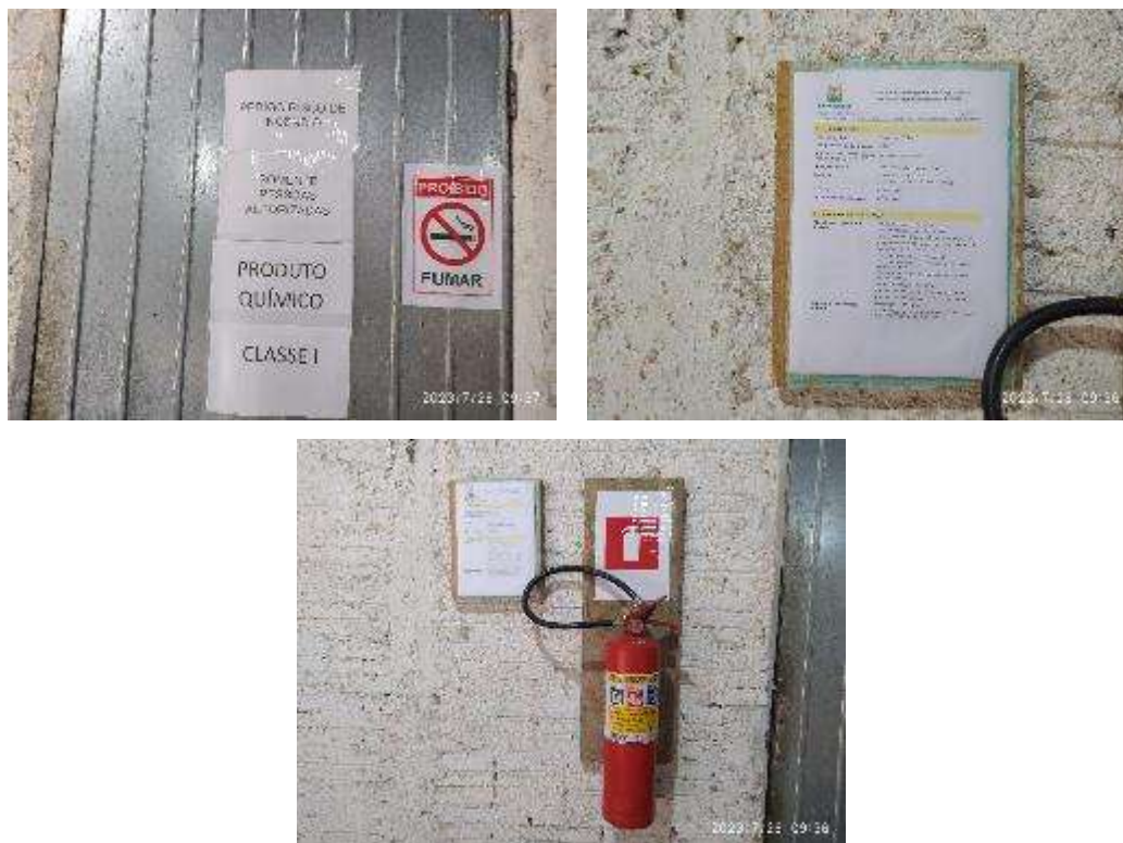
Figura 17 – Identificação do local de armazenamento dos recipientes com produtos químicos / Fichas de Segurança dos produtos / Extintor
