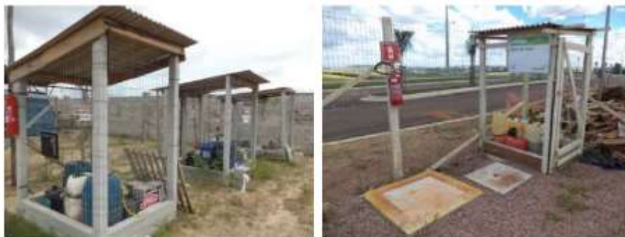
Figura 9 – Locais adequados para acondicionamento de recipientes com insumos químicos
