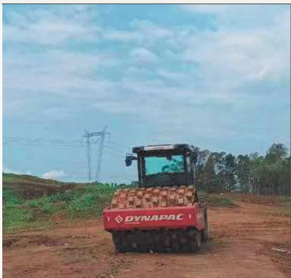
Compactação de solo
