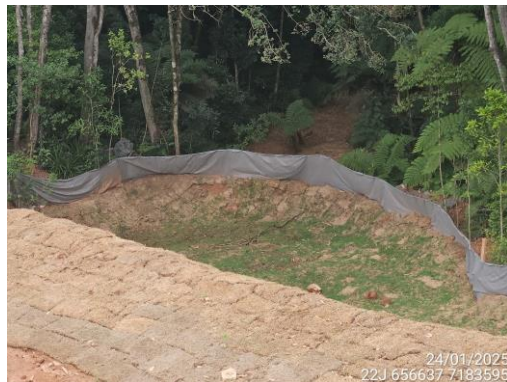
Figura 23. Medidas adotadas para a preservação dos recursos hídricos, como sistemas de contenção de sedimentos
