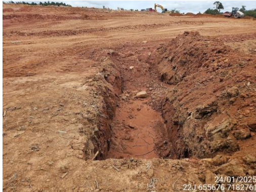
Figura 25. Medidas adotadas para a preservação dos recursos hídricos, como sistemas de contenção de sedimentos
