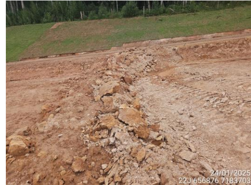
Figura 25. Medidas adotadas para a preservação dos recursos hídricos, como sistemas de contenção de sedimentos
