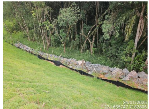
Figura 23. Medidas adotadas para a preservação dos recursos hídricos, como sistemas de contenção de sedimentos
