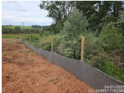
Figura 22. Medidas adotadas para a preservação dos recursos hídricos, como proteção das Áreas de Preservação Permanentes (APP).
