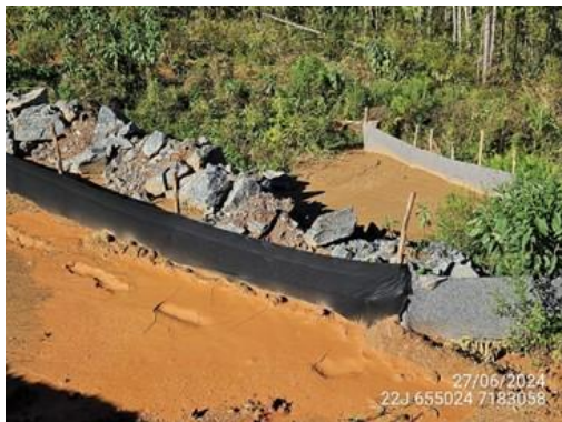
Figura 24. Medidas adotadas para a preservação dos recursos hídricos, como sistemas de contenção de sedimentos
