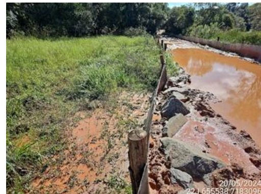
Figura 24. Medidas adotadas para a preservação dos recursos hídricos, como sistemas de contenção de sedimentos
