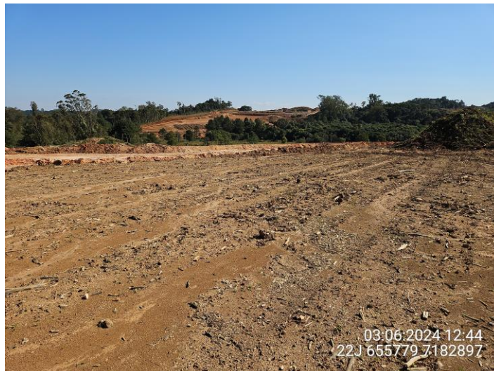
Figura 16. Ponto P05: obras de terraplanagem realizadas cerca de 150 metros do ponto P05.
