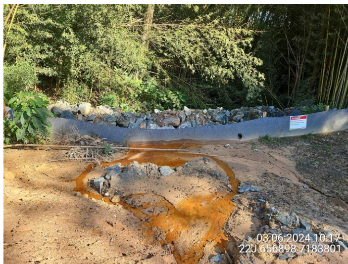
Figura 20. Ponto P07: afluente da margem esquerda do rio Timbutuva: presença de detritos vegetais no entorno e no leito do curso d'água / manta geotêxtil a jusante para conter sedimentos.
