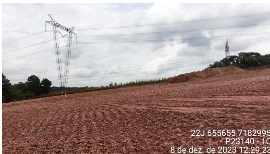
Figura 14. Ponto P05: obras de terraplanagem realizadas cerca de 150 metros do ponto P05.
