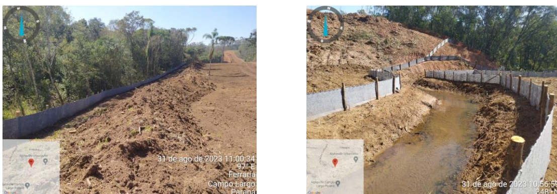
Figura 23. Medidas adotadas para a preservação dos recursos hídricos, como sistemas de contenção de sedimentos
