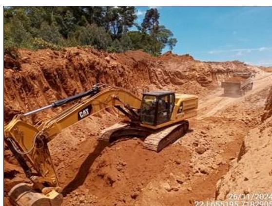
FIGURA 55: ESCAVAÇÃO PARA RETIRADA DE ATERRO.
