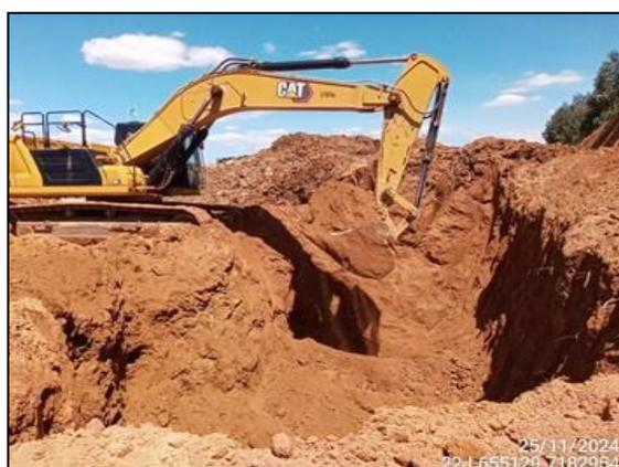
FIGURA 54: ESCAVAÇÃO PARA RETIRADA DE ATERRO.
