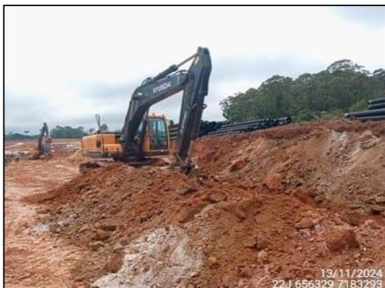
FIGURA 5: ESCAVAÇÃO PARA INSTALAÇÃO DE TUBULAÇÃO.
