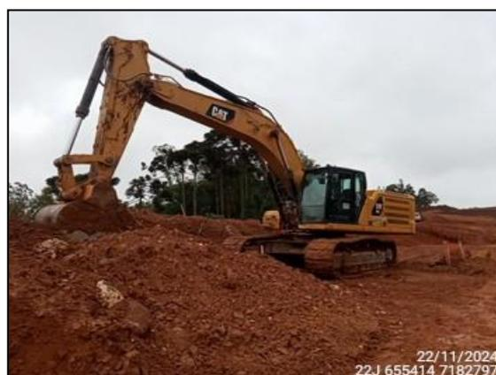
FIGURA 53: ESCAVAÇÃO E MOVIMENTAÇÃO DE SOLO PARA ABERTURA DE LOTES E VIA NO LOTEAMENTO.
