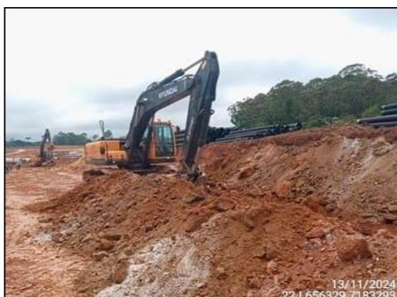
FIGURA 48: ESCAVAÇÃO PARA RETIRADA DE ATERRO
