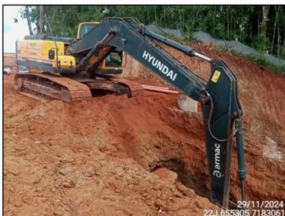
FIGURA 58: ESCAVAÇÃO PARA INSTALAÇÃO DE TUBULAÇÃO DE ESGOTO.
