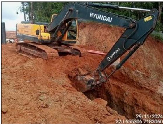
FIGURA 9: ESCAVAÇÃO DE TUBULAÇÃO PARA ESGOTO.
