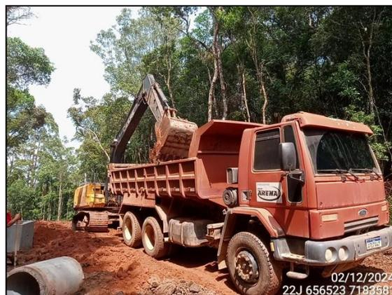
FIGURA 2: ESCAVAÇÃO PARA INSTALAÇÃO DE ESCAPE DE ESGOTO.
