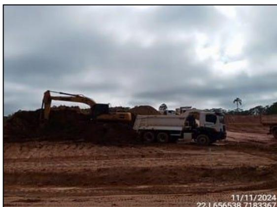
FIGURA 46: ESCAVAÇÃO PARA RETIRADA DE MATERIAL DESTINADO A ATERRO
