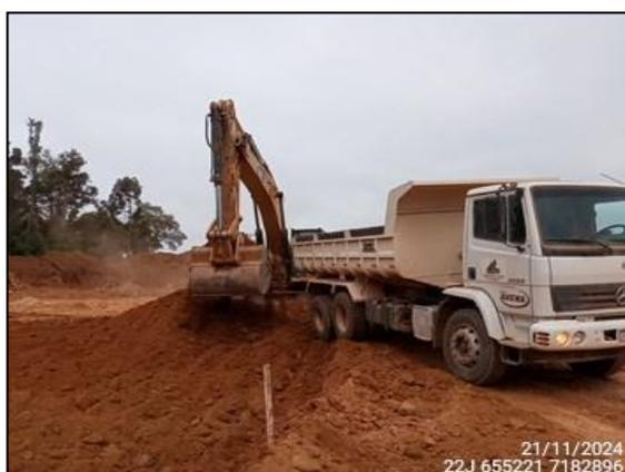
FIGURA 52: ESCAVAÇÃO E MOVIMENTAÇÃO DE SOLO PARA ABERTURA DE LOTES E VIA NO LOTEAMENTO.
