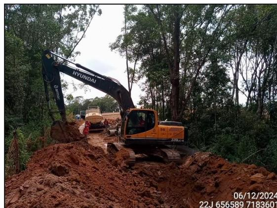
FIGURA 8: ESCAVAÇÃO PARA INSTALAÇÃO DE ESCAPE DE ESGOTO.
