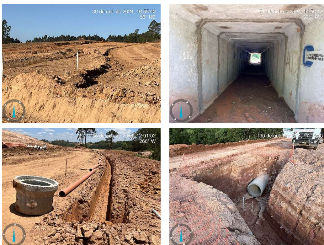
Figura 4 – Execução da terraplenagem, drenagem, passagens de fauna, rede de água e esgoto
