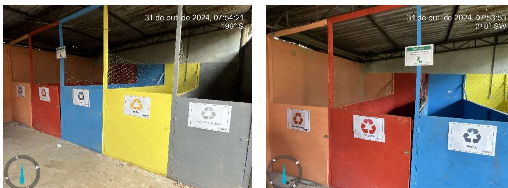
Figura 8 – Baia para armazenamento resíduo Classe D
