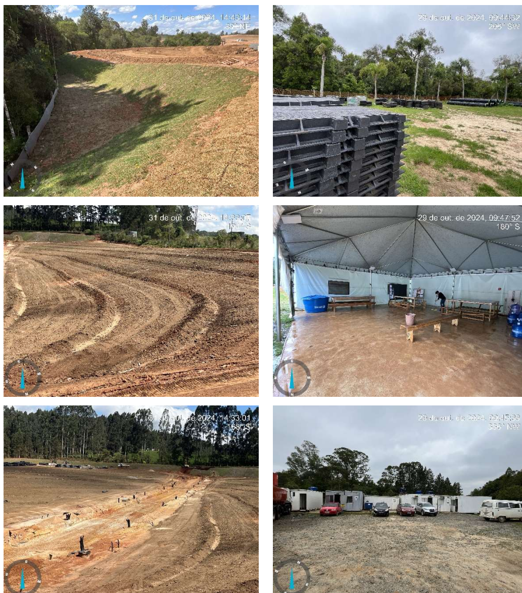
Figura 12 – Limpeza e organização geral do empreendimento
