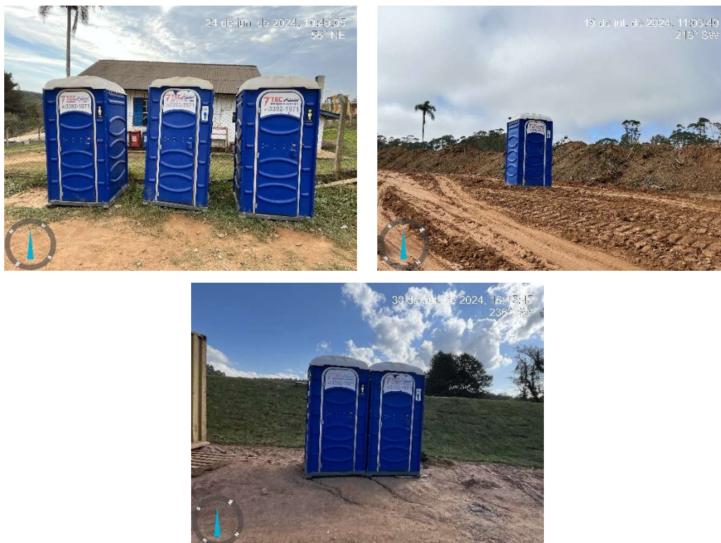
Figura 10 – Banheiros químicos disponíveis aos colaboradores
