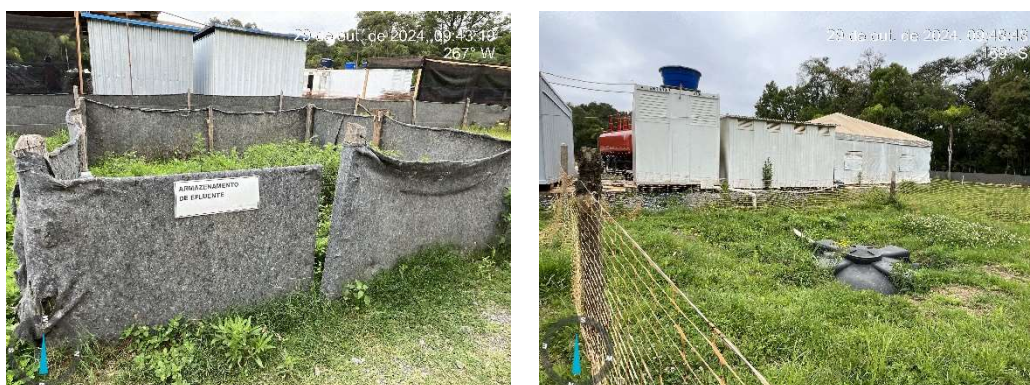
Figura 11 – Tanques impermeáveis para armazenamento do efluente
