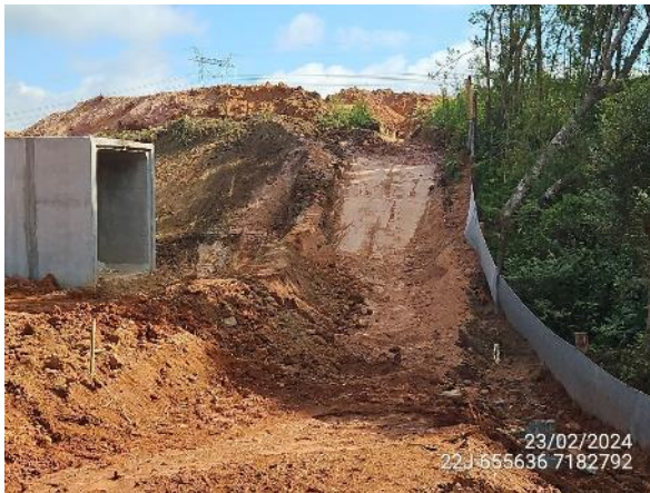
Figura 6. Reconfiguração das bacias de contenção, com controle do processo erosivo.
