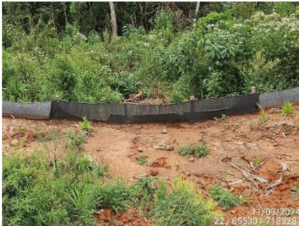
Figura 3. Adição de novas mantas geotêxteis em área sensível, de alta concentração de sedimentos.
