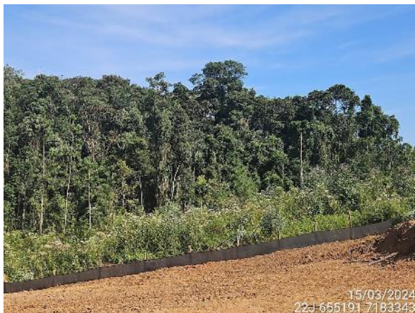
Figura 22. Delimitação de área protegida com manta geotêxtil.
