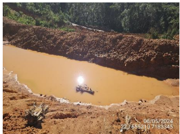
Figura 17. Bacia de contenção com alto volume de água, ilustrando a boa função de retenção hídrica.
