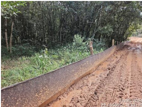
Figura 5. Instalação da manta geotêxtil em área de estrada sobre APP, protegendo-a.
