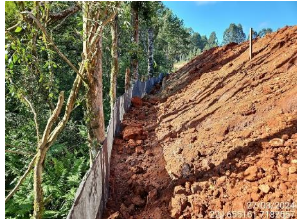
Figura 4. Reconformação da encosta a montante, aliviando pressão sobre limite da APP.
