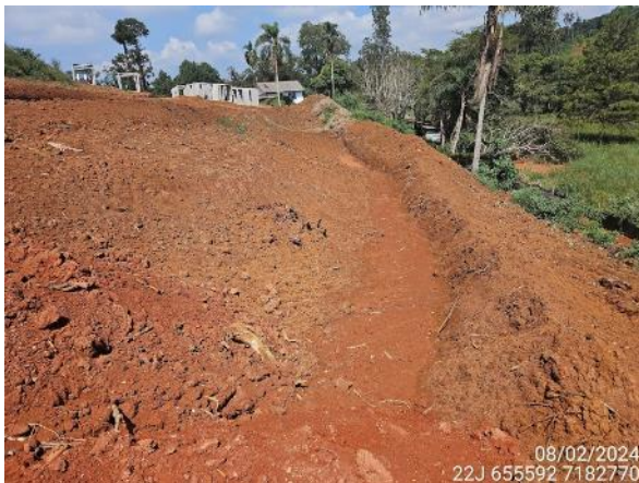
Figura 14. Confecção de bacia de contenção em curva de nível, objetivando proteger APP a jusante.
