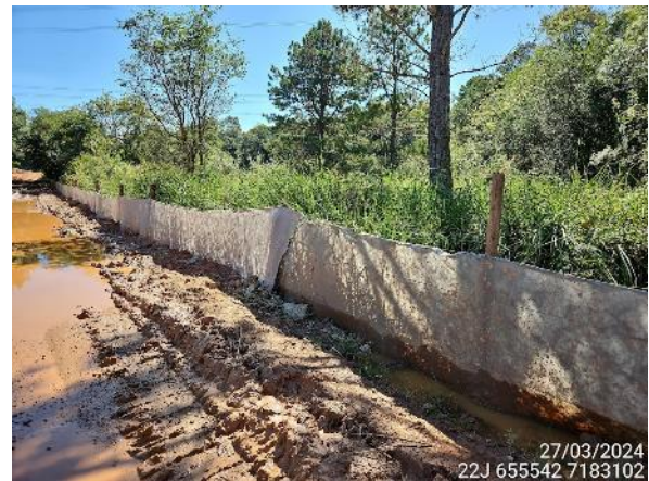
Figura 21. Delimitação de APP com manta geotêxtil, ao longo de estrada.
