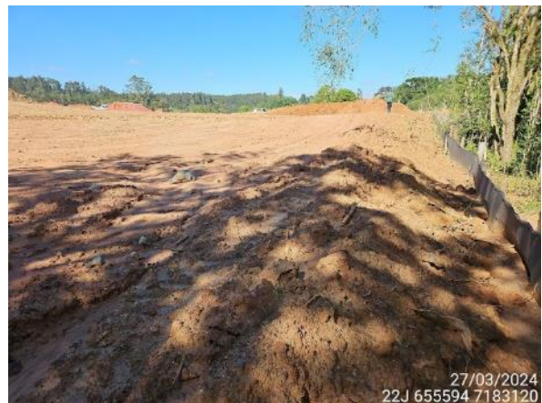
Figura 9. Reconformação de terreno eliminou pontos de erosão.
