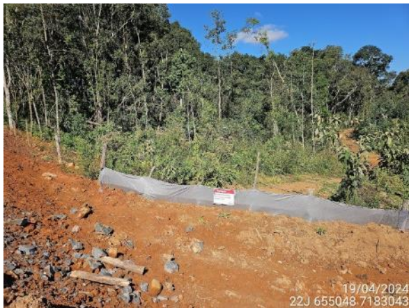
Figura 20. Instalação de mantas geotêxteis em área de APP.
