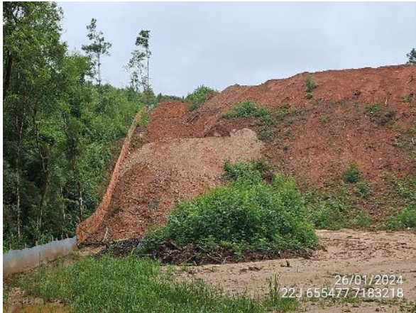
Figura 12. Confecção de terraços e bacias de contenção em encosta.
