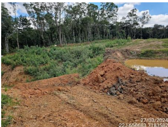
Figura 16. Reconformação de bacia de contenção.
