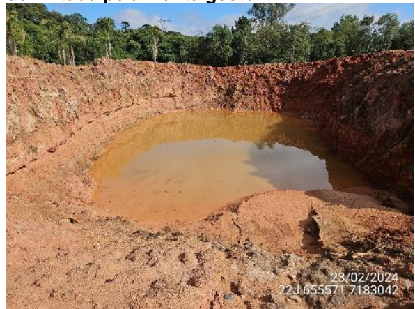
Figura 15. Bacia de contenção com boa função, evitando o carreamento de sedimentos para a APP.
