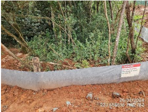
Figura 1. Colocação de manta geotêxtil em limite de APP.
