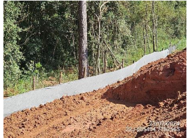
Figura 2. Manta foi reconfigurada e substituída.
