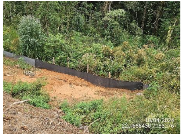
Figura 6. Reconfiguração de novas mantas geotêxteis em área com alta concentração de sedimentos.
