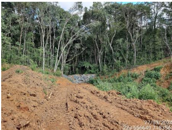
Figura 8. Reconfiguração de vertente erosionada e posicionamento de barreira geotécnica no talvegue.
