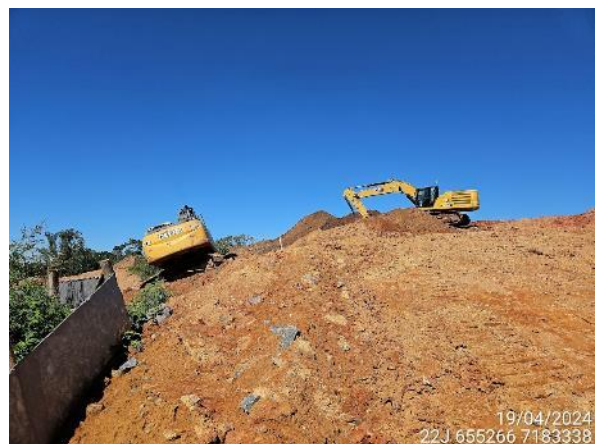
Figura 11. Ações corretivas sobre erosões, com uso de maquinário.
