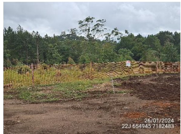
Figura 23. Delimitação de área protegida com cerquite.
