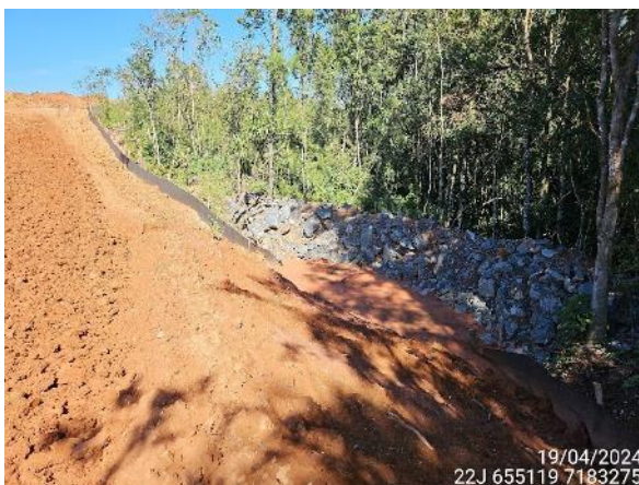
Figura 10. Controle de erosão pela construção de barreiras geotécnicas.
