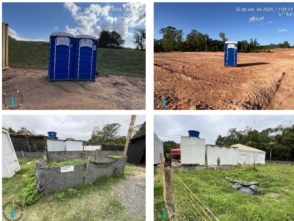
Figura 4 – Banheiros químicos e tanques impermeáveis para armazenar o efluente
