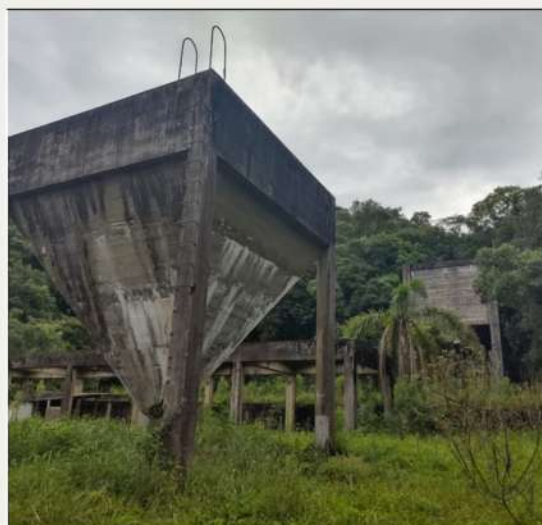
Visita à obra - 08/12/23
