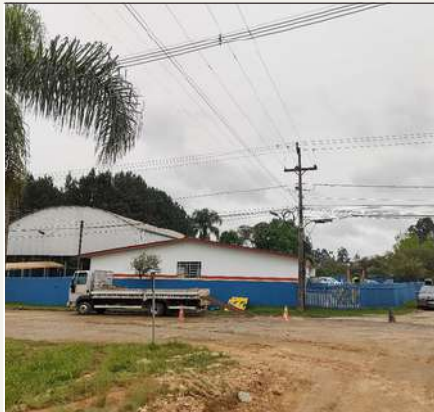
Escola Municipal Luiz Julio - Rua Mato Grosso - estrada de acesso ao empreendimento
