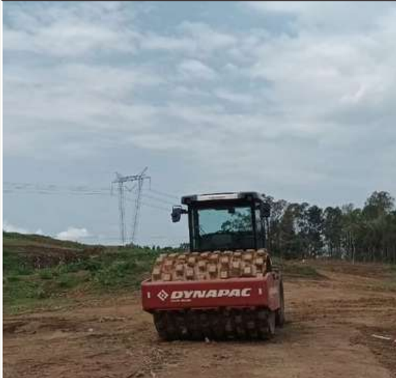
Compactação de solo
