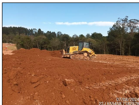
FIGURA 48: TERRAPLANAGEM.
