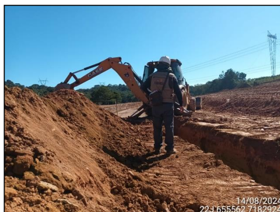
FIGURA 57: ARQUEÓLOGO ACOMPANHANDO ESCAVAÇÃO E MOVIMENTAÇÃO DE SOLO.
