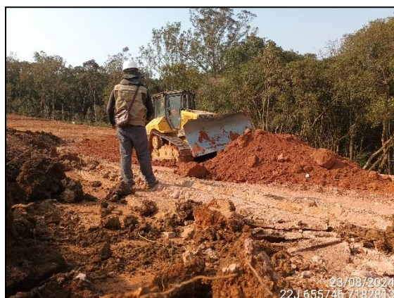
FIGURA 8: ARQUEÓLOGO ACOMPANHANDO TERRAPLANAGEM.
