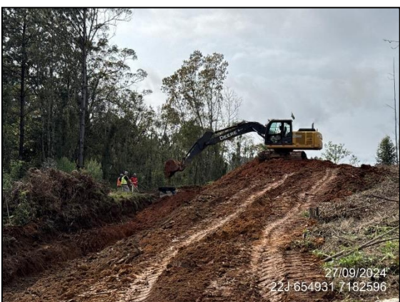
FIGURA 5: ESCAVAÇÃO E MOVIMENTAÇÃO DE SOLO.
