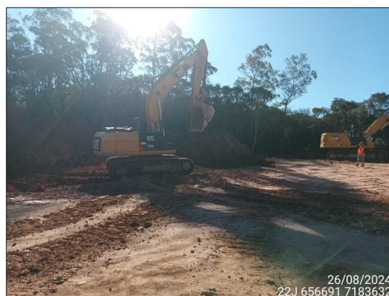
FIGURA 73: ESCAVAÇÃO E MOVIMENTAÇÃO DE SOLO.
