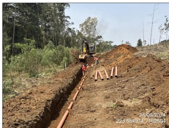
FIGURA 106: ESCAVAÇÃO E MOVIMENTAÇÃO DE SOLO.
