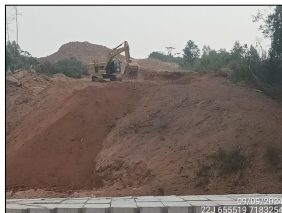
FIGURA 92: ESCAVAÇÃO E MOVIMENTAÇÃO DE SOLO.
