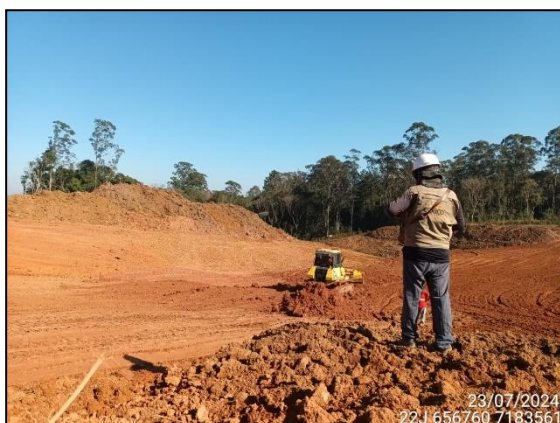
FIGURA 3: ARQUEÓLOGO ACOMPANHANDO TERRAPLANAGEM.
