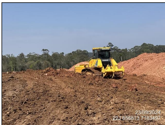
FIGURA 1: ESCAVAÇÃO E MOVIMENTAÇÃO DE SOLO.
