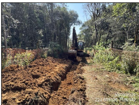
FIGURA 6: ESCAVAÇÃO E MOVIMENTAÇÃO DE SOLO.
