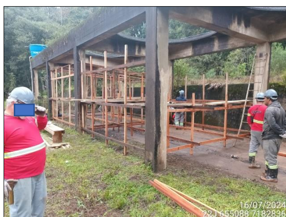
FIGURA 21: LEVANTAMENTO DE ESTRUTURA PARA GUARDAR TUBULAÇÃO.
