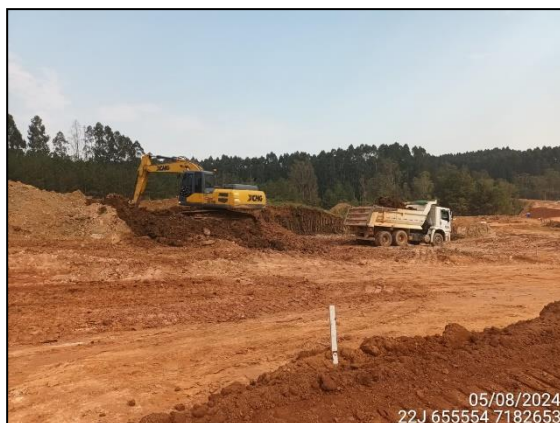
FIGURA 1: ESCAVAÇÃO E MOVIMENTAÇÃO DE SOLO.
