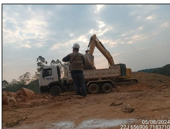
FIGURA 45: ARQUEÓLOGO ACOMPANHANDO ESCAVAÇÃO E MOVIMENTAÇÃO DE SOLO.
