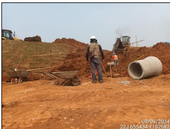
FIGURA 1: ARQUEÓLOGO ACOMPANHANDO ESCAVAÇÃO E MOVIMENTAÇÃO DE SOLO.
