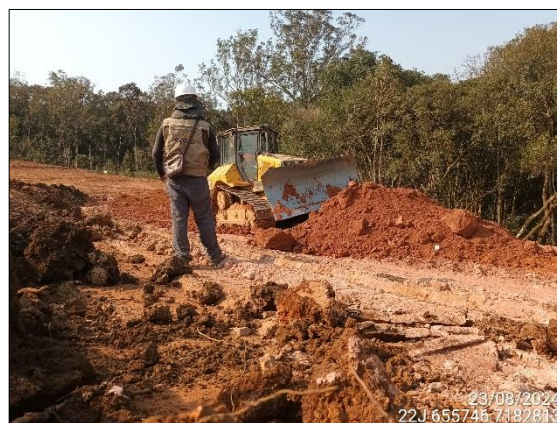
FIGURA 71: ARQUEÓLOGO ACOMPANHANDO TERRAPLANAGEM.
