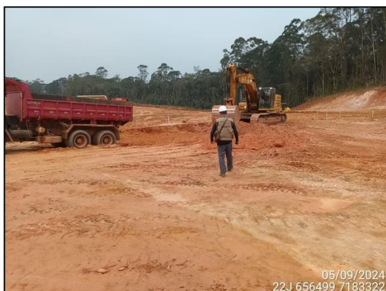
FIGURA 89: ARQUEÓLOGO ACOMPANHANDO ESCAVAÇÃO E MOVIMENTAÇÃO DE SOLO.
