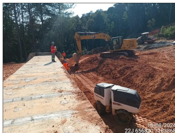
FIGURA 61: ESCAVAÇÃO E MOVIMENTAÇÃO DE SOLO.
