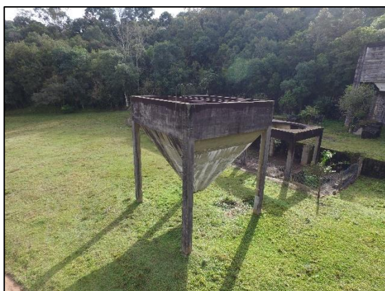
FIGURA 2: ANTIGA ESTRUTURA DOS BRITADORES DA MINA TIMBUTUVA
