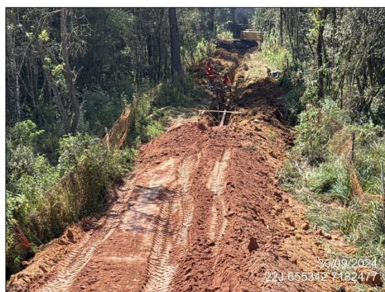
FIGURA 108: ESCAVAÇÃO E MOVIMENTAÇÃO DE SOLO.
