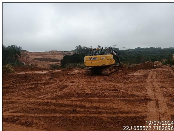
FIGURA 5: ESCAVAÇÃO E MOVIMENTAÇÃO DE SOLO.
