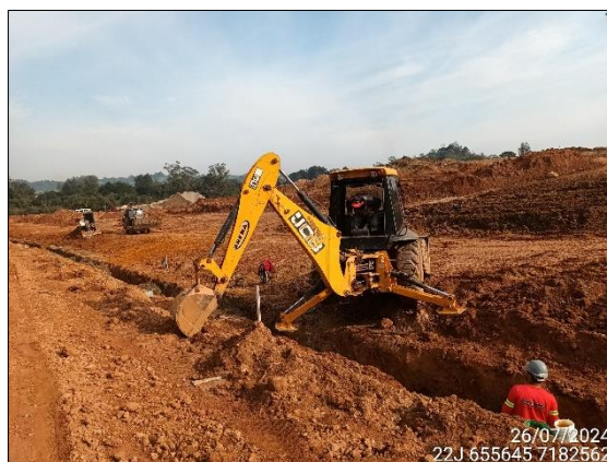
FIGURA 35: ESCAVAÇÃO E MOVIMENTAÇÃO DE SOLO.
