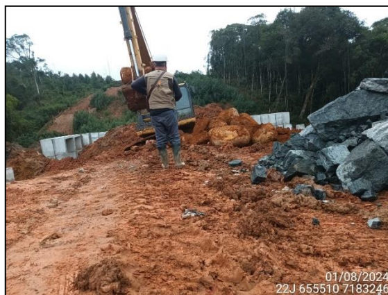
FIGURA 41: ARQUEÓLOGO ACOMPANHANDO ESCAVAÇÃO E MOVIMENTAÇÃO DE SOLO E ROCHOSO.
