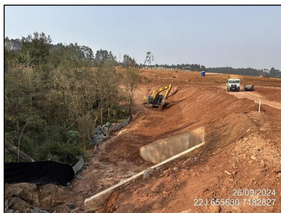
FIGURA 4: ESCAVAÇÃO E MOVIMENTAÇÃO DE SOLO.
