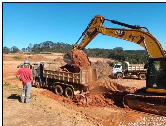
FIGURA 59: ESCAVAÇÃO E MOVIMENTAÇÃO DE SOLO.
