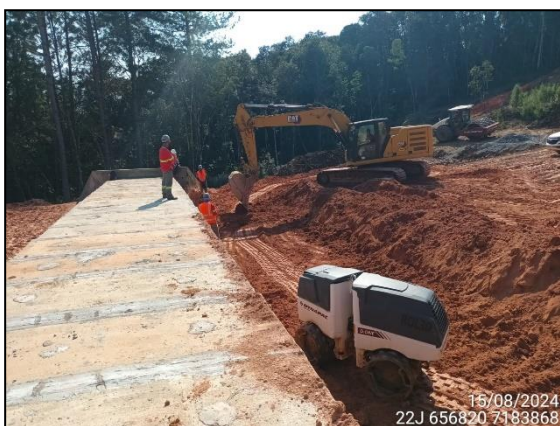
FIGURA 7: ESCAVAÇÃO E MOVIMENTAÇÃO DE SOLO.
