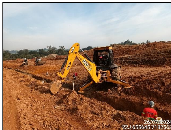
FIGURA 6: ESCAVAÇÃO E MOVIMENTAÇÃO DE SOLO.
