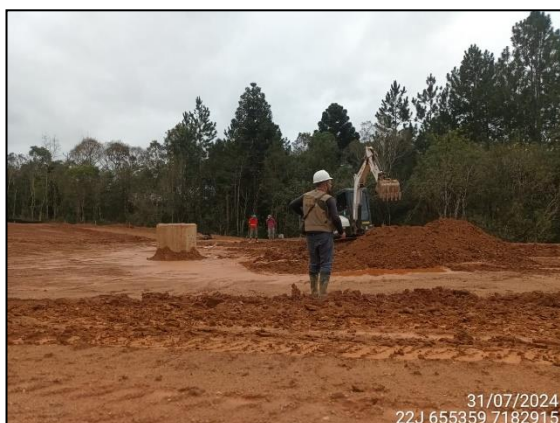
FIGURA 38: ARQUEÓLOGO ACOMPANHANDO ESCAVAÇÃO E MOVIMENTAÇÃO DE SOLO.
