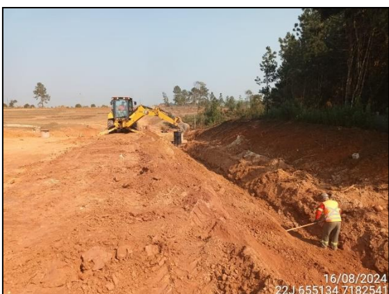
FIGURA 62: ESCAVAÇÃO E MOVIMENTAÇÃO DE SOLO
