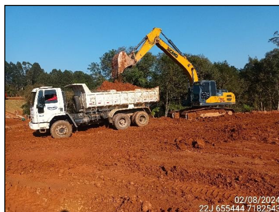
FIGURA 10: ESCAVAÇÃO E MOVIMENTAÇÃO DE SOLO.
