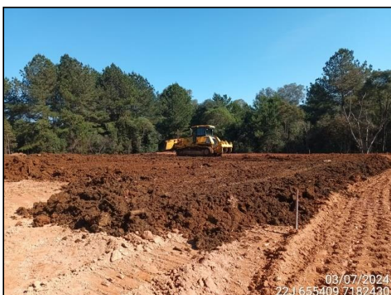
FIGURA 5: TERRAPLANAGEM.
