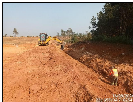
FIGURA 8: ESCAVAÇÃO E MOVIMENTAÇÃO DE SOLO.
