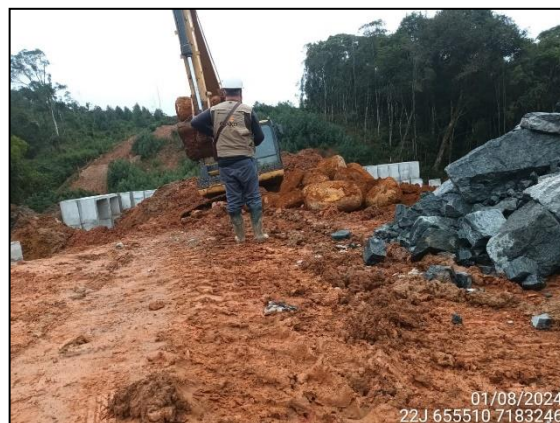
FIGURA 8: ARQUEÓLOGO ACOMPANHANDO ESCAVAÇÃO E MOVIMENTAÇÃO DE SOLO E MATERIAL ROCHOSO.
