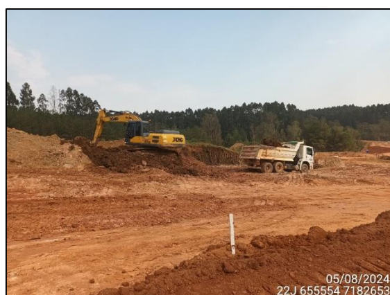
FIGURA 44: ESCAVAÇÃO E MOVIMENTAÇÃO DE SOLO.
