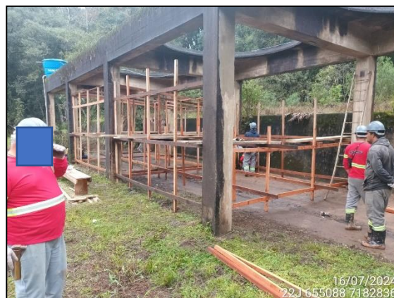
FIGURA 2: CONSTRUÇÃO DE ESTRUTURA.
