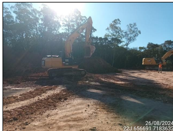
FIGURA 2: ESCAVAÇÃO E MOVIMENTAÇÃO DE SOLO.
