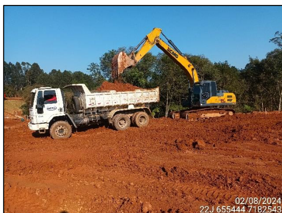
FIGURA 42: ESCAVAÇÃO E MOVIMENTAÇÃO DE SOLO.
