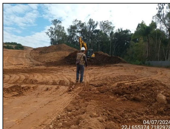
FIGURA 6: ARQUEÓLOGO ACOMPANHANDO ESCAVAÇÃO E MOVIMENTAÇÃO DE SOLO.
