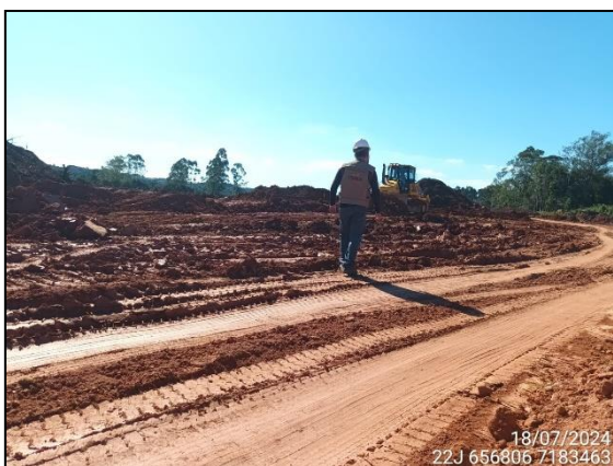
FIGURA 5: ARQUEÓLOGO ACOMPANHANDO TERRAPLANAGEM.
