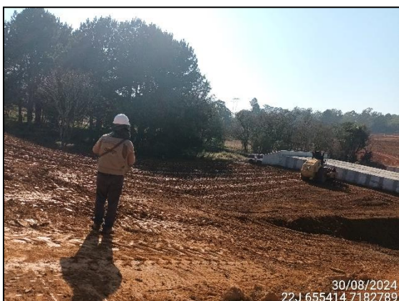
FIGURA 9: ARQUEÓLOGO ACOMPANHANDO TERRAPLANAGEM.
