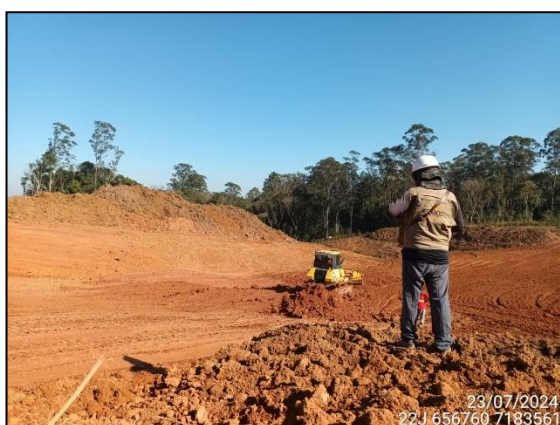
FIGURA 30: ARQUEÓLOGO ACOMPANHANDO TERRAPLANAGEM.
