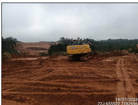
FIGURA 26: ESCAVAÇÃO E MOVIMENTAÇÃO DE SOLO
