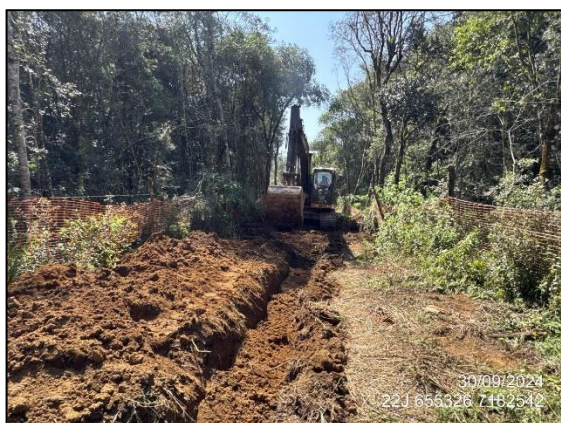
FIGURA 107: ABERTURA DE VALA.
