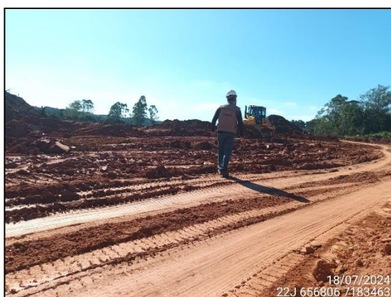
FIGURA 24: ARQUEÓLOGO ACOMPANHANDO TERRAPLANAGEM.
