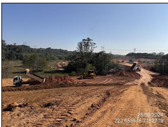
FIGURA 3: ATERRAMENTO E TERRAPLENAGEM.
