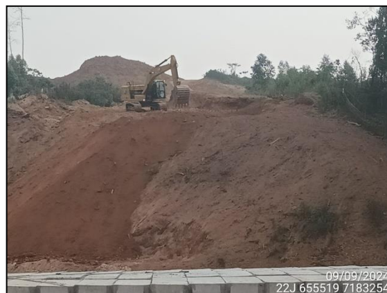
FIGURA 2: ESCAVAÇÃO E MOVIMENTAÇÃO DE SOLO.
