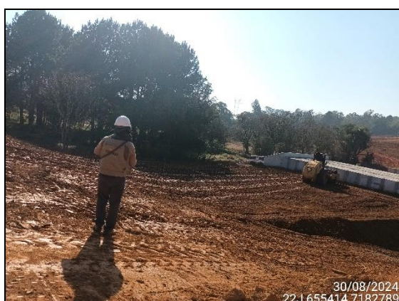
FIGURA 80: ARQUEÓLOGO ACOMPANHANDO TERRAPLANAGEM.
