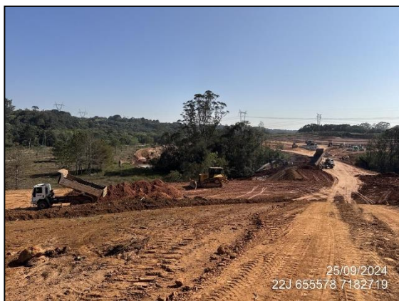
FIGURA 105: ESCAVAÇÃO E MOVIMENTAÇÃO DE SOLO
