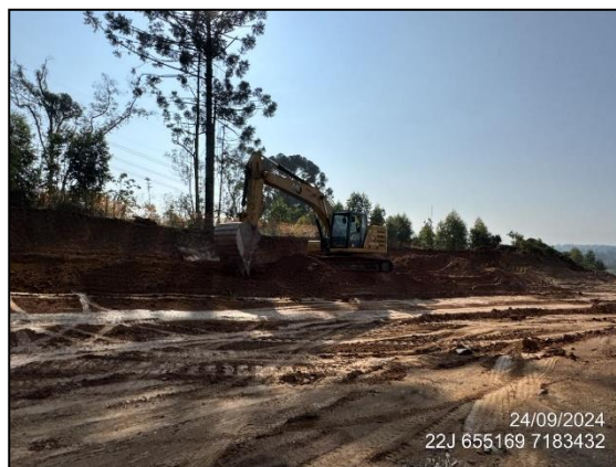
FIGURA 2: ESCAVAÇÃO E MOVIMENTAÇÃO DE SOLO.
