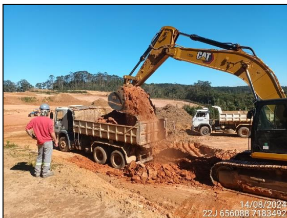
FIGURA 5: ESCAVAÇÃO E MOVIMENTAÇÃO DE SOLO.
