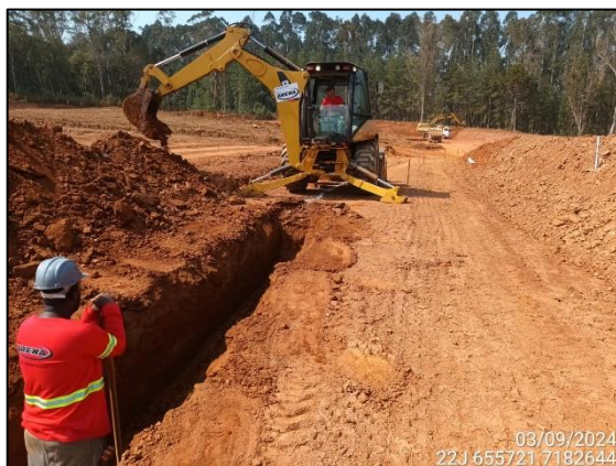
FIGURA 85: ESCAVAÇÃO E MOVIMENTAÇÃO DE SOLO.
