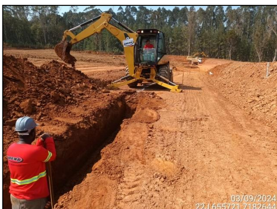
FIGURA 3: ESCAVAÇÃO E MOVIMENTAÇÃO DE SOLO.
