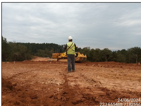
FIGURA 84: ARQUEÓLOGO ACOMPANHANDO TERRAPLANAGEM.
