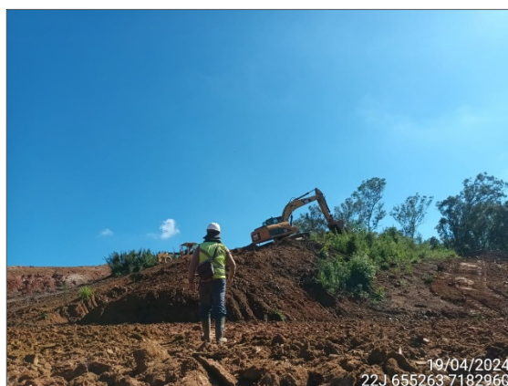
FIGURA 21: ARQUEÓLOGO ACOMPANHANDO ESCAVAÇÃO E MOVIMENTAÇÃO DE SOLO.
