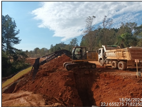
FIGURA 3: ESCAVAÇÃO E MOVIMENTAÇÃO DE SOLO.
