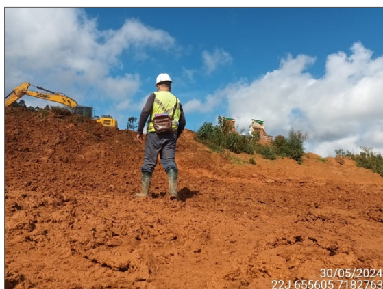
FIGURA 59: ARQUEÓLOGO ACOMPANHANDO ESCAVAÇÃO E MOVIMENTAÇÃO DE SOLO.
