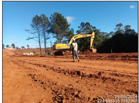
FIGURA 4: ARQUEÓLOGO ACOMPANHANDO ESCAVAÇÃO E MOVIMENTAÇÃO DE SOLO.
