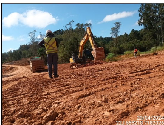
FIGURA 28: ARQUEÓLOGO ACOMPANHANDO ESCAVAÇÃO E MOVIMENTAÇÃO DE SOLO.
