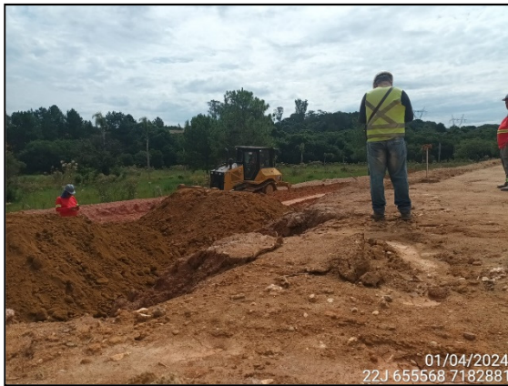
FIGURA 1: ARQUEÓLOGO ACOMPANHANDO TERRAPLANAGEM.
