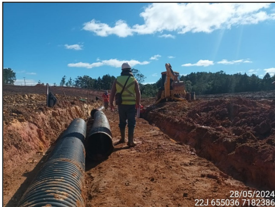
FIGURA 3: ARQUEÓLOGO ACOMPANHANDO ESCAVAÇÃO E MOVIMENTAÇÃO DE SOLO.
