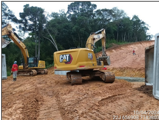
FIGURA 3: ESCAVAÇÃO E MOVIMENTAÇÃO DE SOLO.
