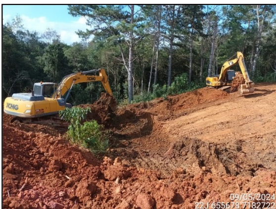
FIGURA 39: ESCAVAÇÃO E MOVIMENTAÇÃO DE SOLO.
