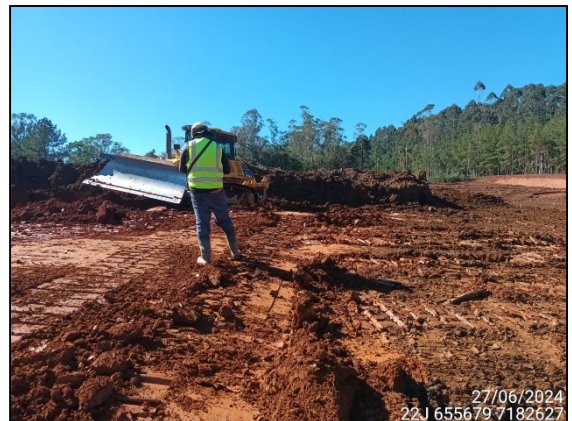
FIGURA 6: ARQUEÓLOGO ACOMPANHANDO TERRAPLANAGEM.
