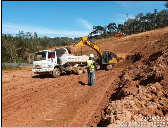
FIGURA 1: ARQUEÓLOGO ACOMPANHANDO ESCAVAÇÃO E MOVIMENTAÇÃO DE SOLO.
