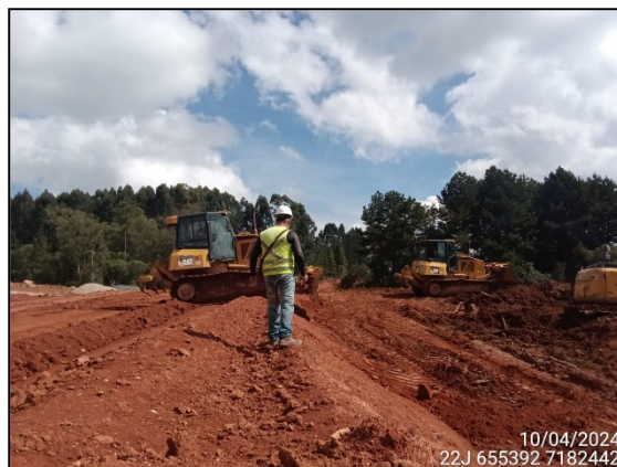
FIGURA 14: ARQUEÓLOGO ACOMPANHANDO ESCAVAÇÃO E MOVIMENTAÇÃO DE SOLO.
