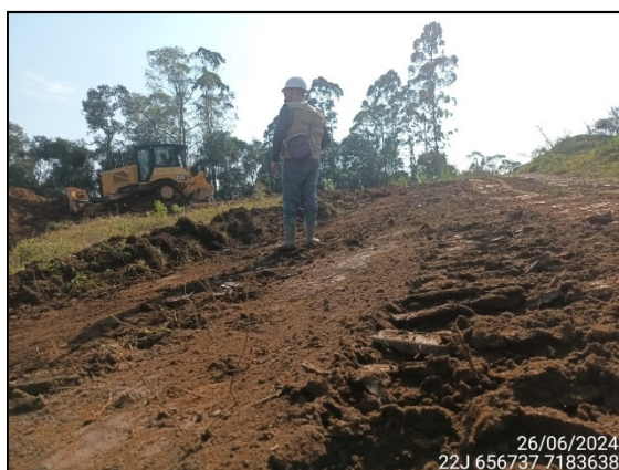
FIGURA 88: ARQUEÓLOGO ACOMPANHANDO TERRAPLANAGEM.
