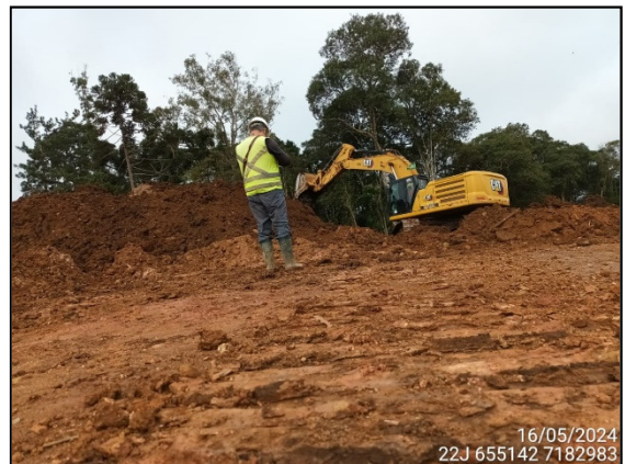
FIGURA 4: ARQUEÓLOGO ACOMPANHANDO ESCAVAÇÃO E MOVIMENTAÇÃO DE SOLO.
