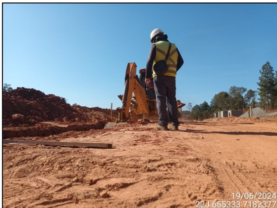
FIGURA 5: ARQUEÓLOGO ACOMPANHANDO ESCAVAÇÃO E MOVIMENTAÇÃO DE SOLO.
