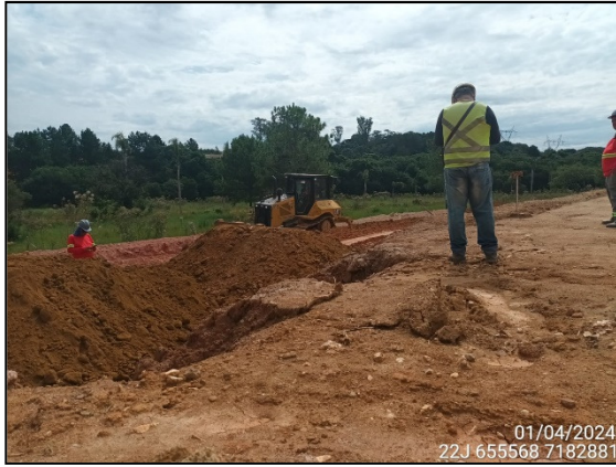
FIGURA 6: ARQUEÓLOGO ACOMPANHANDO TERRAPLANAGEM.
