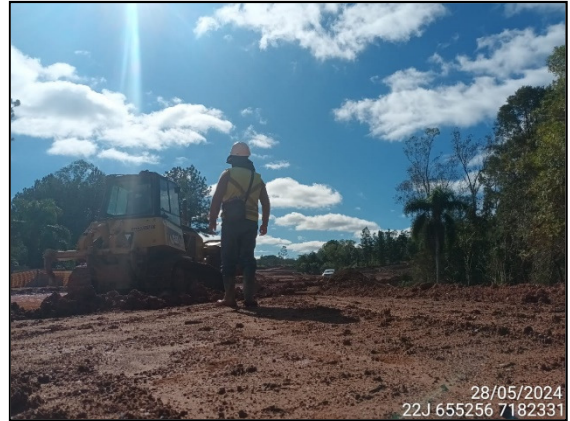
FIGURA 2: ARQUEÓLOGO ACOMPANHANDO TERRAPLANAGEM.
