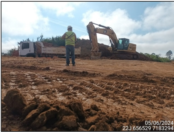
FIGURA 66: ARQUEÓLOGO ACOMPANHANDO ESCAVAÇÃO E MOVIMENTAÇÃO DE SOLO.
