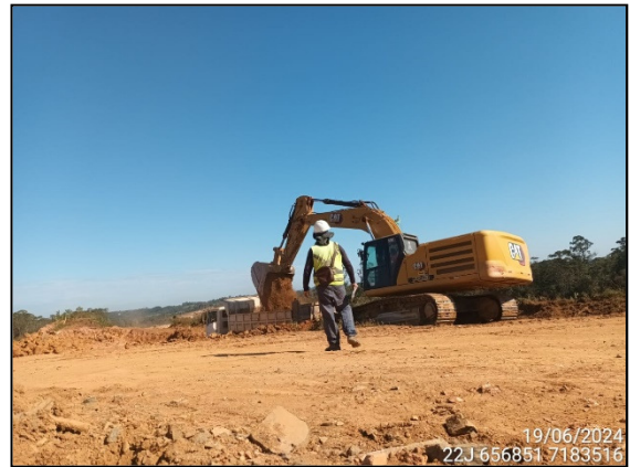
FIGURA 4: ARQUEÓLOGO ACOMPANHANDO ESCAVAÇÃO E MOVIMENTAÇÃO DE SOLO.
