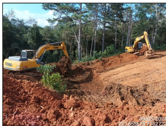
FIGURA 4: ESCAVAÇÃO E MOVIMENTAÇÃO DE SOLO.
