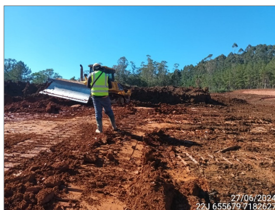
FIGURA 89: ARQUEÓLOGO ACOMPANHANDO TERRAPLANAGEM.
