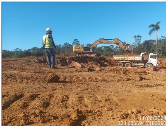
FIGURA 3: ARQUEÓLOGO ACOMPANHANDO ESCAVAÇÃO E MOVIMENTAÇÃO DE SOLO.
