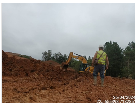
FIGURA 27: ARQUEÓLOGO ACOMPANHANDO ESCAVAÇÃO E MOVIMENTAÇÃO DE SOLO
