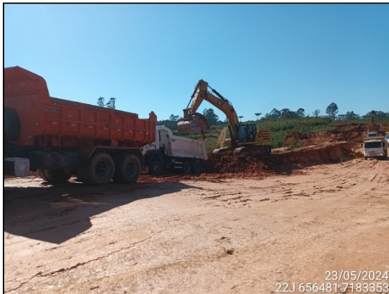
FIGURA 53: ESCAVAÇÃO E MOVIMENTAÇÃO DE SOLO.
