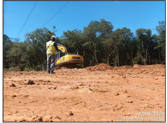
FIGURA 7: ARQUEÓLOGO ACOMPANHANDO ESCAVAÇÃO E MOVIMENTAÇÃO DE SOLO.
