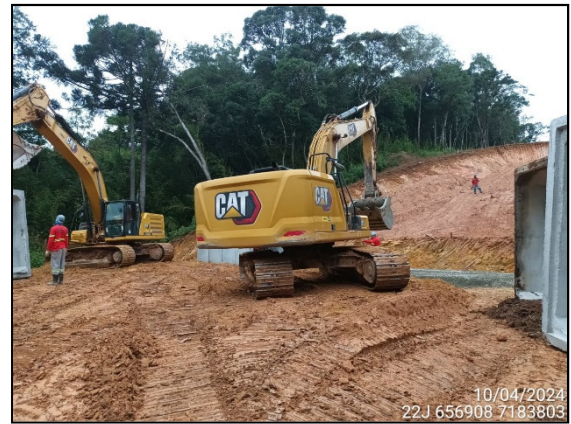
FIGURA 13: ESCAVAÇÃO E MOVIMENTAÇÃO DE SOLO.
