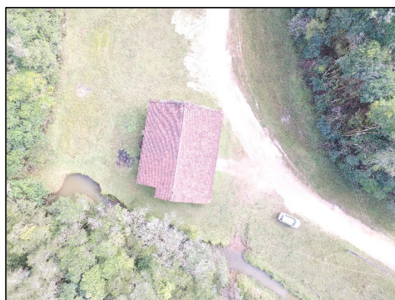
FIGURA 5: BARRACÃO DA ANTIGA MINA TIMBUTUVA
