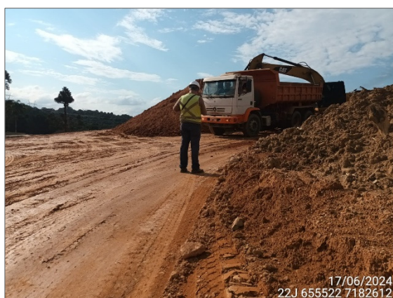
FIGURA 77: ARQUEÓLOGO ACOMPANHANDO ESCAVAÇÃO E MOVIMENTAÇÃO DE SOLO.
