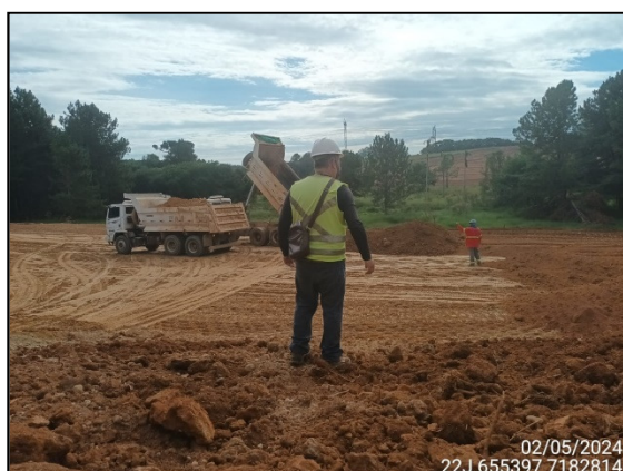
FIGURA 31: ARQUEÓLOGO ACOMPANHANDO TERRAPLANAGEM.
