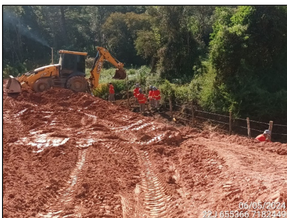
FIGURA 35: COLOCAÇÃO DE TELA EM ÁREA DE APP.
