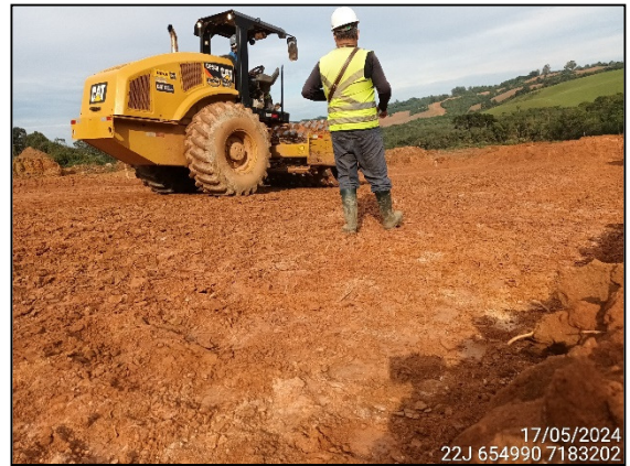
FIGURA 48: ARQUEÓLOGO ACOMPANHANDO TERRAPLANAGEM.
