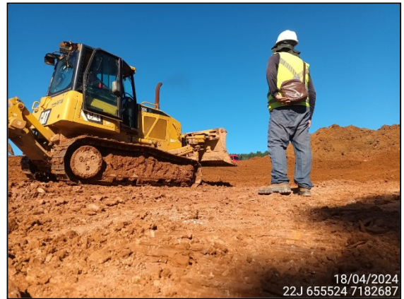
FIGURA 4: ARQUEÓLOGO ACOMPANHANDO TERRAPLANAGEM.
