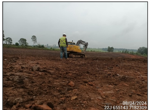
FIGURA 11: ARQUEÓLOGO ACOMPANHANDO ESCAVAÇÃO E MOVIMENTAÇÃO DE SOLO.
