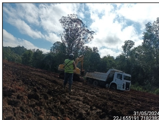
FIGURA 60: ESCAVAÇÃO E MOVIMENTAÇÃO DE SOLO.
