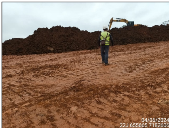
FIGURA 3: ARQUEÓLOGO ACOMPANHANDO ESCAVAÇÃO E MOVIMENTAÇÃO DE SOLO.
