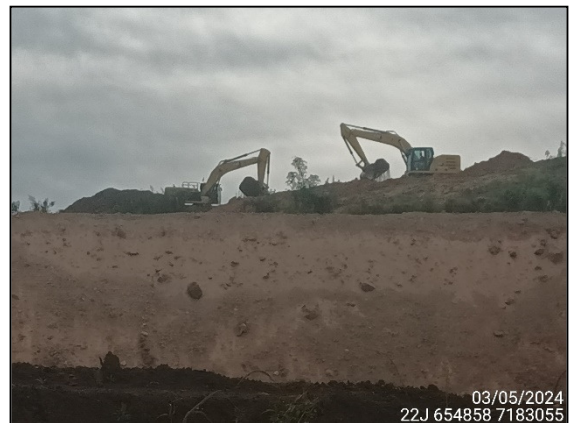
FIGURA 6: ESCAVAÇÃO E MOVIMENTAÇÃO DE SOLO.
