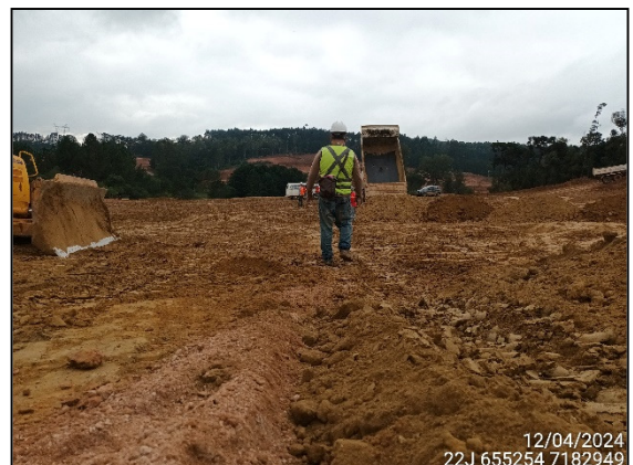
FIGURA 6: ARQUEÓLOGO ACOMPANHANDO TERRAPLANAGEM.
