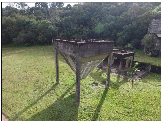
FIGURA 2: ANTIGA ESTRUTURA DOS BRITADORES DA MINA TIMBUTUVA
