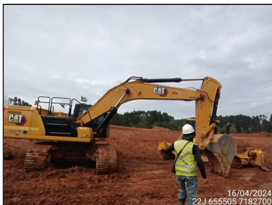
FIGURA 18: ARQUEÓLOGO ACOMPANHANDO ESCAVAÇÃO E MOVIMENTAÇÃO DE SOLO.
