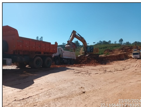
FIGURA 4: ESCAVAÇÃO E MOVIMENTAÇÃO DE SOLO.
