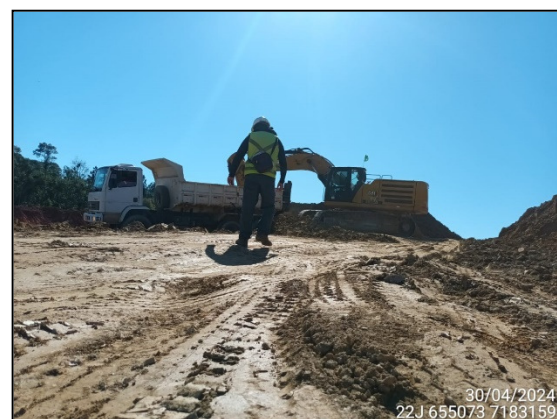
FIGURA 29: ESCAVAÇÃO E MOVIMENTAÇÃO DE SOLO.
