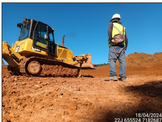
FIGURA 20: ARQUEÓLOGO ACOMPANHANDO TERRAPLANAGEM.
