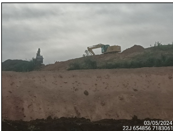
FIGURA 33: A ESCAVAÇÃO E MOVIMENTAÇÃO DE SOLO.
