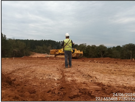
FIGURA 1: ARQUEÓLOGO ACOMPANHANDO TERRAPLANAGEM.
