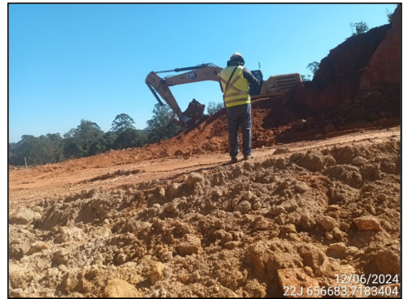
FIGURA 73: ARQUEÓLOGO ACOMPANHANDO ESCAVAÇÃO E MOVIMENTAÇÃO DE SOLO.
