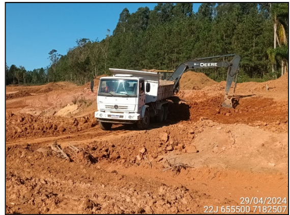
FIGURA 2: ESCAVAÇÃO E MOVIMENTAÇÃO DE SOLO.
