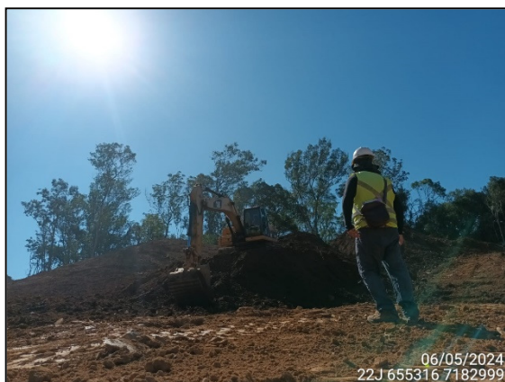
FIGURA 1: ARQUEÓLOGO ACOMPANHANDO ESCAVAÇÃO E MOVIMENTAÇÃO DE SOLO.
