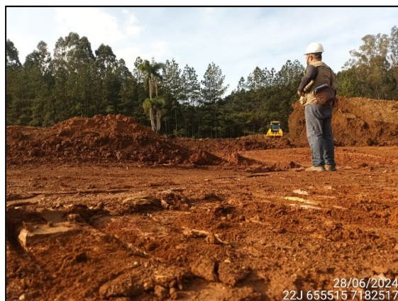
FIGURA 8: ARQUEÓLOGO ACOMPANHANDO TERRAPLANAGEM.
