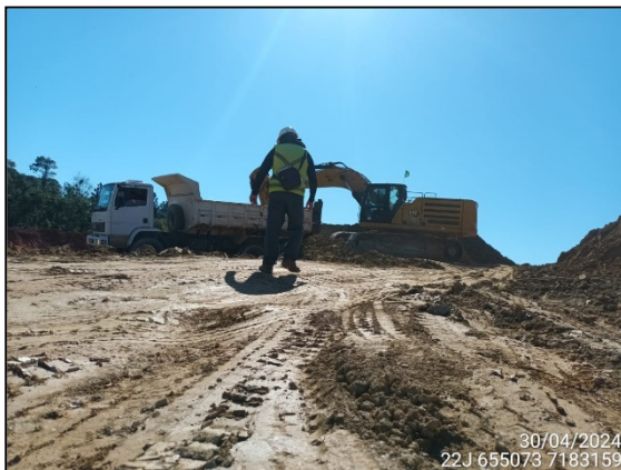
FIGURA 3: ARQUEÓLOGO ACOMPANHANDO ESCAVAÇÃO E MOVIMENTAÇÃO DE MATERIAL ROCHOSO.
