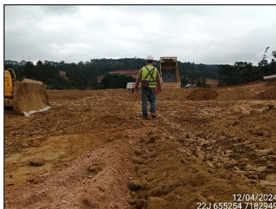
FIGURA 16: ARQUEÓLOGO ACOMPANHANDO TERRAPLANAGEM.
