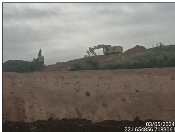
FIGURA 7: ESCAVAÇÃO E MOVIMENTAÇÃO DE SOLO.
