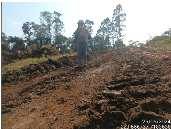
FIGURA 5: ARQUEÓLOGO ACOMPANHANDO TERRAPLANAGEM.
