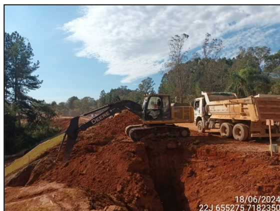
FIGURA 79: ESCAVAÇÃO E MOVIMENTAÇÃO DE SOLO.
