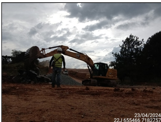
FIGURA 24: ARQUEÓLOGO ACOMPANHANDO ESCAVAÇÃO E MOVIMENTAÇÃO DE MATERIAL ROCHOSO.
