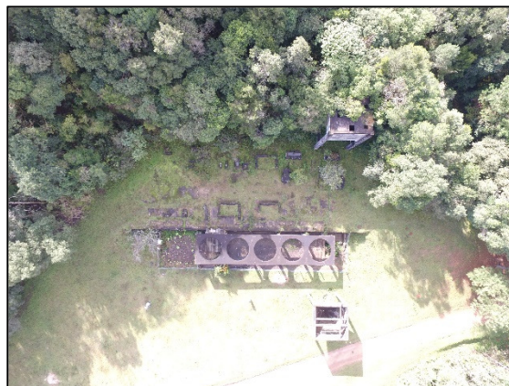
FIGURA 3: ESTRUTURA DA ANTIGA MINA TIMBUTUVA
