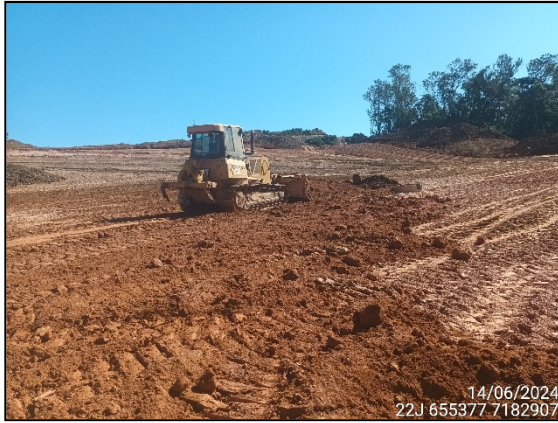
FIGURA 7: TERRAPLANAGEM.
