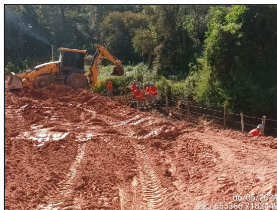
FIGURA 2: COLOCAÇÃO DE TELA EM ÁREA DE APP.
