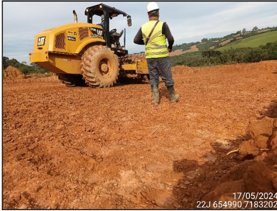
FIGURA 7: ARQUEÓLOGO ACOMPANHANDO TERRAPLANAGEM.
