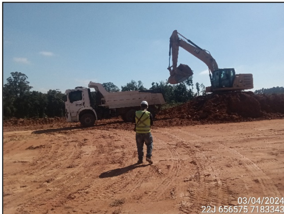
FIGURA 3: ARQUEÓLOGO ACOMPANHANDO ESCAVAÇÃO E MOVIMENTAÇÃO DE SOLO.
