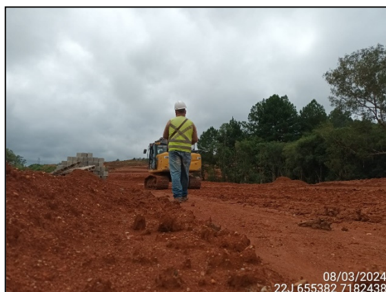
FIGURA 6: ARQUEÓLOGO ACOMPANHANDO ESCAVAÇÃO E MOVIMENTAÇÃO DE SOLO.
