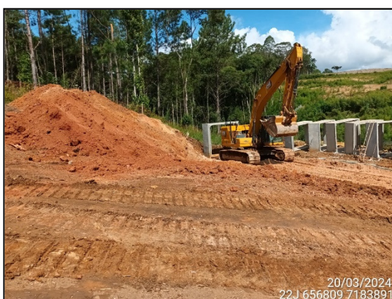
FIGURA 3: ESCAVAÇÃO E MOVIMENTAÇÃO DE SOLO.
