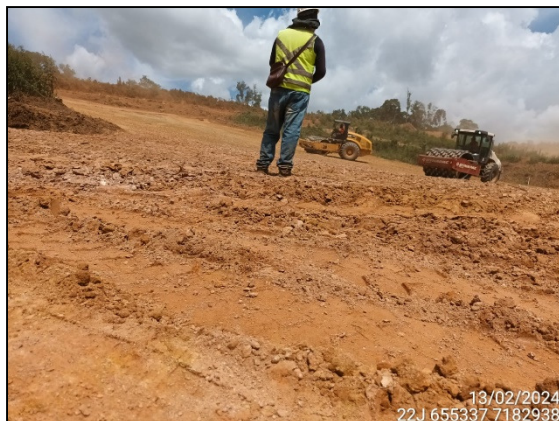
FIGURA 2: ARQUEÓLOGO ACOMPANHANDO TERRAPLANAGEM.
