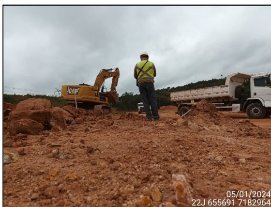
FIGURA 4: ARQUEÓLOGO ACOMPANHANDO ESCAVAÇÃO E MOVIMENTAÇÃO DE SOLO.
