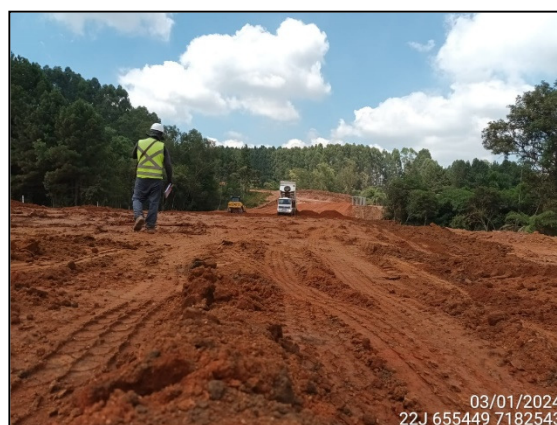
FIGURA 7: ARQUEÓLOGO ACOMPANHANDO TERRAPLANAGEM.
