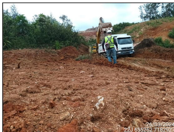
FIGURA 68: ARQUEÓLOGO ACOMPANHANDO TERRAPLANAGEM.
