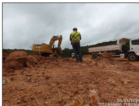
FIGURA 9: ARQUEÓLOGO ACOMPANHANDO ESCAVAÇÃO E MOVIMENTAÇÃO DE SOLO.
