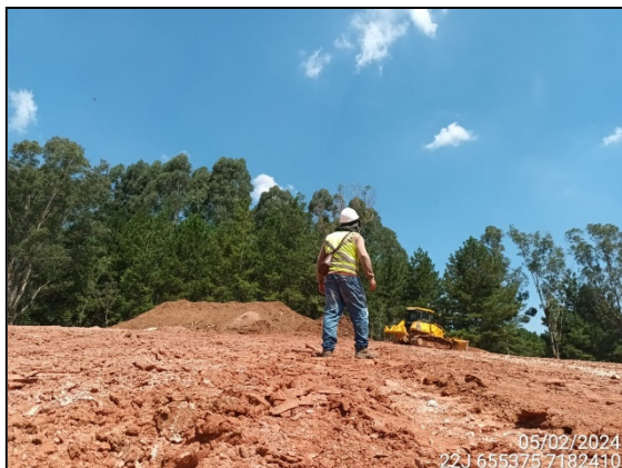
FIGURA 1: ARQUEÓLOGO ACOMPANHANDO TERRAPLANAGEM.
