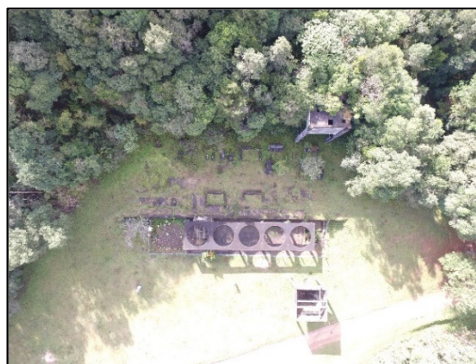
FIGURA 3: ESTRUTURA DA ANTIGA MINA TIMBUTUVA
