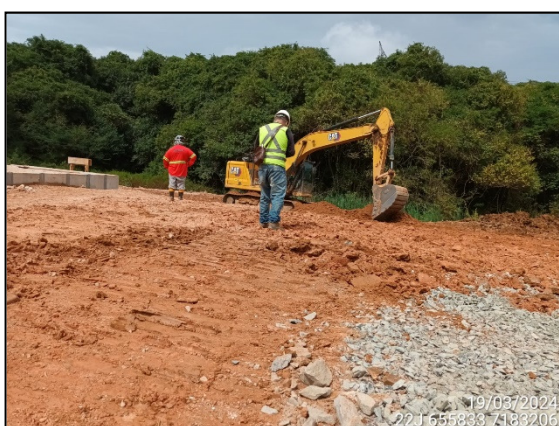
FIGURA 63: ARQUEÓLOGO ACOMPANHANDO ESCAVAÇÃO E MOVIMENTAÇÃO DE SOLO.
