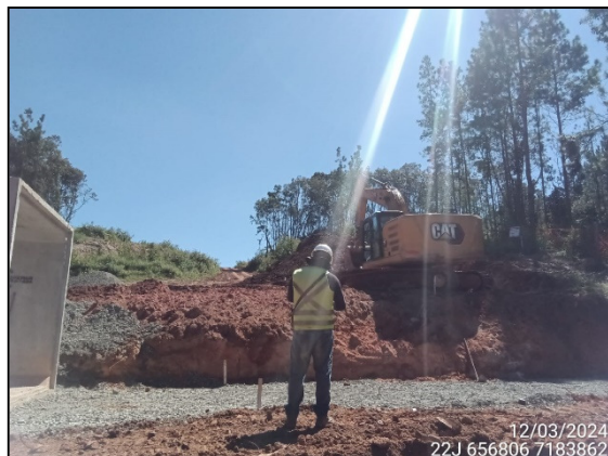
FIGURA 2: ARQUEÓLOGO ACOMPANHANDO ESCAVAÇÃO E MOVIMENTAÇÃO DE SOLO.
