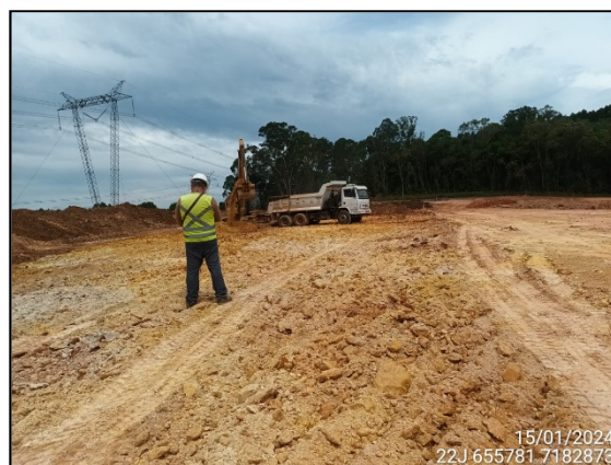
FIGURA 15: ESCAVAÇÃO E MOVIMENTAÇÃO DE SOLO.
