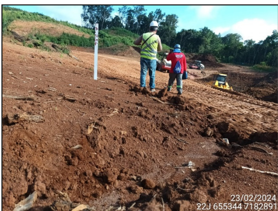
FIGURA 5: ARQUEÓLOGO ACOMPANHANDO TERRAPLANAGEM.
