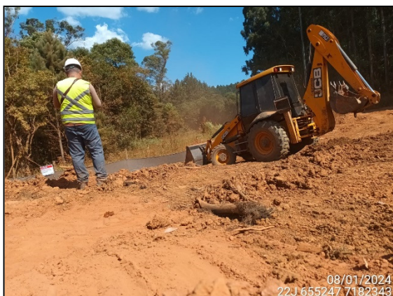
FIGURA 1: ARQUEÓLOGO ACOMPANHANDO ESCAVAÇÃO E MOVIMENTAÇÃO DE SOLO.
