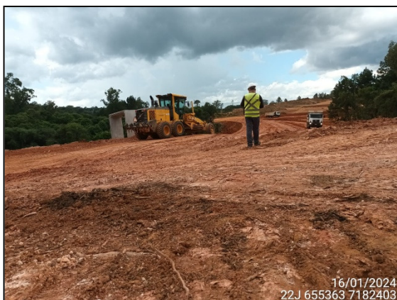
FIGURA 16: ARQUEÓLOGO ACOMPANHANDO TERRAPLANAGEM.
