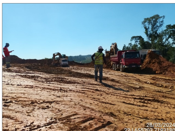
FIGURA 70: ARQUEÓLOGO ACOMPANHANDO ESCAVAÇÃO E MOVIMENTAÇÃO DE SOLO.
