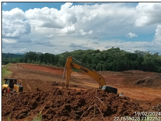
FIGURA 1: ESCAVAÇÃO E MOVIMENTAÇÃO DE SOLO.
