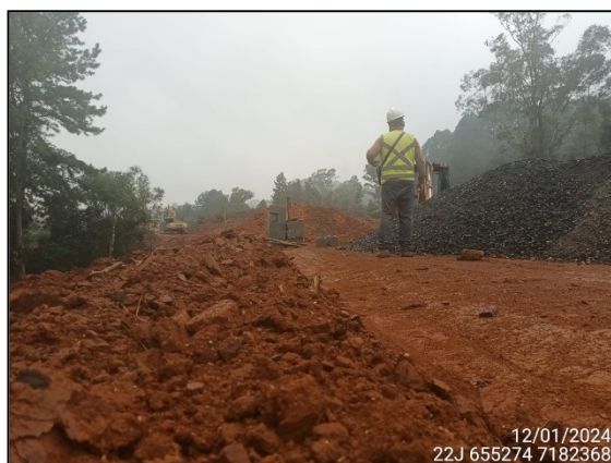
FIGURA 14: ARQUEÓLOGO ACOMPANHANDO ESCAVAÇÃO E MOVIMENTAÇÃO DE SOLO.
