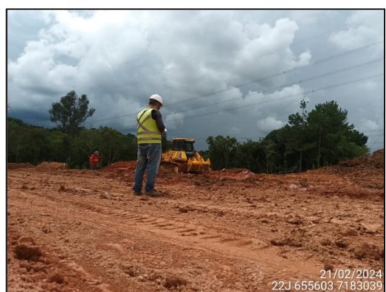
FIGURA 43: ARQUEÓLOGO ACOMPANHANDO TERRAPLANAGEM.
