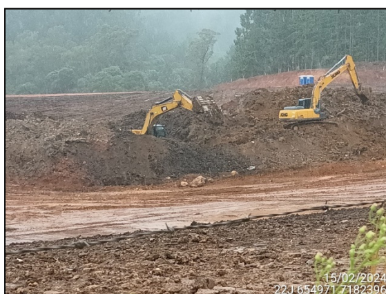
FIGURA 4: ESCAVAÇÃO E MOVIMENTAÇÃO DE SOLO.
