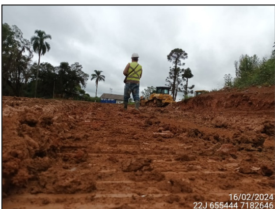
FIGURA 5: ARQUEÓLOGO ACOMPANHANDO TERRAPLANAGEM.
