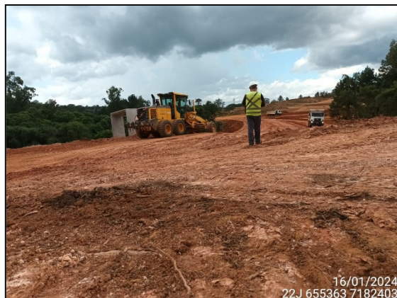
FIGURA 2: ARQUEÓLOGO ACOMPANHANDO TERRAPLANAGEM.
