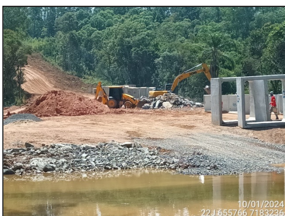
FIGURA 12: MOVIMENTAÇÃO DE MATERIAL ROCHOSO.
