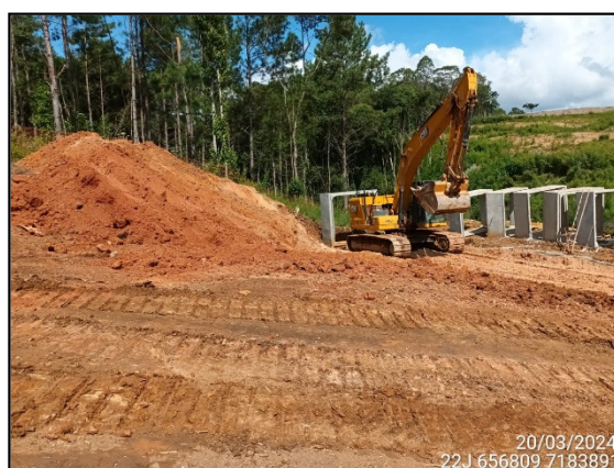
FIGURA 64: ESCAVAÇÃO E MOVIMENTAÇÃO DE SOLO.
