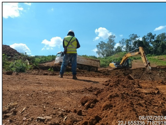
FIGURA 34: ARQUEÓLOGO ACOMPANHANDO ESCAVAÇÃO E MOVIMENTAÇÃO DE SOLO.
