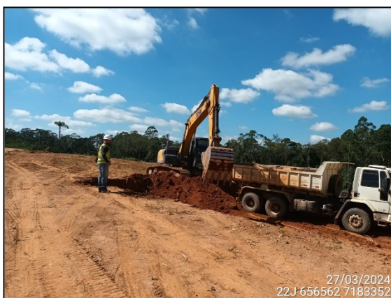
FIGURA 3: ARQUEÓLOGO ACOMPANHANDO ESCAVAÇÃO E MOVIMENTAÇÃO DE SOLO.
