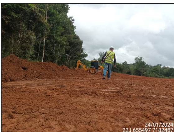
FIGURA 3: ARQUEÓLOGO ACOMPANHANDO ESCAVAÇÃO E MOVIMENTAÇÃO DE SOLO.
