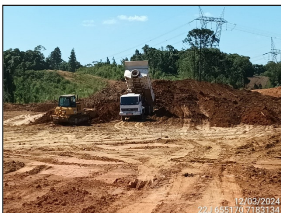
FIGURA 3: ESCAVAÇÃO E MOVIMENTAÇÃO DE SOLO.
