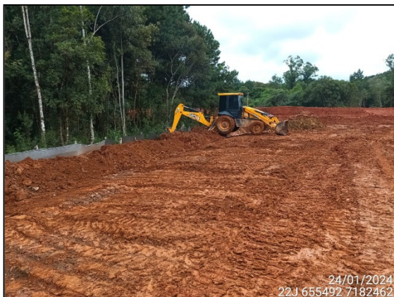
FIGURA 22: ARQUEÓLOGO ACOMPANHANDO ESCAVAÇÃO E MOVIMENTAÇÃO DE SOLO.
