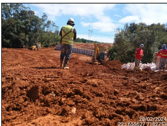
FIGURA 3: ARQUEÓLOGO ACOMPANHANDO ESCAVAÇÃO E MOVIMENTAÇÃO DE SOLO.
