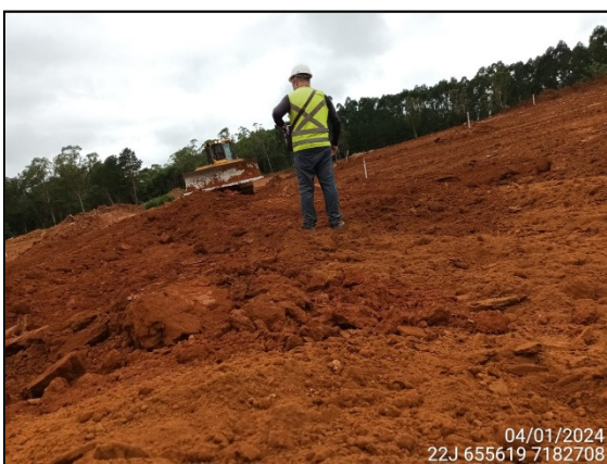
FIGURA 3: ARQUEÓLOGO ACOMPANHANDO TERRAPLANAGEM.
