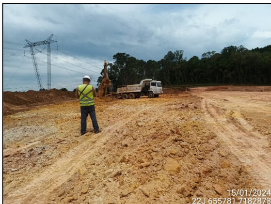
FIGURA 1: ARQUEÓLOGO ACOMPANHANDO ESCAVAÇÃO E MOVIMENTAÇÃO DE SOLO.
