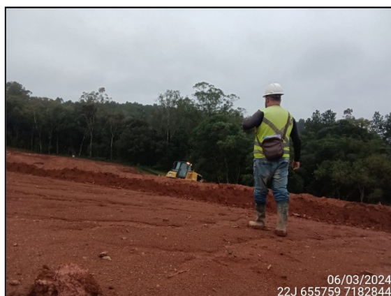
FIGURA 4: ARQUEÓLOGO ACOMPANHANDO TERRAPLANAGEM.
