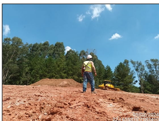
FIGURA 31: ARQUEÓLOGO ACOMPANHANDO TERRAPLANAGEM.
