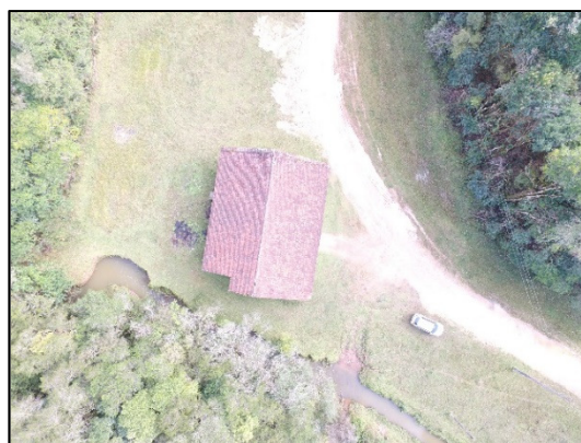
FIGURA 5: BARRACÃO DA ANTIGA MINA TIMBUTUVA
