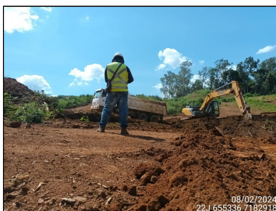
FIGURA 4: ARQUEÓLOGO ACOMPANHANDO ESCAVAÇÃO E MOVIMENTAÇÃO DE SOLO.
