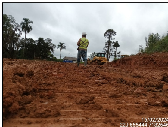
FIGURA 40: ARQUEÓLOGO ACOMPANHANDO TERRAPLANAGEM
