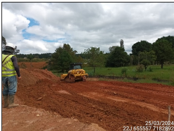
FIGURA 1: ARQUEÓLOGO ACOMPANHANDO TERRAPLANAGEM.
