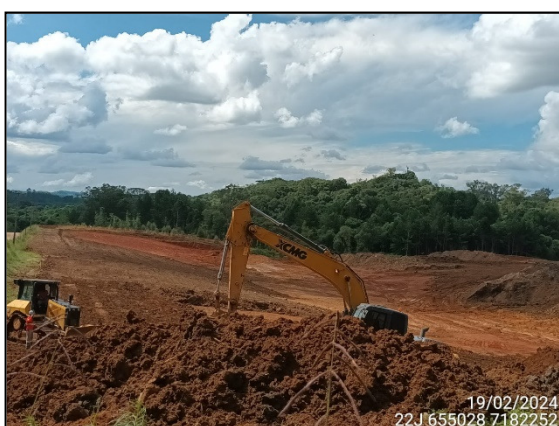
FIGURA 41: ESCAVAÇÃO E MOVIMENTAÇÃO DE SOLO.
