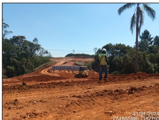
FIGURA 6: ARQUEÓLOGO ACOMPANHANDO TERRAPLANAGEM.
