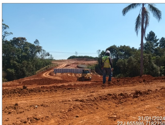
FIGURA 27: ARQUEÓLOGO ACOMPANHANDO TERRAPLANAGEM.
