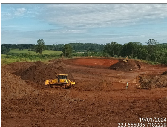
FIGURA 5: ESCAVAÇÃO E MOVIMENTAÇÃO DE SOLO.
