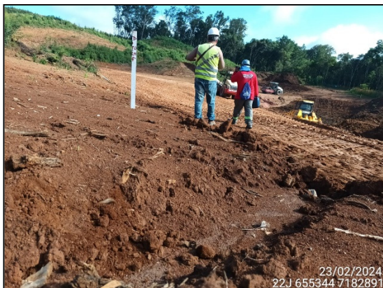
FIGURA 45: ARQUEÓLOGO ACOMPANHANDO TERRAPLANAGEM.
