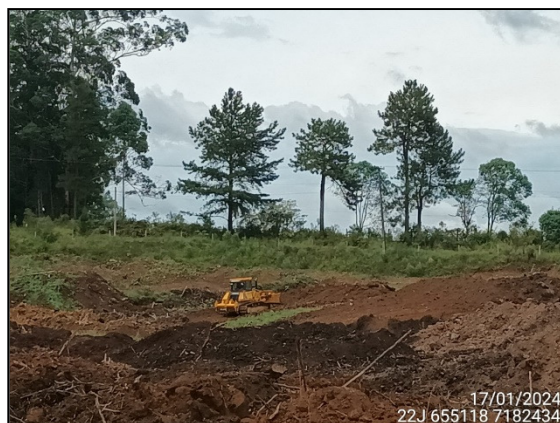
FIGURA 17: ESCAVAÇÃO E MOVIMENTAÇÃO DE SOLO.
