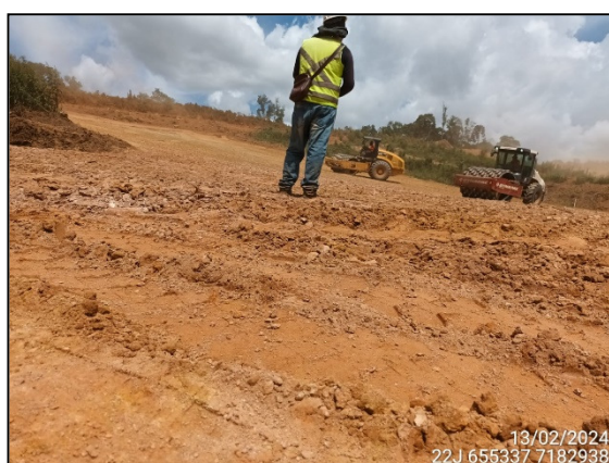
FIGURA 37: ARQUEÓLOGO ACOMPANHANDO TERRAPLANAGEM.
