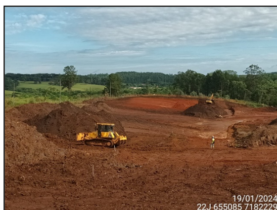
FIGURA 19: ESCAVAÇÃO E MOVIMENTAÇÃO DE SOLO.
