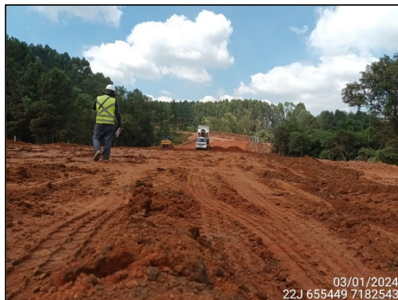
FIGURA 2: ARQUEÓLOGO ACOMPANHANDO TERRAPLANAGEM.
