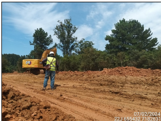
FIGURA 33: ARQUEÓLOGO ACOMPANHANDO ESCAVAÇÃO E MOVIMENTAÇÃO DE SOLO.
