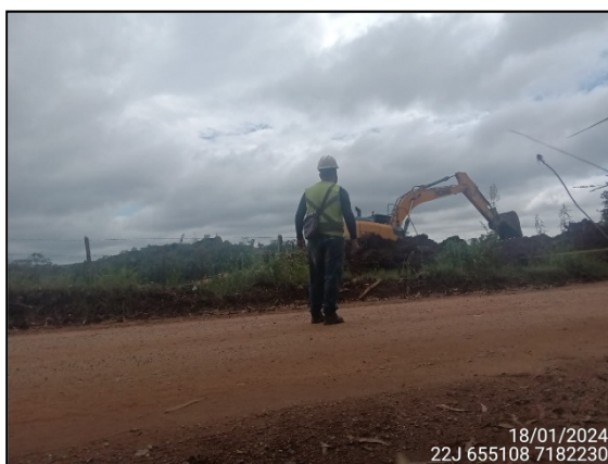
FIGURA 4: ARQUEÓLOGO ACOMPANHANDO ESCAVAÇÃO E MOVIMENTAÇÃO DE SOLO.
