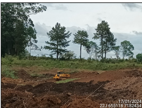
FIGURA 3: ESCAVAÇÃO E MOVIMENTAÇÃO DE SOLO.
