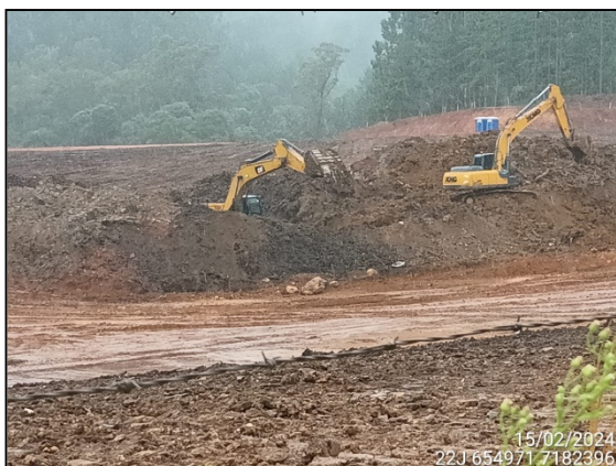
FIGURA 39: ESCAVAÇÃO E MOVIMENTAÇÃO DE SOLO
