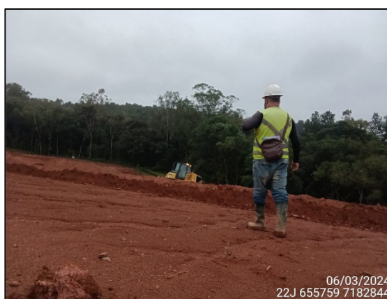
FIGURA 54: ARQUEÓLOGO ACOMPANHANDO TERRAPLANAGEM.
