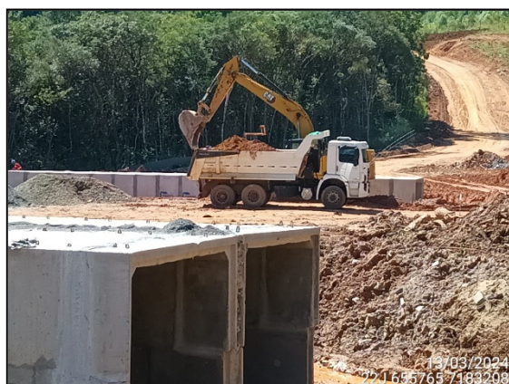
FIGURA 4: ESCAVAÇÃO E MOVIMENTAÇÃO DE SOLO.
