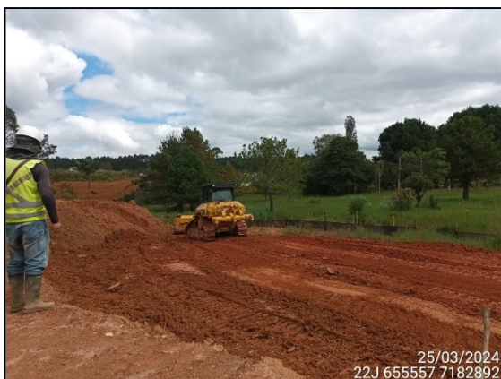
FIGURA 67: ARQUEÓLOGO ACOMPANHANDO TERRAPLANAGEM.
