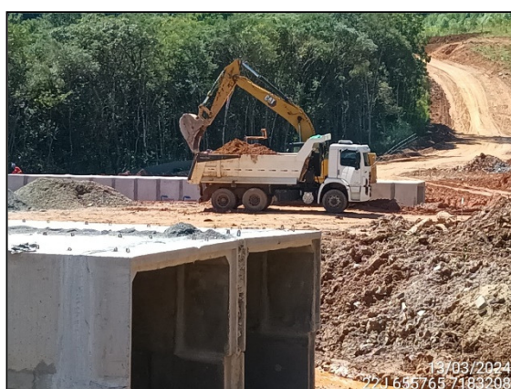
FIGURA 59: ESCAVAÇÃO E MOVIMENTAÇÃO DE SOLO.
