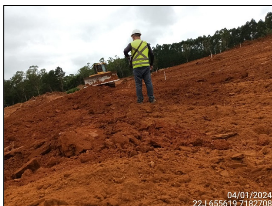
FIGURA 8: ARQUEÓLOGO ACOMPANHANDO TERRAPLANAGEM.
