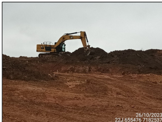
FIGURA 25: ESCAVAÇÃO E MOVIMENTAÇÃO DE SOLO.
