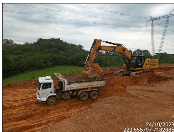
FIGURA 23: ESCAVAÇÃO E MOVIMENTAÇÃO DE SOLO.
