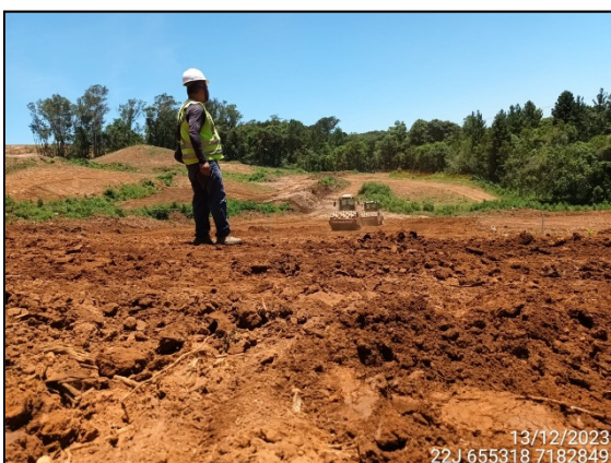
FIGURA 3: ARQUEÓLOGO ACOMPANHANDO TERRAPLANAGEM.
