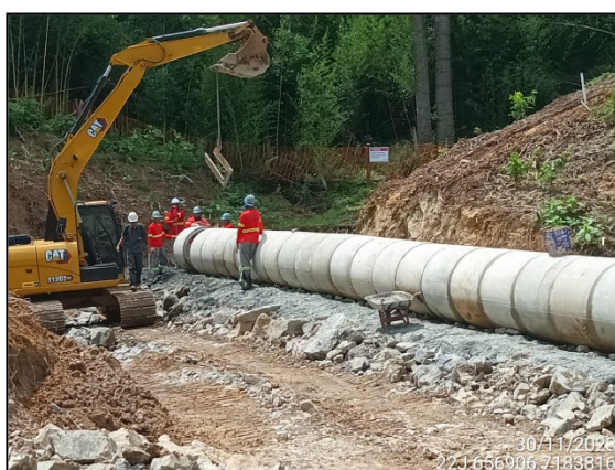
FIGURA 49: MOVIMENTAÇÃO DE TUBULAÇÃO DE CONCRETO.
