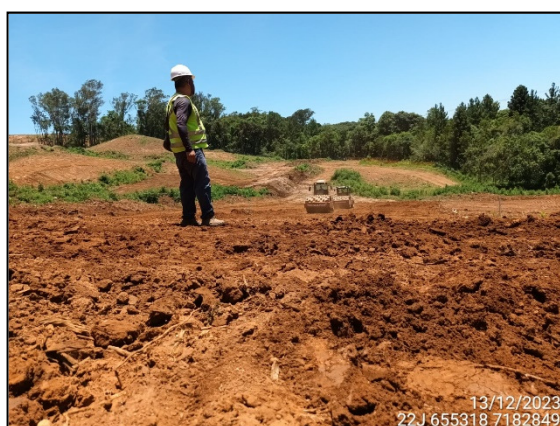
FIGURA 59: ARQUEÓLOGO ACOMPANHANDO TERRAPLANAGEM.
