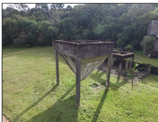
FIGURA 2: ANTIGA ESTRUTURA DOS BRITADORES DA MINA TIMBUTUVA
