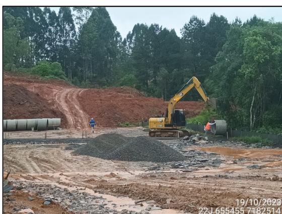
FIGURA 20: MOVIMENTAÇÃO DE TUBULAÇÃO DE CONCRETO.
