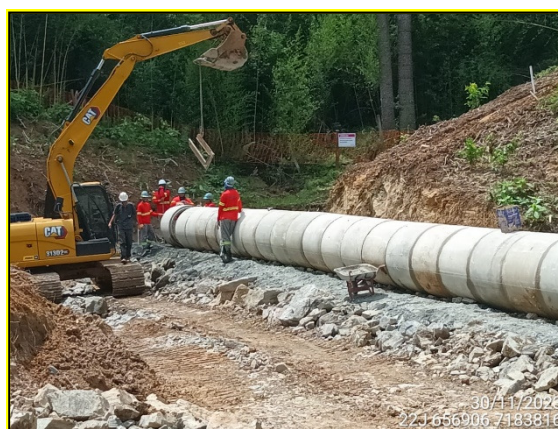
FIGURA 4: ARQUEÓLOGO ACOMPANHANDO MOVIMENTAÇÃO DE TUBULAÇÃO DE CONCRETO.
