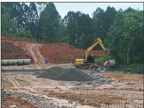
FIGURA 5: MOVIMENTAÇÃO DE TUBULAÇÕES DE CONCRETO.
