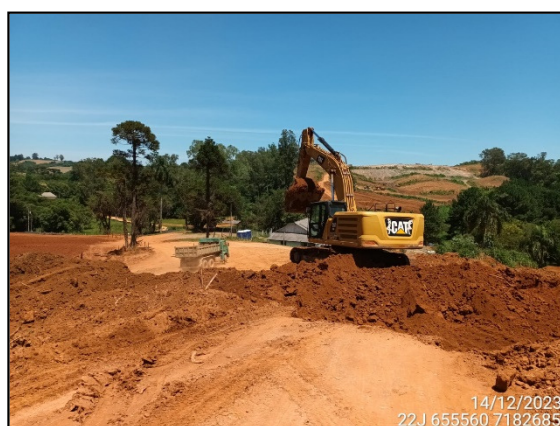
FIGURA 60: ESCAVAÇÃO E MOVIMENTAÇÃO DE SOLO.
