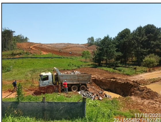
FIGURA 14: MOVIMENTAÇÃO DE MATERIAL ROCHOSO.
