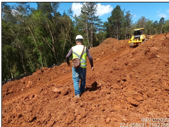
FIGURA 1: ARQUEÓLOGO DE CAMPO ACOMPANHANDO TERRAPLANAGEM.
