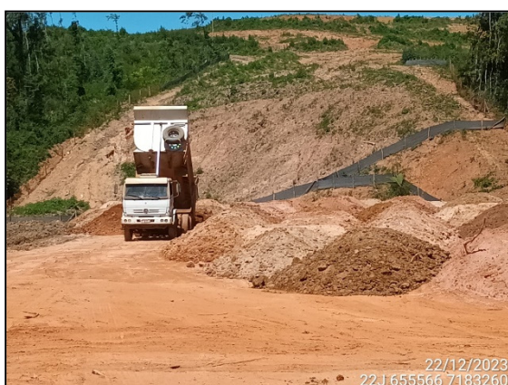
FIGURA 6: ESCAVAÇÃO E MOVIMENTAÇÃO DE SOLO.
