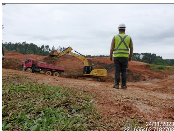
FIGURA 5: ARQUEÓLOGO ACOMPANHANDO ESCAVAÇÃO E MOVIMENTAÇÃO DE SOLO.
