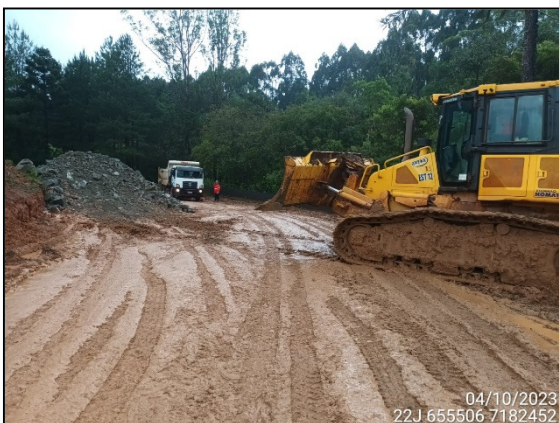
FIGURA 3: MOVIMENTAÇÃO DE MATERIAL ROCHOSO.
