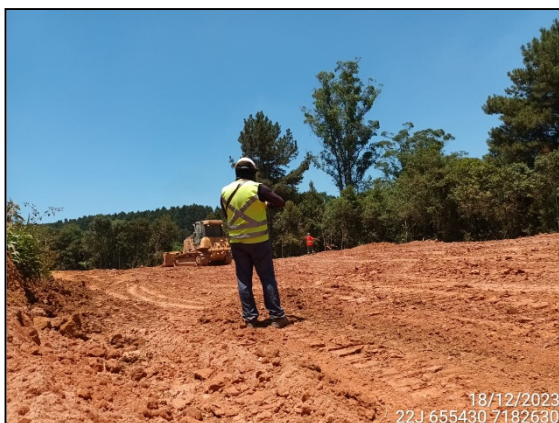
FIGURA 1: ARQUEÓLOGO ACOMPANHANDO TERRAPLANAGEM.
