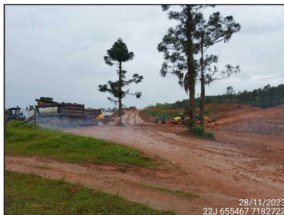
FIGURA 47: OBRA PARALISADA DEVIDO A OCORRÊNCIA DE CHUVAS NA REGIÃO.
