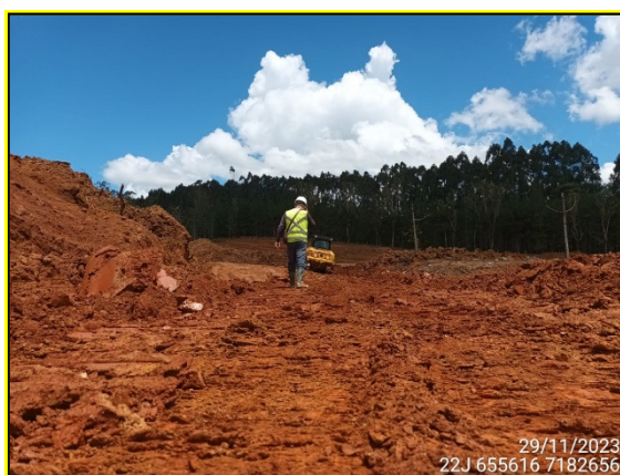
FIGURA 3: ARQUEÓLOGO ACOMPANHANDO TERRAPLANAGEM.
