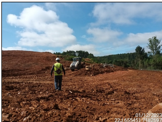
FIGURA 1: ARQUEÓLOGO ACOMPANHANDO TERRAPLANAGEM.
