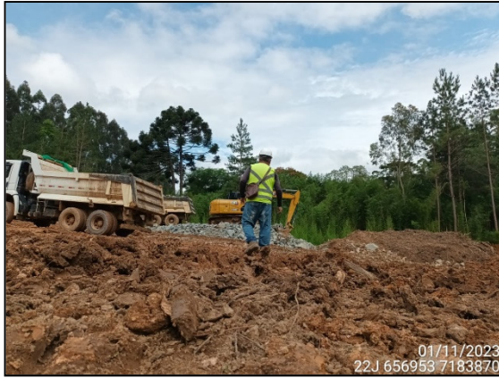
FIGURA 1: ARQUEÓLOGO DE CAMPO ACOMPANHANDO ESCAVAÇÃO E MOVIMENTAÇÃO DE MATERIAL ROCHOSO.
