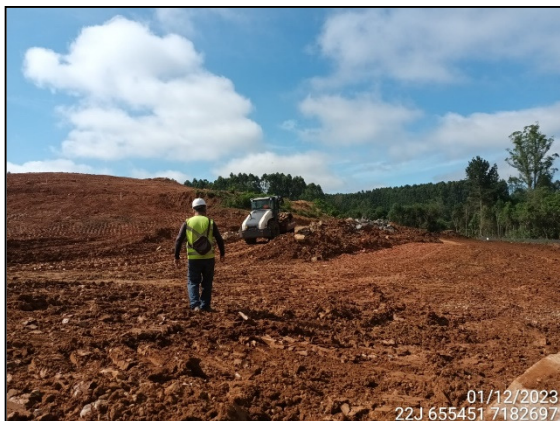
FIGURA 51: ARQUEÓLOGO ACOMPANHANDO TERRAPLANAGEM.
