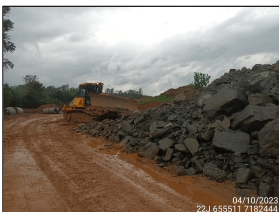
FIGURA 8: MOVIMENTAÇÃO DE MATERIAL ROCHOSO.
