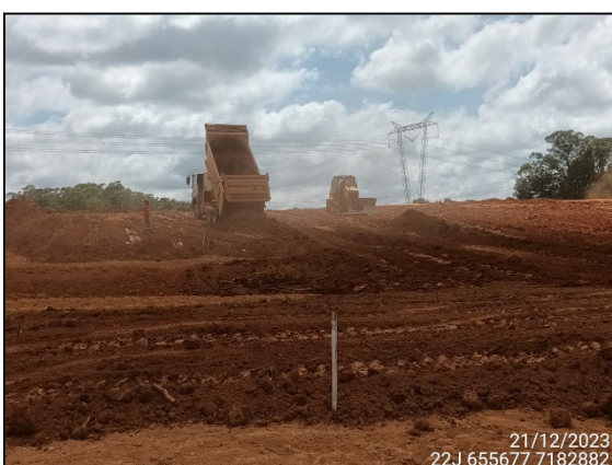
FIGURA 5: ESCAVAÇÃO E MOVIMENTAÇÃO DE SOLO.
