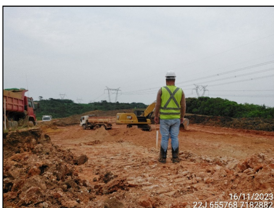
FIGURA 3: ARQUEÓLOGO ACOMPANHANDO ESCAVAÇÃO E MOVIMENTAÇÃO DE SOLO.
