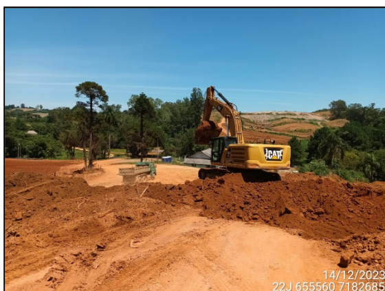
FIGURA 4: ESCAVAÇÃO E MOVIMENTAÇÃO DE SOLO.
