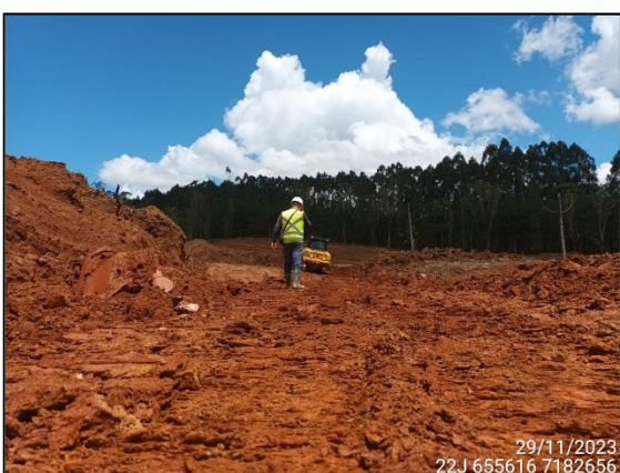
FIGURA 48: ARQUEÓLOGO DE CAMPO ACOMPANHANDO TERRAPLANAGEM.
