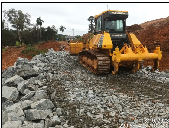
FIGURA 4: MOVIMENTAÇÃO DE MATERIAL ROCHOSO.
