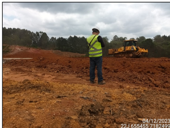
FIGURA 2: ARQUEÓLOGO ACOMPANHANDO TERRAPLANAGEM.
