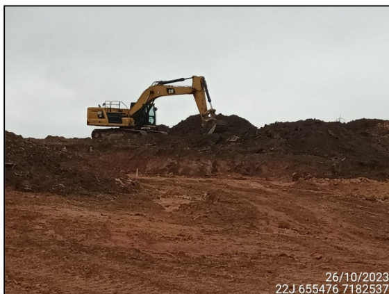
FIGURA 4: ESCAVAÇÃO E MOVIMENTAÇÃO DE SOLO.
