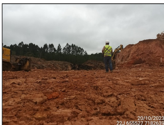
FIGURA 21: ARQUEÓLOGO ACOMPANHANDO ESCAVAÇÃO DE SOLO.
