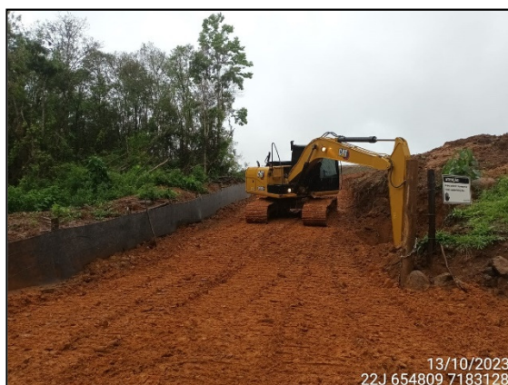
FIGURA 15: ARQUEÓLOGO ACOMPANHANDO ESCAVAÇÃO DE SOLO.
