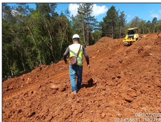
FIGURA 11: ARQUEÓLOGO ACOMPANHANDO TERRAPLANAGEM.
