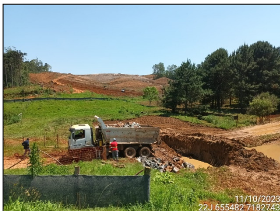
FIGURA 4: MOVIMENTAÇÃO DE MATERIAL ROCHOSO.
