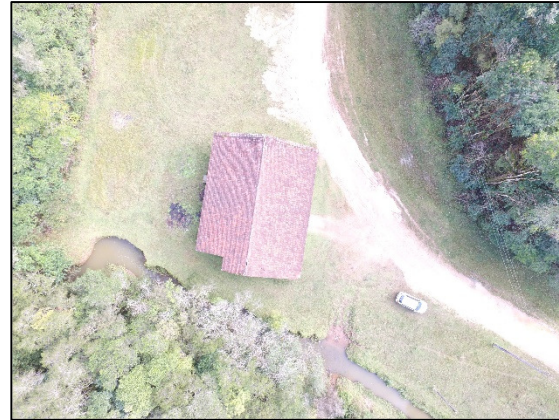
FIGURA 5: BARRACÃO DA ANTIGA MINA TIMBUTUVA
