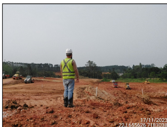
FIGURA 4: ARQUEÓLOGO ACOMPANHANDO TERRAPLANAGEM.
