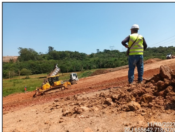
FIGURA 13: ARQUEÓLOGO ACOMPANHANDO ESCAVAÇÃO DE SOLO.
