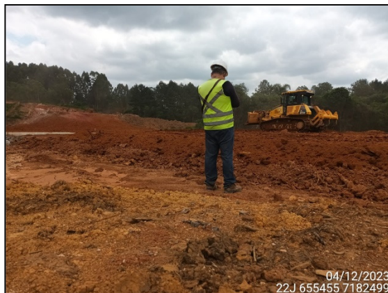
FIGURA 52: ARQUEÓLOGO ACOMPANHANDO TERRAPLANAGEM.
