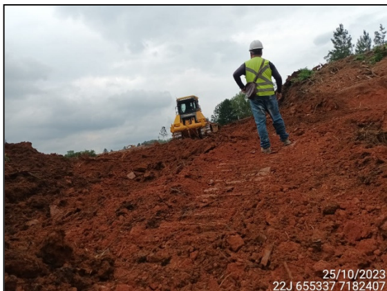
FIGURA 24: ARQUEÓLOGO DE CAMPO ACOMPANHANDO TERRAPLANAGEM.
