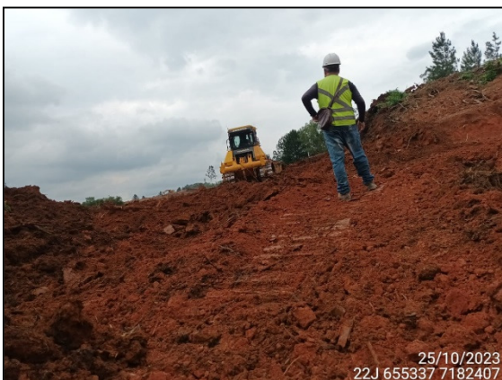
FIGURA 3: ARQUEÓLOGO DE CAMPO ACOMPANHANDO TERRAPLANAGEM.
