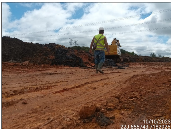
FIGURA 12: ARQUEÓLOGO ACOMPANHANDO ESCAVAÇÃO DE SOLO.
