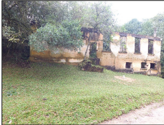
FIGURA 4: PRÉDIO ONDE FUNCIONAVA O LABORATÓRIO DA ANTIGA MINA TIMBUTUVA
