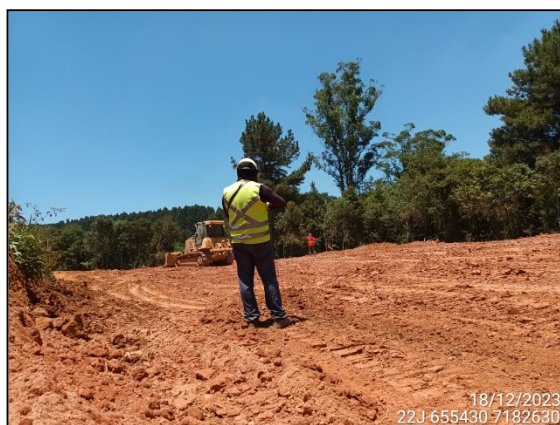
FIGURA 61: ARQUEÓLOGO ACOMPANHANDO TERRAPLANAGEM.
