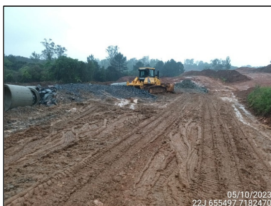
FIGURA 9: MOVIMENTAÇÃO DE MATERIAL ROCHOSO.
