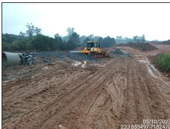
FIGURA 4: MOVIMENTAÇÃO DE MATERIAL ROCHOSO.
