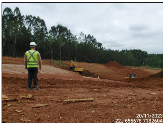
FIGURA 1: ARQUEÓLOGO ACOMPANHANDO ESCAVAÇÃO E MOVIMENTAÇÃO DE SOLO.
