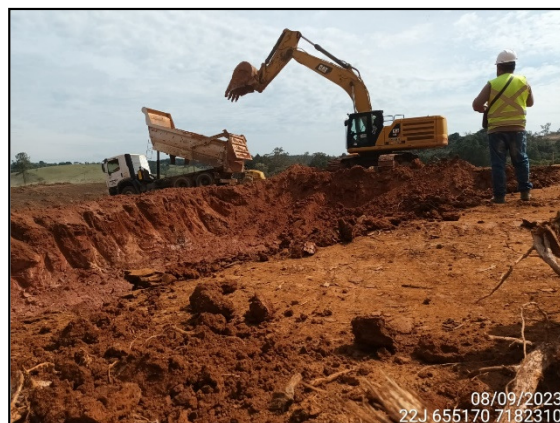
FIGURA 84: ARQUEÓLOGO ACOMPANHANDO ESCAVAÇÃO DE SOLO.
