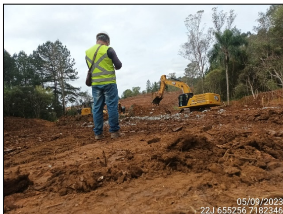
FIGURA 4: ESCAVAÇÃO E MOVIMENTAÇÃO DE MATERIAL ROCHOSO.
