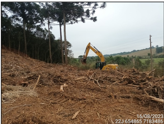
FIGURA 3: LIMPEZA DE ÁREA PREVIAMENTE SUPRIMIDA.
