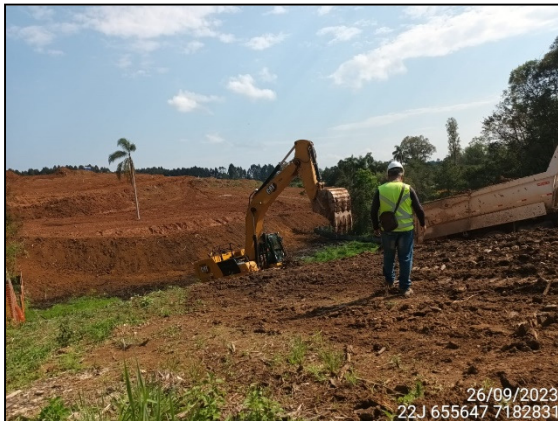
FIGURA 97: ARQUEÓLOGO DE CAMPO ACOMPANHANDO ESCAVAÇÃO DE SOLO.
