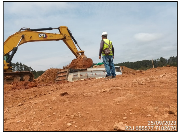
FIGURA 96: ARQUEÓLOGO ACOMPANHANDO ESCAVAÇÃO DE SOLO.
