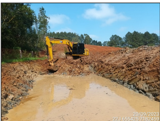
FIGURA 3: ESCAVAÇÃO E MOVIMENTAÇÃO DE SOLO.
