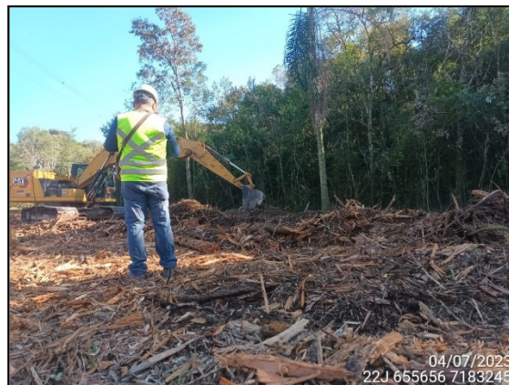
FIGURA 7: LIMPEZA DE ÁREA PREVIAMENTE SUPRIMIDA.
