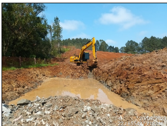
FIGURA 93: ESCAVAÇÃO DE SOLO.
