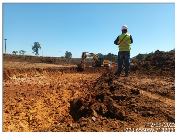
FIGURA 86: ARQUEÓLOGO ACOMPANHANDO ESCAVAÇÃO DE SOLO.
