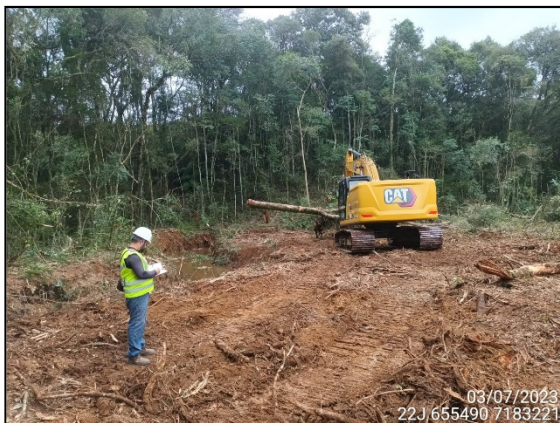
FIGURA 6: LIMPEZA E DESTOCAMENTO.
