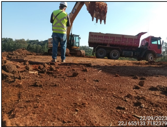
FIGURA 95: ARQUEÓLOGO ACOMPANHANDO ESCAVAÇÃO DE SOLO.
