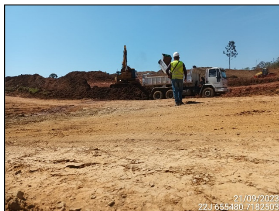
FIGURA 94: ARQUEÓLOGO ACOMPANHANDO ESCAVAÇÃO DE SOLO.
