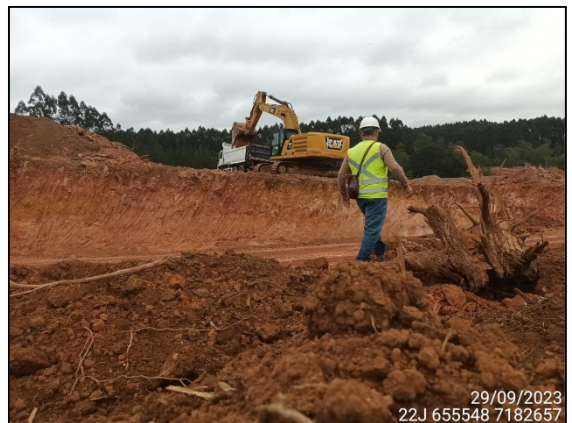
FIGURA 6: ESCAVAÇÃO E MOVIMENTAÇÃO DE SOLO.
