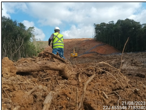
FIGURA 1: LIMPEZA DE ÁREA PREVIAMENTE SUPRIMIDA.
