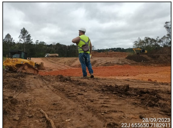
FIGURA 4: ARQUEÓLOGO DE CAMPO ACOMPANHANDO TERRAPLANAGEM.
