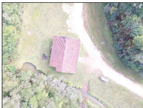
FIGURA 5: BARRACÃO DA ANTIGA MINA TIMBUTUVA
