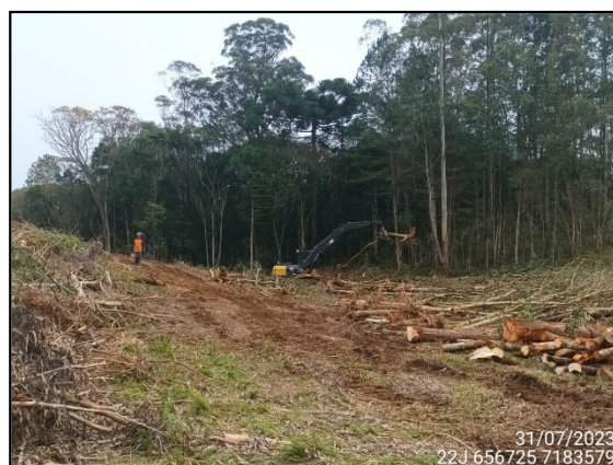
FIGURA 25: LIMPEZA EM ÁREA DE SUPRESSÃO VEGETAL.
