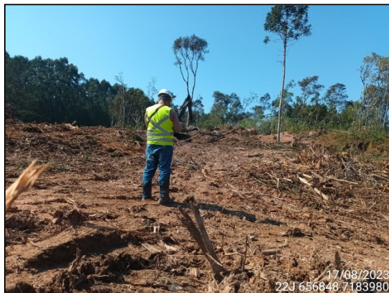
FIGURA 4: LIMPEZA DE ÁREA PREVIAMENTE SUPRIMIDA.
