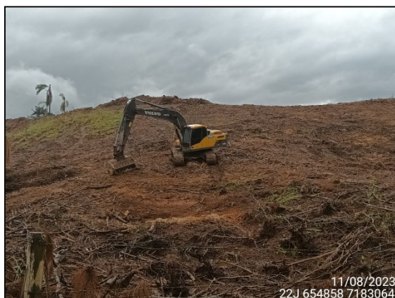
FIGURA 4: CORTE E LIMPEZA DE ÁREA PREVIAMENTE SUPRIMIDA.
