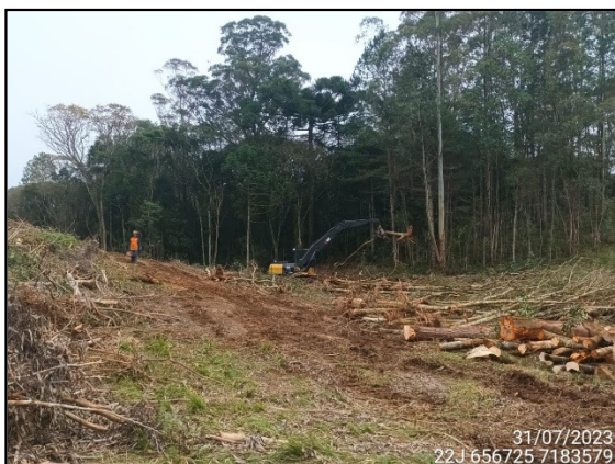
FIGURA 8: LIMPEZA SUPERFICIAL EM ÁREA DE SUPRESSÃO VEGETAL.
