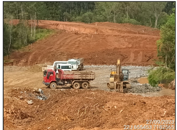
FIGURA 98: ESCAVAÇÃO DE MATERIAL ROCHOSO.
