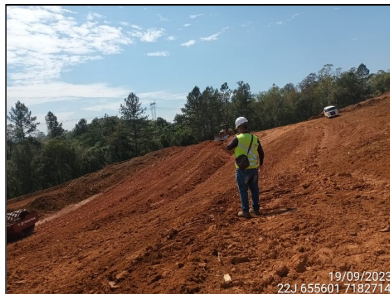
FIGURA 2: ARQUEÓLOGO DE CAMPO ACOMPANHANDO TERRAPLANAGEM.
