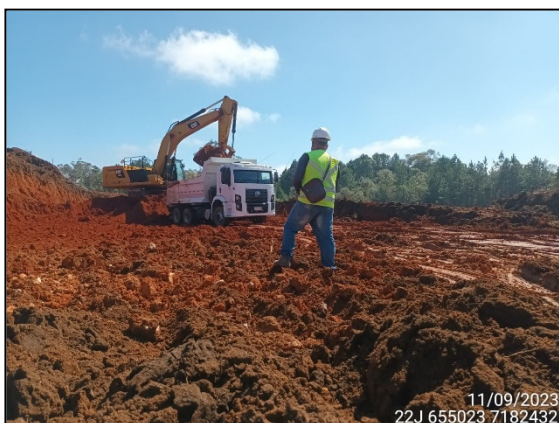
FIGURA 85: ARQUEÓLOGO ACOMPANHANDO ESCAVAÇÃO DE SOLO.
