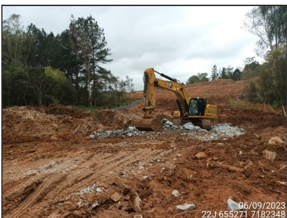
FIGURA 5: ESCAVAÇÃO E MOVIMENTAÇÃO DE MATERIAL ROCHOSO.
