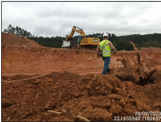
FIGURA 101: ARQUEÓLOGO DE CAMPO ACOMPANHANDO ESCAVAÇÃO DE SOLO.
