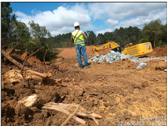
FIGURA 5: ESCAVAÇÃO E MOVIMENTAÇÃO DE MATERIAL ROCHOSO.
