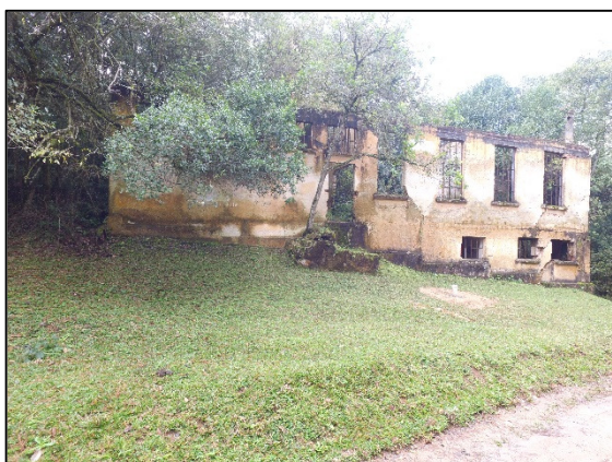
FIGURA 4: PRÉDIO ONDE FUNCIONAVA O LABORATÓRIO DA ANTIGA MINA TIMBUTUVA
