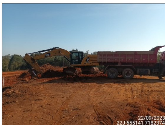
FIGURA 6: ESCAVAÇÃO E MOVIMENTAÇÃO DE SOLO.
