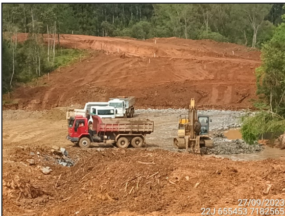
FIGURA 3: ESCAVAÇÃO DE MATERIAL ROCHOSO.
