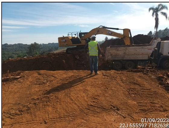
FIGURA 1: ARQUEÓLOGO DE CAMPO ACOMPANHANDO ESCAVAÇÃO E MOVIMENTAÇÃO DE SOLO.
