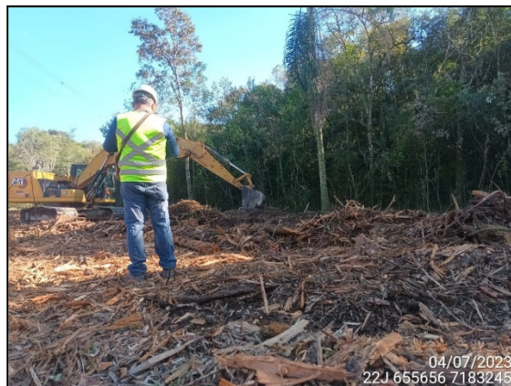
FIGURA 6: LIMPEZA SUPERFICIAL EM ÁREA SUPRIMIDA.
