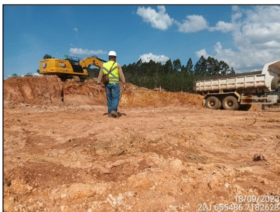
FIGURA 91: ARQUEÓLOGO ACOMPANHANDO ESCAVAÇÃO DE SOLO.
