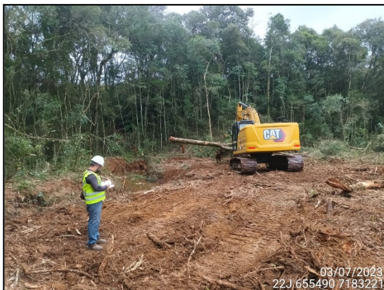
FIGURA 5: LIMPEZA E DESTOCAMENTO.
