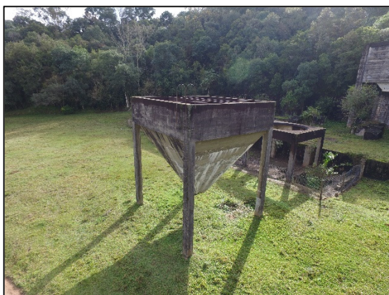
FIGURA 2: ANTIGA ESTRUTURA DOS BRITADORES DA MINA TIMBUTUVA
