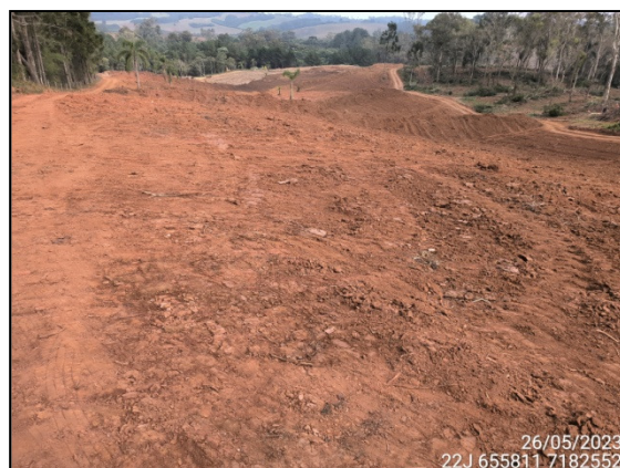
FIGURA 22: VISTA PARCIAL DA ÁREA DE LIMPEZA SUPERFICIAL.
