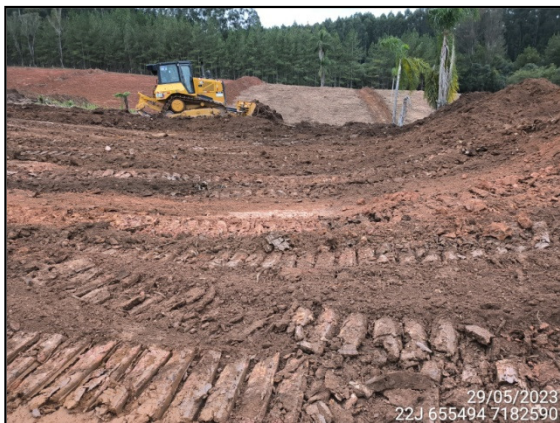
FIGURA 1: VISTA PARCIAL DA ÁREA DE LIMPEZA SUPERFICIAL.
