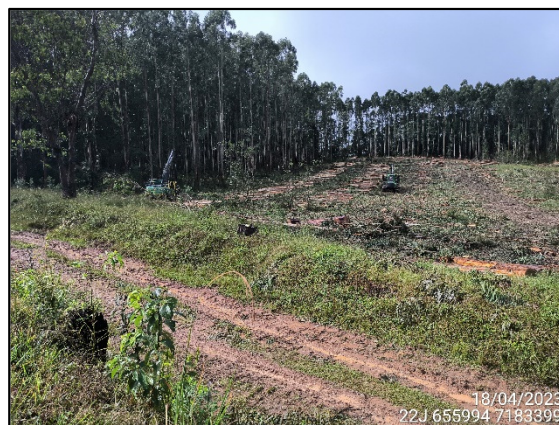
FIGURA 11: VISTA PARCIAL ATIVIDADE DE CORTE DE MATA EXÓTICA.
