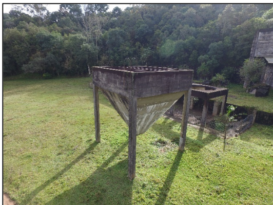
FIGURA 2: ANTIGA ESTRUTURA DOS BRITADORES DA MINA TIMBUTUVA
