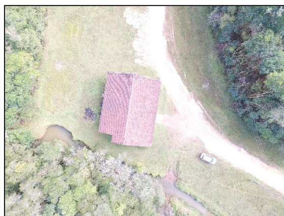
FIGURA 5: BARRACÃO DA ANTIGA MINA TIMBUTUVA
