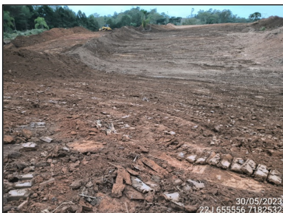
FIGURA 3: VISTA PARCIAL DA ÁREA DE LIMPEZA SUPERFICIAL.
