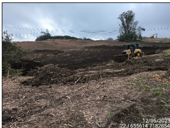
FIGURA 7: VISTA PARCIAL DA ÁREA DE LIMPEZA SUPERFICIAL.
