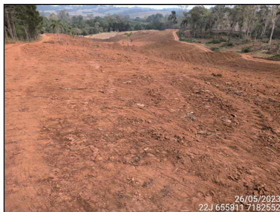
FIGURA 1: VISTA PARCIAL DA ÁREA ONDE FOI REALIZADA A LIMPEZA SUPERFICIAL.
