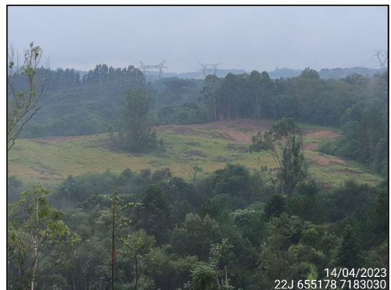
FIGURA 6: VISTA PARCIAL DA ÁREA DE LIMPEZA SUPERFICIAL.
