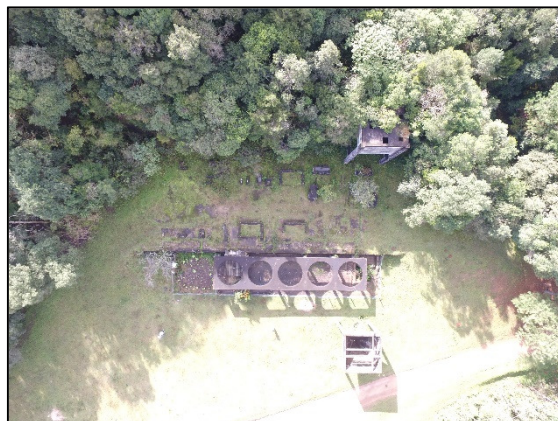
FIGURA 3: ESTRUTURA DA ANTIGA MINA TIMBUTUVA
