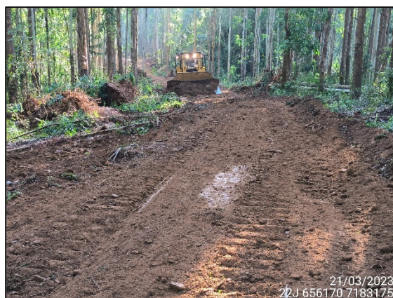
FIGURA 4: MANUTENÇÃO DE ACESSO.
