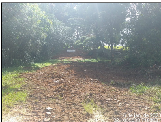
FIGURA 5: ABERTURA DE ACESSO.
