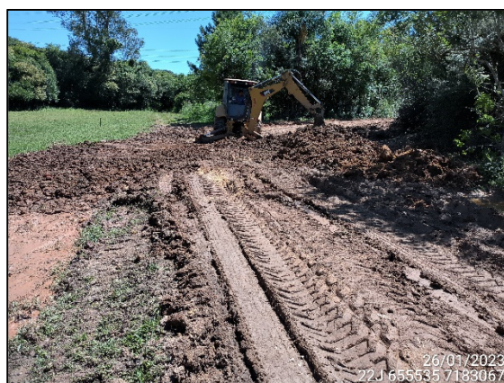
FIGURA 4: MANUTENÇÃO DE ACESSO.
