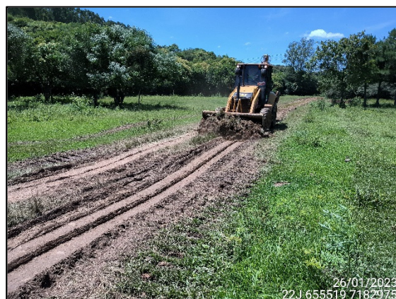
FIGURA 9: MANUTENÇÃO DO ACESSO.
