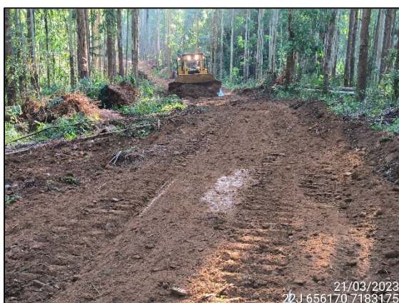
FIGURA 26: MANUTENÇÃO DE ACESSO.
