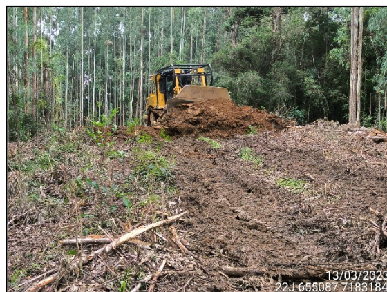
FIGURA 23: MANUTENÇÃO DE ACESSO.
