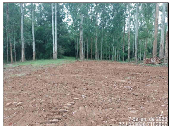
FIGURA 6: ABERTURA DE ACESSO.
