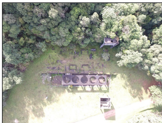
FIGURA 3: ESTRUTURA DA ANTIGA MINA TIMBUTUVA
