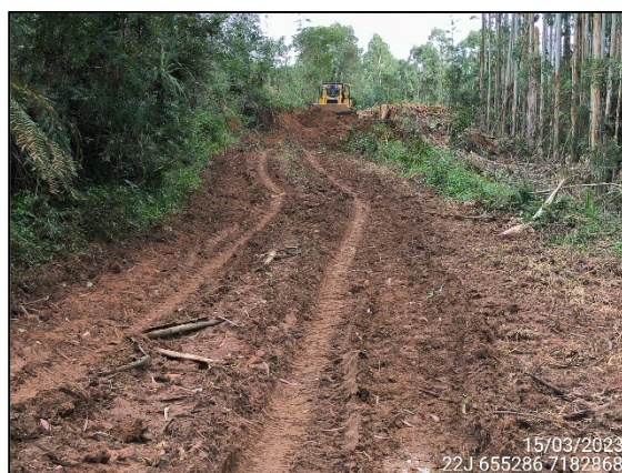
FIGURA 4: MANUTENÇÃO DE ACESSO.
