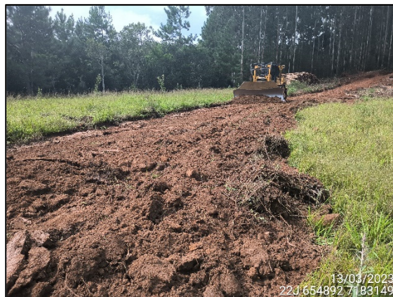
FIGURA 2: MANUTENÇÃO DE ACESSO.
