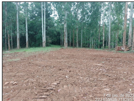
FIGURA 7: ABERTURA DO ACESSO.
