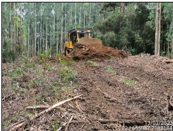
FIGURA 1: MANUTENÇÃO DE ACESSO.
