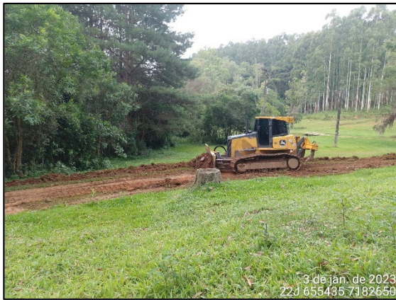
FIGURA 7: MANUTENÇÃO DO ACESSO.
