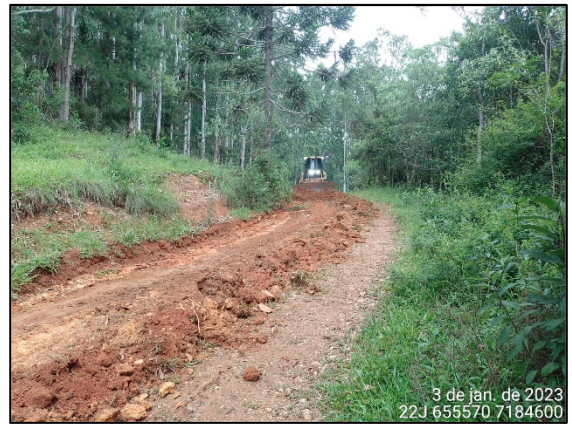
FIGURA 8: MANUTENÇÃO DO ACESSO.
