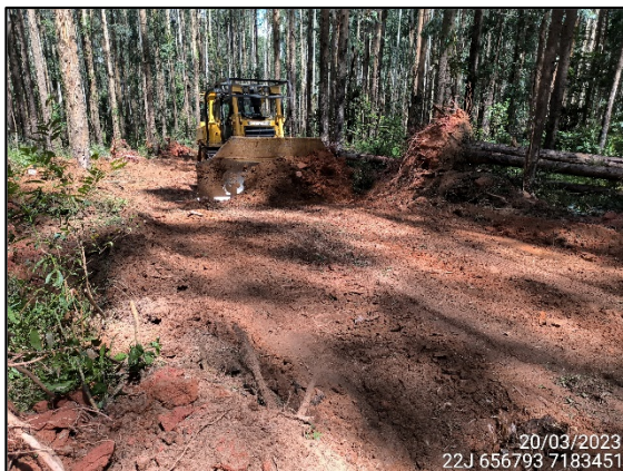
FIGURA 1: MANUTENÇÃO DE ACESSO.
