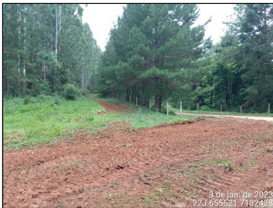
FIGURA 9: MANUTENÇÃO DO ACESSO.
