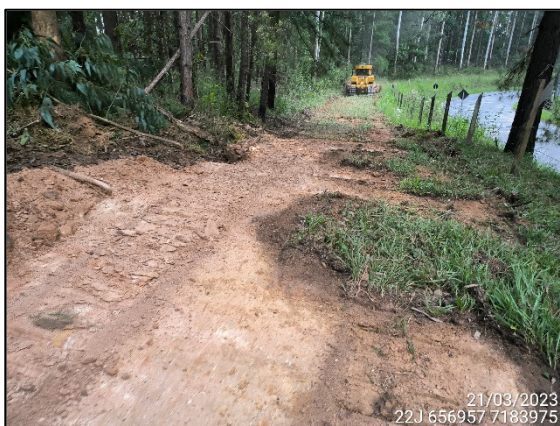
FIGURA 5: MANUTENÇÃO DE ACESSO.
