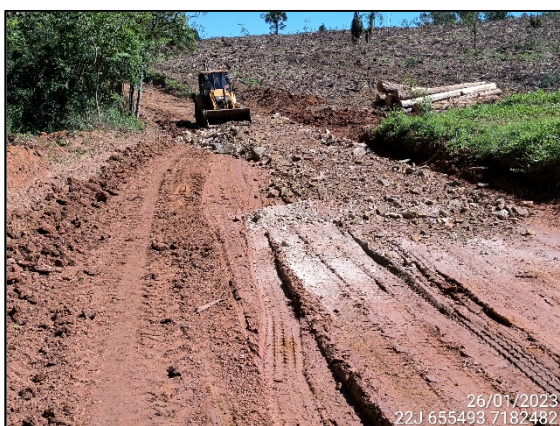
FIGURA 3: MANUTENÇÃO DE ACESSO.
