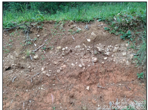
FIGURA 10: MANUTENÇÃO DO ACESSO.
