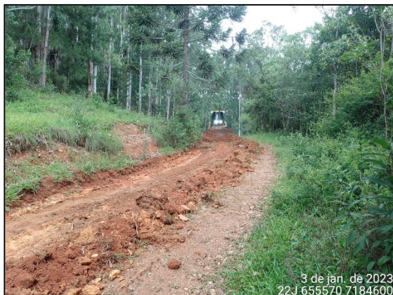
FIGURA 6: MANUTENÇÃO DO ACESSO.
