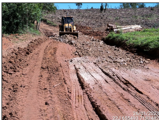
FIGURA 8: MANUTENÇÃO DO ACESSO.
