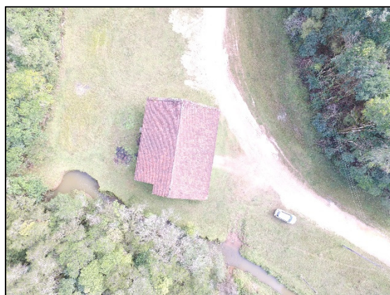
FIGURA 5: BARRACÃO DA ANTIGA MINA TIMBUTUVA
