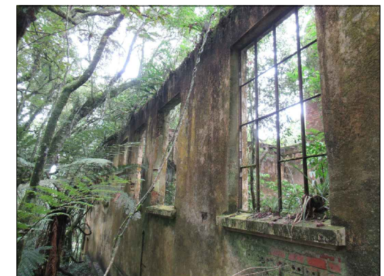
Fachada Sudeste Acervo próprio, 2021.
