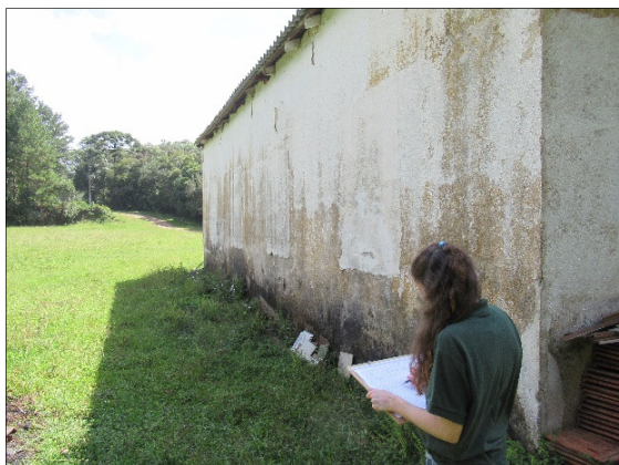
FIGURA 41: ANOTAÇÃO DE ABERTURAS SUPRIMIDAS (ESTRUTURA: BARRACÃO). FONTE: ESPAÇO ARQUEOLOGIA, 2021.
