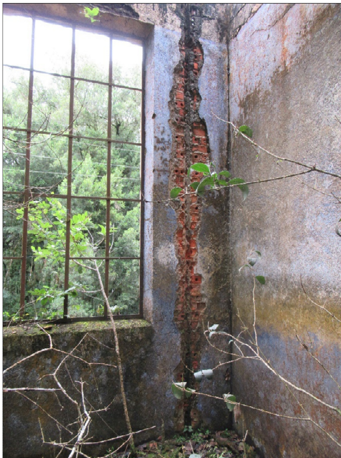
FIGURA 51: ENCANAMENTOS RETIRADOS DA EDIFICAÇÃO DO LABORATÓRIO. FONTE: ESPAÇO ARQUEOLOGIA, 2021.
