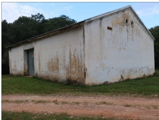
FIGURA 53: BARRACÃO [01]. FONTE: ESPAÇO ARQUEOLOGIA, 2021.
