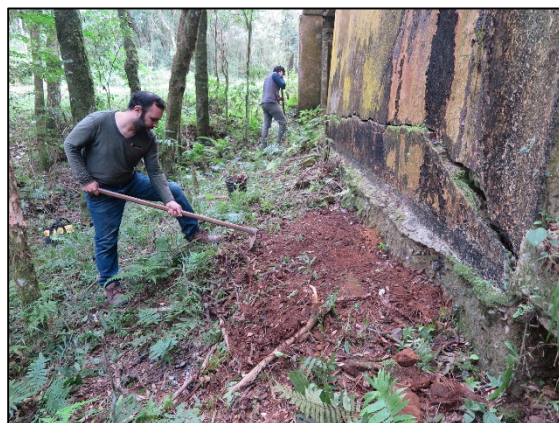
FIGURA 3: RETIRADA DA COBERTURA VEGETAL PARA EVIDENCIAÇÃO DOS ALICERCES DA EDIFICAÇÃO – FAZENDA TIMBUTUVA 8. FONTE: ESPAÇO ARQUEOLOGIA, 2021.
