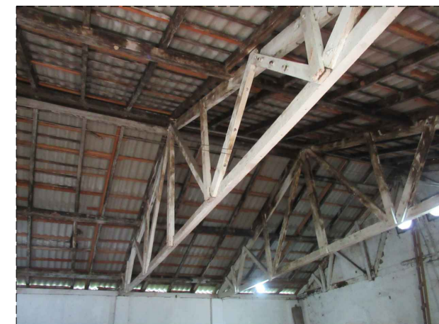
Estrutura da cobertura. Acervo próprio, 2021.
