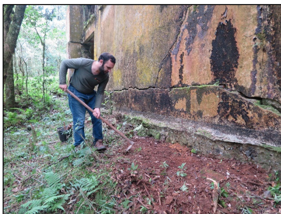
FIGURA 10: RETIRADA DA COBERTURA VEGETAL PARA DEMARCAÇÃO DA TRINCHEIRA 2. FONTE: ESPAÇO ARQUEOLOGIA, 2021.
