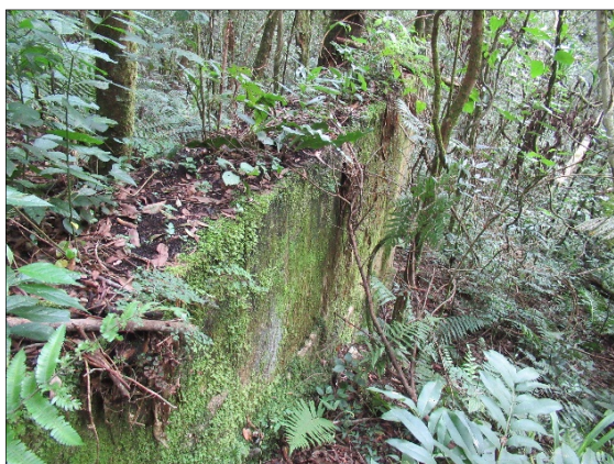
FIGURA 55: FUNDAÇÕES DA ESTEIRA [03]. FONTE: ESPAÇO ARQUEOLOGIA, 2021.
