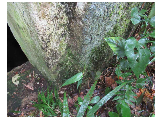
Umidade ascendente Acervo próprio, 2021.
