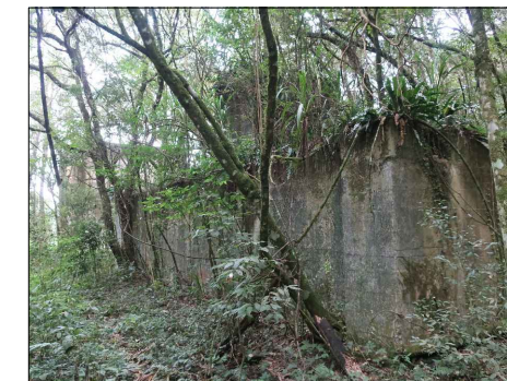
Fundações de Edificação Coordenadas: 25°27'48.22"S / 49°27'25.44"O
