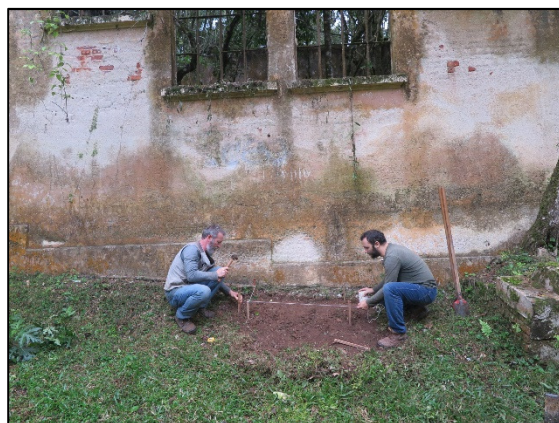
FIGURA 21: DEMARCAÇÃO DA TRINCHEIRA 3 NA PARTE FRONTAL DA EDIFICAÇÃO. FONTE: ESPAÇO ARQUEOLOGIA, 2021.
