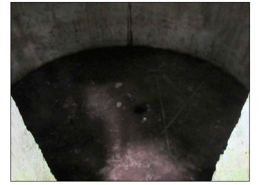
5 Pavimento no interior Acervo próprio, 2021.
