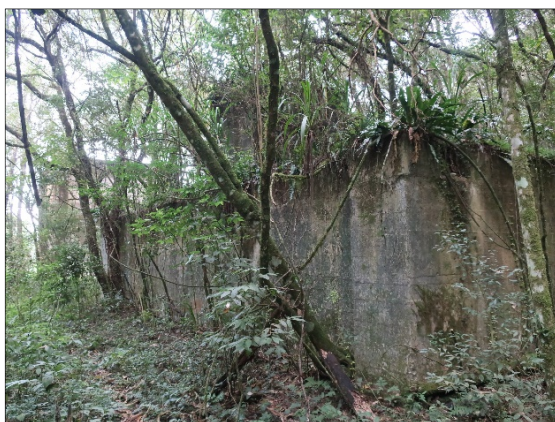
FIGURA 56: FUNDAÇÕES DE EDIFICAÇÃO [04]. FONTE: ESPAÇO ARQUEOLOGIA, 2021.
